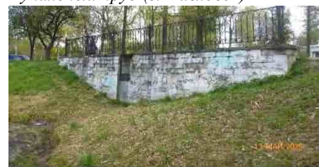
Водосливная плотина на пруду
