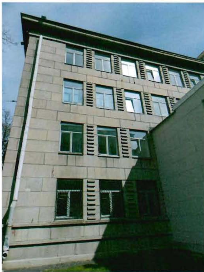
Фото 5. Фрагмент южного фасада.
