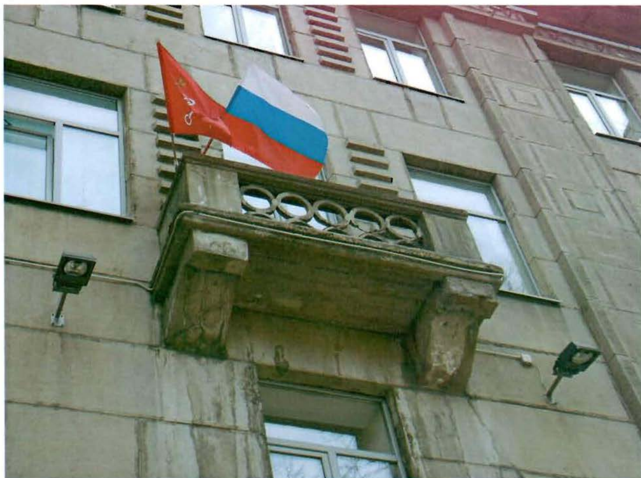
Фото 6. Балкон на западном фасаде.
