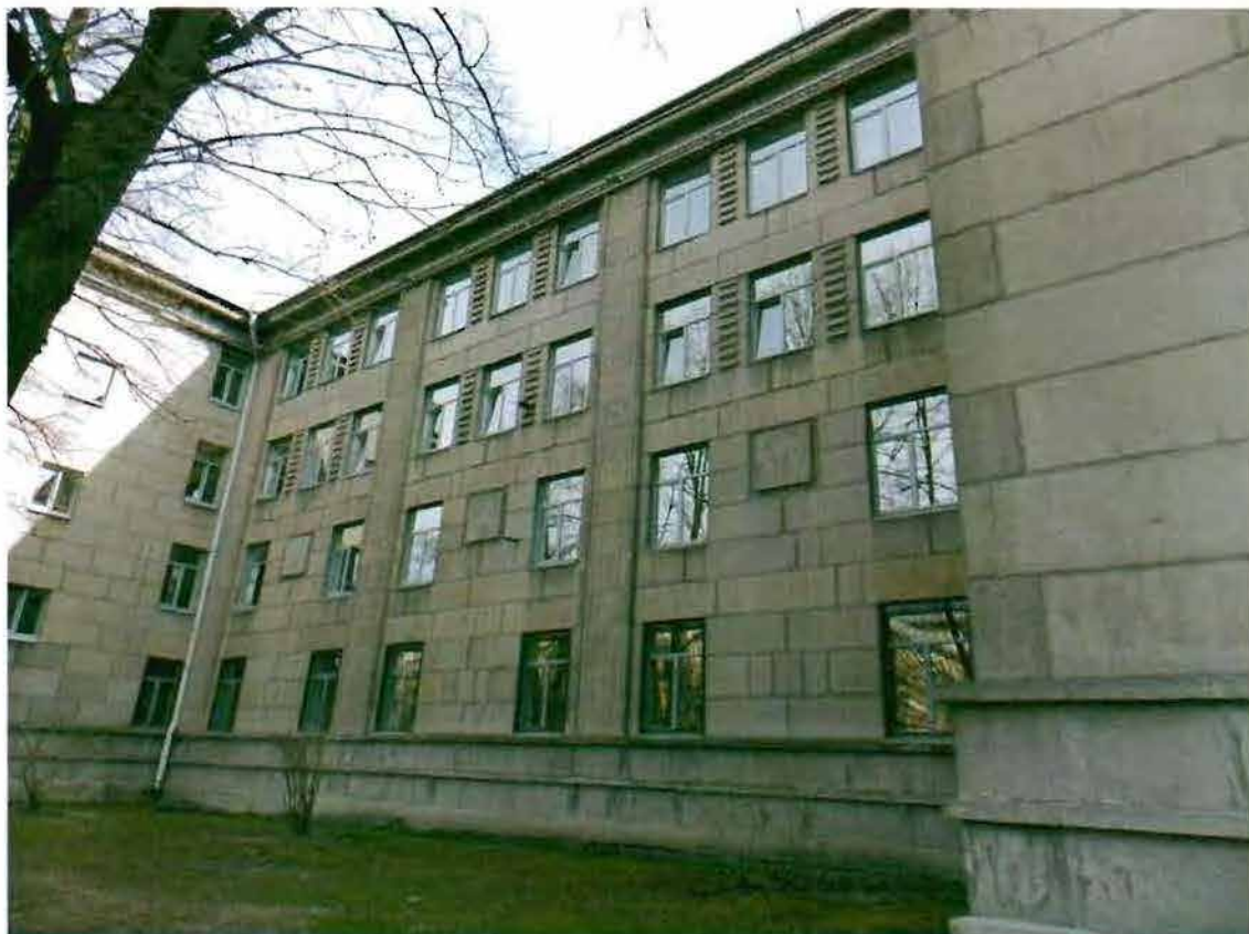
Фото 9. Фрагмент западного фасада.
