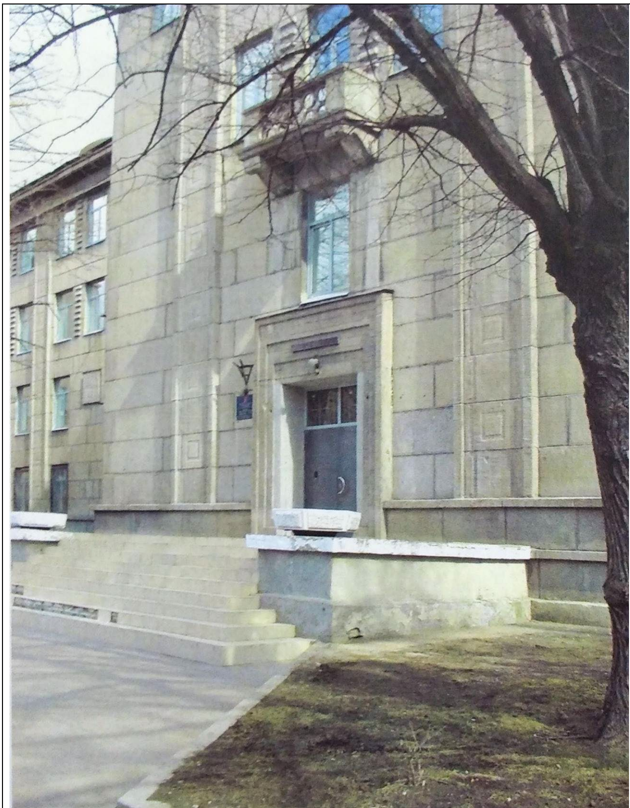
8. Фрагмент главного западного фасада. Фото 2009 г.
