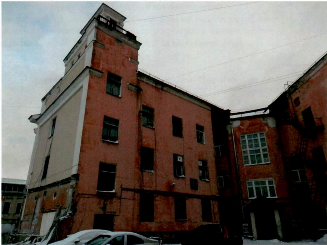
3. Северо-западный дворовый фасад
