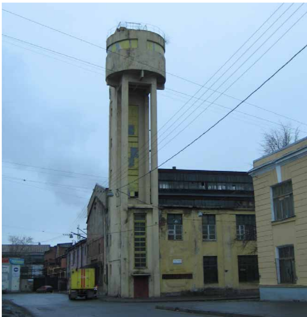
33. Канатный цех. Направление съемки: север. 2008 г.
