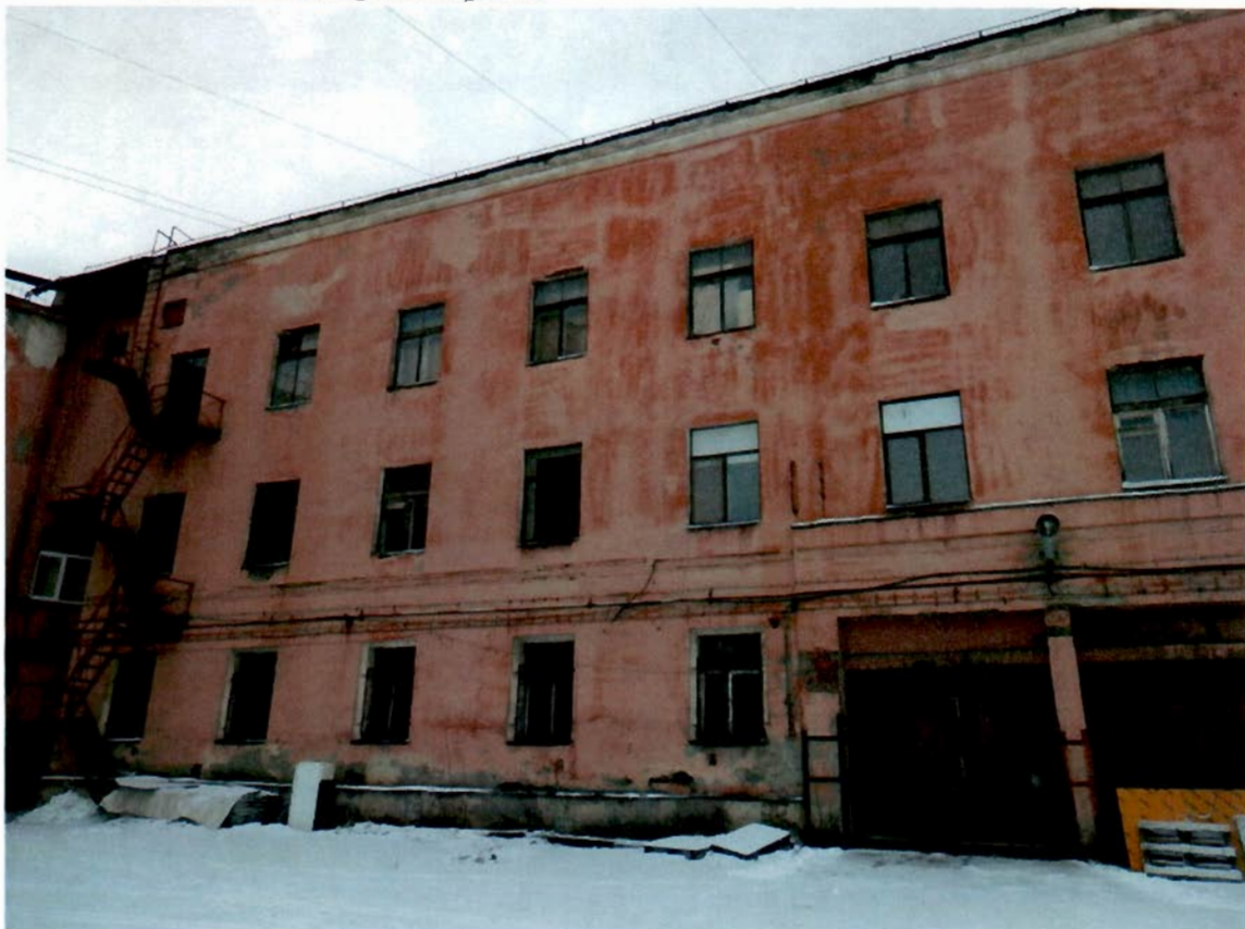
4. Восточный дворовый фасад
