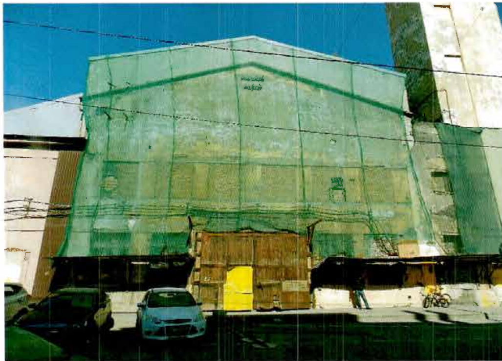
3. Вид на юго-восточный фасад.
