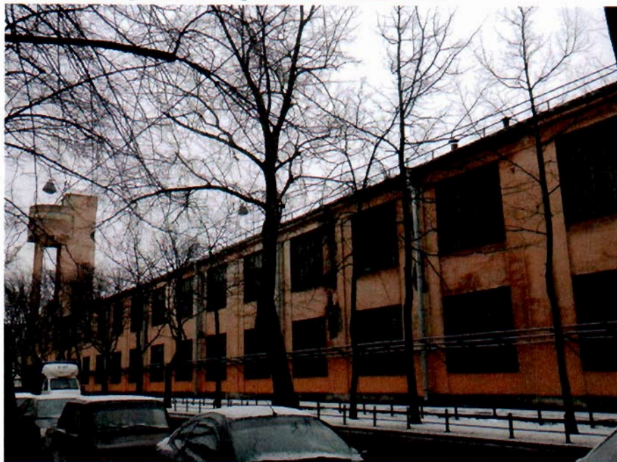
1. Лицевой фасад со стороны 25-й линии В.О.
