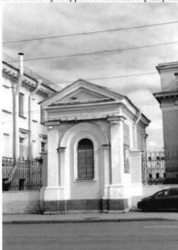
11. Юго-западный фасад северо-западной Часовни.
