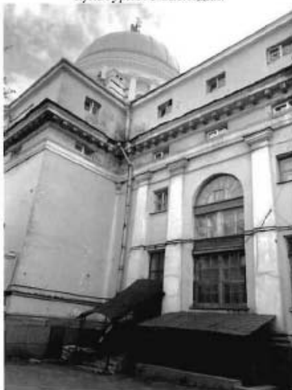
3. Фрагмент северо-западного фасада объекта культурного наследия.
