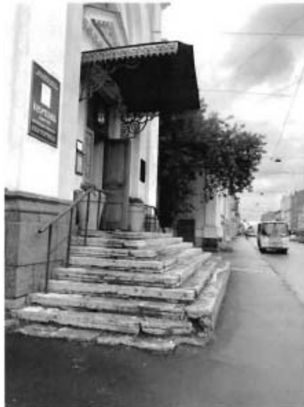
2. Юго-западный фасад объекта культурного наследия. Главный вход.
