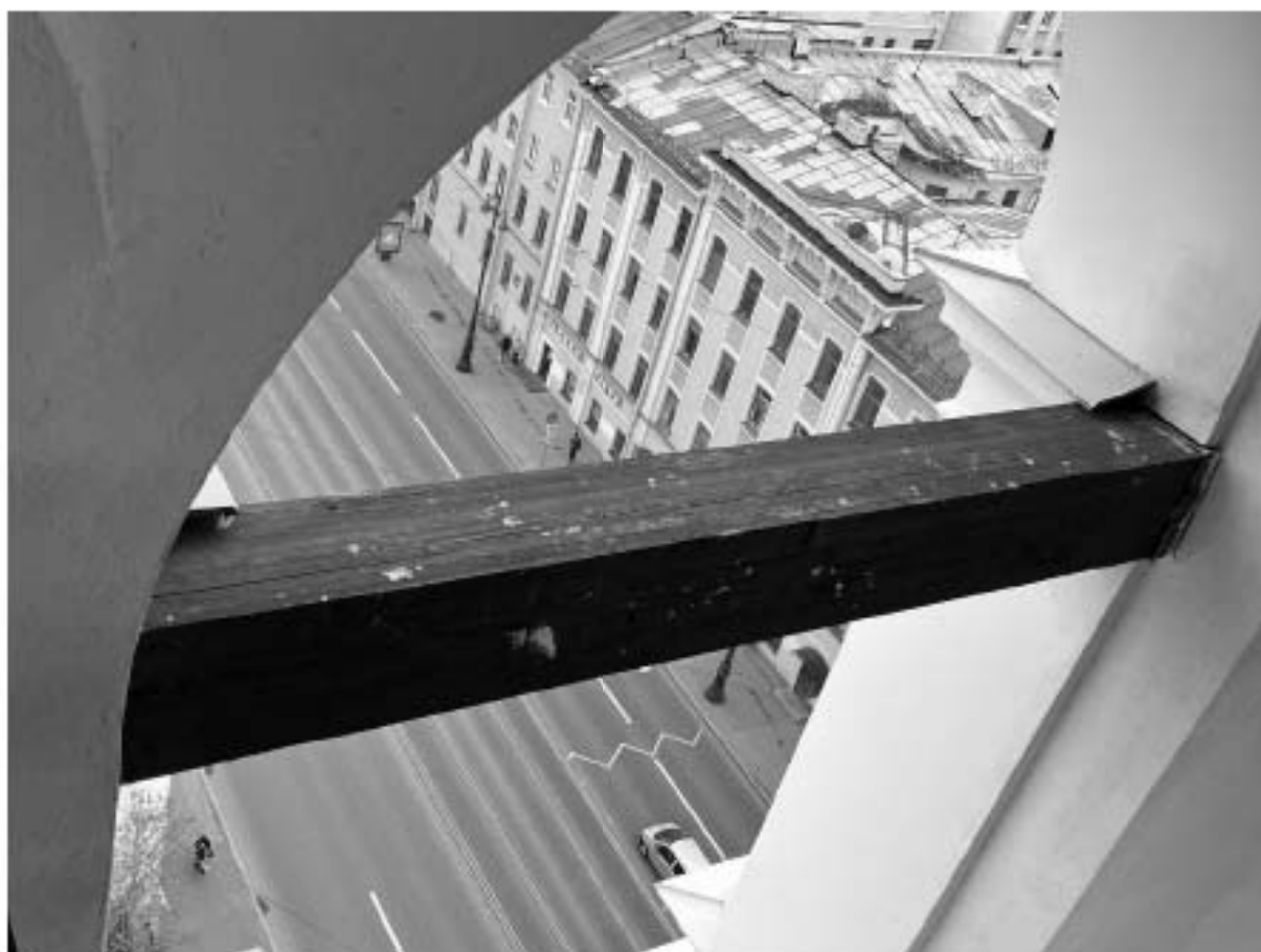
Фото 8. Балки подвеса колоколов в проемах 2 яруса
