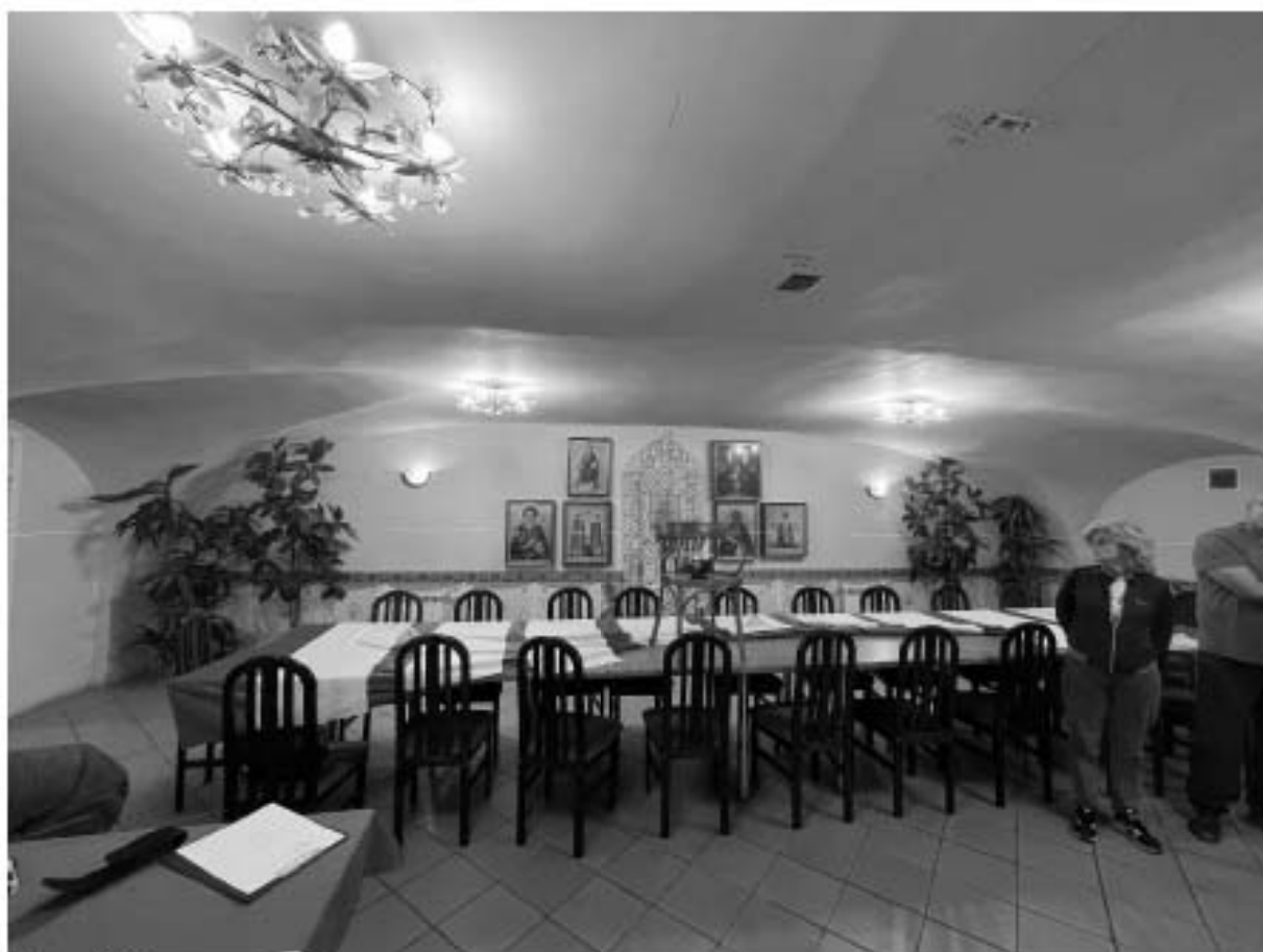
Фото 9. Вид на сводчатые перекрытия цокольного этажа.
