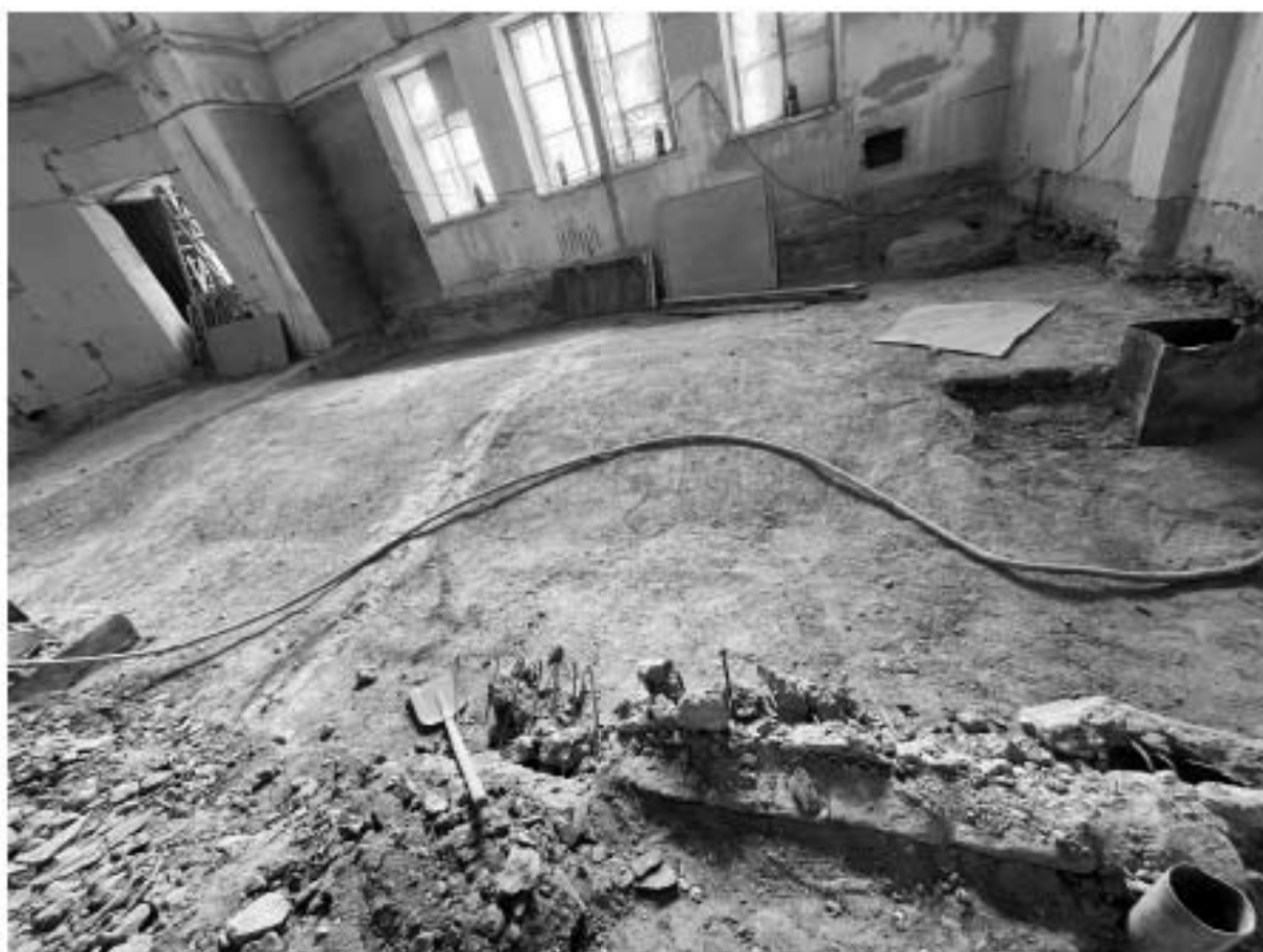
Фото 10. Вид на сводчатые перекрытия цокольного этажа из помещения 1 этажа.
