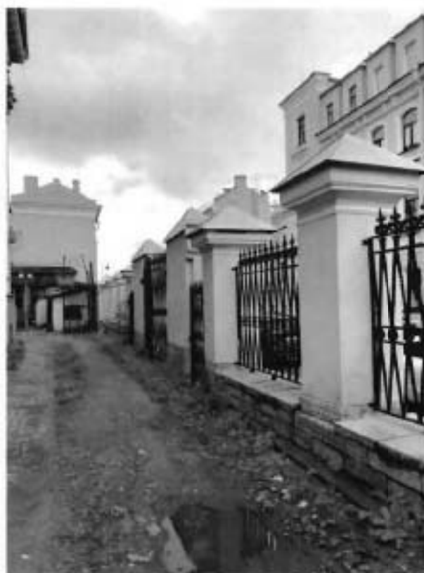
16. Фрагмент ограды вдоль Тучкова переулка. Юго-западный фасад.
