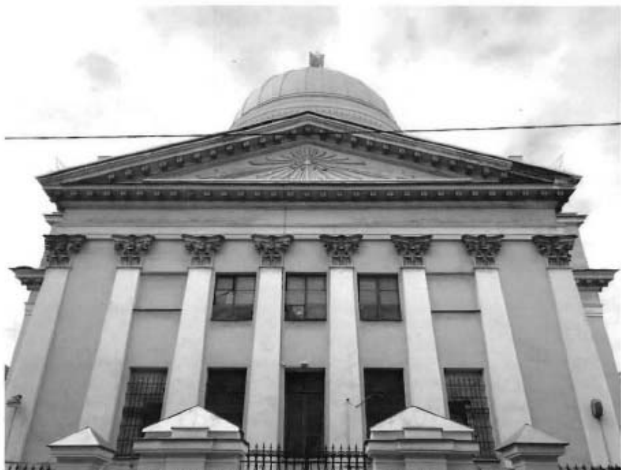
5. Северо-восточный фасад объекта культурного наследия.
