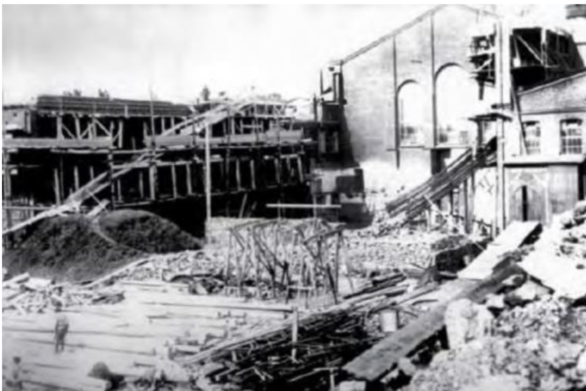
33. Строительство электростанции. 1897–1898 гг.
