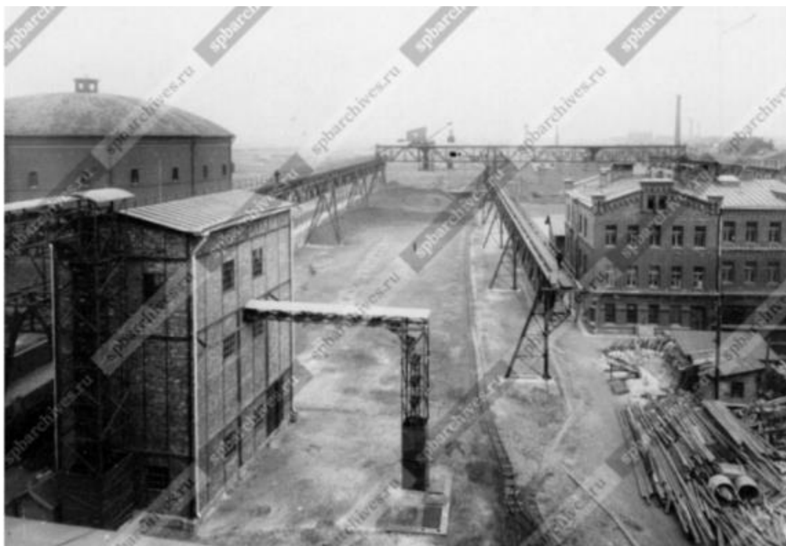
48. Двор электростанции «Общества электрического освещения 1886 г.». 1911 г. ЦГА КФФД СПб. Шифр: Е 8662
