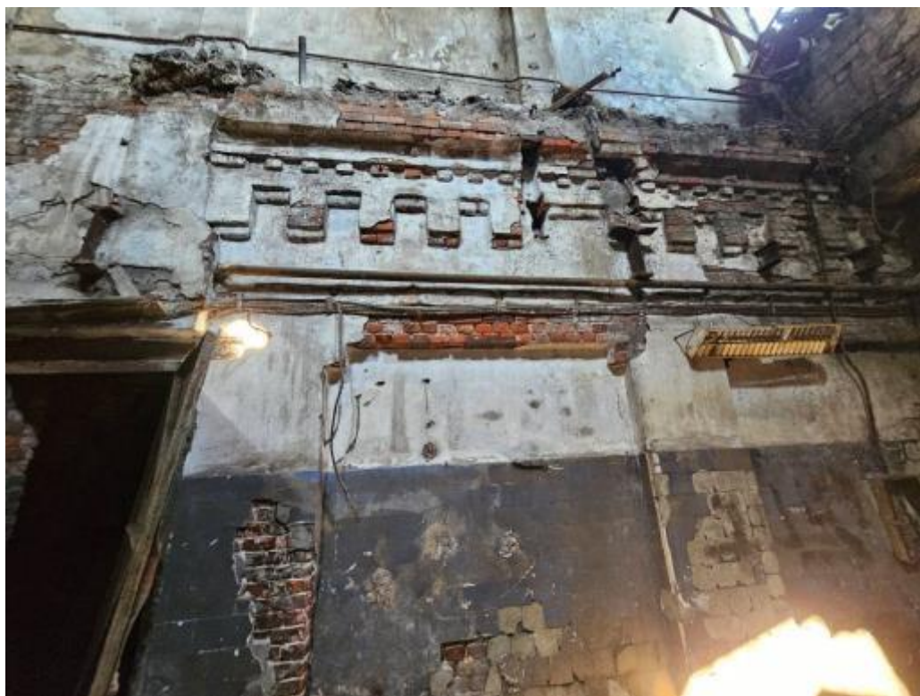
32. Фрагмент основания дымовой трубы.
