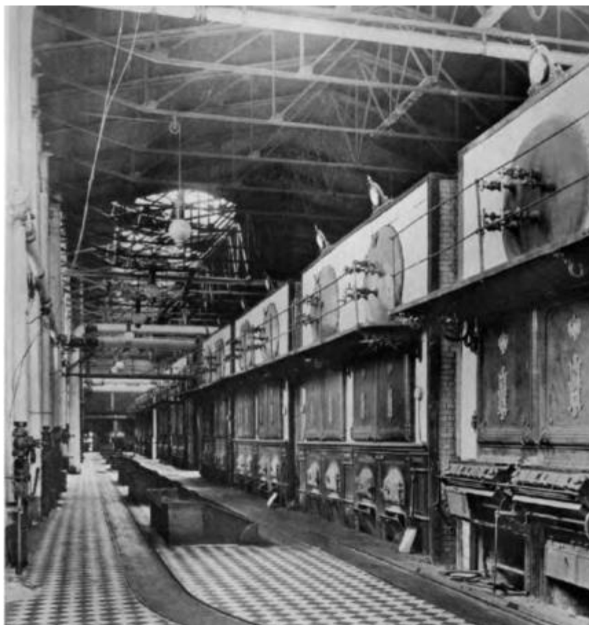
53. Котельное помещение электростанции. Центральные станции Общества электрического освещения 1886 г. в Москве и С.-Петербурге. 1901
