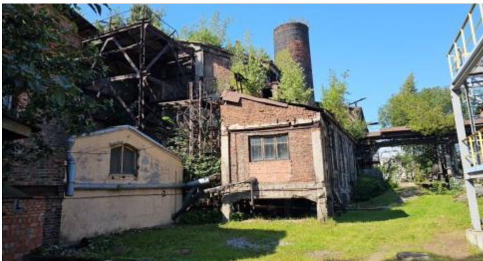
14. Вид с юга на боковой восточный корпус и дымовую трубу.
