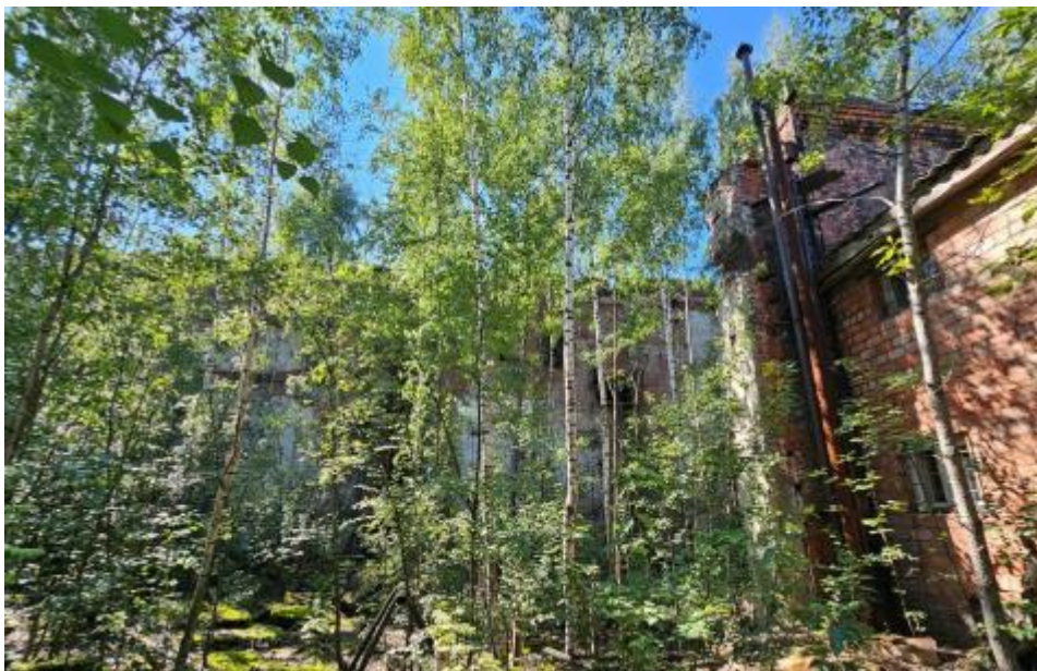
13. Вид на восточный фасад центрального корпуса.
