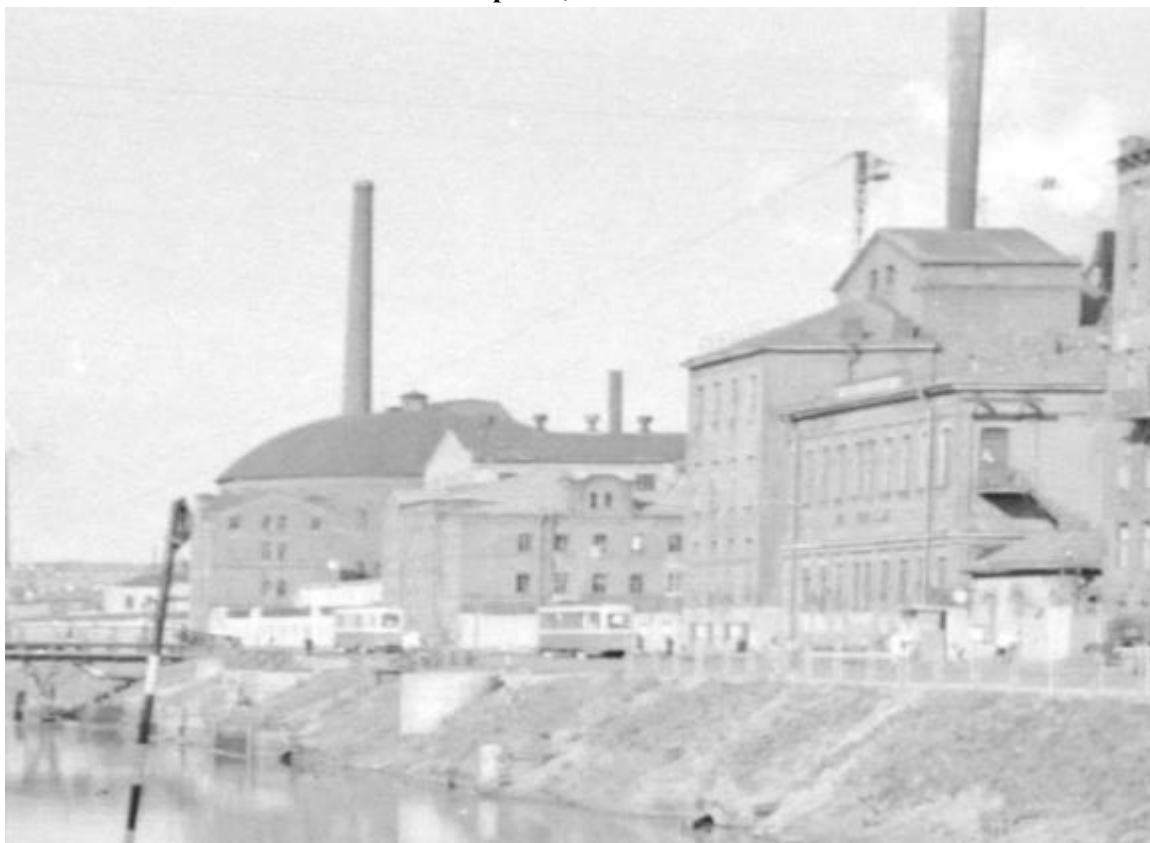
85. Застройка берега Обводного канала. справа электростанция ГЭС-1. 1950-е гг.
