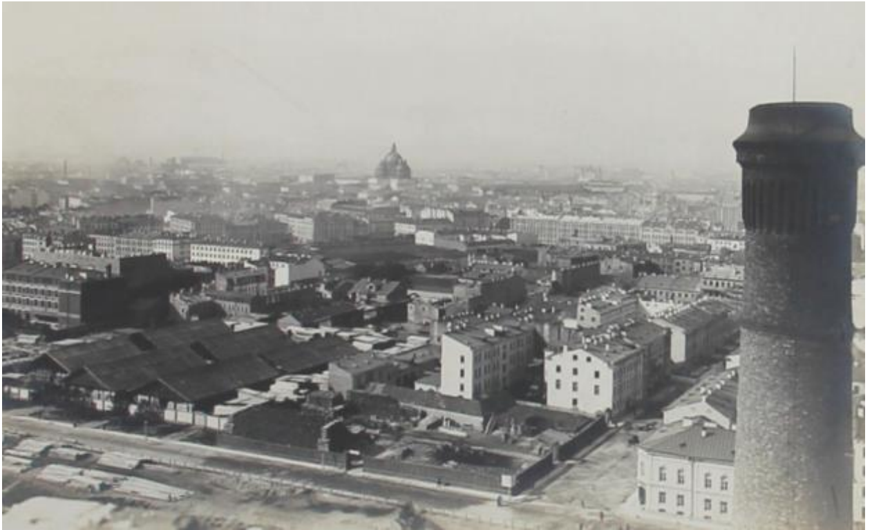
43. Электростанция «Общества электрического освещения» на набережной Обводного канала. Вид завершения трубы
