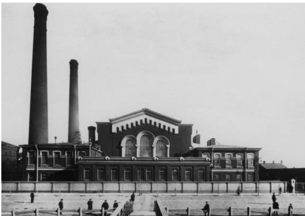
42. Центральная станции Общества электрического освещения 1886 г. Фото около 1900 г. Архив ТЭЦ-2.
