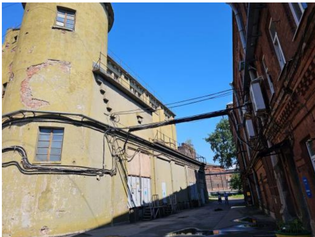
9. Вид южной части здания.
