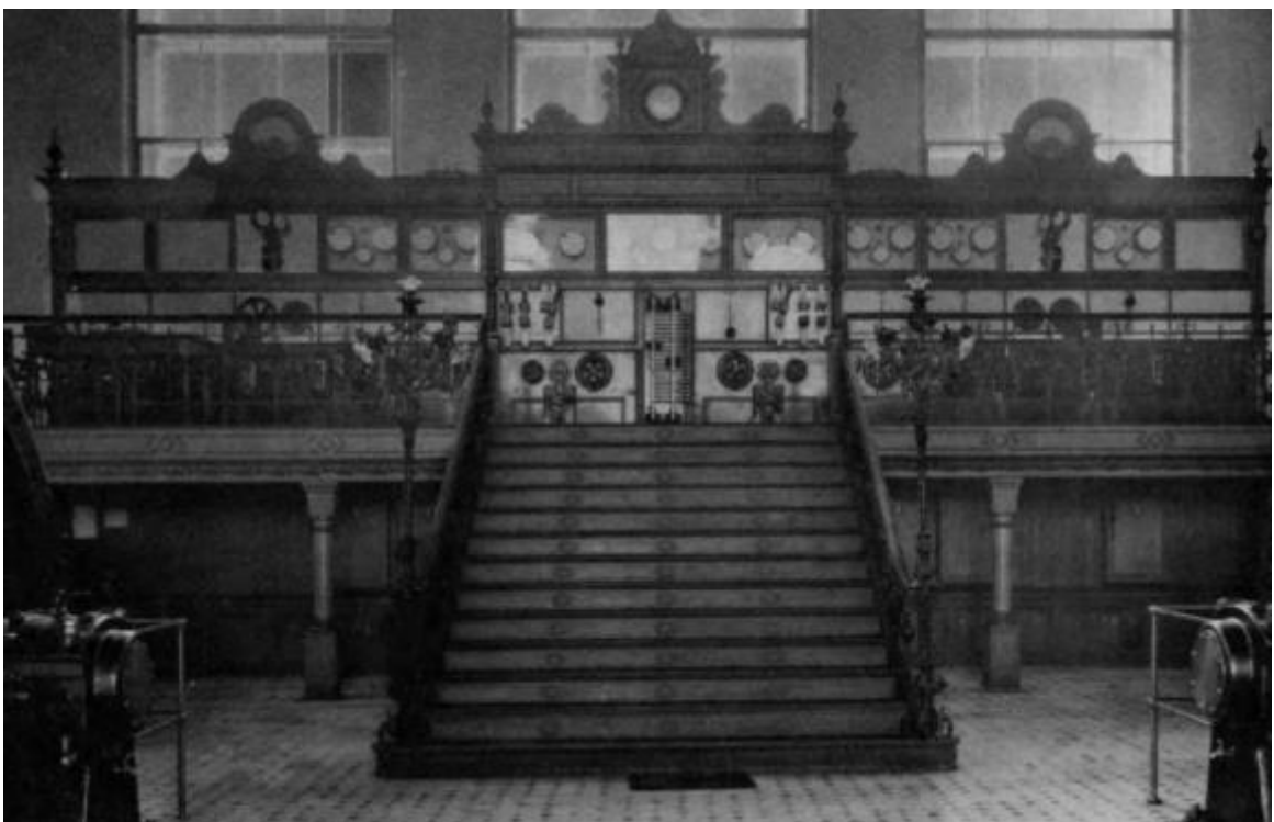
52. Машинный зал станции «Общества электрического освещения 1886 г.». Альбом участников Первого Всероссийского электротехнического съезда. СПб., 1900
