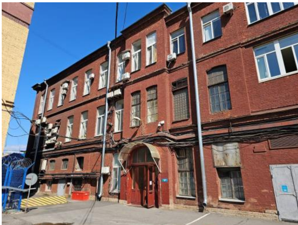
5. Вид на западный фасад бокового западного корпуса.
