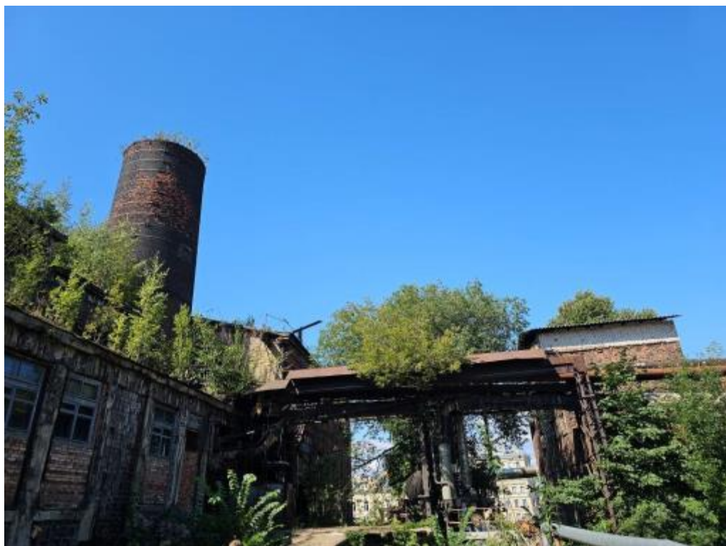
18. Вид с востока на дымовую трубу.
