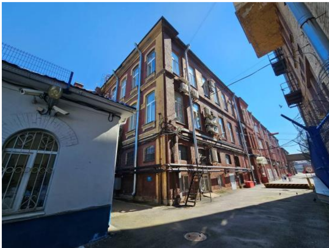
1. Вид на западный боковой корпус со стороны Обводного канала.
