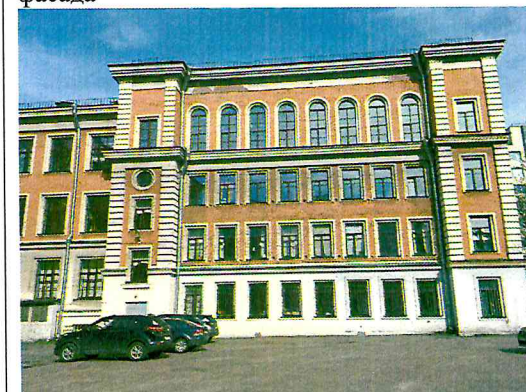
дворовый фасад северного флигеля
