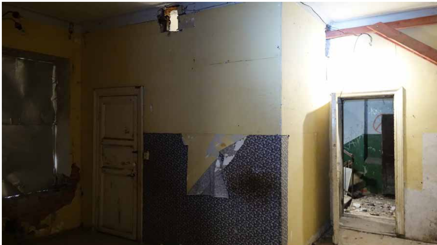
Фото 126. Помещение 45. Общий вид. Первый этаж. Дата фотофиксации: 01.03.24
