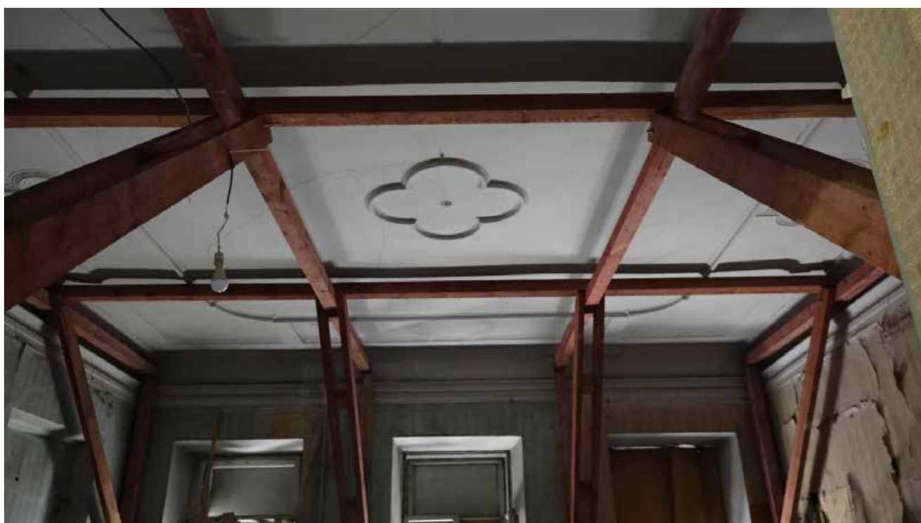
Фото 146. Помещение 58. Комплексная отделка потолка тянутым профилированным декором с падугой. Второй этаж. Дата фотофиксации: 01.03.24
