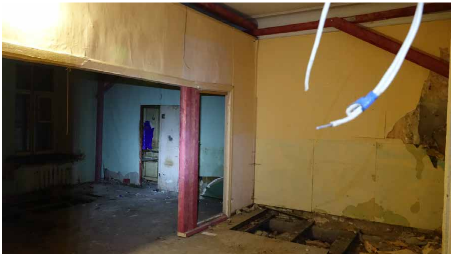
Фото 93. Помещение 13. Общий вид. Первый этаж. Дата фотофиксации: 01.03.24
