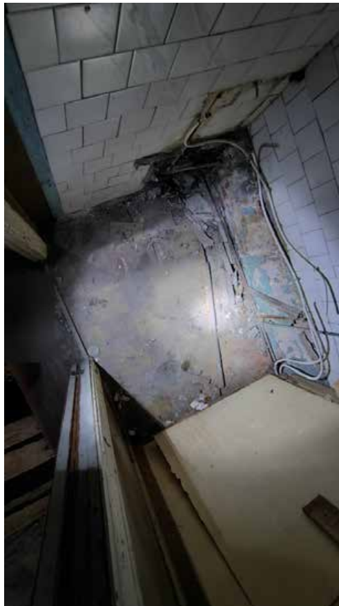
Фото 185. Помещение 94. Общий вид. Второй этаж. Дата фотофиксации: 01.03.24
