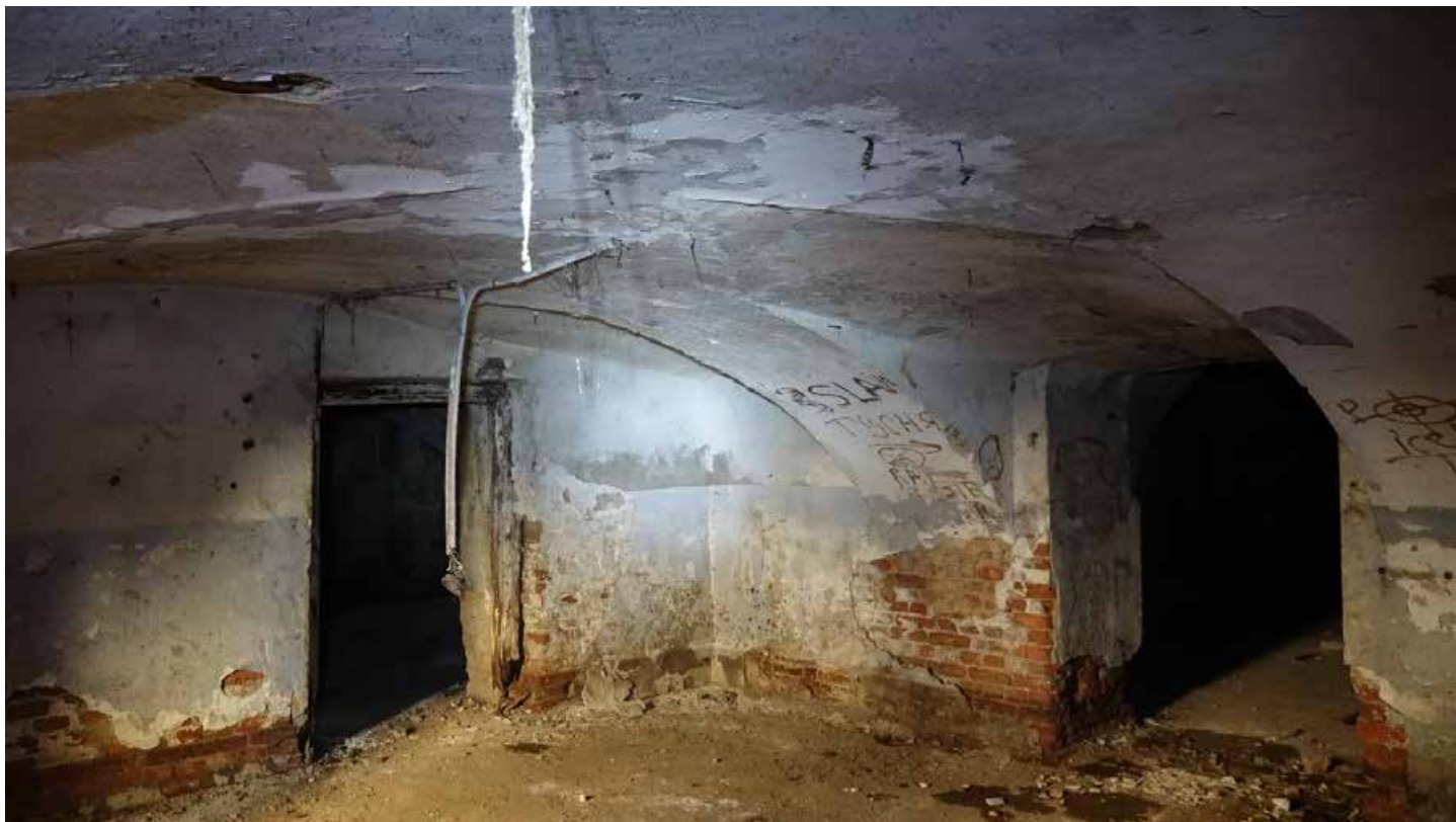
Фото 37. Помещение 1. Фрагмент. Цокольный этаж. Дата фотофиксации: 01.03.24
