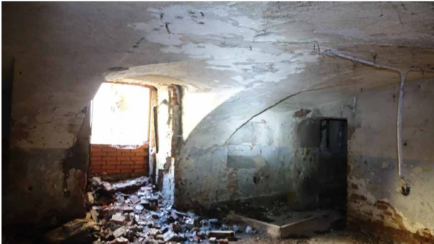
Фото 39. Помещение 1. Вид на частично заложный дверной проем прямка. Цокольный этаж. Дата фотофиксации: 01.03.24
