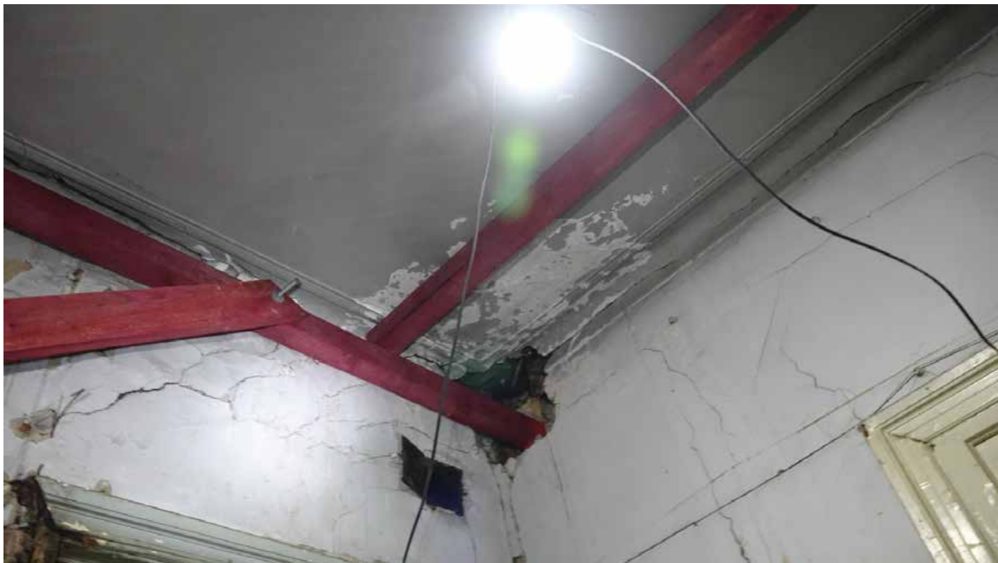
Фото 153. Помещение 63. Фрагмент. Второй этаж. Дата фотофиксации: 01.03.24
