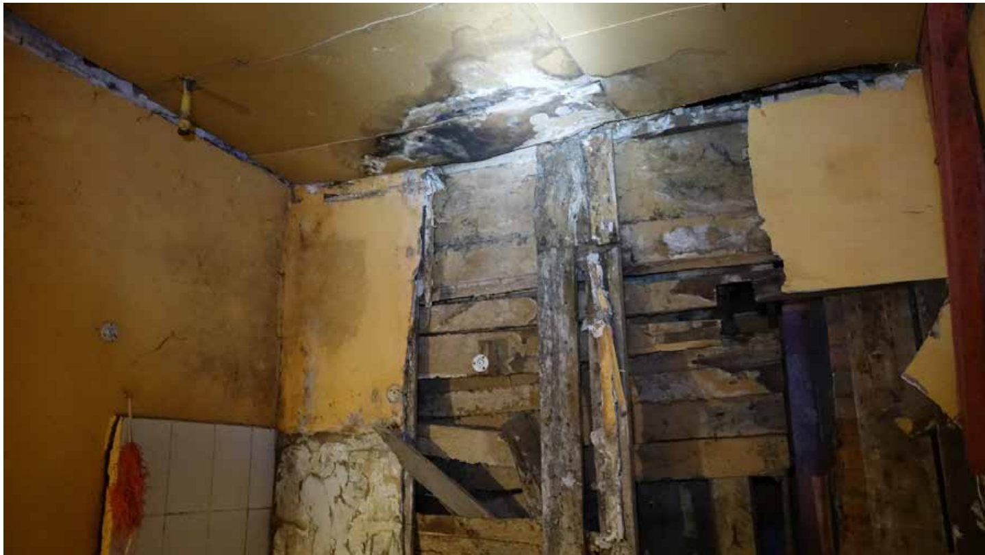
Фото 124. Помещение 44. Общий вид. Первый этаж. Дата фотофиксации: 01.03.24
