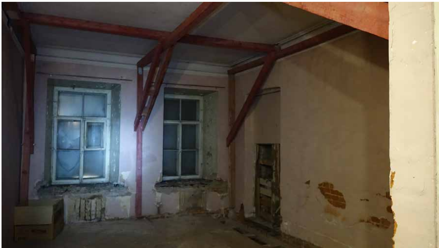
Фото 116. Помещение 40. Общий вид. Первый этаж. Дата фотофиксации: 01.03.24
