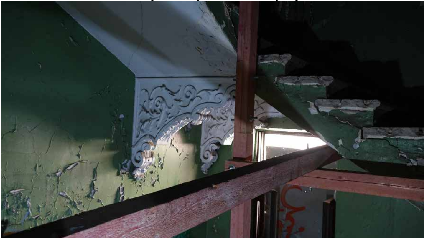
Фото 6. Лестница Л1. Фрагмент с кронштейнами. Дата фотофиксации: 01.03.24
