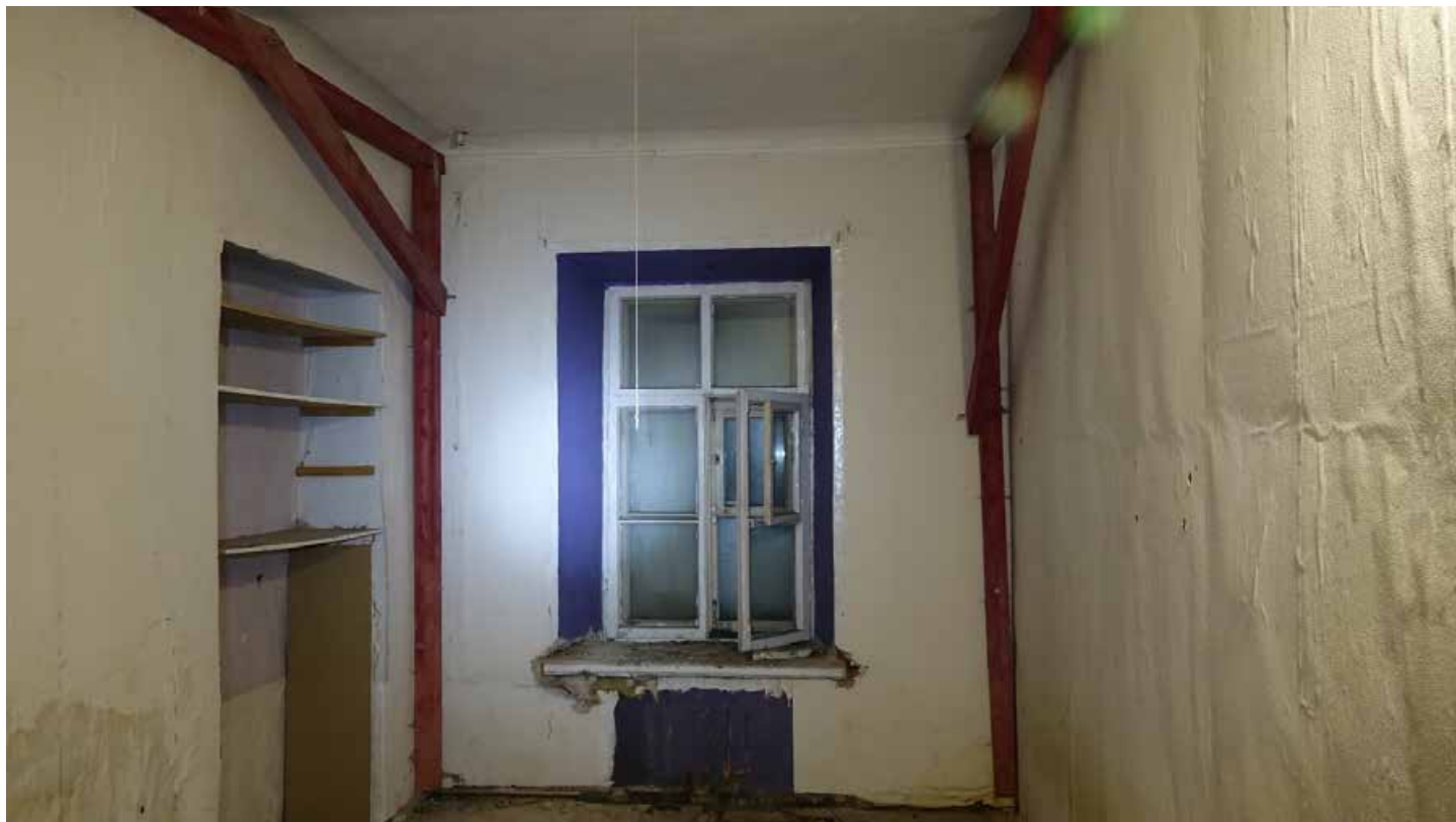
Фото 92. Помещение 12. Общий вид. Первый этаж. Дата фотофиксации: 01.03.24
