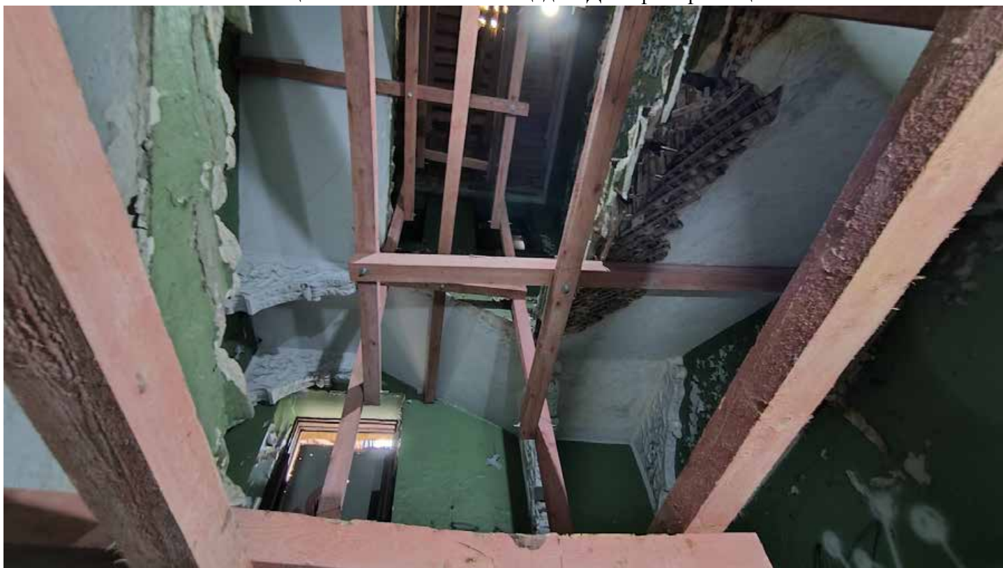
Фото 4. Лестница Л1. Кронштейны, лестничные марши. Дата фотофиксации: 01.03.24
