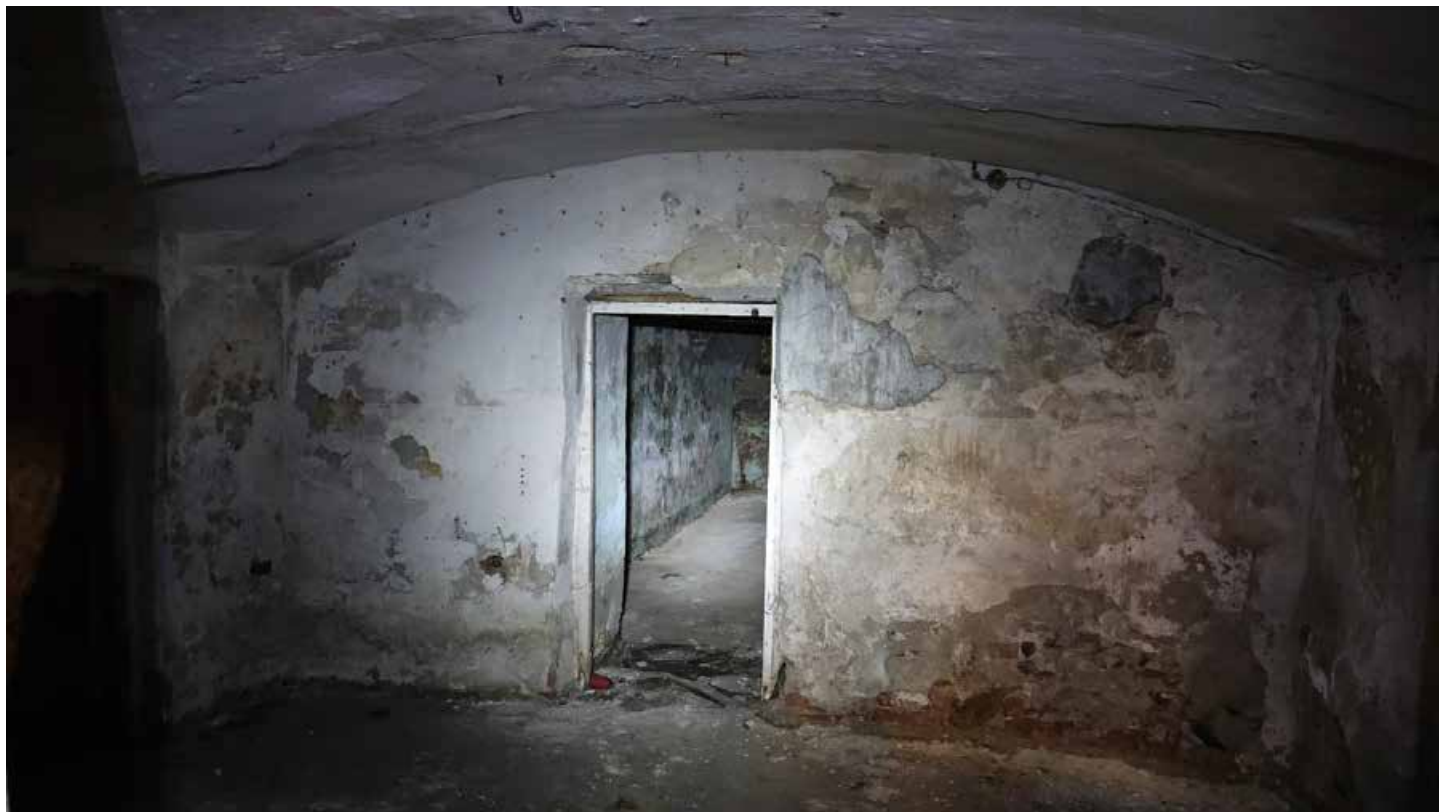
Фото 1. Помещение 153. Цилиндрический свод. Цокольный этаж. Дата фотофиксации: 01.03.24
