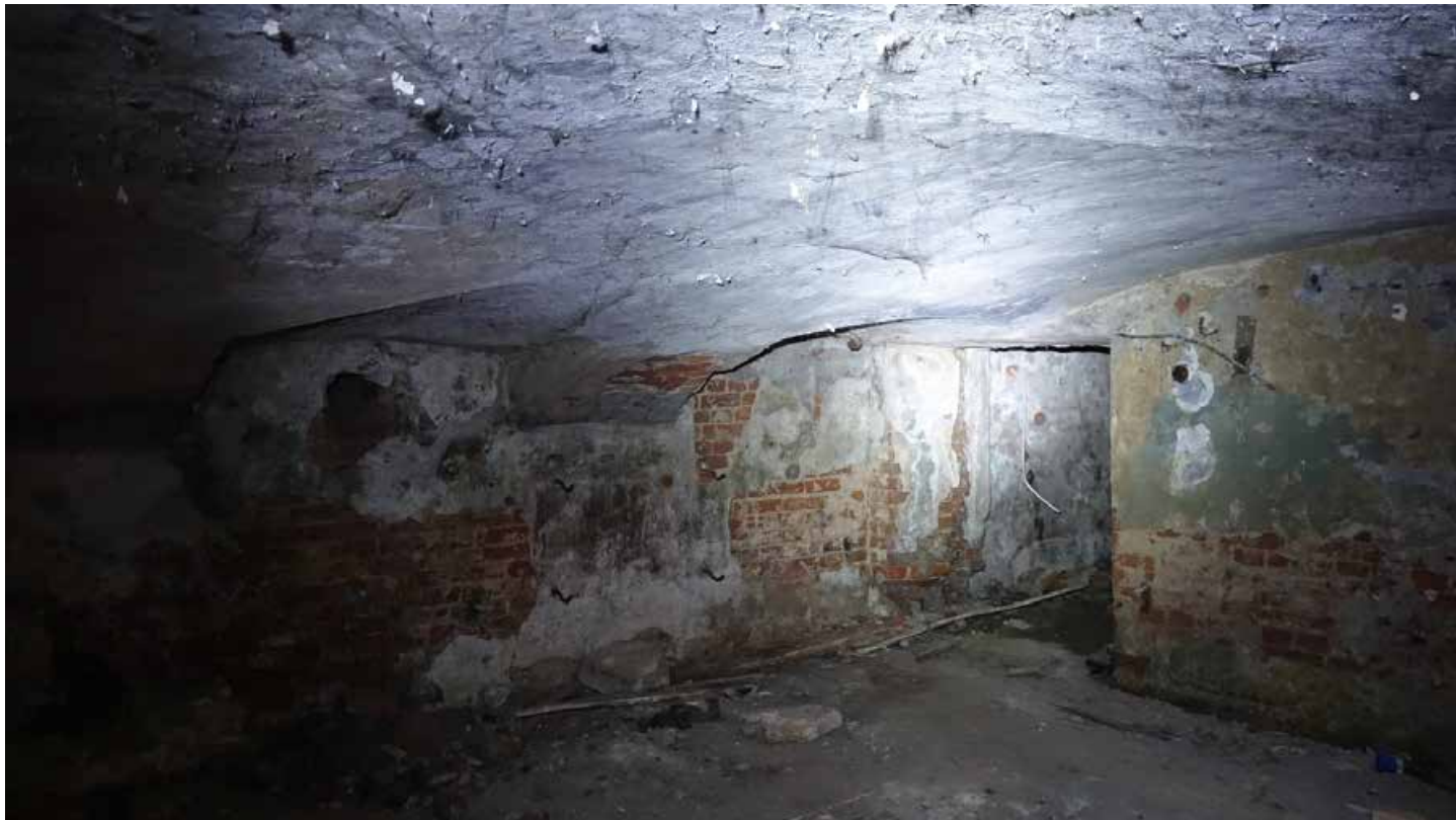
Фото 43. Помещение 8. Коробовый свод с распалубками. Фрагмент. Цокольный этаж. Дата фотофиксации: 01.03.24
