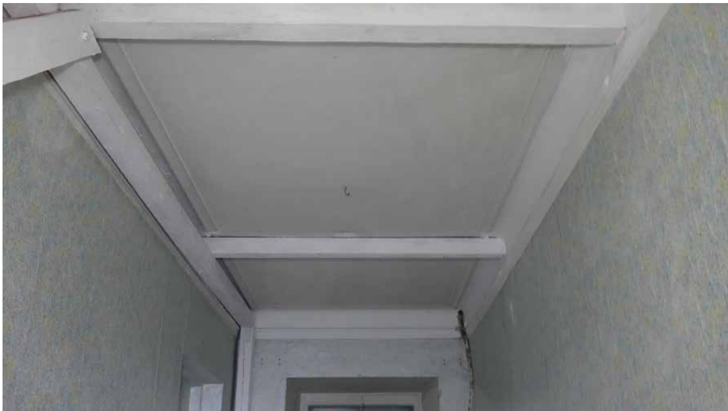
Фото 118. Помещение 41. Потолок. Первый этаж. Дата фотофиксации: 01.03.24
