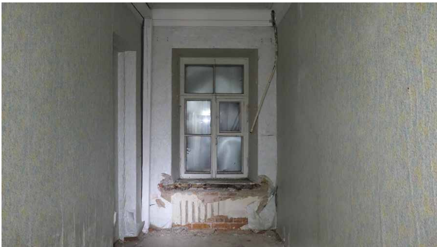
Фото 117. Помещение 41. Общий вид. Первый этаж. Дата фотофиксации: 01.03.24
