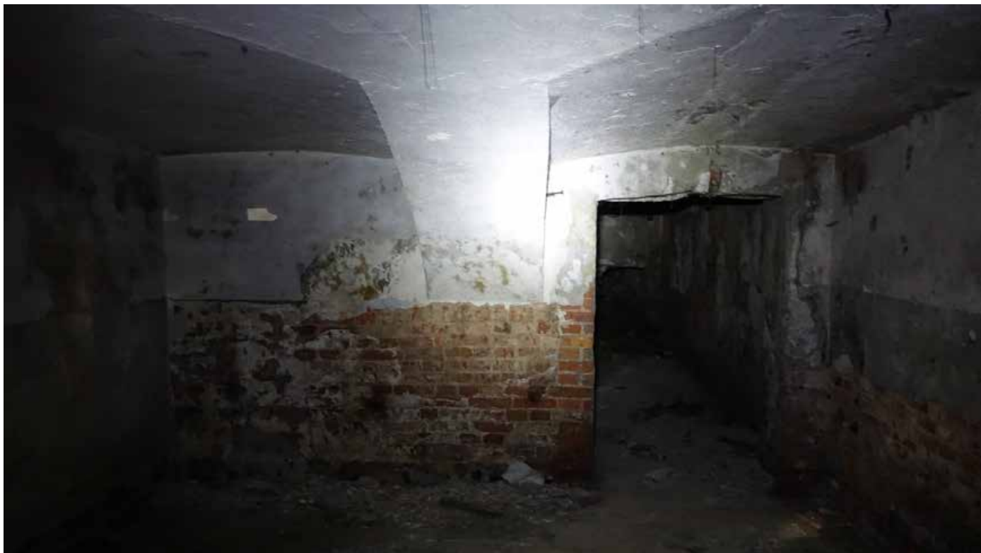
Фото 47. Помещение 5. Коробовый свод с распалубками. Фрагмент. Цокольный этаж. Дата фотофиксации: 01.03.24
