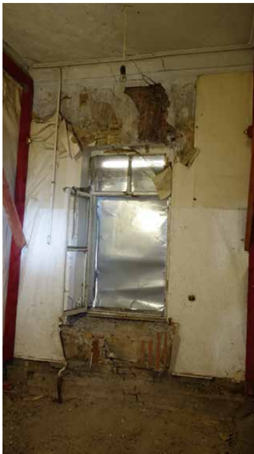
Фото 155. Помещение 64. Оконные заполнения. Второй этаж. Дата фотофиксации: 01.03.24
