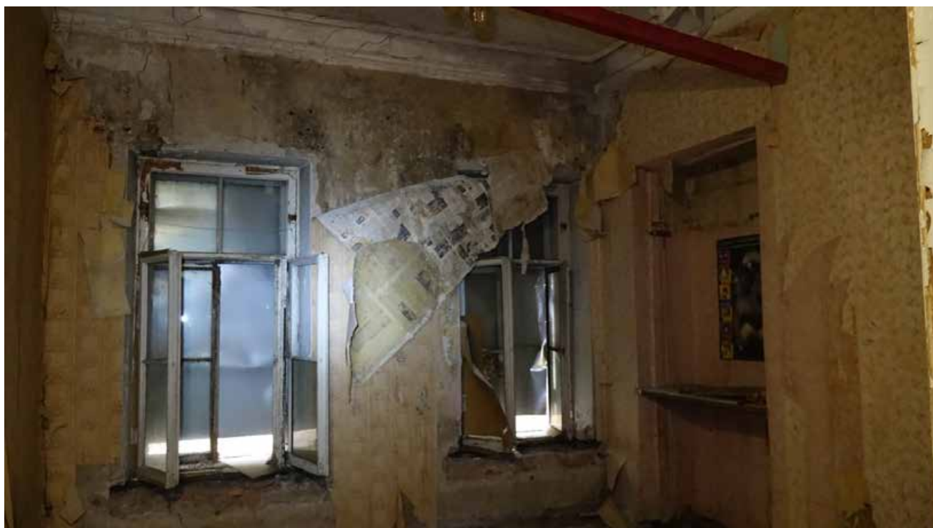
Фото 144. Помещение 62. Общий вид. Второй этаж. Дата фотофиксации: 01.03.24
