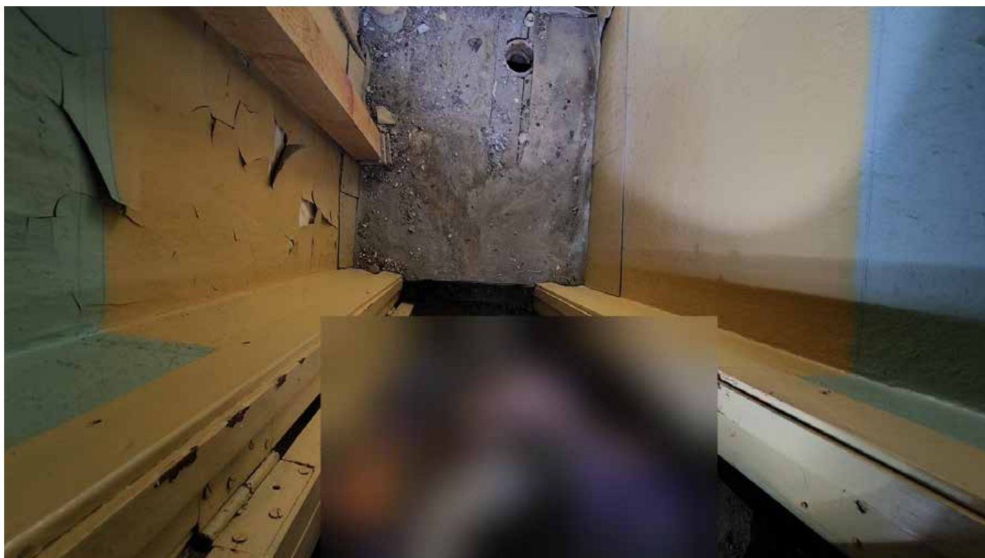
Фото 184. Помещение 93. Общий вид. Второй этаж. Дата фотофиксации: 01.03.24
