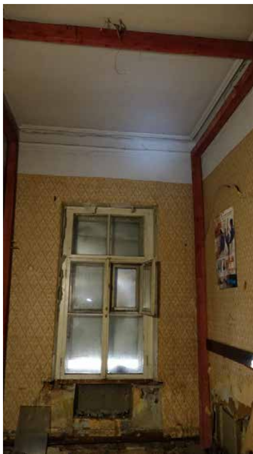
Фото 170. Помещение 77. Общий вид. Второй этаж. Дата фотофиксации: 01.03.24
