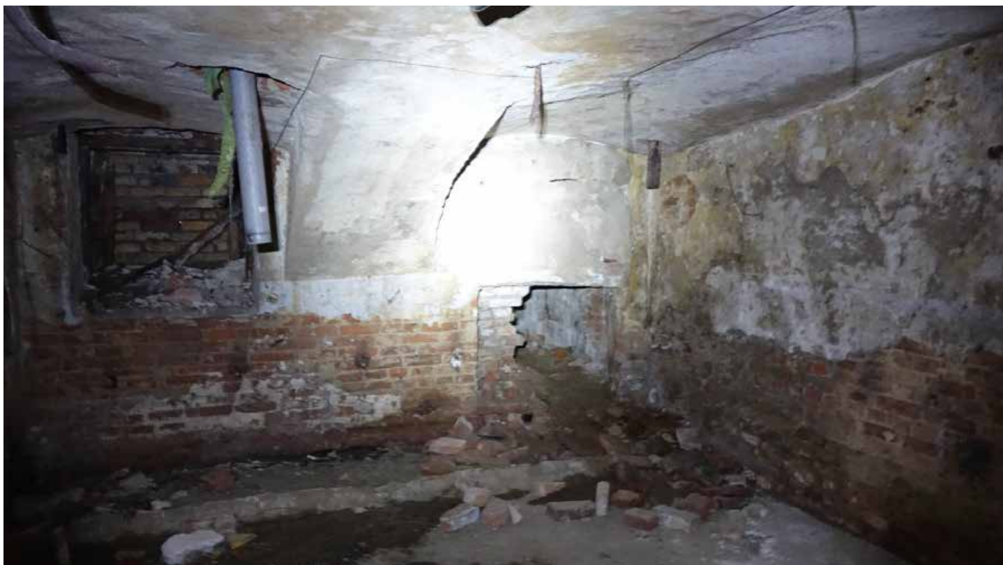
Фото 40. Помещение 6. Фрагмент стены, свода, заложный оконный проем. Цокольный этаж. Дата фотофиксации: 01.03.24
