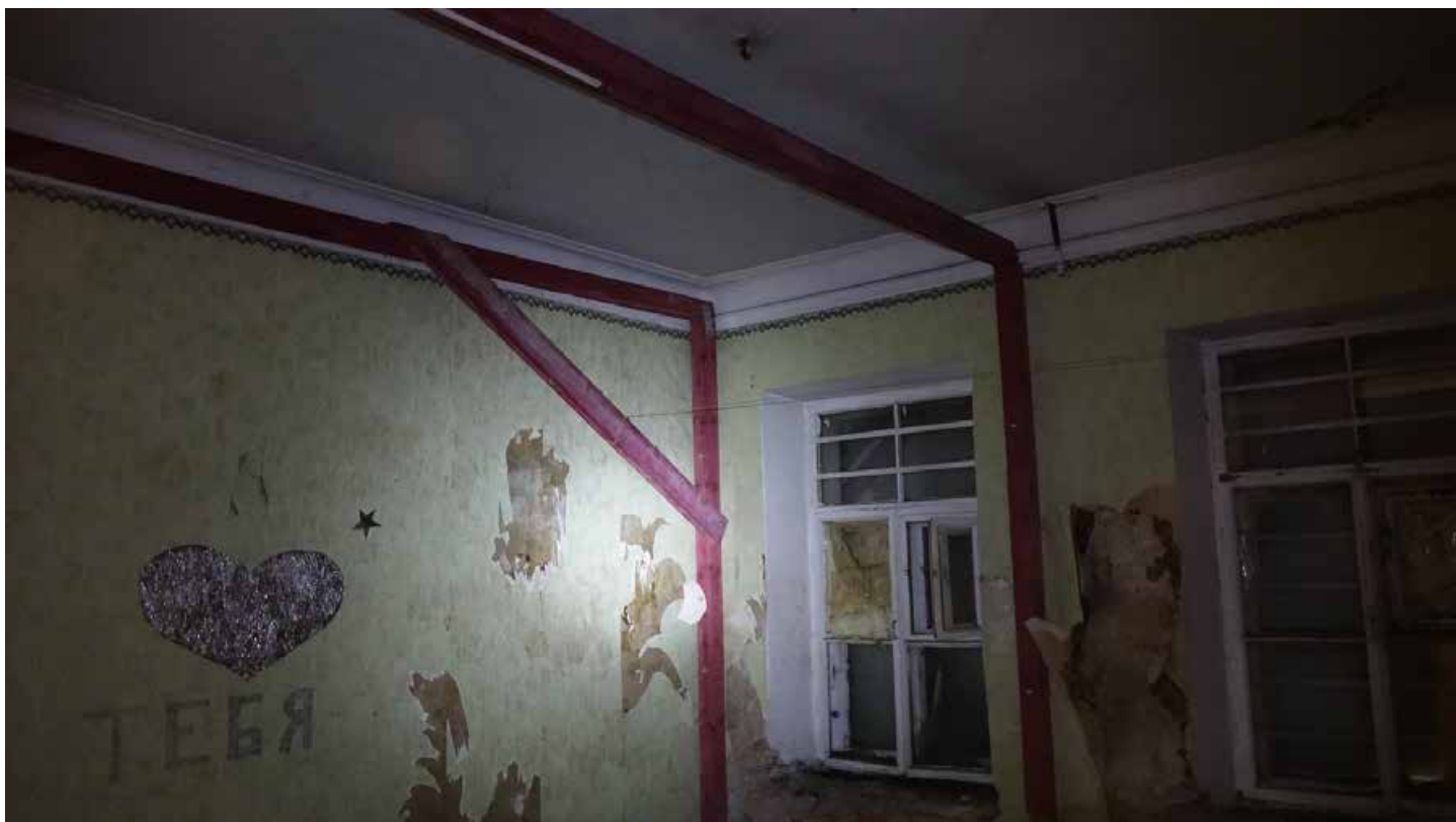
Фото 97. Помещение 11. Общий вид. Первый этаж. Дата фотофиксации: 01.03.24
