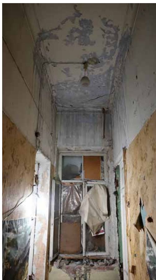
Фото 188. Помещение 90. Коридор. Второй этаж. Дата фотофиксации: 01.03.24
