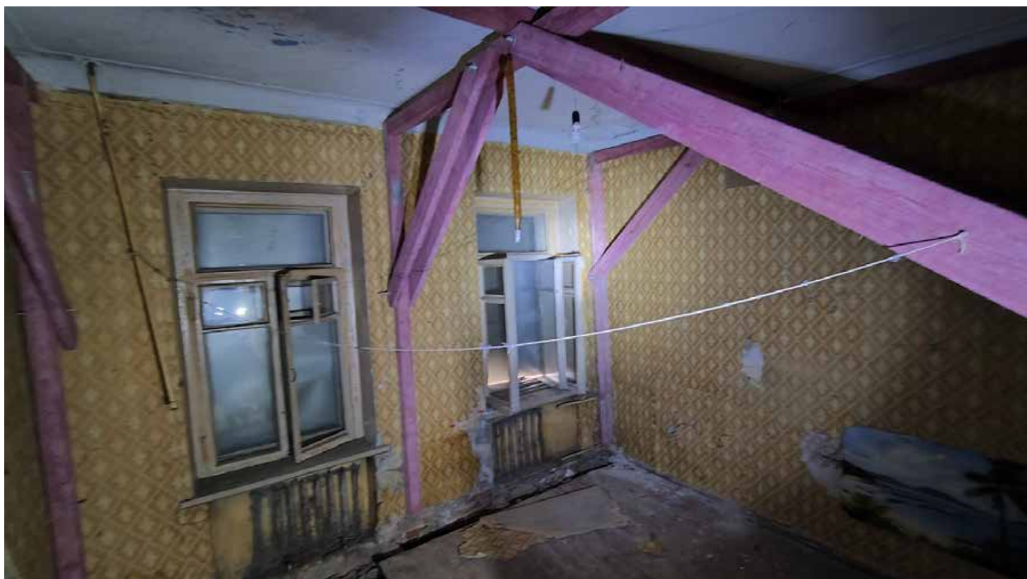
Фото 87. Помещение 21. Общий вид. Первый этаж. Дата фотофиксации: 01.03.24
