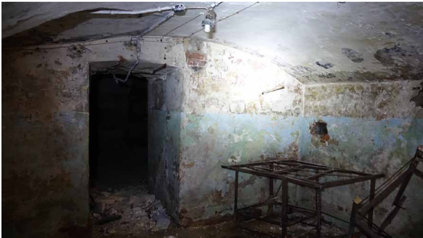
Фото 13. Помещение 154. Цилиндрический свод. Цокольный этаж. Дата фотофиксации: 01.03.24
