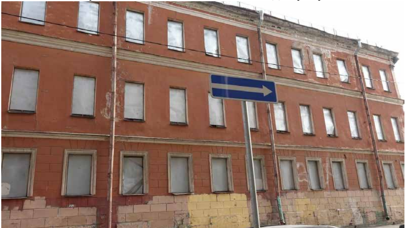
Фото 2. Западный фасад, фрагмент. Дата фотофиксации: 01.03.24
