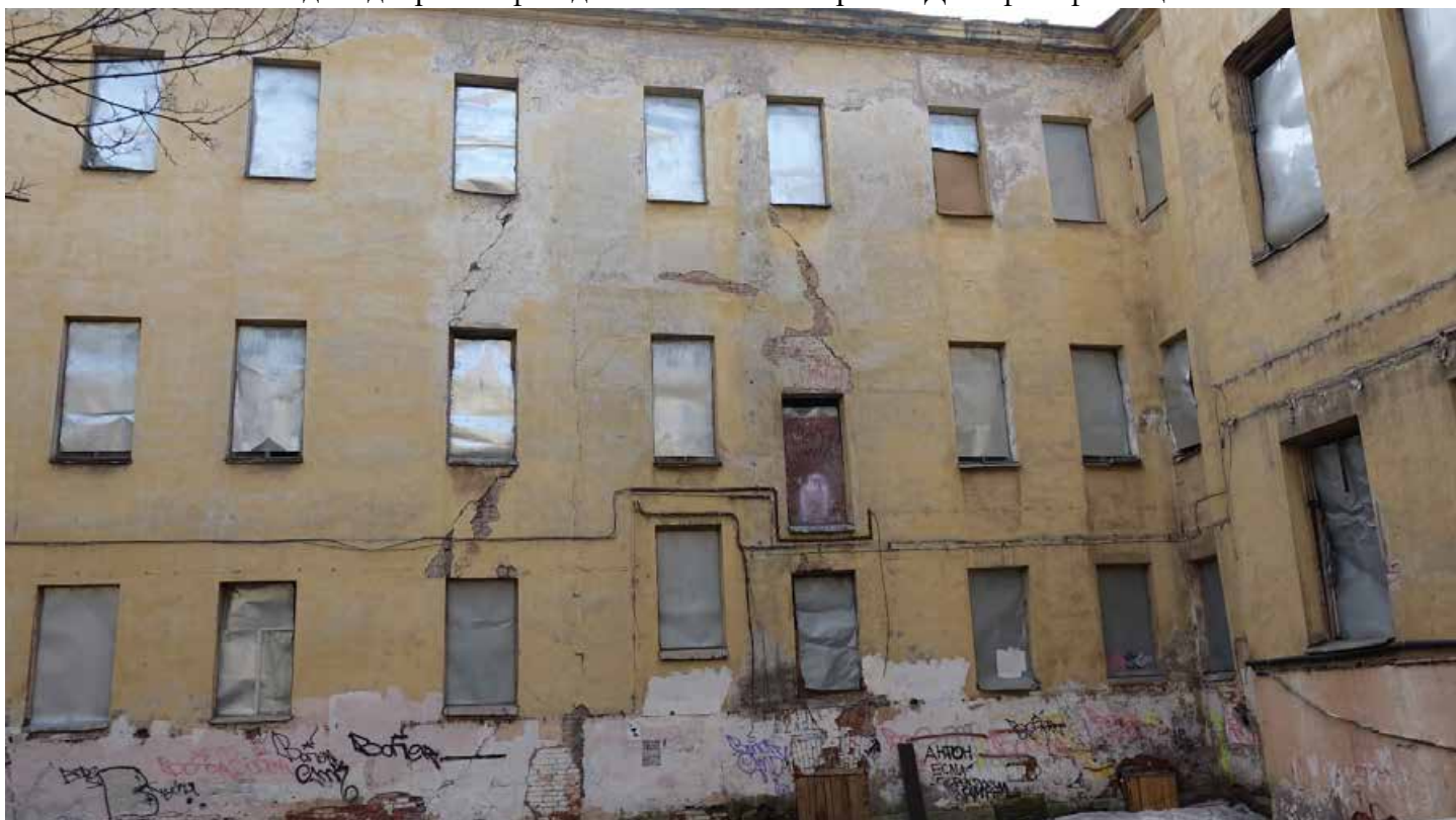
Фото 22. Дворовый фасад центрального объема. Фрагмент с заложенными оконными проемами и приемом по 3й световой оси. Дата фотофиксации: 01.03.24
