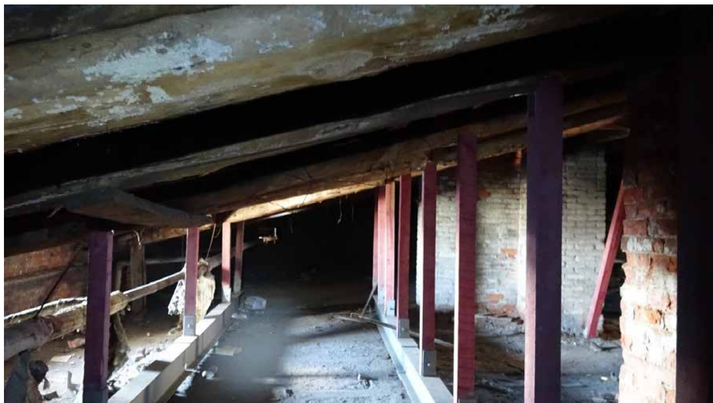
Фото 247. Мансарда. Основной объём. фрагмент. Дата фотофиксации: 01.03.24
