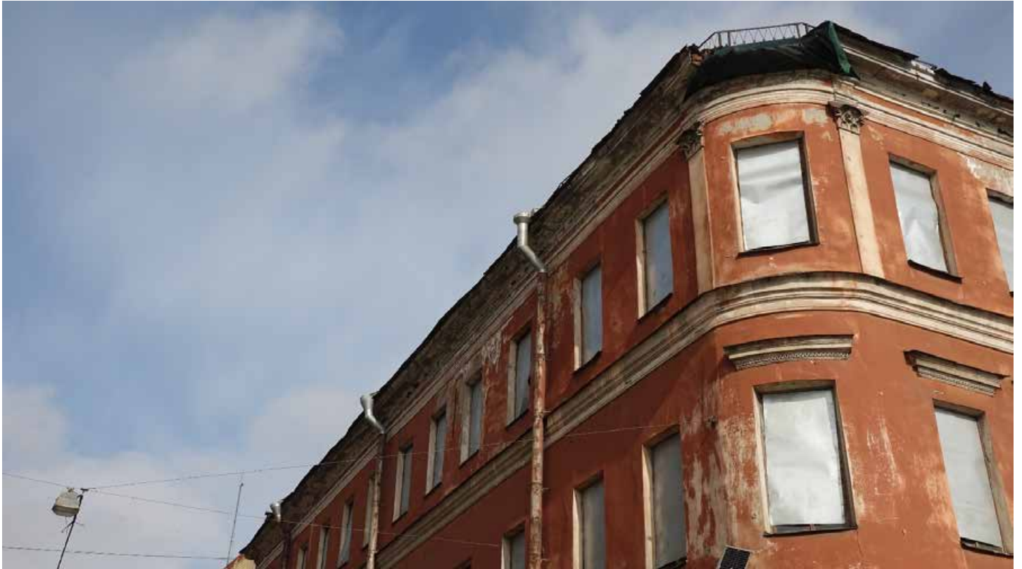
Фото 13. Профилированный штукатурный венчающий карниз большого выноса. Фрагмент. Дата фотофиксации: 01.03.24
