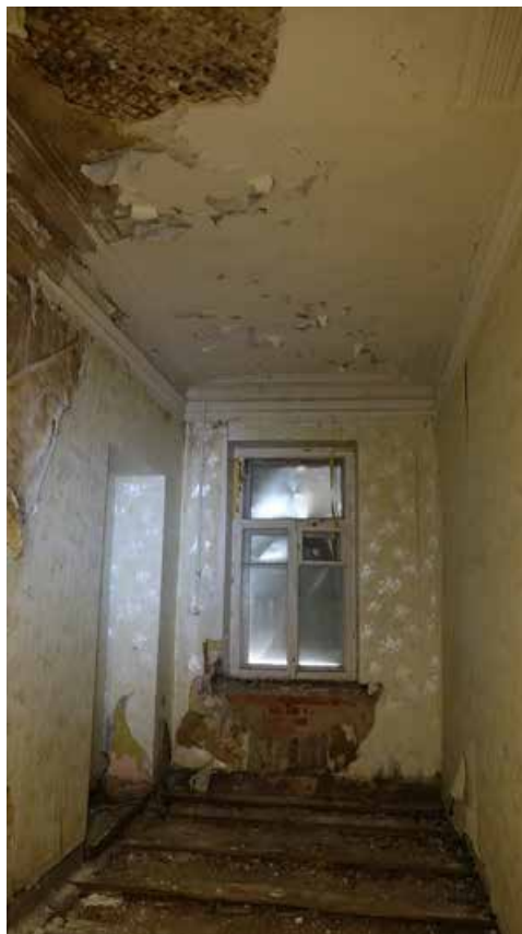
Фото 220. Помещение 126. Общий вид. Третий этаж. Дата фотофиксации: 01.03.24
