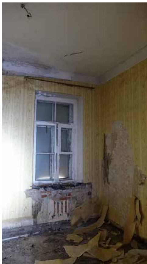
Фото 193. Помещение 100. Фрагмент. Третий этаж. Дата фотофиксации: 01.03.24
