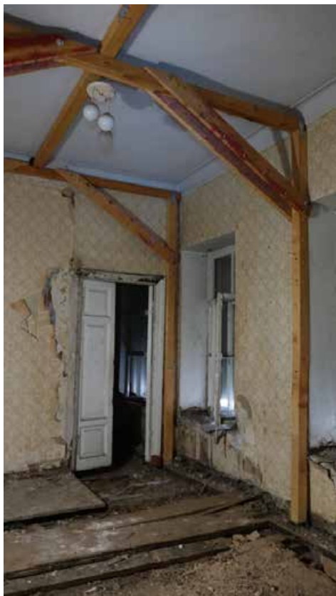
Фото 181. Помещение 87. Общий вид. Второй этаж. Дата фотофиксации: 01.03.24
