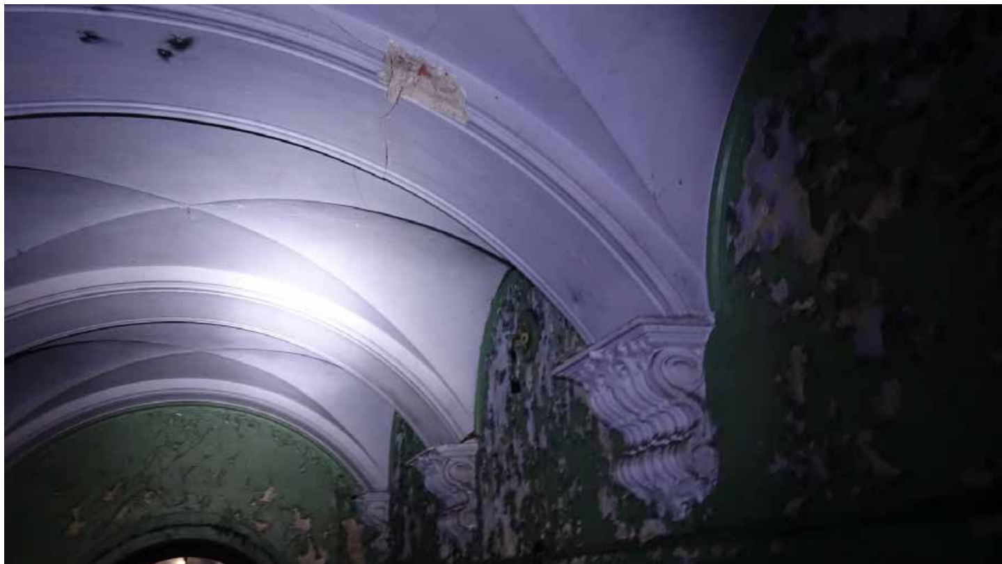
Фото 107. Помещение 1, парадный вестибюль, фрагмент. Своды, подпружные арки, волютообразные кронштейны. Первый этаж. Дата фотофиксации: 01.03.24
