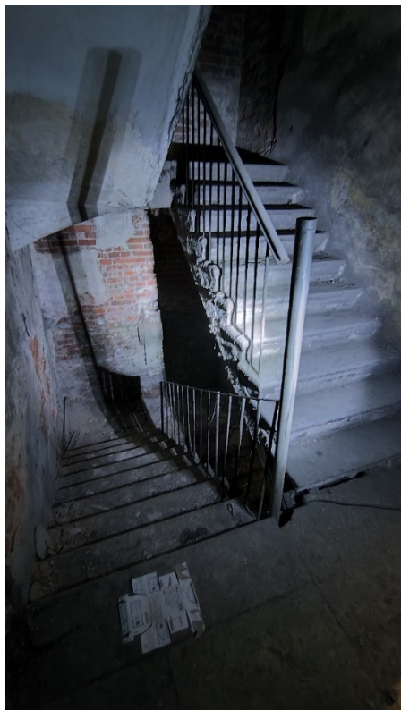
Фото 17. Служебная лестница ЛЗ. Фрагмент. Дата фотофиксации: 01.03.24
