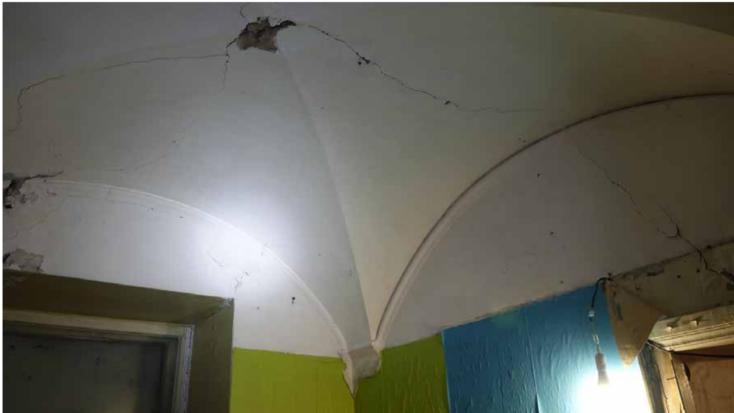
Фото 114. Помещение 36. Крестовый свод. Первый этаж. Дата фотофиксации: 01.03.24
