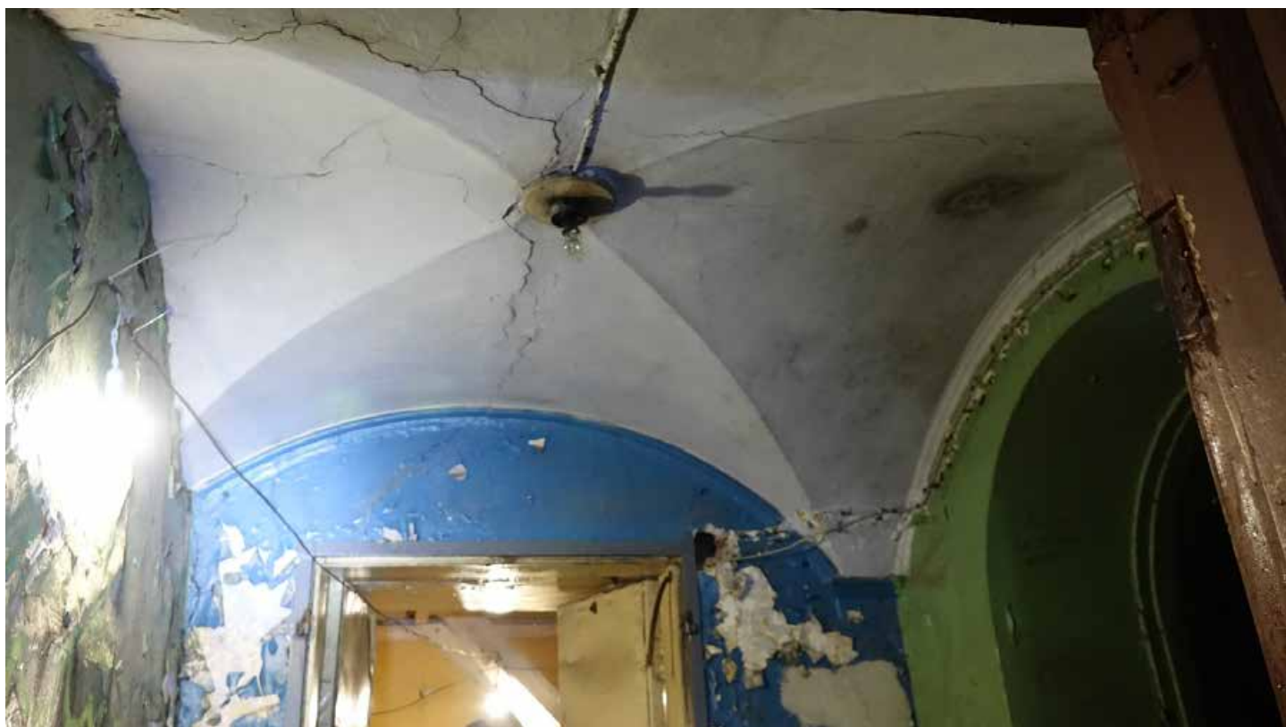
Фото 103. Помещение 2. Крестовый свод. Первый этаж. Дата фотофиксации: 01.03.24
