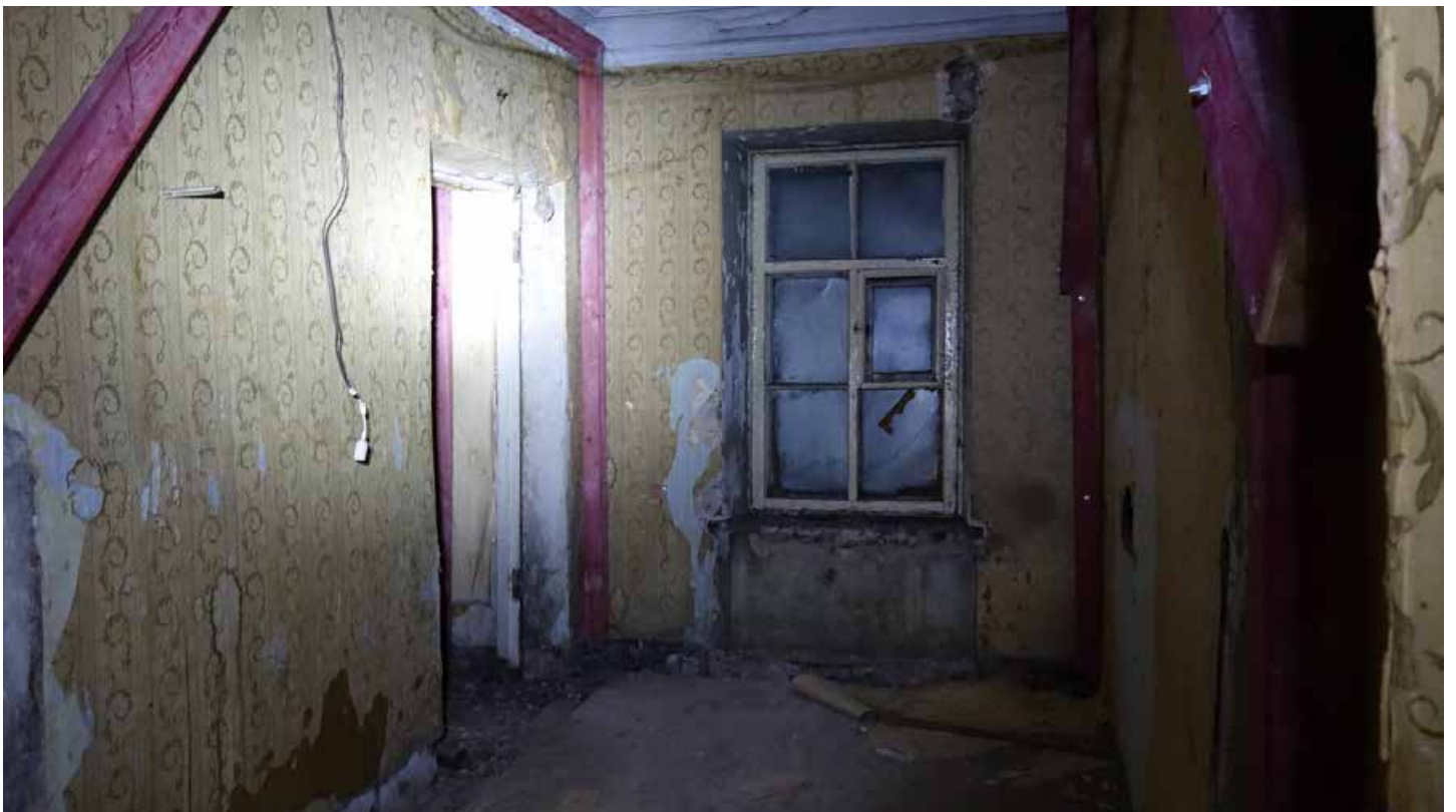
Фото 79. Помещение 18. Общий вид. Первый этаж. Дата фотофиксации: 01.03.24
