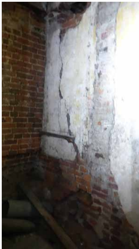
Фото 62. Помещение 26. Общий вид. Первый этаж. Дата фотофиксации: 01.03.24
