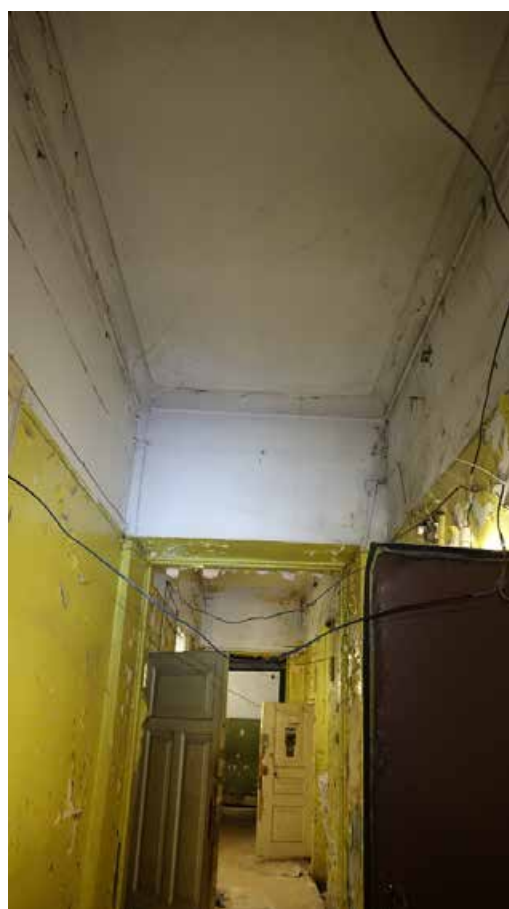
Фото 217. Помещение 124. Коридор. Третий этаж. Дата фотофиксации: 01.03.24
