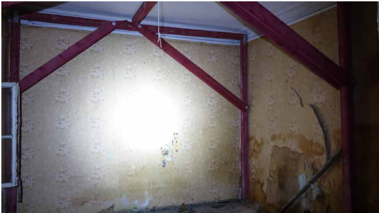
Фото 75. Помещение 24. Общий вид. Первый этаж. Дата фотофиксации: 01.03.24
