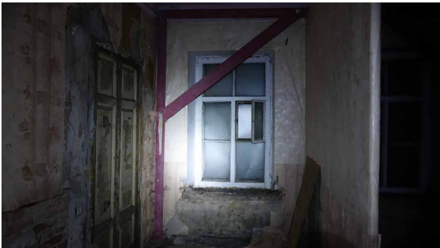
Фото 83. Помещение 20. Общий вид. Первый этаж. Дата фотофиксации: 01.03.24
