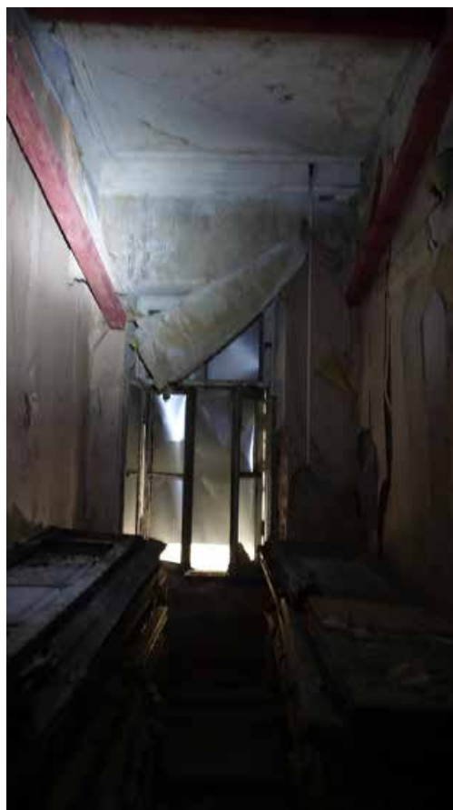
Фото 150. Помещение 61. Общий вид. Второй этаж. Дата фотофиксации: 01.03.24
