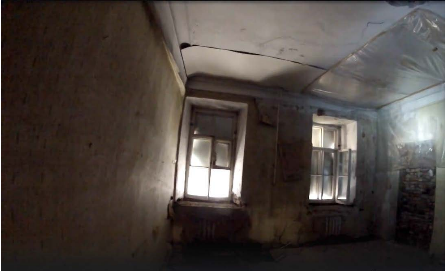
Фото 206. Помещение 114. Общий вид. Третий этаж. Дата фотофиксации: 01.03.24
