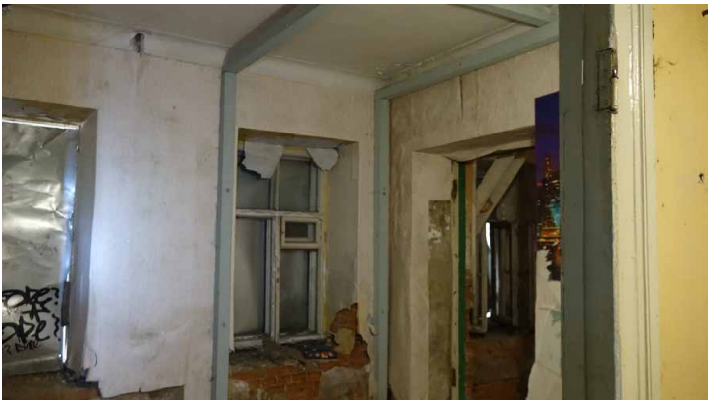
Фото 113. Помещение 37. Общий вид. Первый этаж. Дата фотофиксации: 01.03.24
