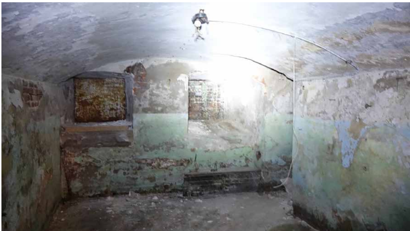
Фото 6. Помещение 152. Цилиндрический свод. Цокольный этаж. Вид на цокольные окна. Дата фотофиксации: 01.03.24
