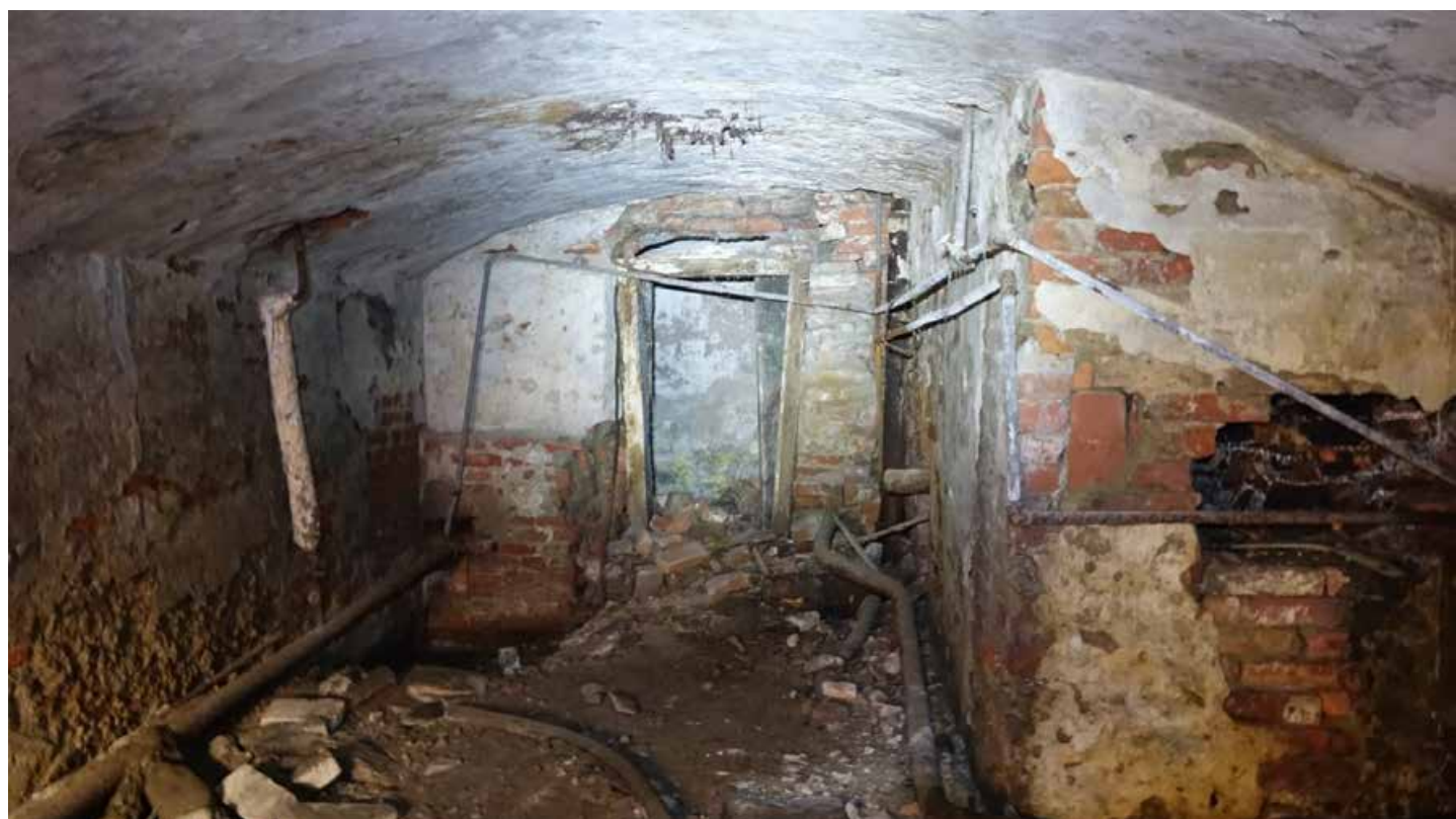
Фото 20. Помещение 158. Цилиндрический свод. Цокольный этаж. Дата фотофиксации: 01.03.24
