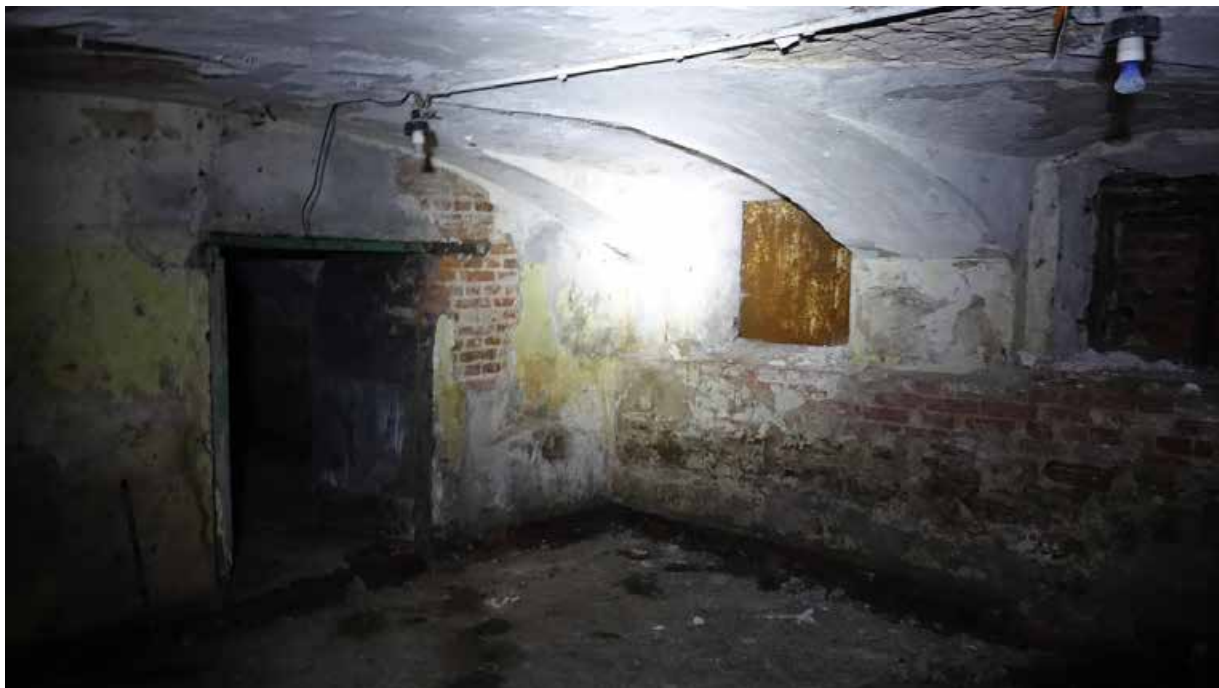
Фото 17. Помещение 150. Вид на заложенные оконные проемы цокольного этажа. Цокольный этаж. Дата фотофиксации: 01.03.24
