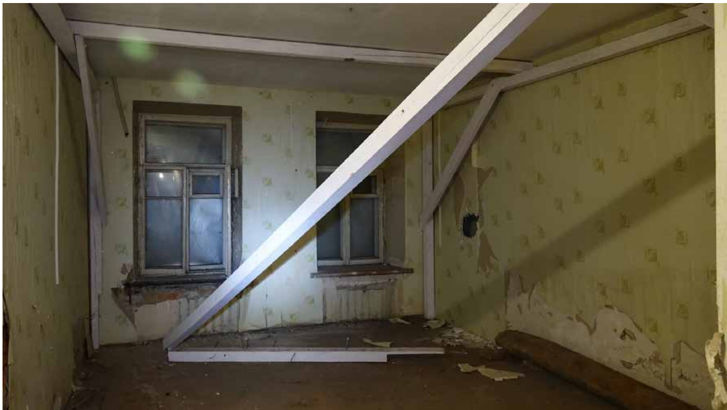
Фото 122. Помещение 42. Общий вид. Первый этаж. Дата фотофиксации: 01.03.24
