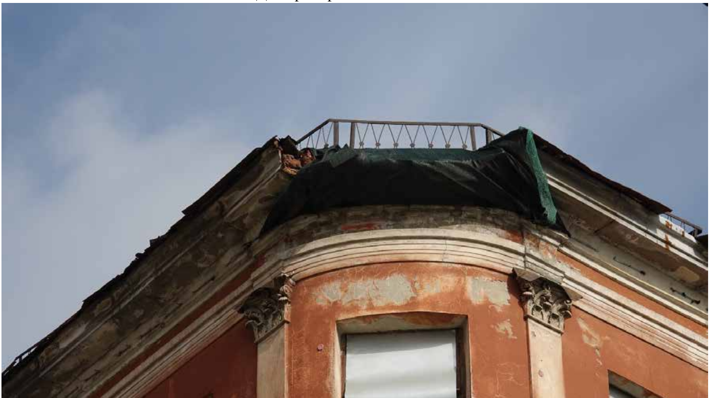
Фото 14. Фрагмент углового объема с карнизом Дата фотофиксации: 01.03.24
