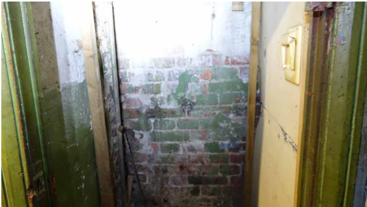
Фото 64. Помещение 32. Общий вид. Первый этаж. Дата фотофиксации: 01.03.24
