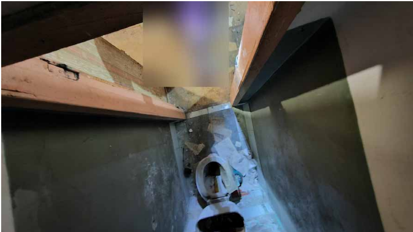
Фото 100. Помещение 6. Общий вид. Первый этаж. Дата фотофиксации: 01.03.24
