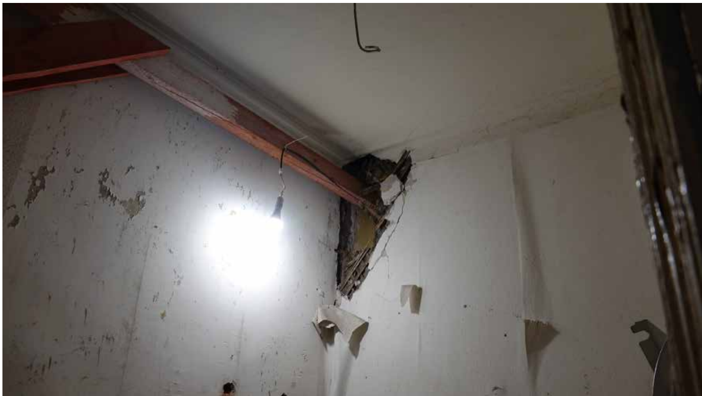
Фото 128. Помещение 46. Потолок, следы деструкции. Первый этаж. Дата фотофиксации: 01.03.24
