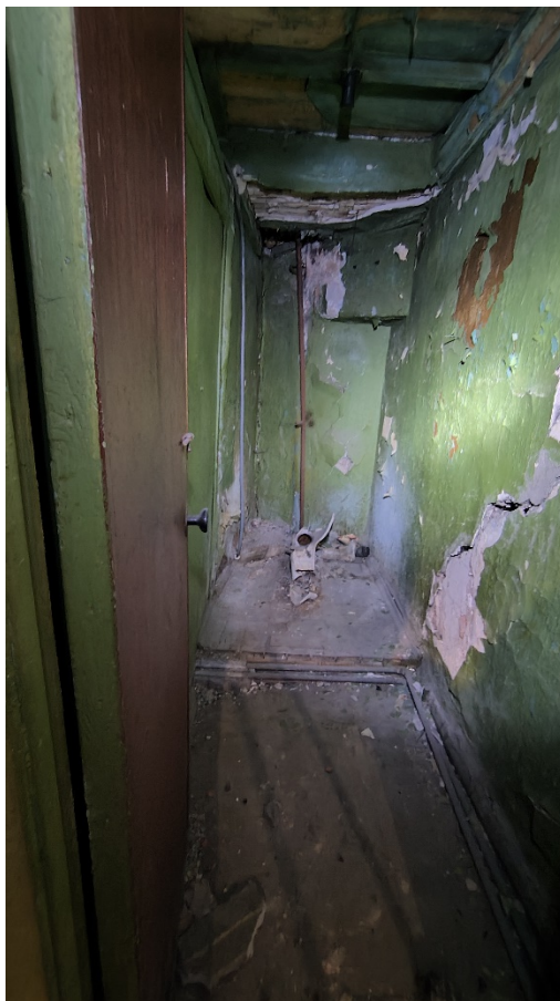
Фото 175. Помещение 82. Общий вид. Второй этаж. Дата фотофиксации: 01.03.24
