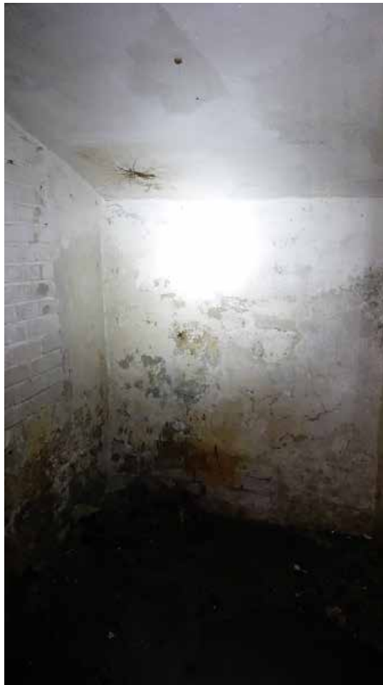
Фото 3. Помещение 155. Цокольный этаж. Дата фотофиксации: 01.03.24
