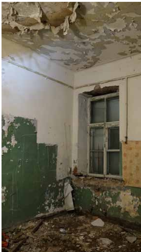
Фото 240. Помещение 139. Фрагмент. Третий этаж. Дата фотофиксации: 01.03.24
