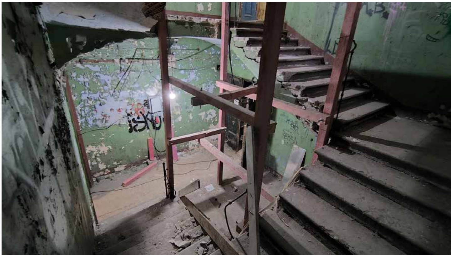
Фото 3. Лестница Л1. Межэтажная площадка. Дата фотофиксации: 01.03.24
