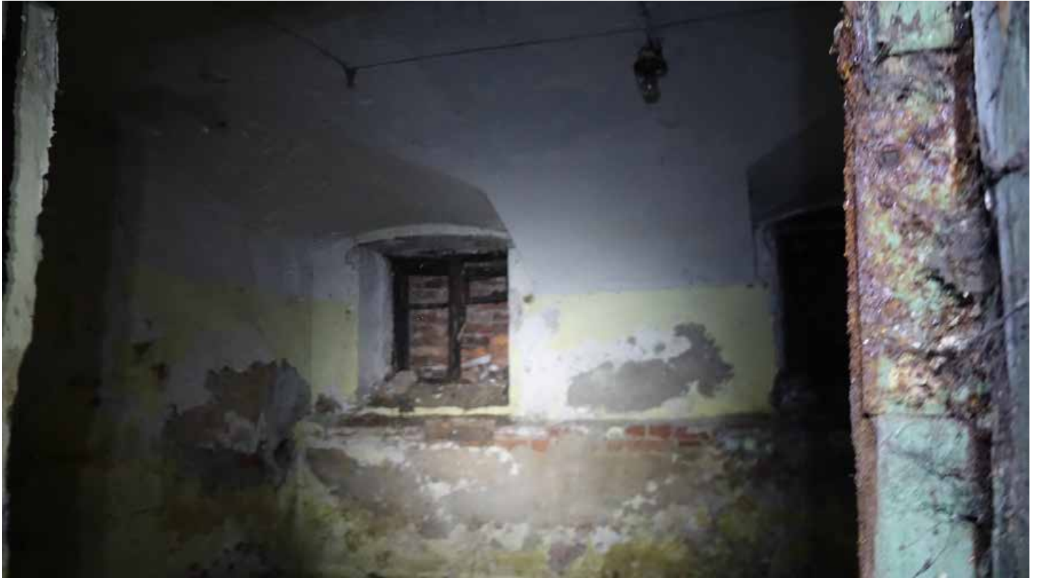
Фото 25. Помещение 145. Вид на оконные проемы цокольного этажа в распалубках. Дата фотофиксации: 01.03.24
