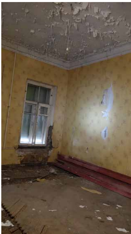
Фото 158. Помещение 67. Общий вид. Второй этаж. Дата фотофиксации: 01.03.24
