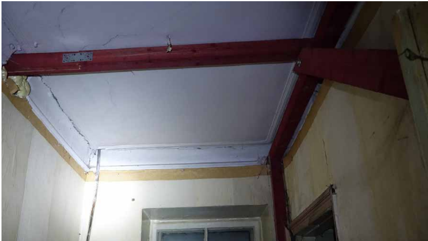
Фото 74. Помещение 23. Фрагмент. Первый этаж. Дата фотофиксации: 01.03.24
