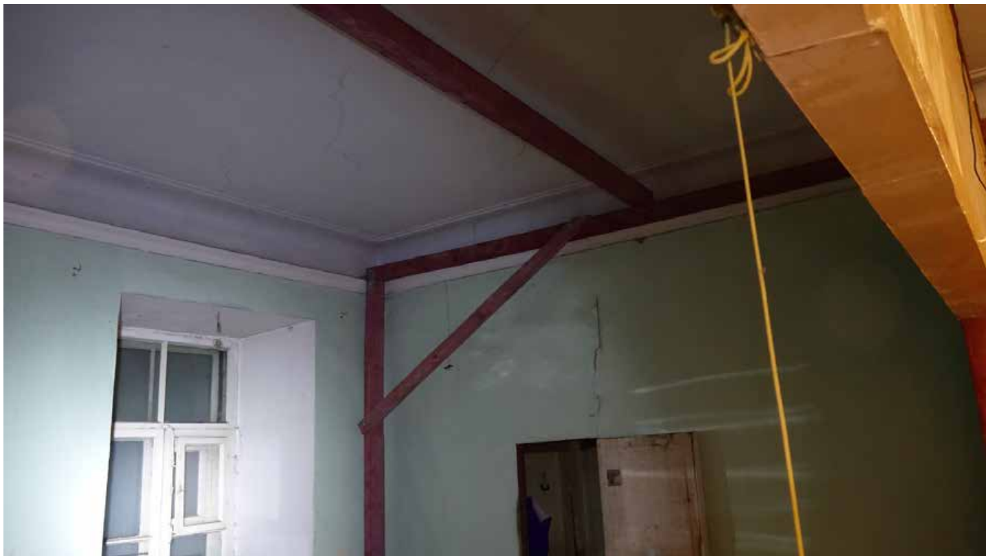
Фото 94. Помещение 14. Падуга и профилированный карниз советского времени. Первый этаж. Дата фотофиксации: 01.03.24
