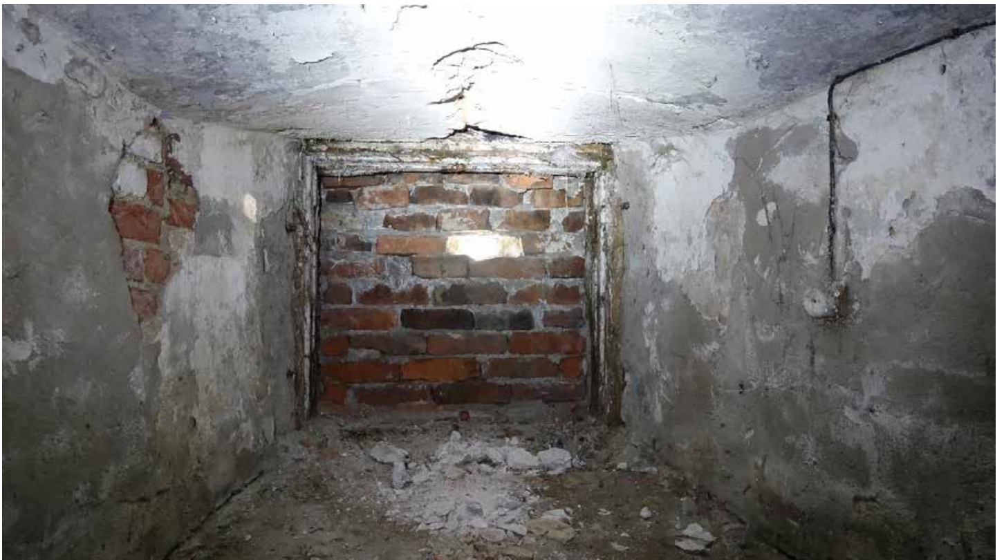
Фото 10. Помещение 151. Цокольный этаж. Вид на заложённый оконный проем цокольного этажа. Дата фотофиксации: 01.03.24
