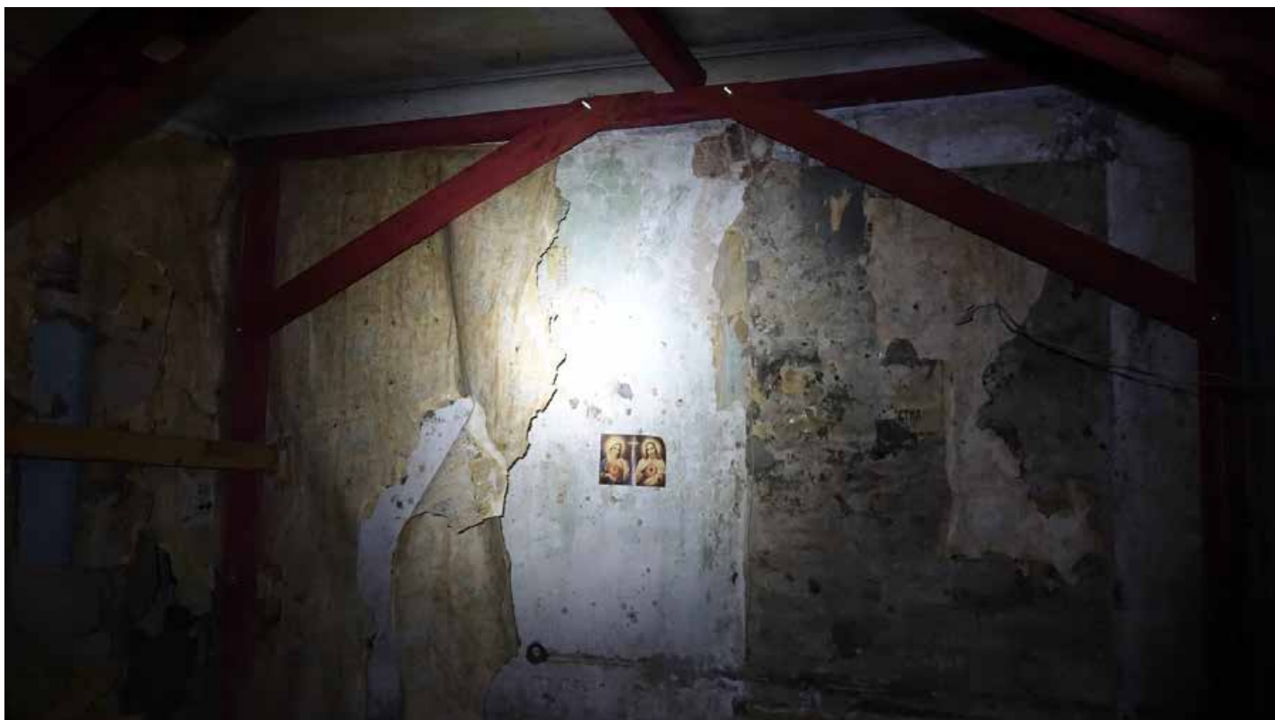
Фото 65. Помещение 33. Общий вид. Первый этаж. Дата фотофиксации: 01.03.24
