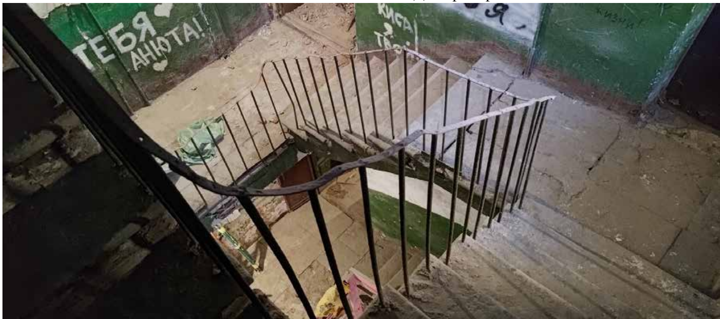
Фото 14. Лестница Л4. Площадка 2-го этажа. Дата фотофиксации: 01.03.24
