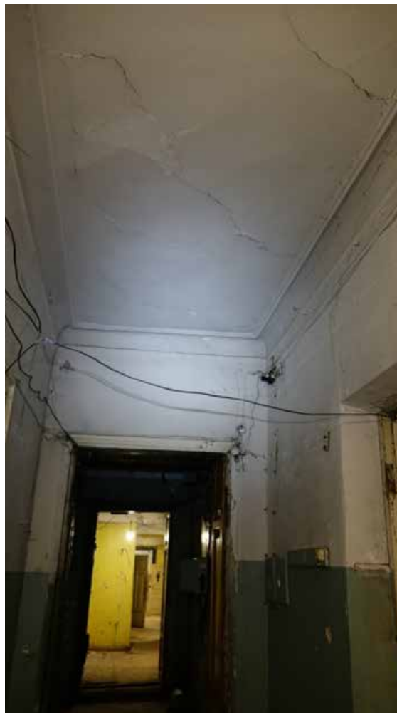
Фото 207. Помещение 113. Коридор. Третий этаж. Дата фотофиксации: 01.03.24
