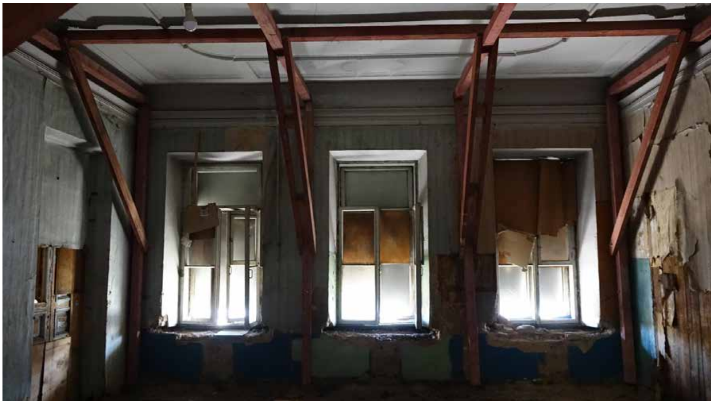
Фото 147. Помещение 58. Общий вид. Второй этаж. Дата фотофиксации: 01.03.24
