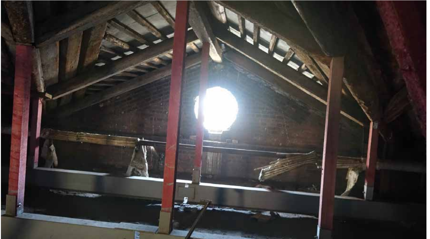
Фото 248. Окно люкарна во фронтоне. Мансарда. Дата фотофиксации: 01.03.24
