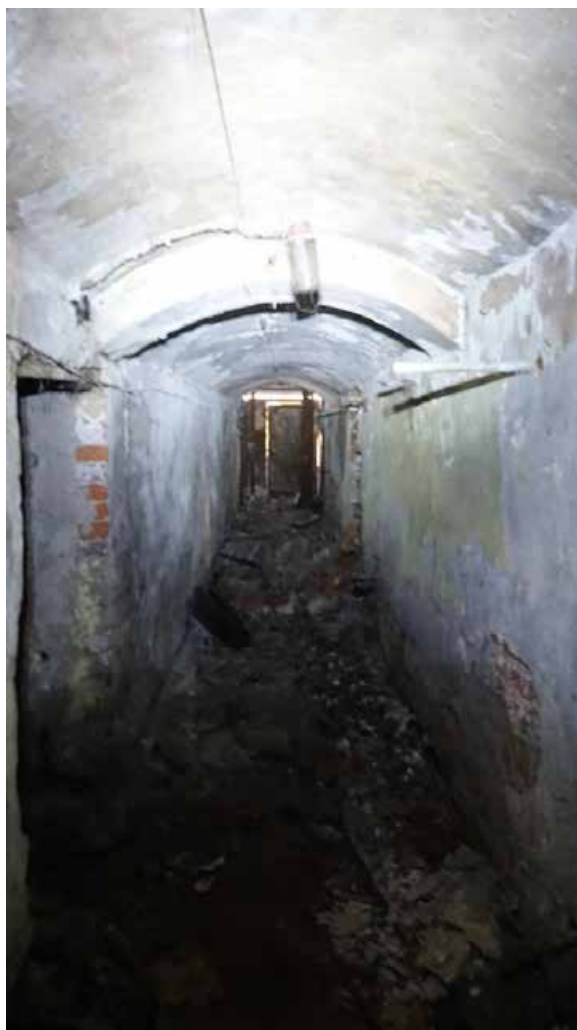
Фото 24. Помещение 144. Цилиндрический свод с подпругной аркой. Цокольный этаж. Дата фотофиксации: 01.03.24
