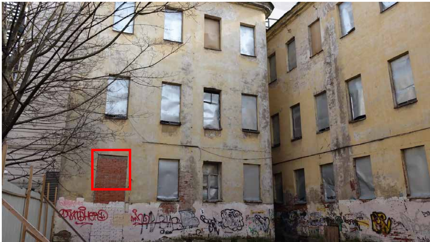
Фото 25. Оконные заполнения восточного фасада с защитными конструкциями.
