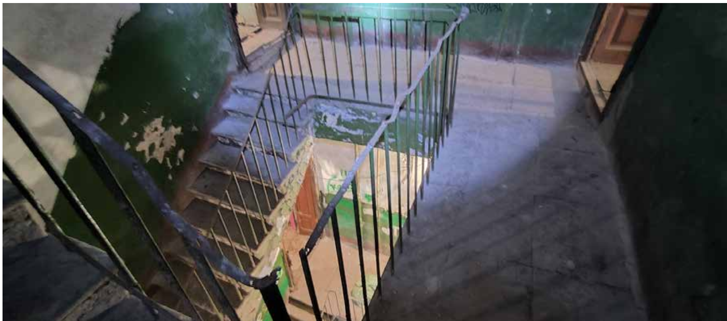
Фото 13. Лестница Л4. Площадка 3-го этажа. Дата фотофиксации: 01.03.24
