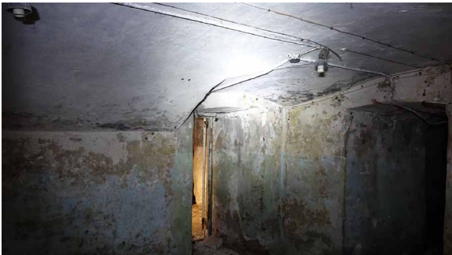
Фото 14. Помещение 154. Фрагмент коробового свода с распалубками. Цокольный этаж. Дата фотофиксации: 01.03.24
