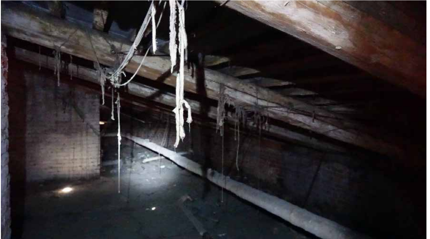
Фото 252. Мансарда. Фрагмент. Дата фотофиксации: 01.03.24
