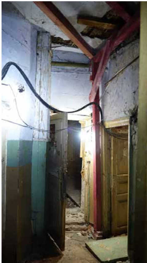
Фото 86. Помещение 17. Общий вид. Первый этаж. Дата фотофиксации: 01.03.24
