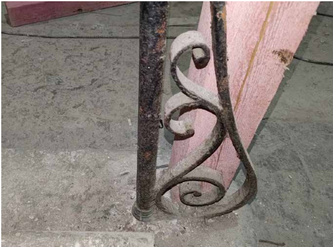
Фото 9. Лестница Л1. Волутообразный кронштейн в основании лестницы. Дата фотофиксации: 01.03.24
