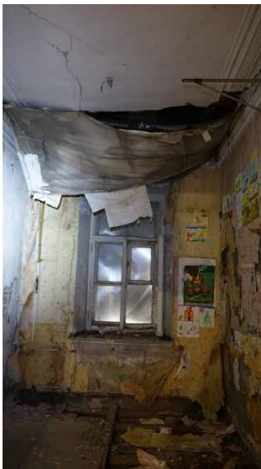
Фото 215. Помещение 123. Общий вид. Третий этаж. Дата фотофиксации: 01.03.24
