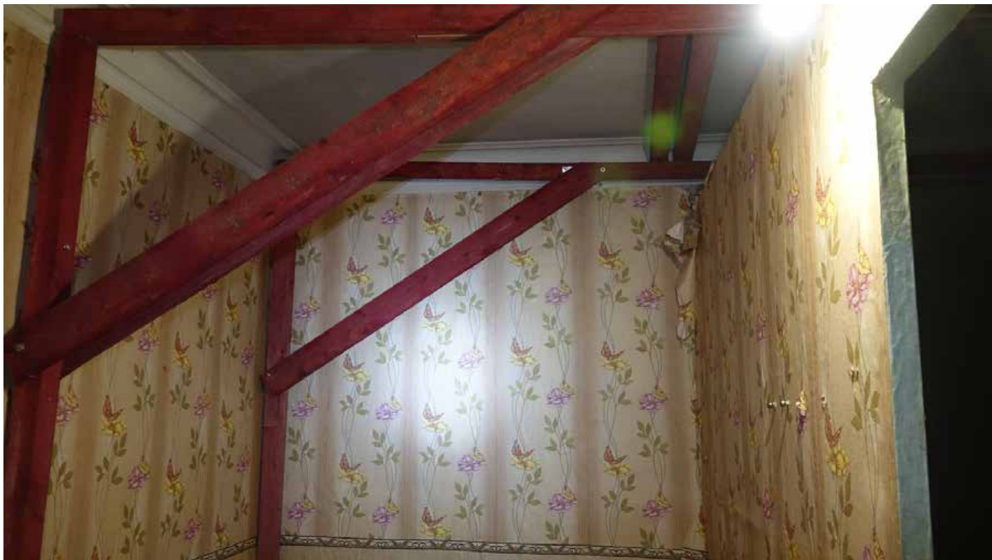
Фото 96. Помещение 10. Падуга и профилированный карниз советского времени. Первый этаж. Дата фотофиксации: 01.03.24
