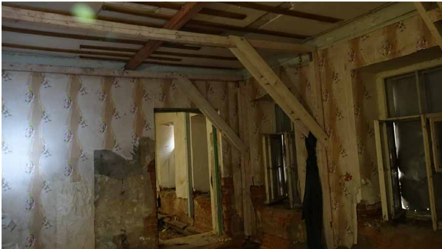
Фото 119. Помещение 38. Общий вид. Первый этаж. Дата фотофиксации: 01.03.24
