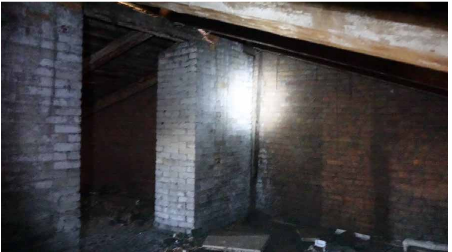
Фото 249. Кирпичные дымоходы, разделяющие основной объём мансарды. Общий вид. Дата фотофиксации: 01.03.24
