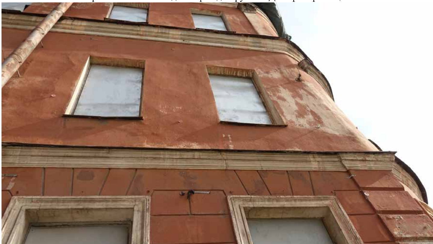
Фото 16. Западный фасад. Фрагмент. Профилированные междуэтажные карнизы.
