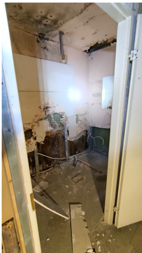
Фото 138. Помещение 53. Общий вид. Второй этаж. Дата фотофиксации: 01.03.24
