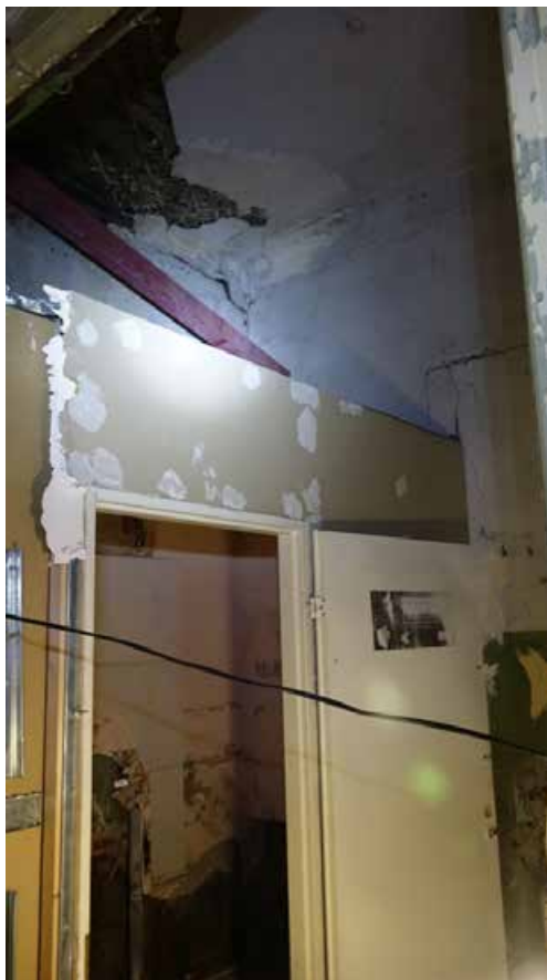
Фото 137. Помещение 52. Общий вид. Второй этаж. Дата фотофиксации: 01.03.24
