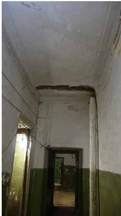
Фото 234. Помещение 128.Коридор. Третий этаж. Дата фотофиксации: 01.03.24
