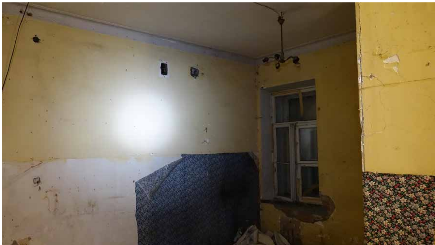
Фото 127. Помещение 45. Вентиляционные отверстия. Первый этаж. Дата фотофиксации: 01.03.24
