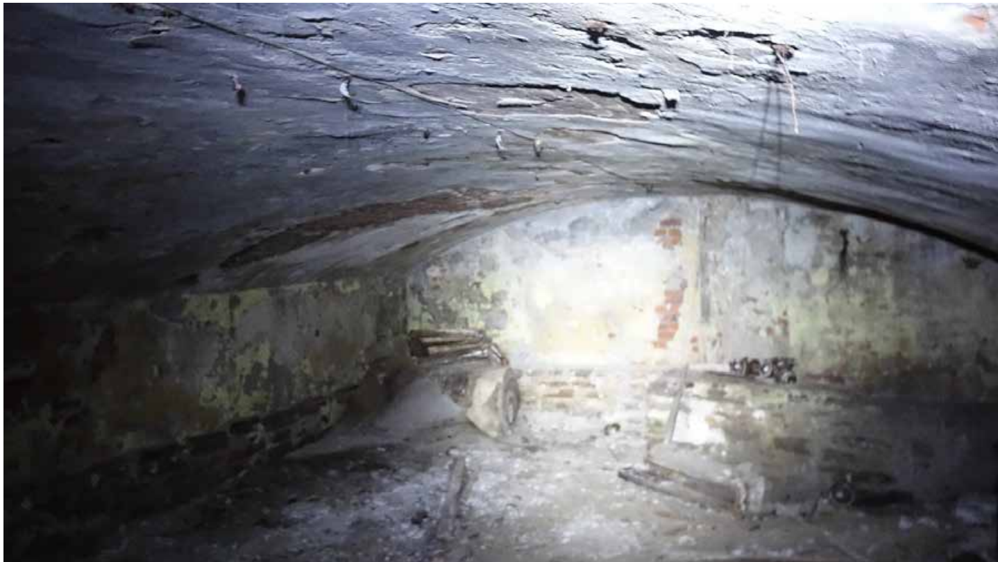
Фото 31. Помещение 147. Цилиндрический свод. Цокольный этаж. Дата фотофиксации: 01.03.24
