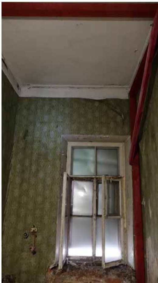
Фото 177. Помещение 83. Оконные заполнения. Второй этаж. Дата фотофиксации: 01.03.24
