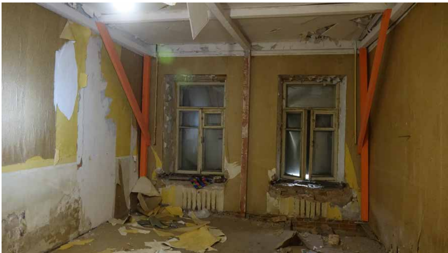
Фото 115. Помещение 39. Общий вид. Первый этаж. Дата фотофиксации: 01.03.24
