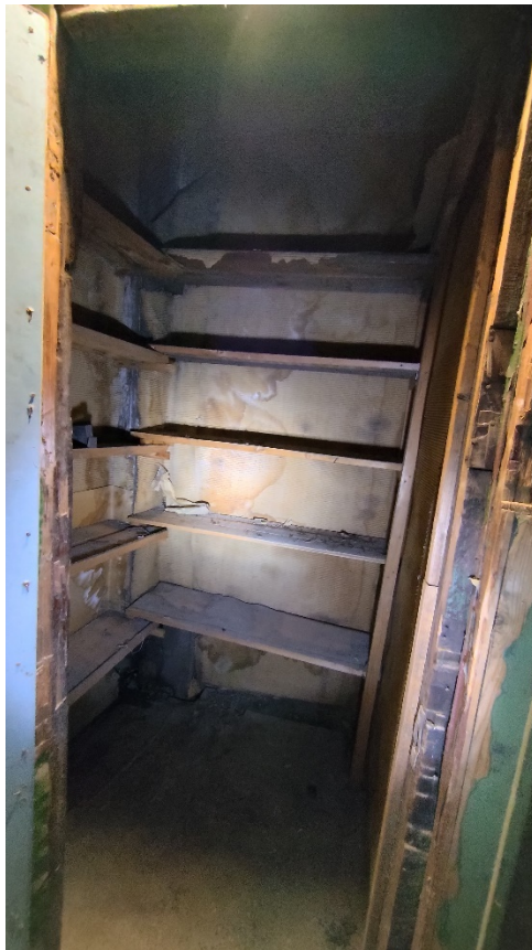
Фото 242. Помещение 8. Общий вид. Третий этаж. Дата фотофиксации: 01.03.24
