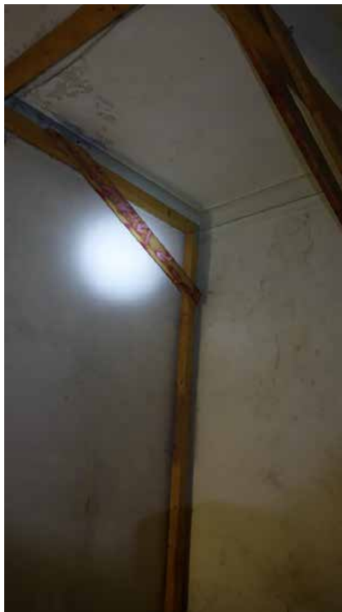
Фото 187. Помещение 95. Фрагмент. Второй этаж. Дата фотофиксации: 01.03.24
