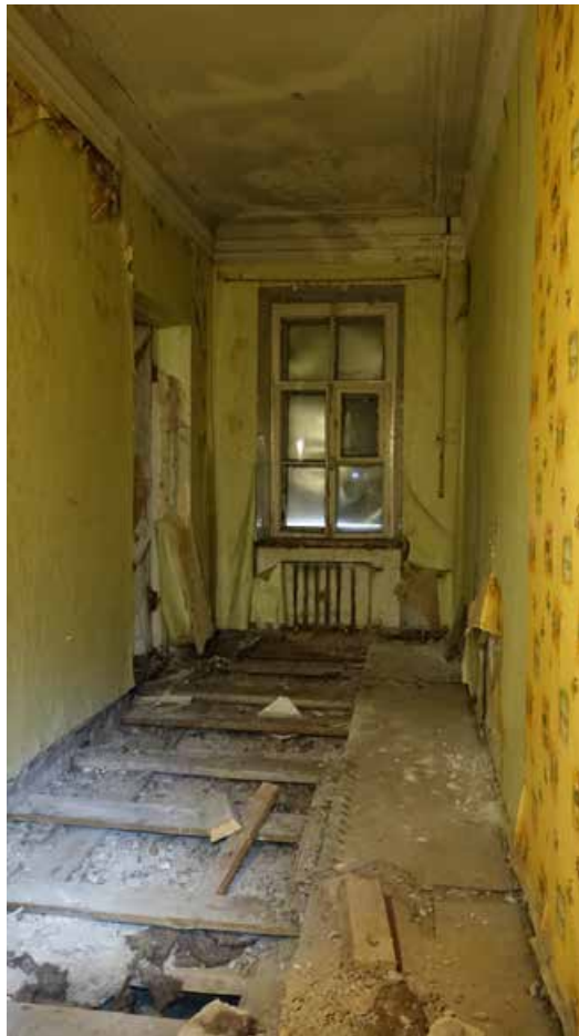
Фото 228. Помещение 132. Общий вид. Третий этаж. Дата фотофиксации: 01.03.24
