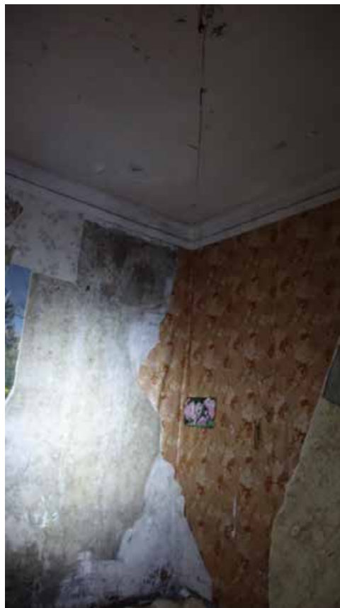
Фото 195. Помещение 102. Фрагмент. Третий этаж. Дата фотофиксации: 01.03.24
