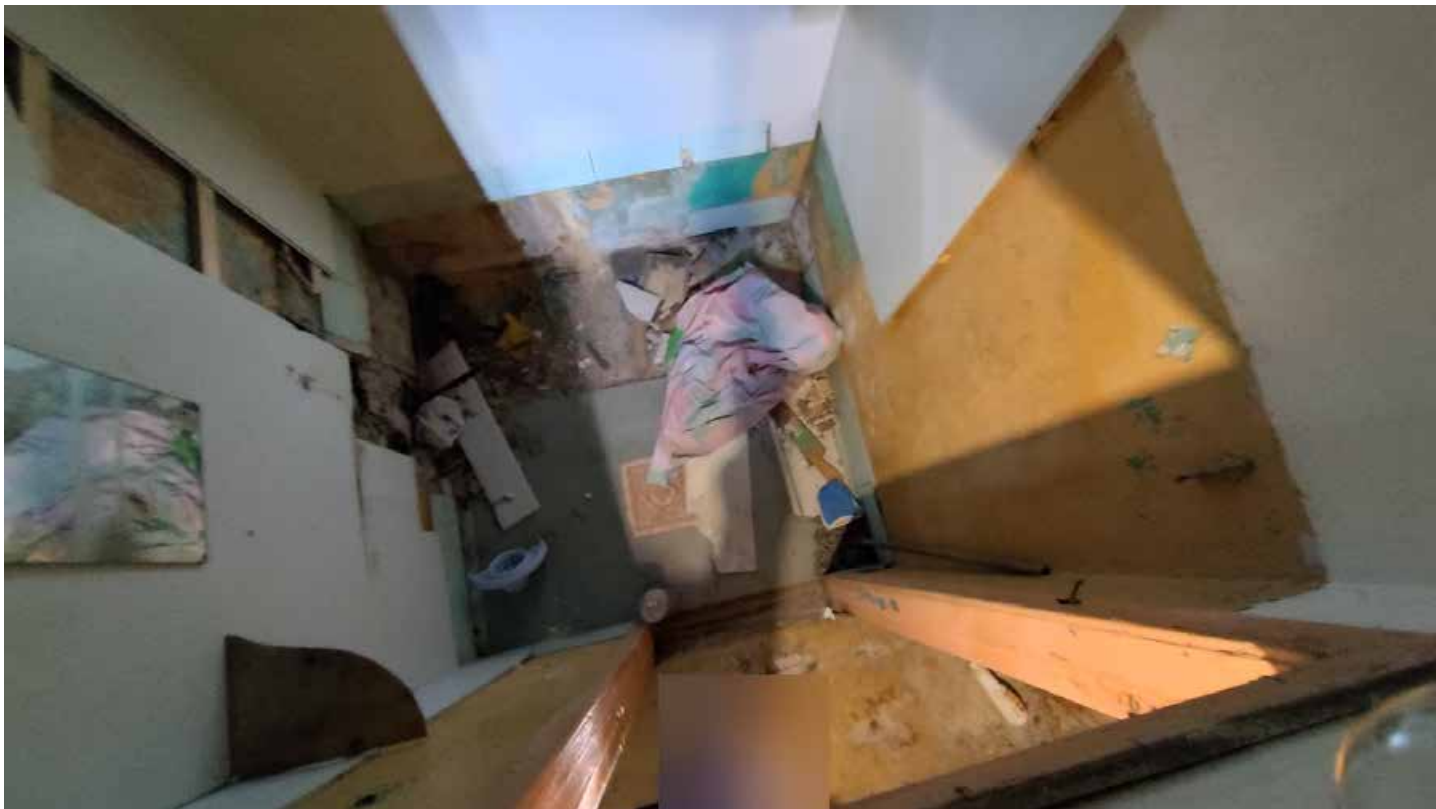
Фото 101. Помещение 7. Общий вид. Первый этаж. Дата фотофиксации: 01.03.24
