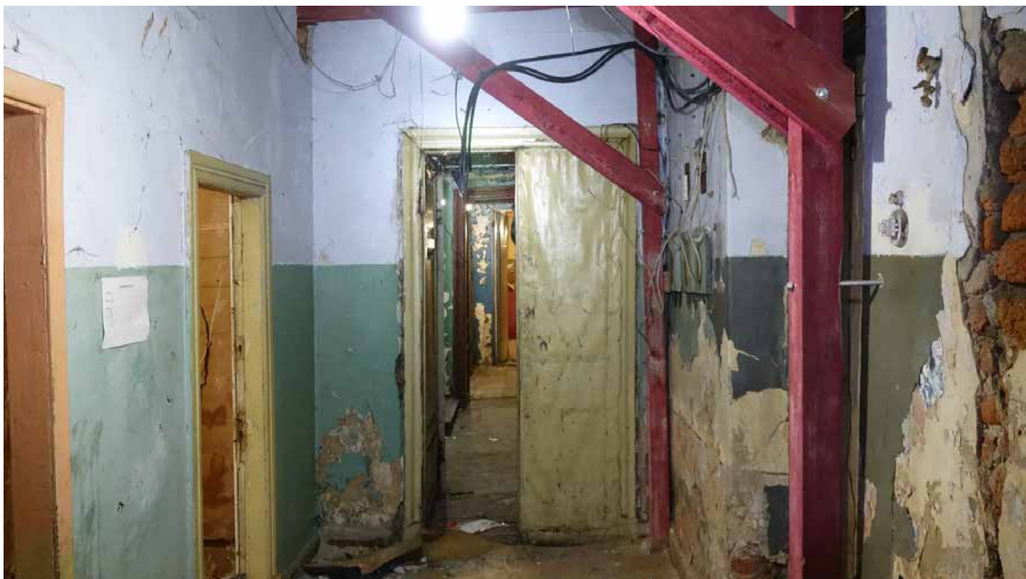
Фото 89. Помещение 4. Общий вид. Первый этаж. Дата фотофиксации: 01.03.24
