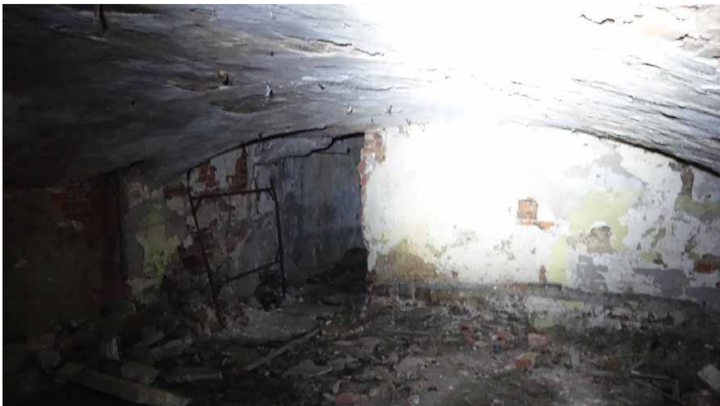
Фото 30. Помещение 147. Цилиндрический свод. Цокольный этаж. Дата фотофиксации: 01.03.24
