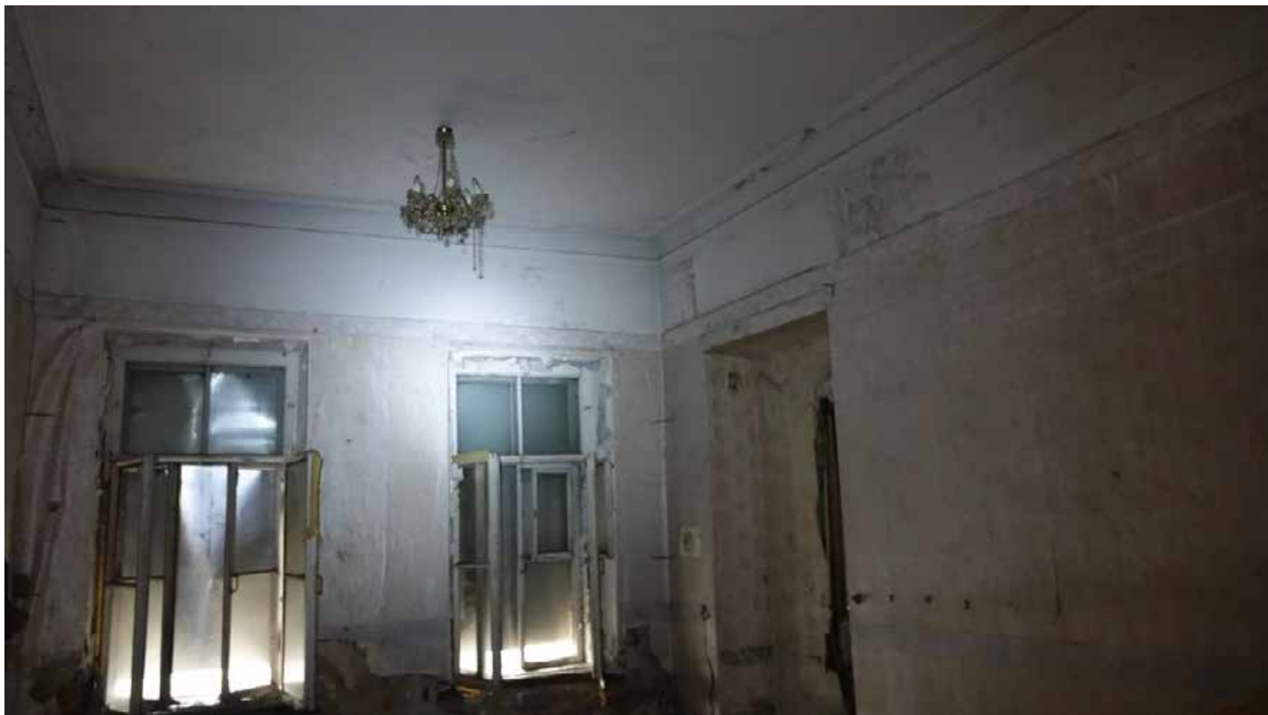
Фото 143. Помещение 57. Общий вид. Второй этаж. Дата фотофиксации: 01.03.24
