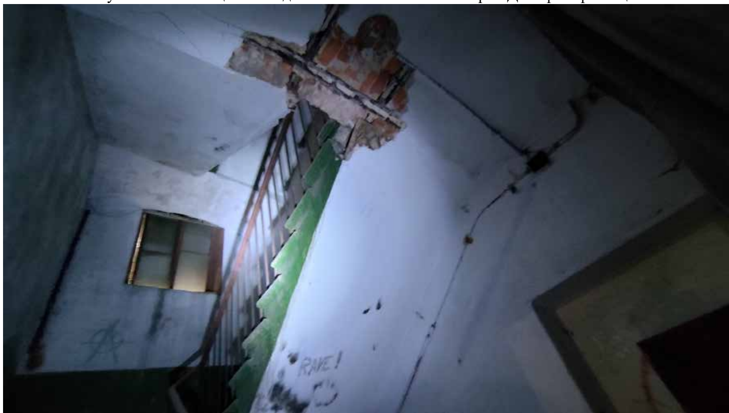
Фото 20. Служебная лестница Л2. Лестничные марши. Дата фотофиксации: 01.03.24
