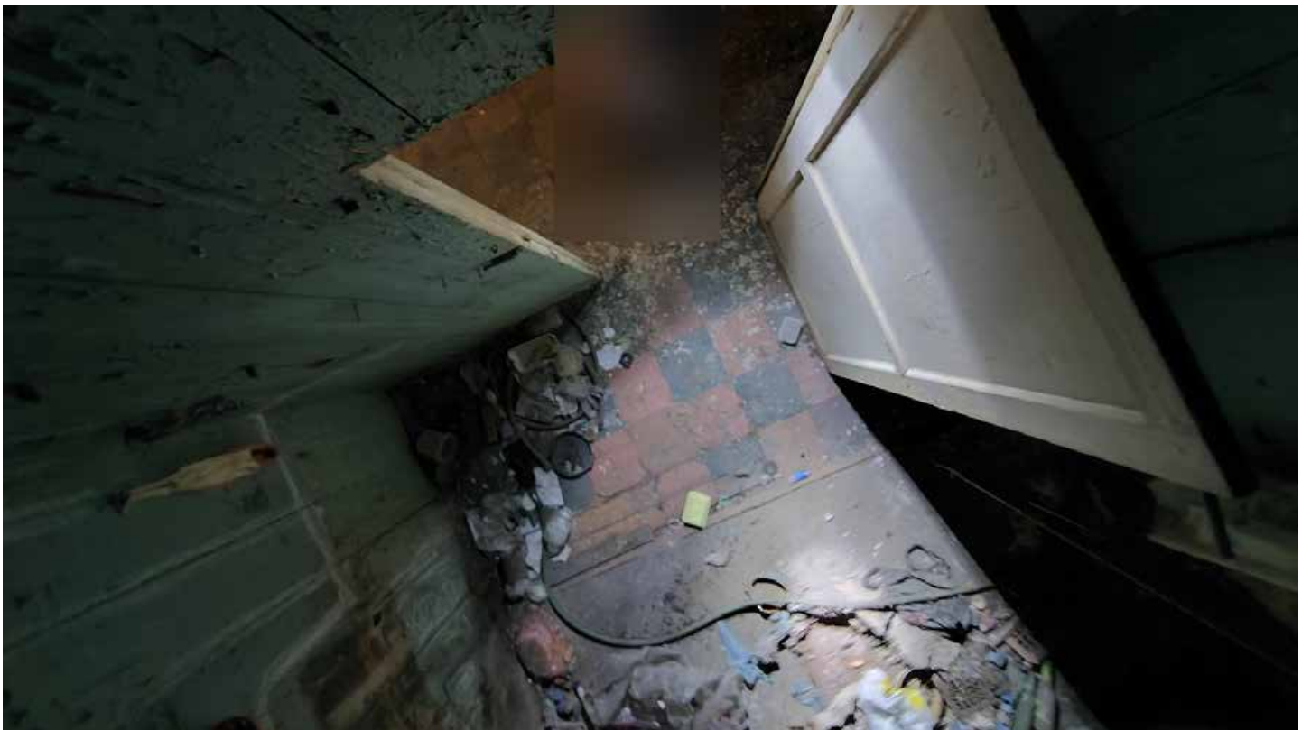
Фото 199. Помещение 106. Общий вид. Третий этаж. Дата фотофиксации: 01.03.24
