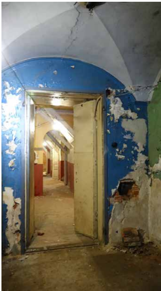
Фото 104. Помещение 112. Общий вид. Дата фотофиксации: 01.03.24
