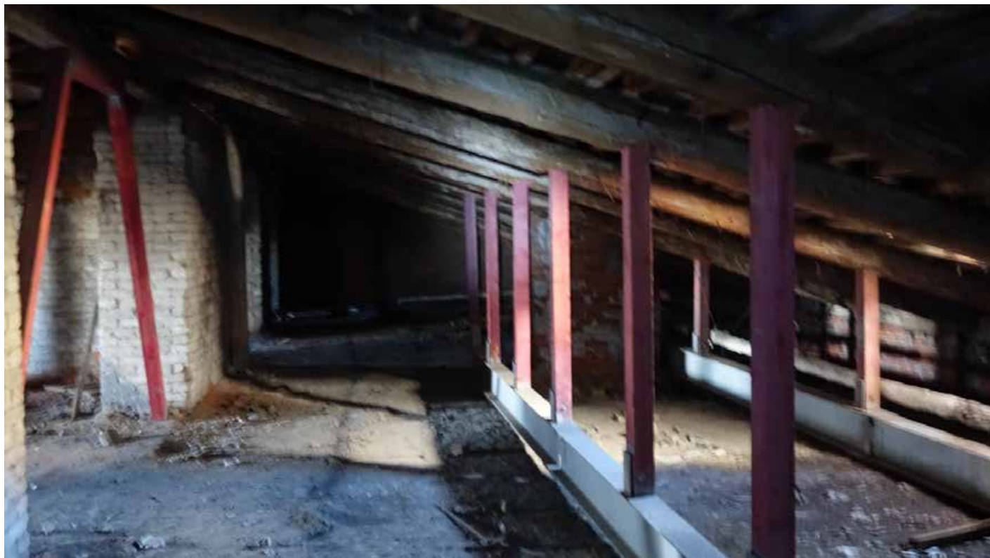
Фото 246. Мансарда. Основной объём. Фрагмент. Дата фотофиксации: 01.03.24
