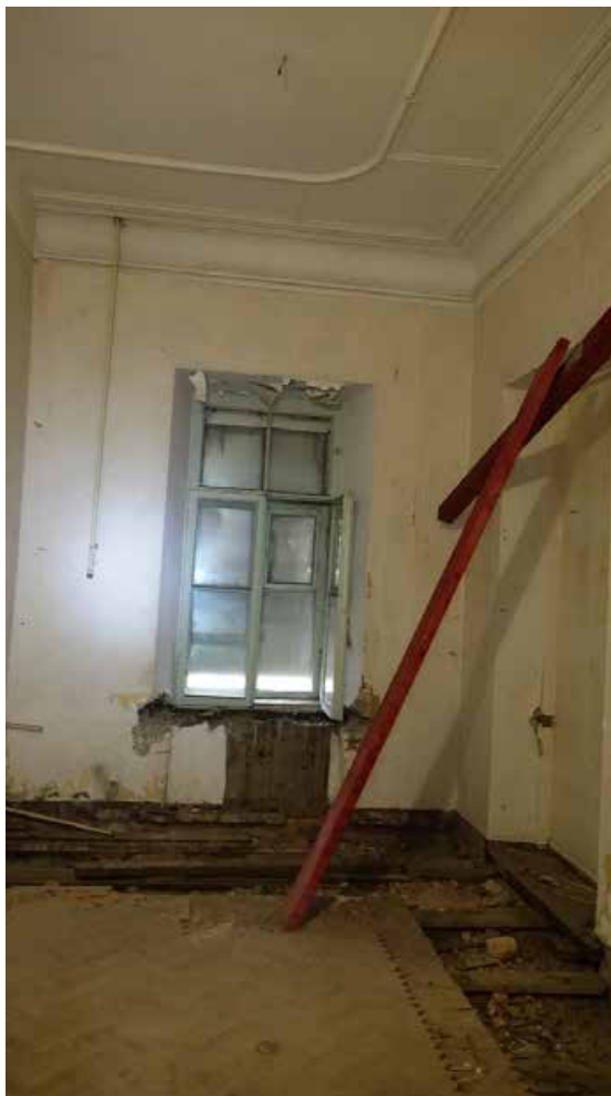
Фото 157. Помещение 66. Общий вид. Второй этаж. Дата фотофиксации: 01.03.24
