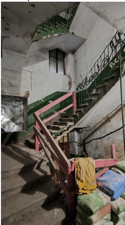
Фото 10. Лестница Л4. Общий вид. Дата фотофиксации: 01.03.24
