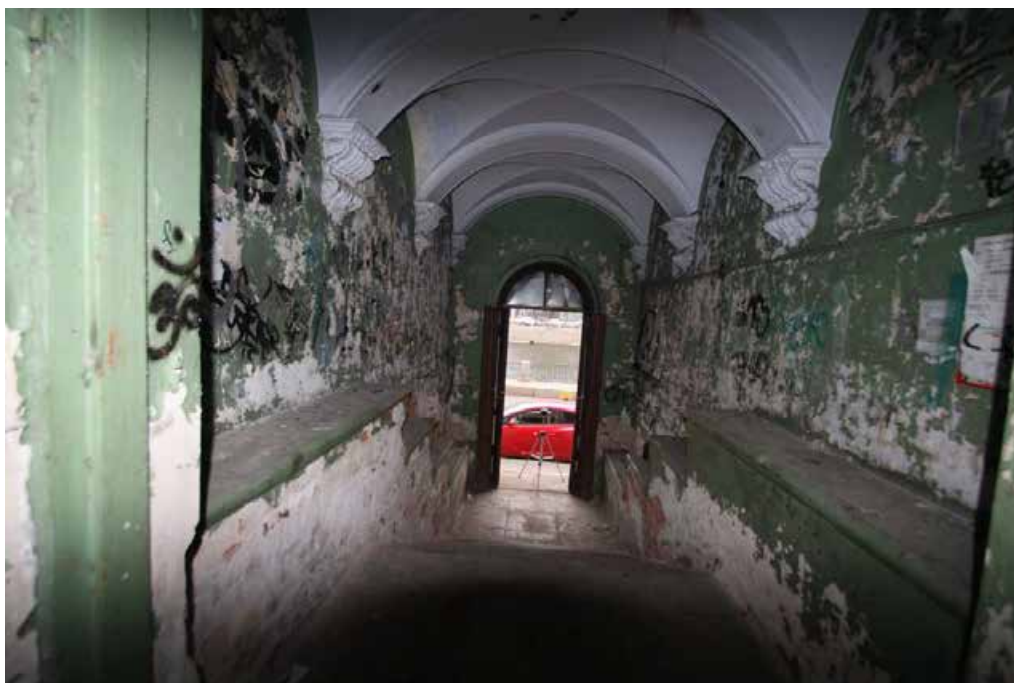
Фото 105. Помещение 1, парадный вестибюль. Общий вид. Дата фотофиксации: 01.03.24
