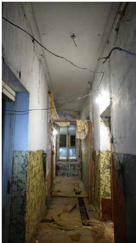
Фото 192. Помещение 98. Коридор. Третий этаж. Дата фотофиксации: 01.03.24
