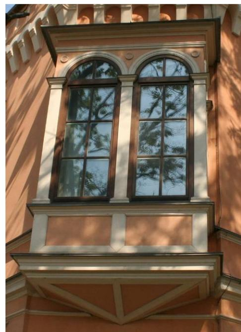
ризалит по южному фасаду с верандой во втором: оконные и дверные проемы с полуциркульным завершением и завершением в виде трехцентровой арки; профилированные архивольты, импосты; филенки, в том числе в подоконном пространстве; профилированные карнизы;
