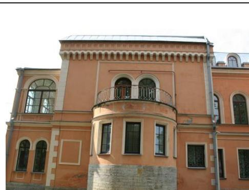
эркер на юго-западном углу здания с оконными проемами с полуциркульным завершением, с профилированными архивольтами, пилястрами в простенках, розетками, выносным профилированным карнизом, тягой под карнизом, филенками в подоконном пространстве; нижняя часть эркера пирамидальной формы с филенчатыми гранями;
