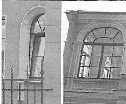
наземный эркер на восточном фасаде, полукруглый в плане, с прямоугольными окнами в профилированных наличниках, профилированные карнизы, филенчатый пояс, повышенный известняковый цоколь; балкон на эркере на уровне второго этажа; сдвоенное окно-дверь с полуциркульным завершением в профилированном наличнике в обрамлении прямоугольной рамы с профилировкой;
