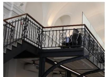
лестница в дворовом корпусе: материал (лещадная плита на металлических косоурах), ограждение лестницы и балкона: материал (металл), рисунок (в виде завитков);
