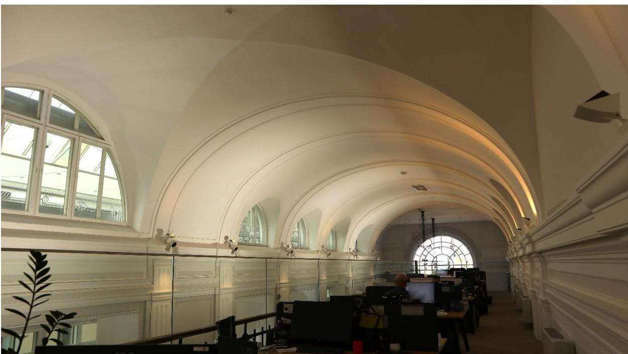
Фото 24. Помещение (б. телефонной станции). 4 этаж. Своды перекрытия.
