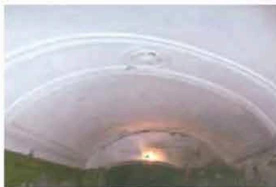
перекрытие воротного проезда в виде цилиндрического свода с распалубками и подпружными арками.
