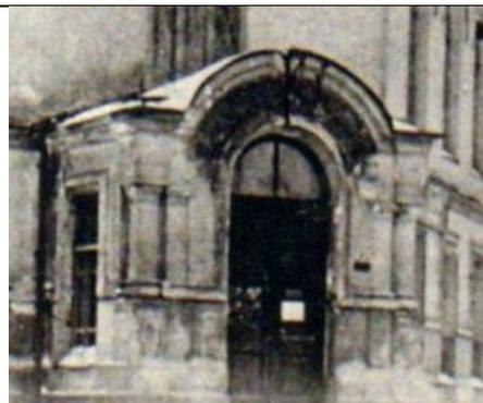
исторические оконные проемы – местоположение, конфигурация (прямоугольные в уровне 1-го этажа; полуциркульные в уровне 2-го этажа; сдвоенные арочные в уровне 3-го этажа), габариты;
