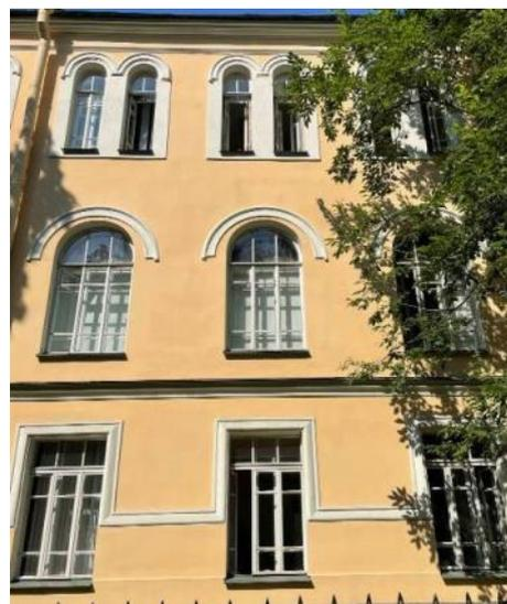
заполнение оконных проемов - материал (дерево), исторический рисунок расстекловки;
