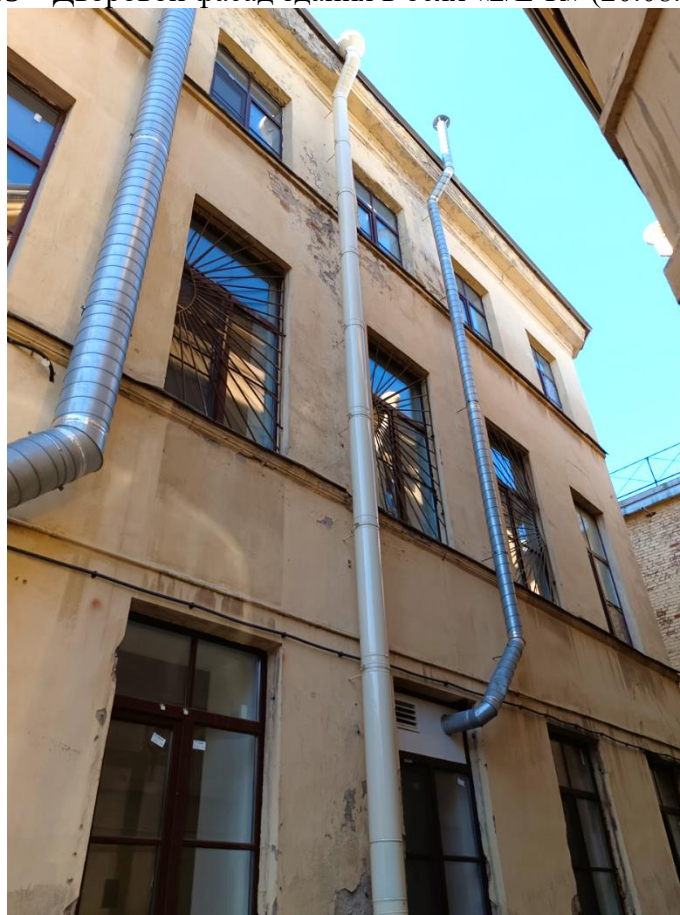
Фото 16 – Дворовой фасад здания в осях «3/С-Т» (20.08.2024 г.)
