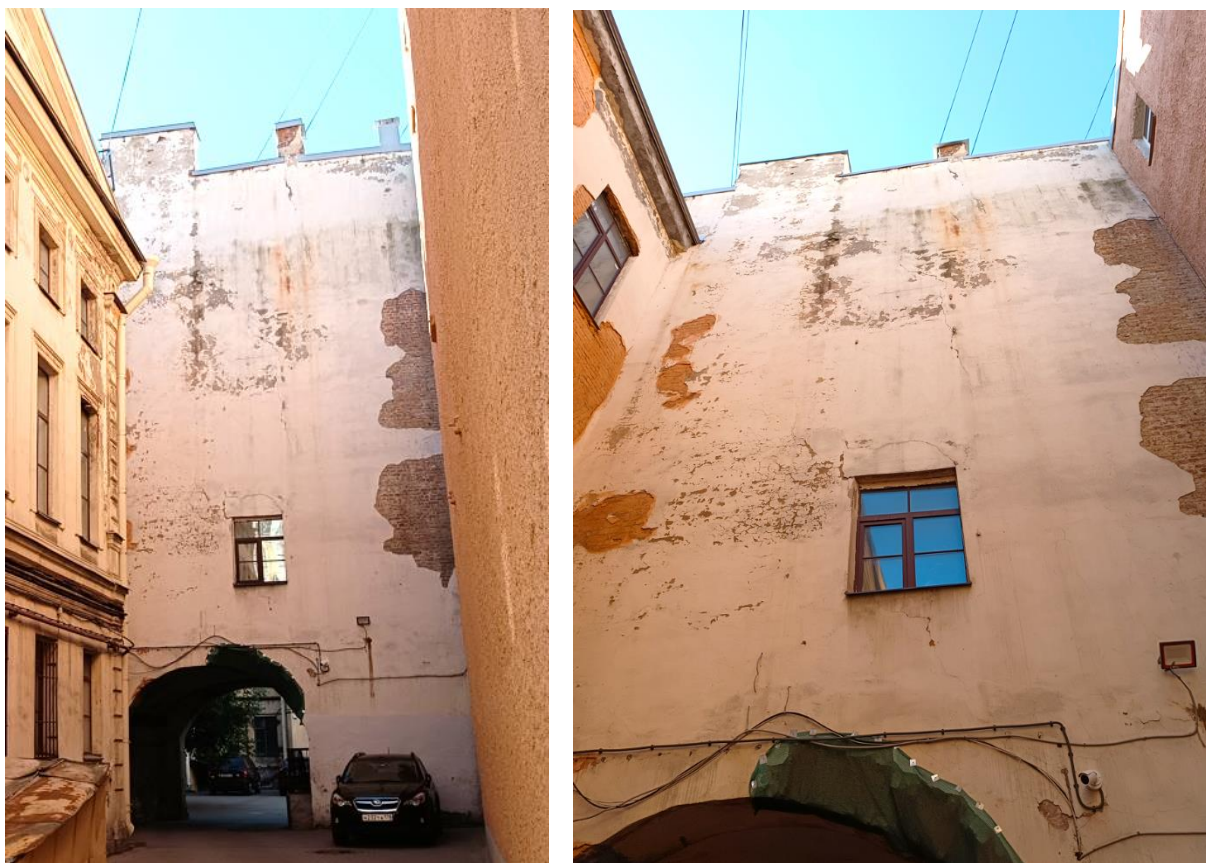
Фото 11 – Дворовой фасад здания в осях «8/И-Н» (20.08.2024 г.)
