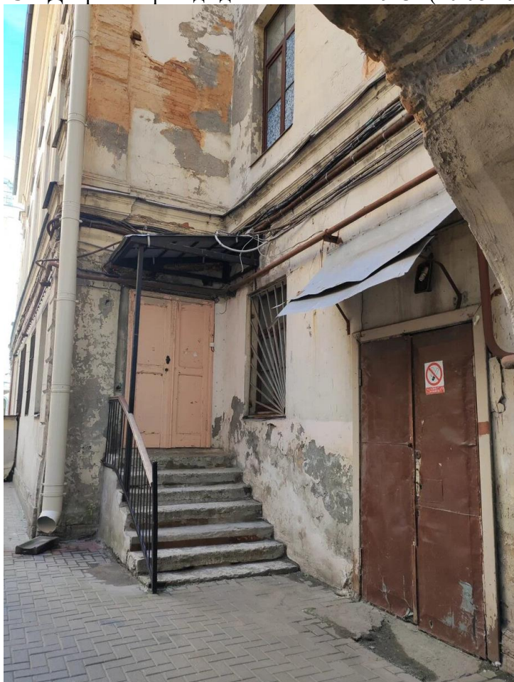
Фото 10 – Дворовой фасад здания в осях «9/Л-И» (20.08.2024 г.)
