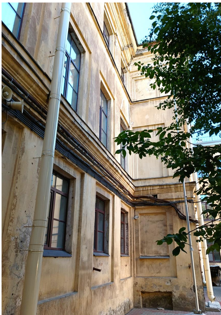
Фото 17 – Дворовой фасад здания в осях «5/Г-Д» (20.08.2024 г.)
