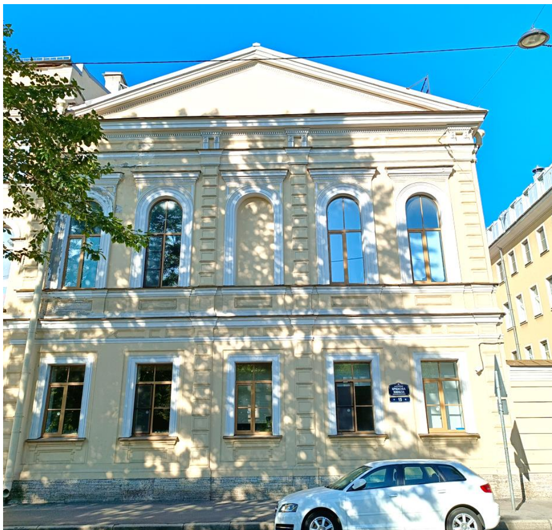
Фото 1 – Лицевой фасад здания в осях «А/10-13» (20.08.2024 г.)
