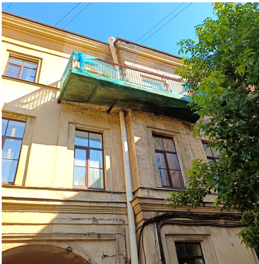
Фото 21 – Дворовой фасад здания в осях «7/Г-И» (20.08.2024 г.)
