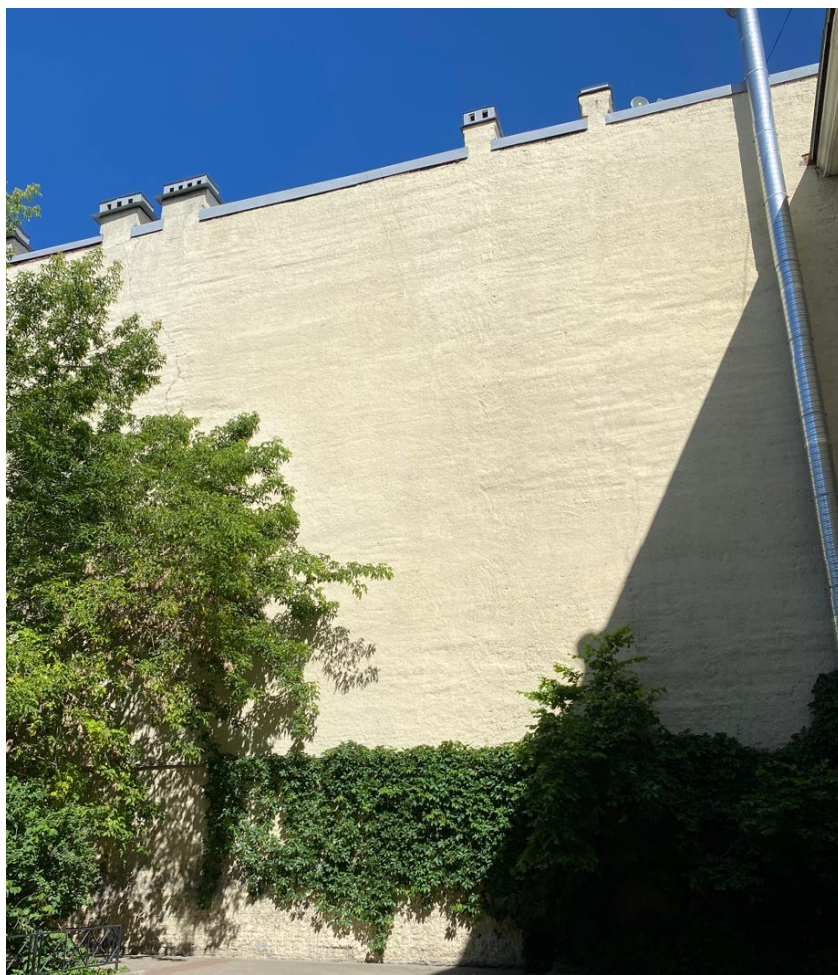
Фото 24 – Дворовой фасад здания в осях «1/Н-Г» (20.08.2024 г.)
