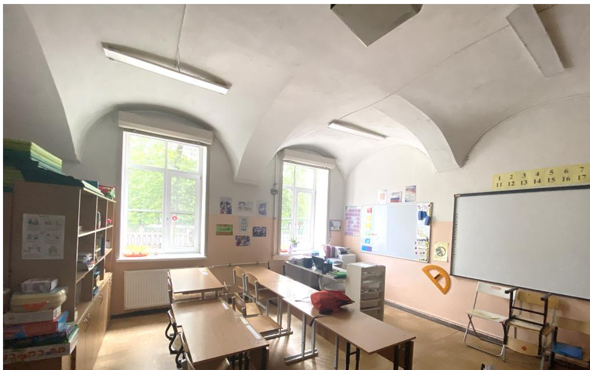
Фото 14 – Внутреннее помещение в осях «10-12/А-Б», 1 этаж (20.08.2024 г.)
