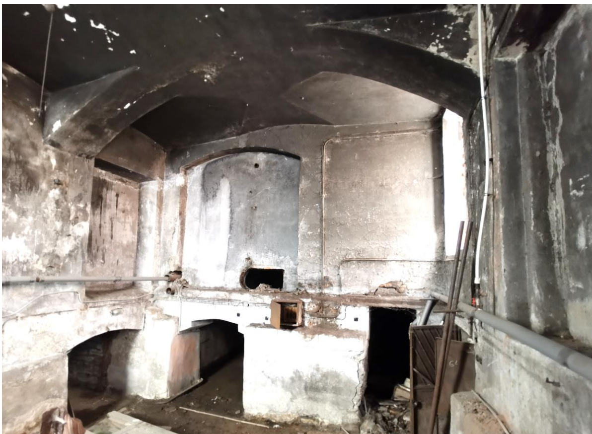
Фото 13 – Внутреннее помещение в осях «11-13/Е-Л», подвал (20.08.2024 г.)
