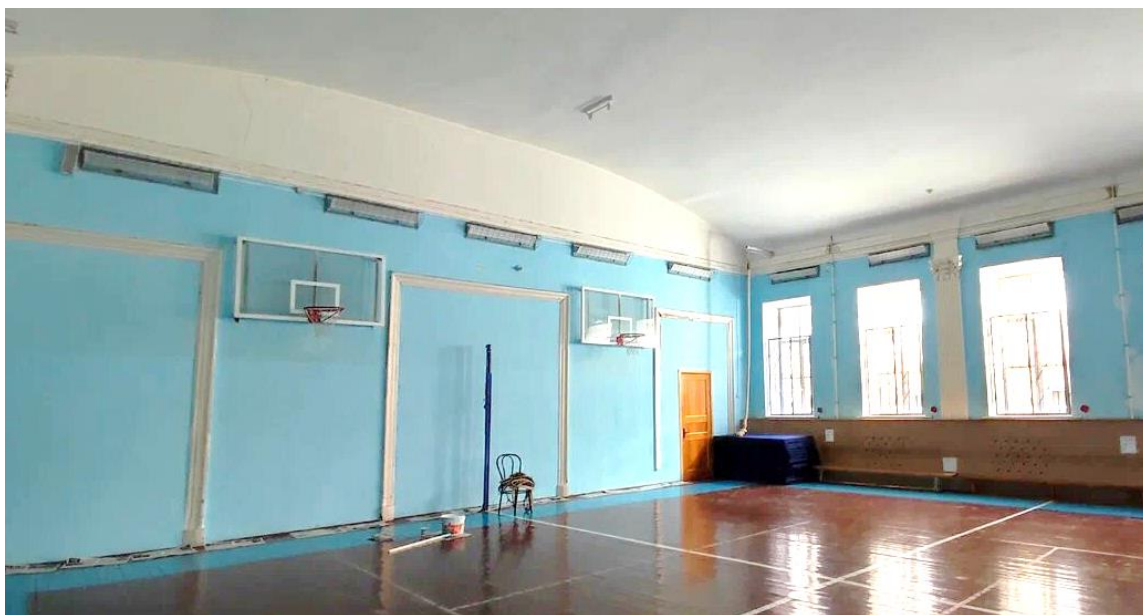
Фото 9 – Внутреннее помещение в осях «10-13/В-Е», 2 этаж (20.08.2024 г.)
