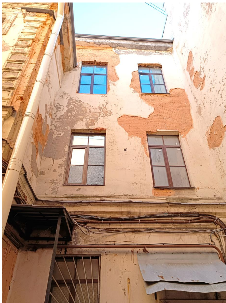
Фото 9 – Дворовой фасад здания в осях «И/9-8» (20.08.2024 г.)
