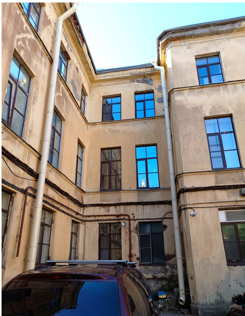
Фото 15 – Дворовой фасад здания в осях «2/Е-К» (20.08.2024 г.)
