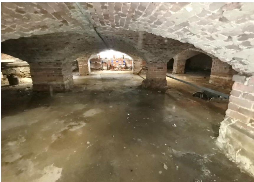
Фото 12 – Внутреннее помещение в осях «1-4/А-Д», подвал (20.08.2024 г.)
