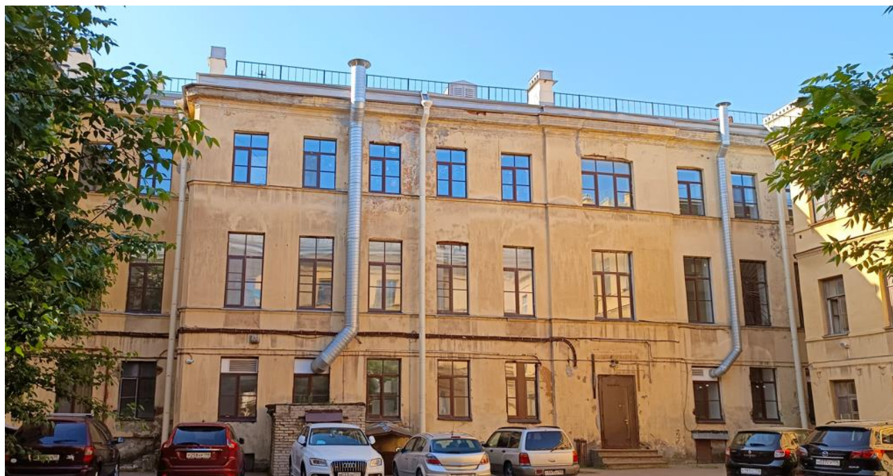
Фото 14 – Дворовой фасад здания в осях «3/К-С» (20.08.2024 г.)
