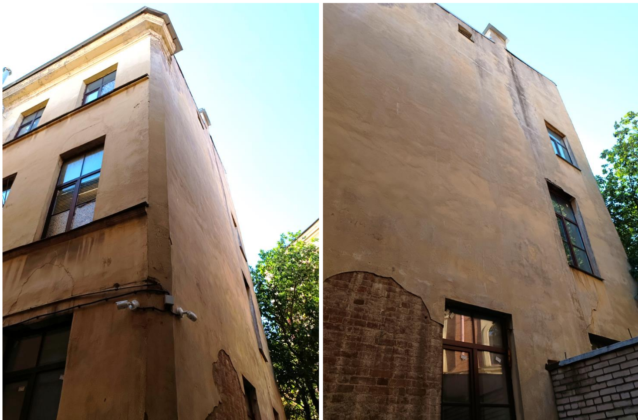
Фото 19 – Торцевой фасад здания в осях «Т/3-1» (20.08.2024 г.)
