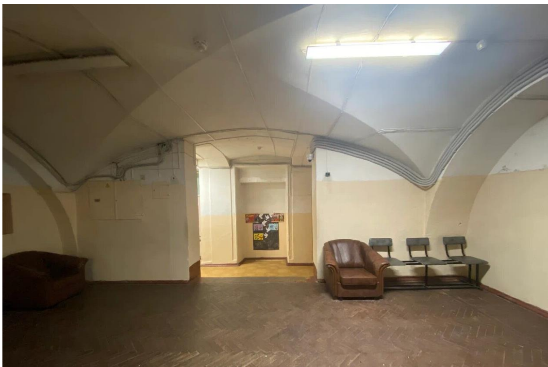
Фото 4 – Внутреннее помещение в осях «8-9/Б-Г», 1 этаж (20.08.2024 г.)
