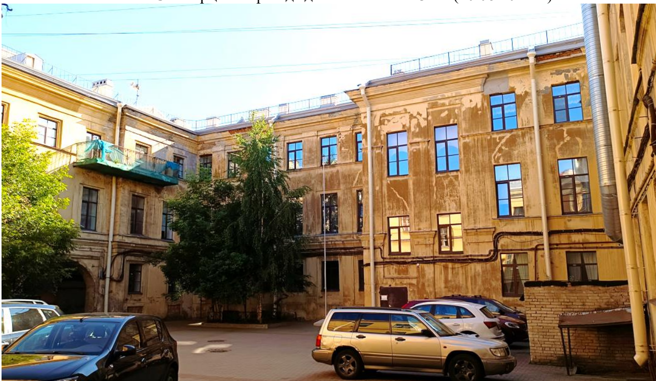
Фото 20 – Дворовой фасад здания в осях «З-7» (20.08.2024 г.)
