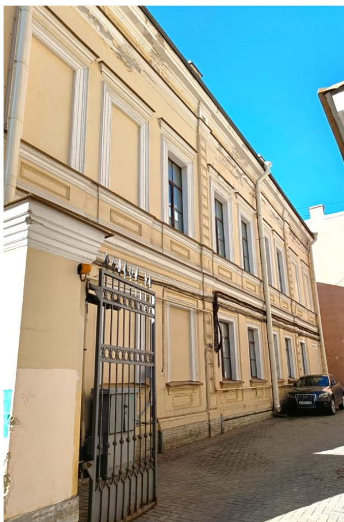
Фото 6 – Торцевой фасад здания в осях «13/А-Л» (20.08.2024 г.)
