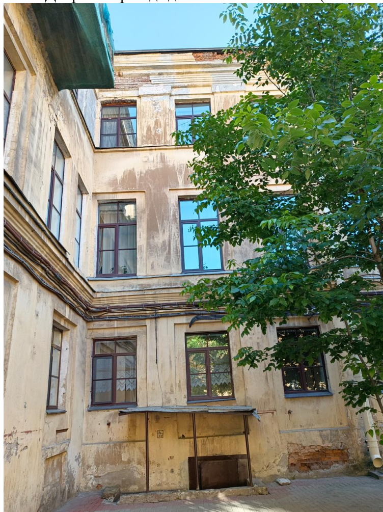
Фото 22 – Дворовой фасад здания в осях «Г/7-6» (20.08.2024 г.)
