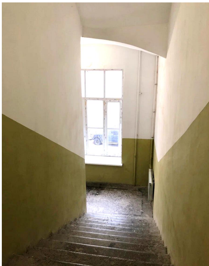
Фото 18 – Лестница в осях «1-3/П-С» (20.08.2024 г.)
