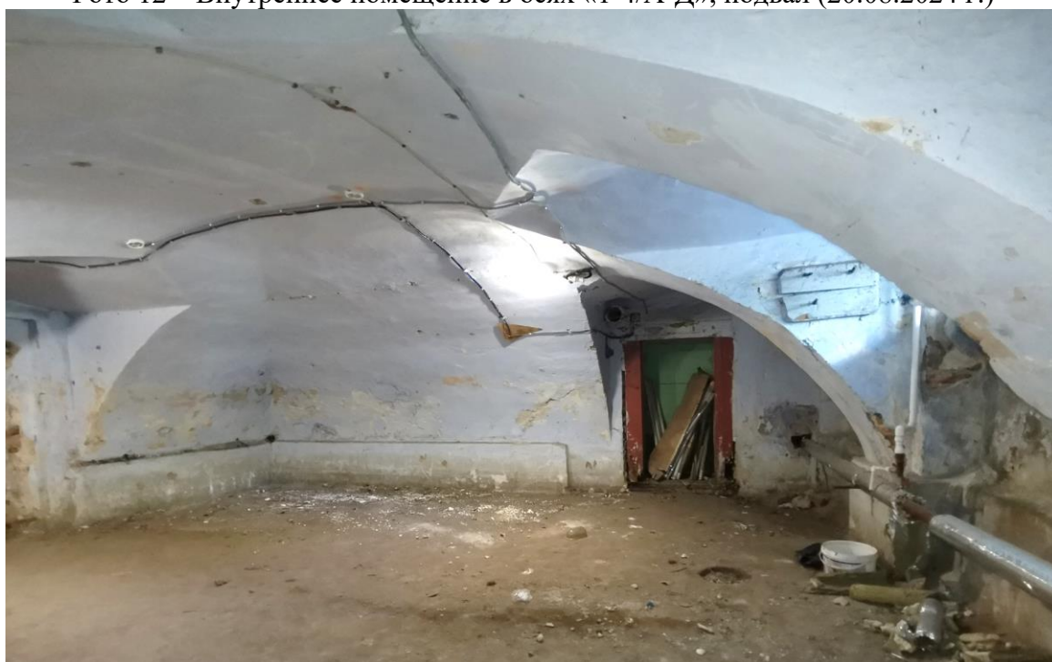
Фото 13 – Внутреннее помещение в осях «6-7/А-Б», подвал (20.08.2024 г.)
