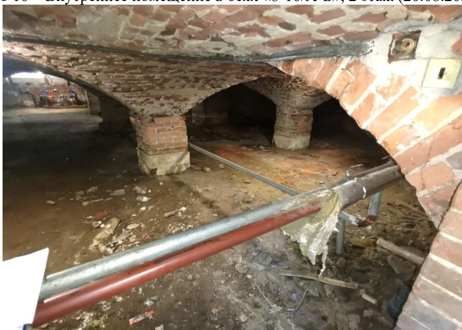
Фото 11 – Внутреннее помещение в осях «1-4/А-Д», подвал (20.08.2024 г.)
