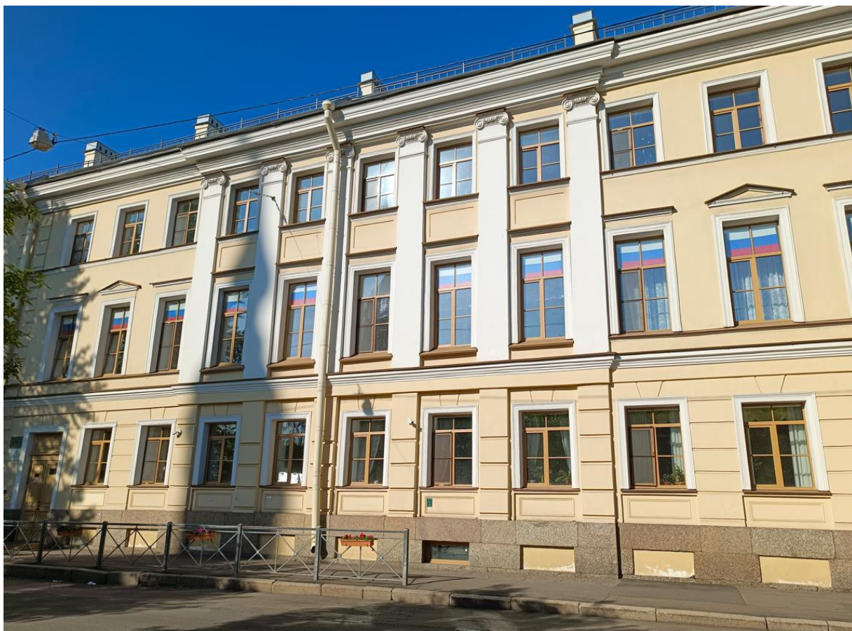
Фото 3 – Лицевой фасад здания в осях «А/4-8» (20.08.2024 г.)
