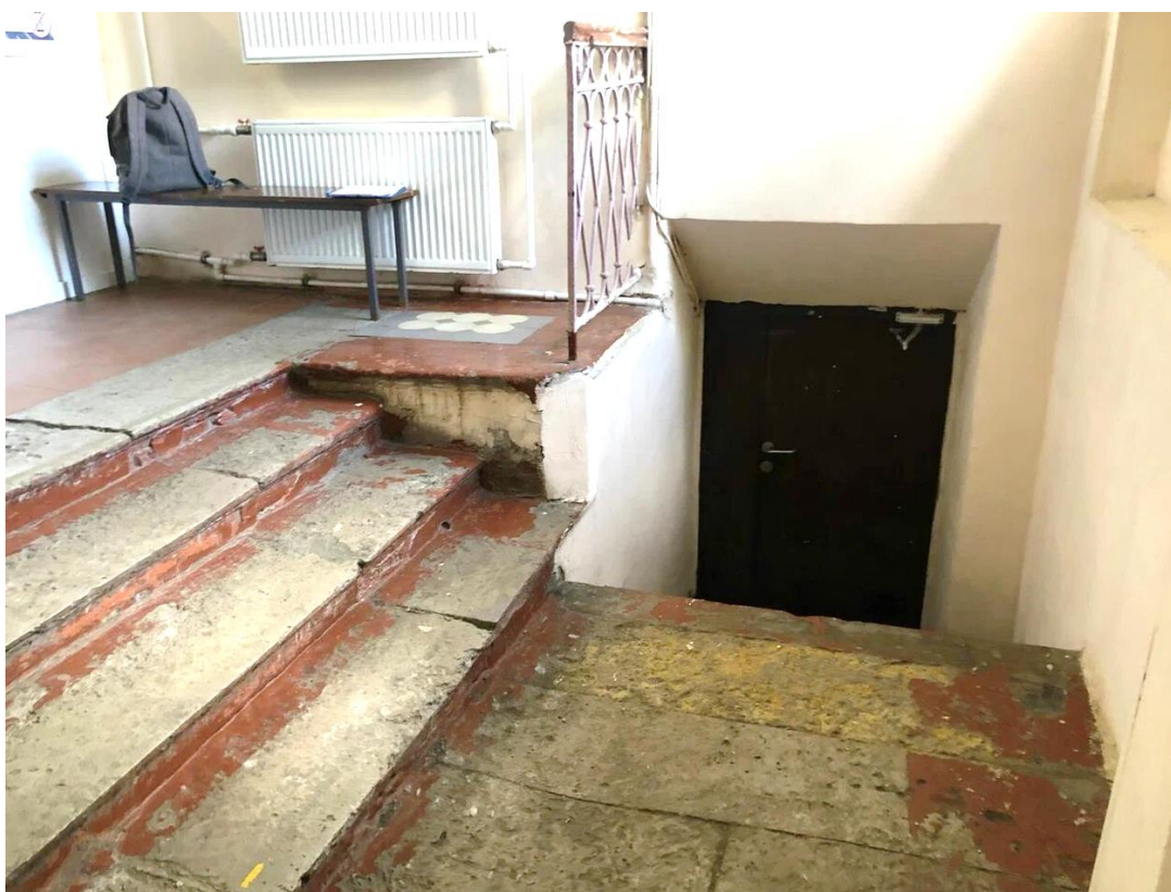
Фото 1 – Вестибюль в осях «4-5/А-Б», 1 этаж (20.08.2024 г.)
