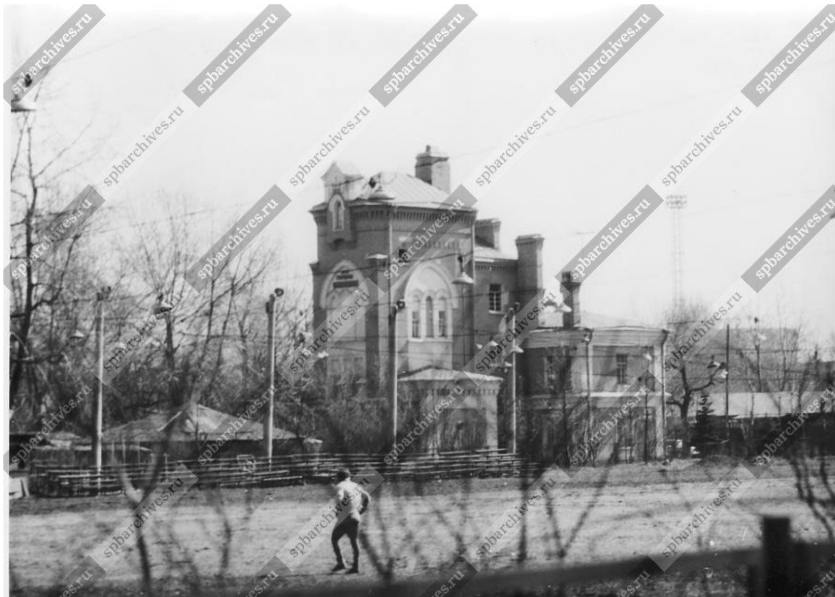
Илл. 70. Вид футбольного поля спортивного стадиона у бывшего рабочего городка Ф.К. Сан-Галли на Ремесленной улице, 6. Архитектор В.Р.Курзанов, 1899 г. Дата съемки: 18 апреля 1982 г. // Источник: ЦГАКФФД СПб. Архивный шифр: Ар 211791.
