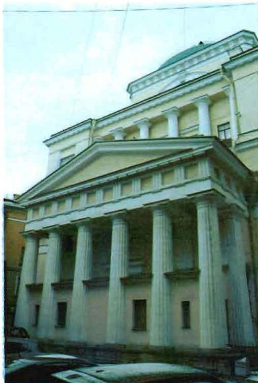
Фото №3. Вид на восточный фасад со стороны двора.
