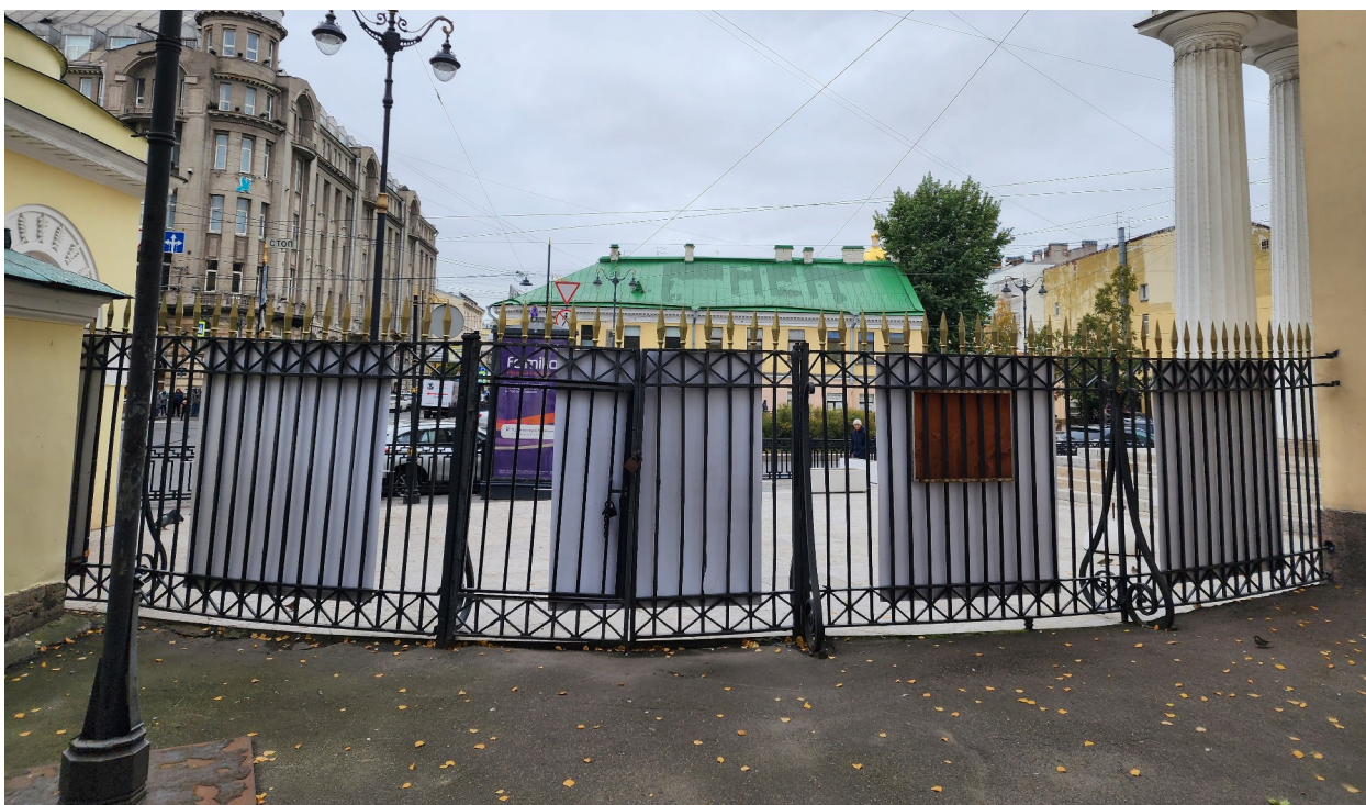
Фото 11. Секция ограды, примыкающая к правой часовне со стороны двора.
