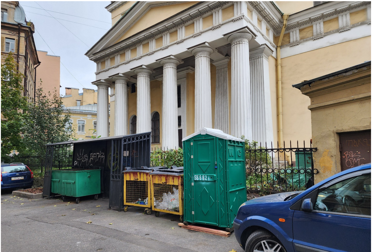
Фото 7. Секция ограды, расположенная на подпорной стенке.
