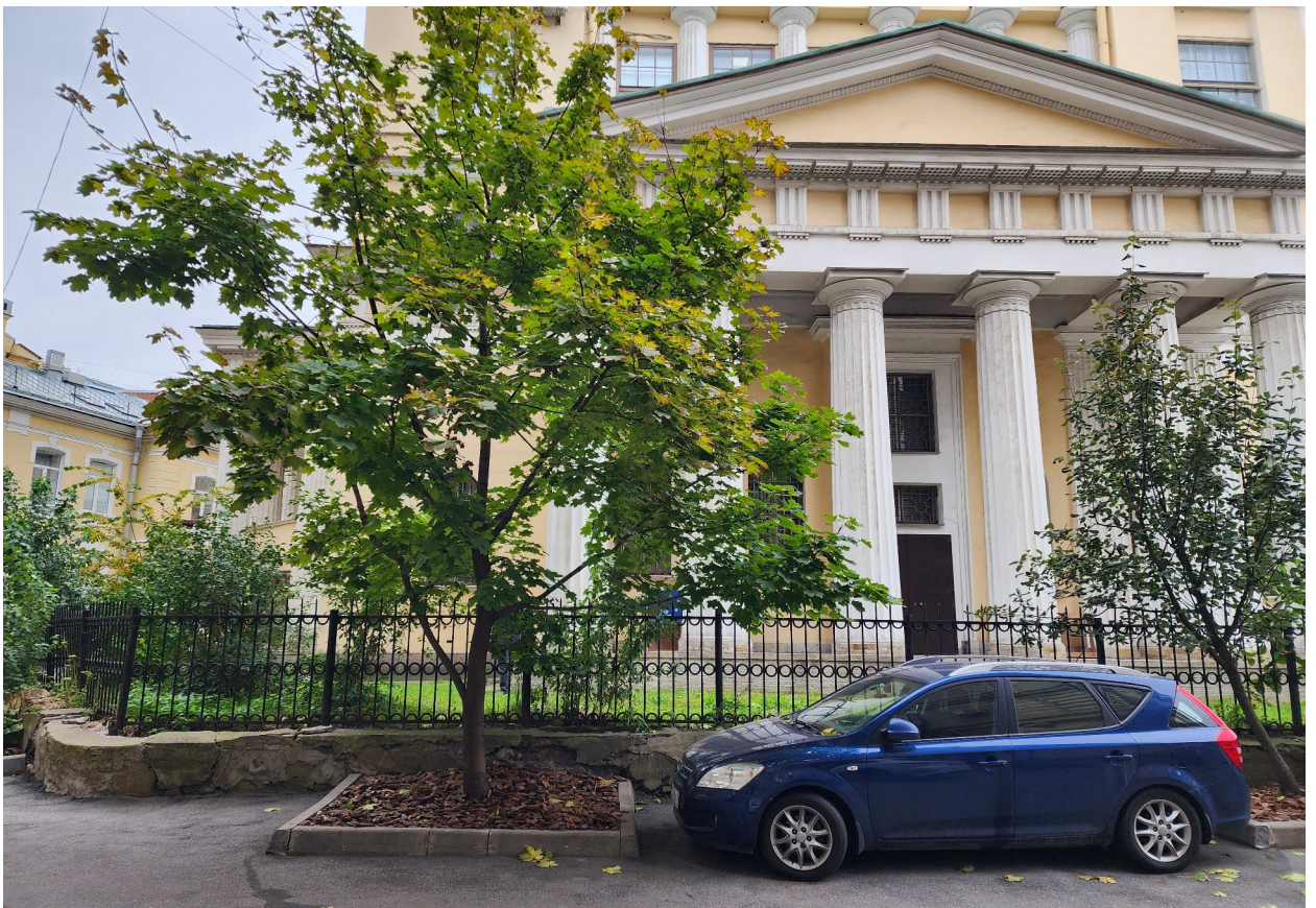
Фото 8. Секция ограды, расположенная на подпорной стенке.
