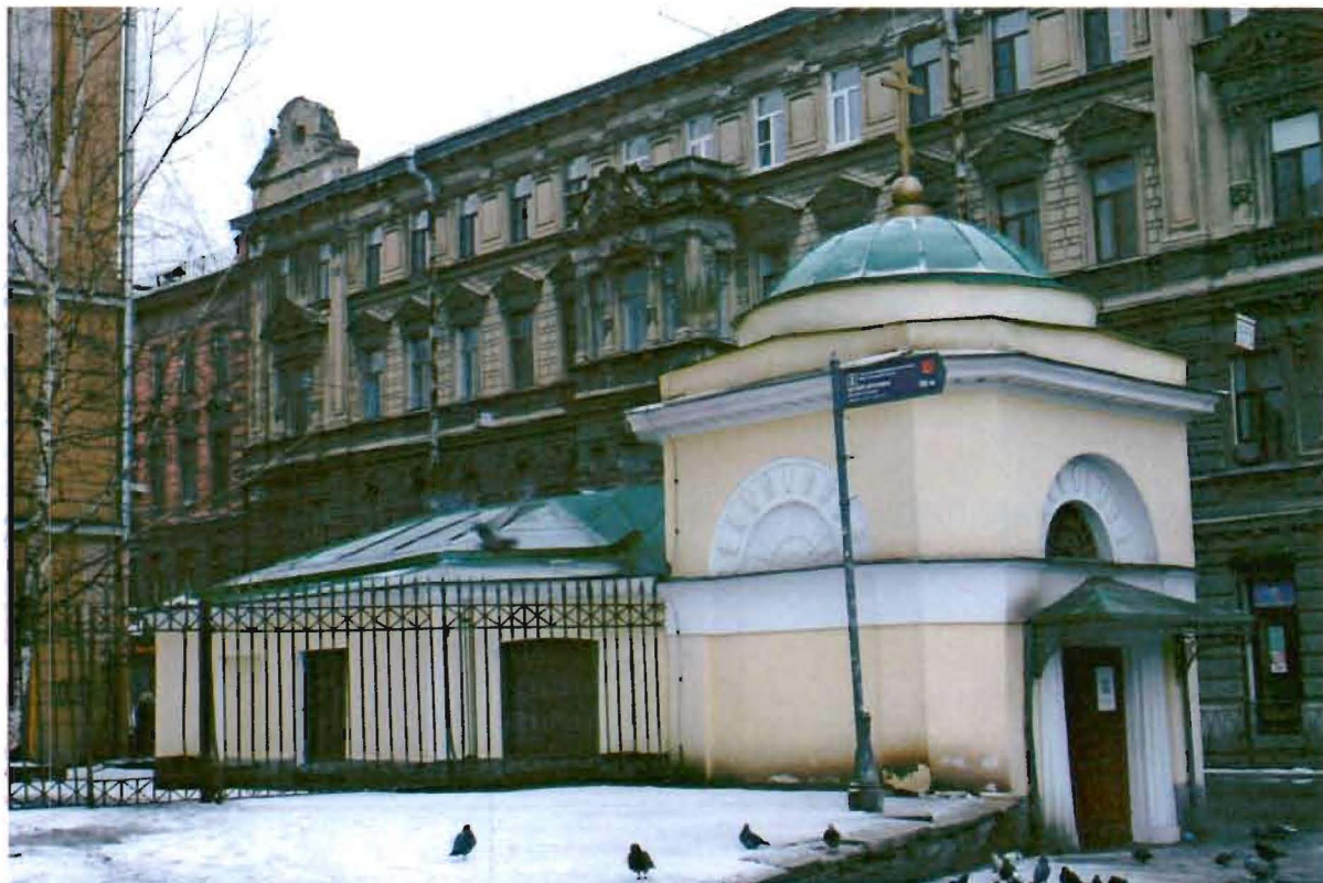
Фото №11. Здание по адресу: Санкт-Петербург, улица Марата, дом 24а, лит. Д.
