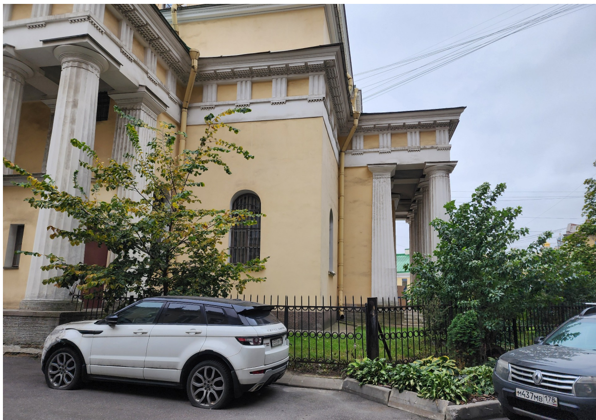
Фото 9. Секция ограды, расположенная на подпорной стенке.
