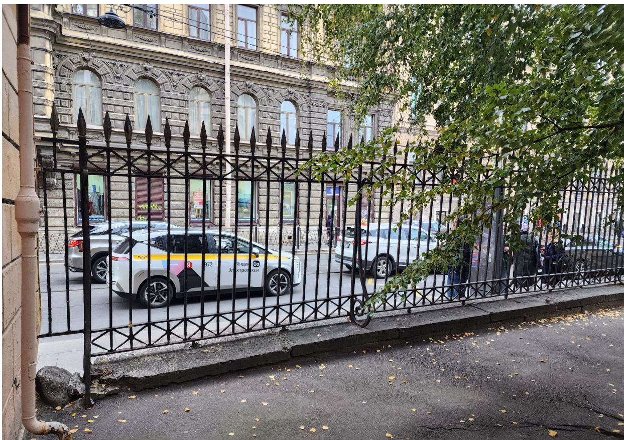
Фото 10. Секция ограды, расположенная вдоль Кузнечного переулка. Со стороны двора.
