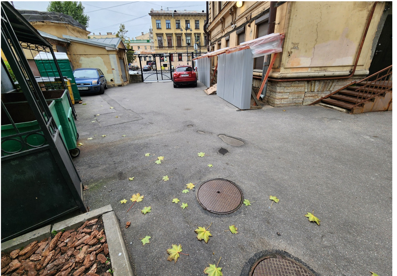
Фото 16. Асфальтовое покрытие двора.
