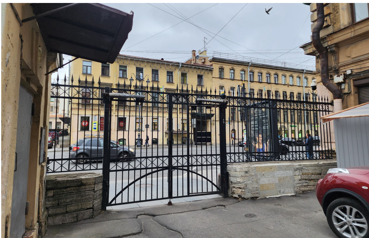
Фото 6. Секция ограды, идущая вдоль ул. Марата со стороны двора.
