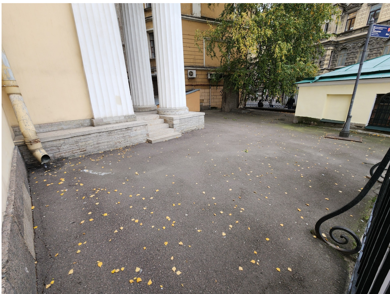
Фото 12. Асфальтовое покрытие двора.
