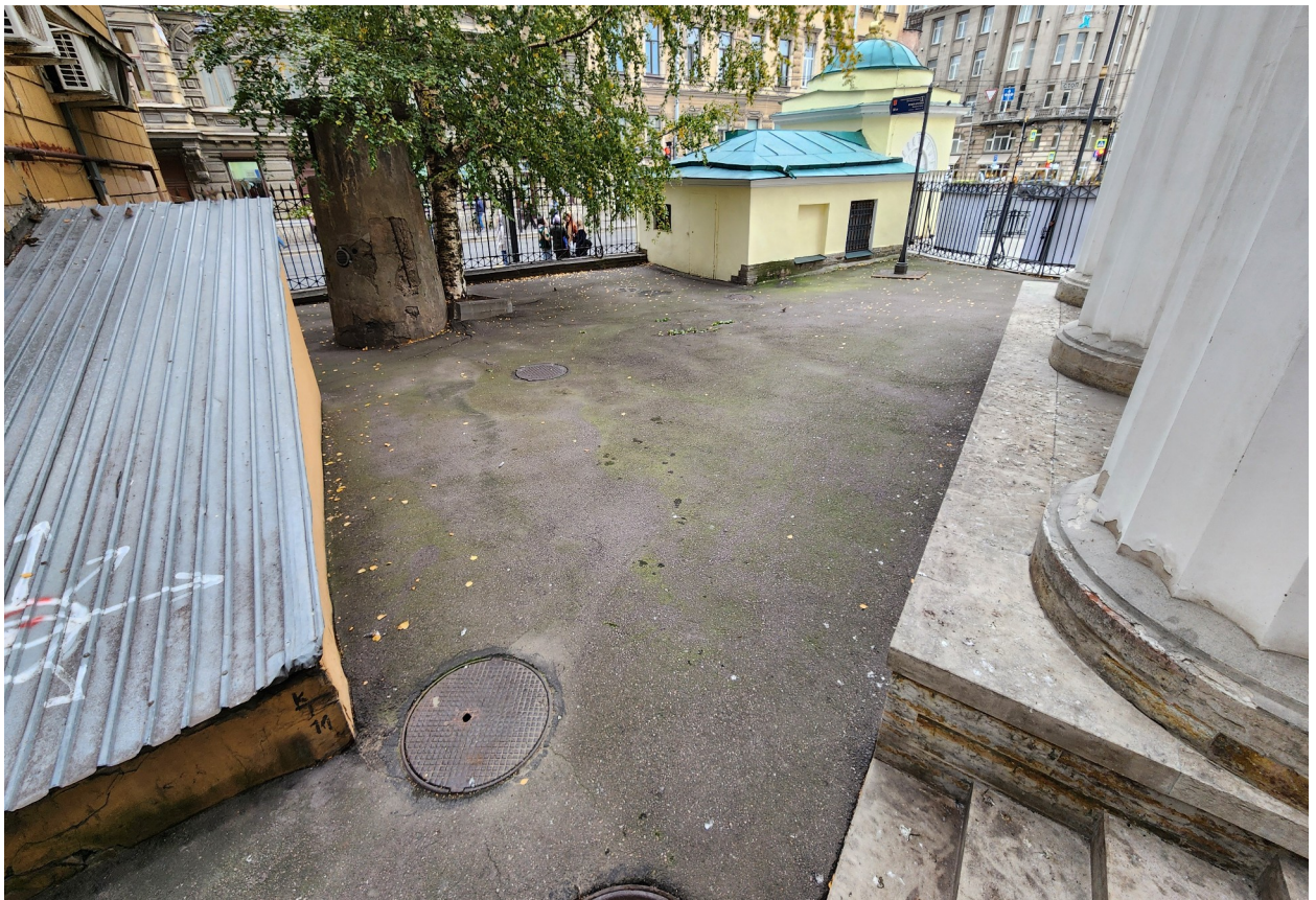
Фото 13. Асфальтовое покрытие двора.
