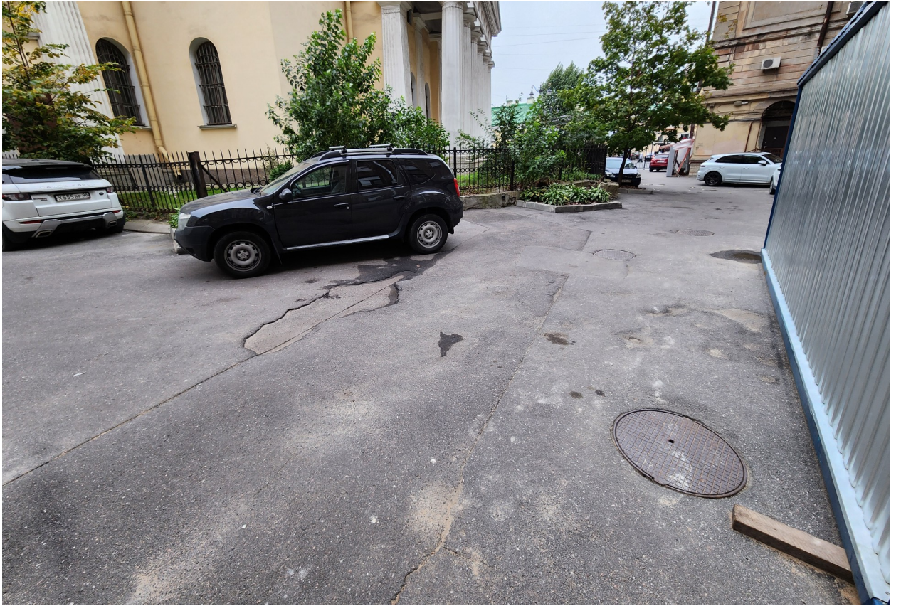
Фото 15. Асфальтовое покрытие двора.
