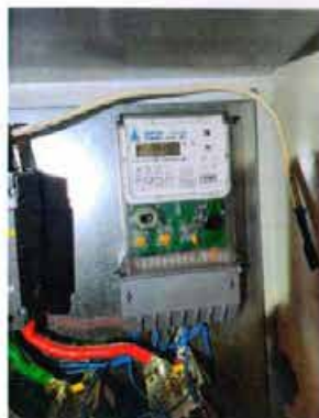
Фото 61. Приборы учета электроэнергии с группой автоматических выключателей в ч.п. 1 помещения 45-Н на цокольном этаже (Часть 1).
