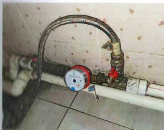
Фото 69. Система холодного водоснабжения с прибором учета в Части 3 (в ч.п. 12, ч.п. 11 помещения 24-Н).
