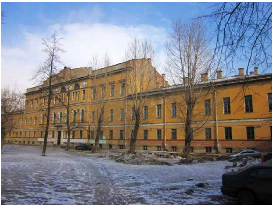
66. Бывший Николаевский дом призрения престарелых и увечных граждан Санкт-Петербургского купеческого общества. Главное здание. Вид на центральную (среднюю) надстроенную часть фасада. Фотография. 2010-е гг. www.citywalls.ru .
