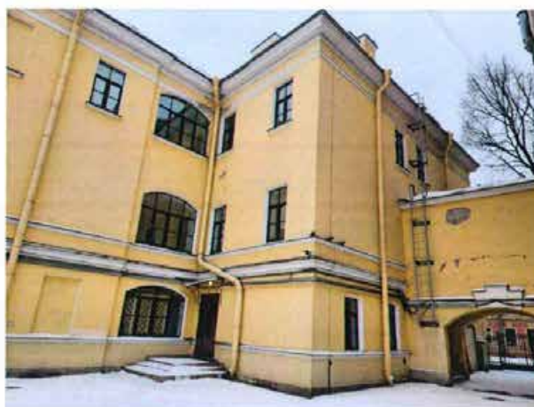
Фото 9. Фрагмент дворовых фасадов здания (Часть 2).
