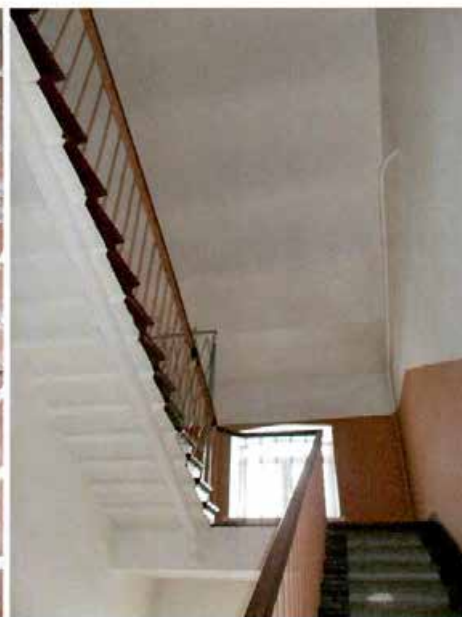
17. Лазарет (лестница 8-ЛК, перекрытия)
