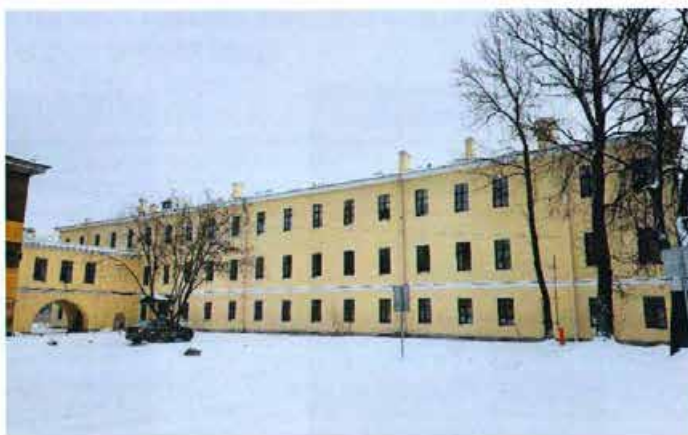
Фото 36. Фрагмент фасадов здания (Часть 1 и Часть 4) со стороны Расстанной улицы.
