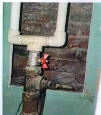
Фото 67. Фрагмент общей кирпичной стены между Частью 1 и Частью 3 (линия раздела 2) на 1-ом этаже в ч.п. 10 помещения 24-Н. Вид со стороны Части 3.
