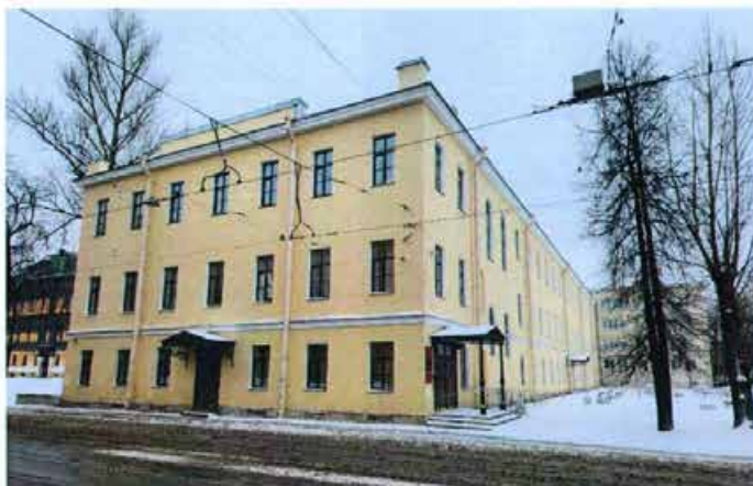
Фото 34. Фрагмент фасада здания (Часть 4) на пересечении Расстанной улицы и Днепропетровской улицы.
