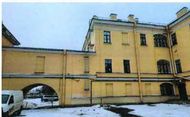
Фото 10. Фрагмент дворовых фасадов здания (Часть 2).
