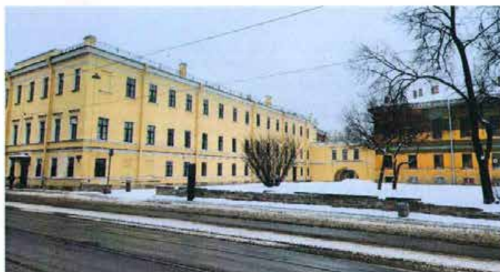
Фото 4. Фрагмент фасада здания (Часть 2 и Часть 1) со стороны улицы Расстанная.
