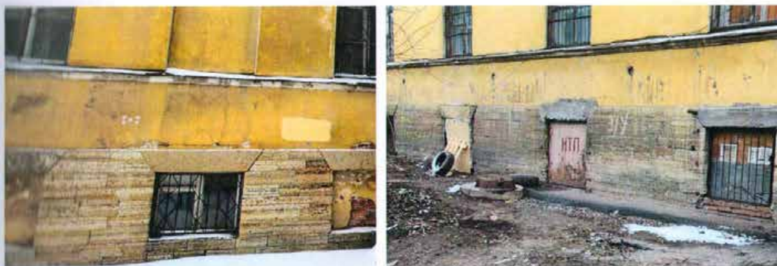
Фото 40. Облицовка цокольной части наружных стен Части 1 здания плитами из известняка со стороны Днепропетровской улицы.
