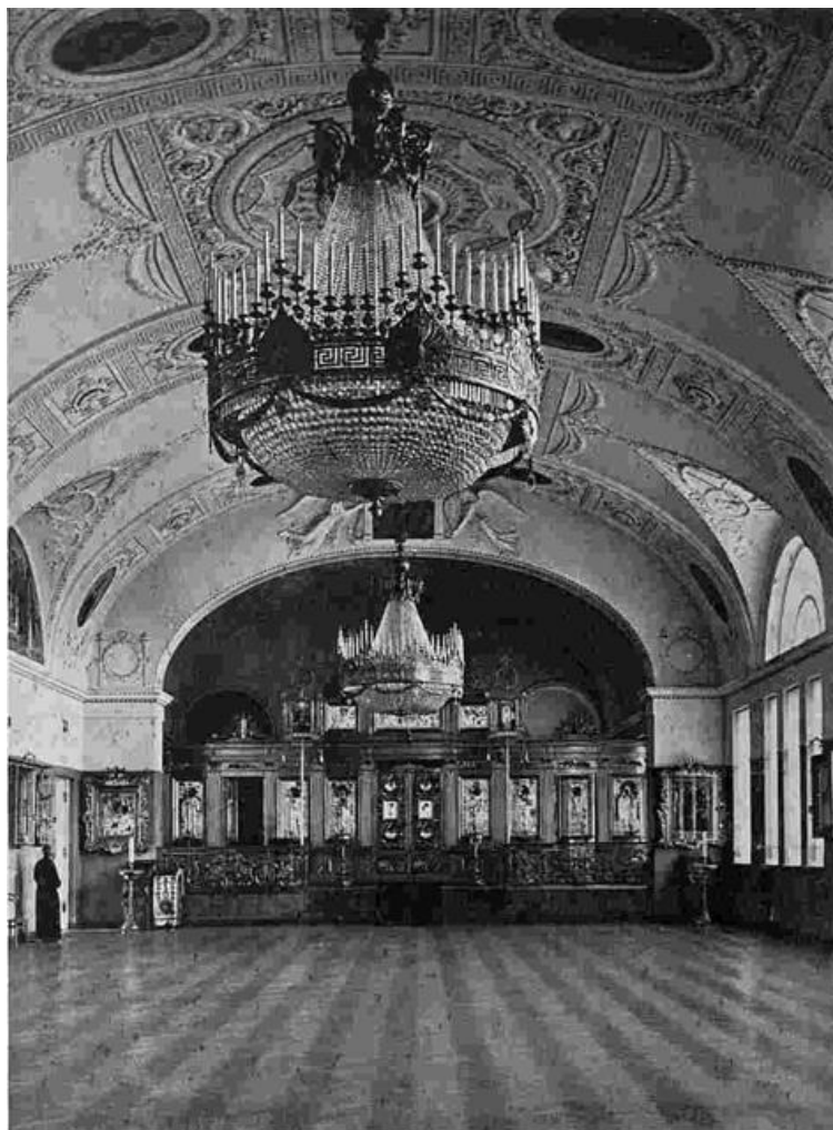
46. Николаевский дом призрения престарелых и увечных граждан Санкт-Петербургского купеческого общества. Церковь после работ по реконструкции здания 1907-1908 гг. Фотография. Зодчий. СПб., 1910.
