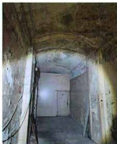
Фото 43. Конструкция перекрытия первого этажа в ч.п. 26 помещения 47-Н (Часть 1).
