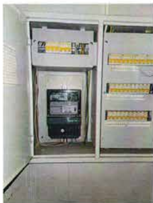
Фото 71. Приборы учета электроэнергии с группой автоматических выключателей в Части 3 (в ч.п. 1 помещения 24-Н).
