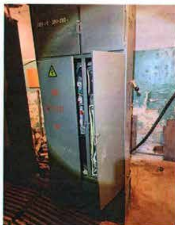
Фото 60. Вводное распределительное устройство системы электроснабжения в ч.п. 1 помещения 45-Н на цокольном этаже (Часть 1).
