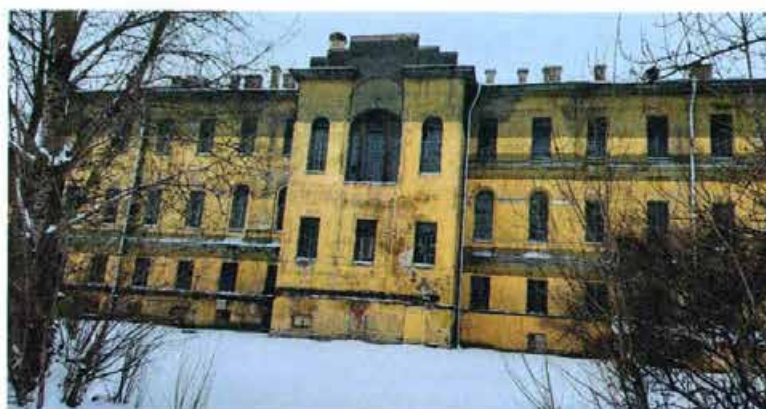
Фото 19. Фрагмент дворовых фасадов здания (Часть 1) со стороны внутриквартальной территории.
