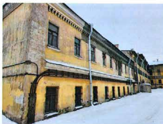
Фото 21. Фрагмент дворовых фасадов здания (Часть 1) со стороны внутриквартальной территории.
