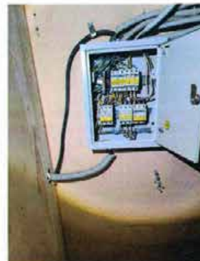
Фото 61. Приборы учета электроэнергии с группой автоматических выключателей в ч.п. 1 помещения 45-Н на цокольном этаже (Часть 1).
