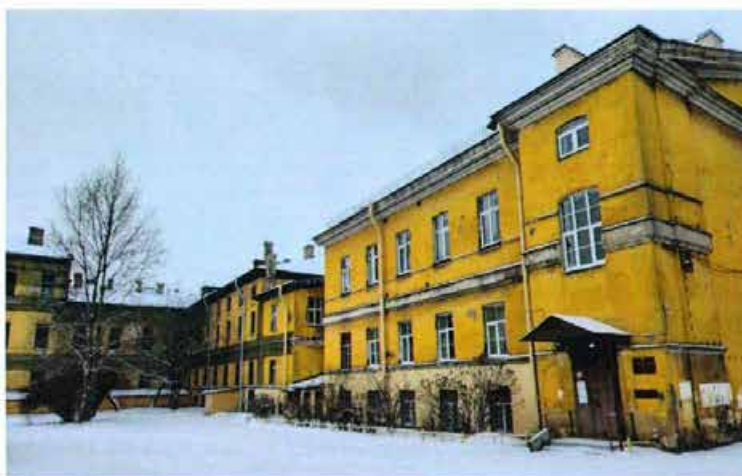
Фото 16. Фрагмент дворовых фасадов здания (Часть 1) со стороны внутриквартальной территории.
