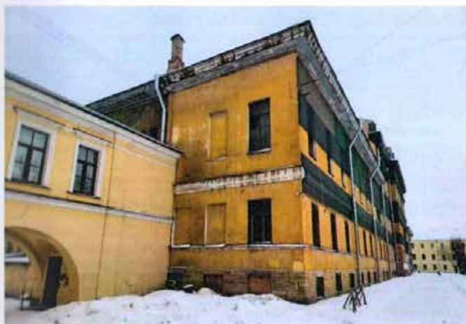
Фото 5. Фрагмент фасада здания на границе примыкания Части 2 и Части 1 со стороны улицы Расстанная.
