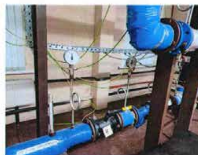
Фото 78. Индивидуальный тепловой пункт в Части 4 (на 1-ом этаже в ч.п. 19 помещения 17-Н).
