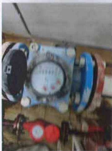
Фото 81. Приборы учета системы колодезного водоснабжения в Части 4 (на 1-ом этаже в ч.п. 1 помещения 72-Н).
