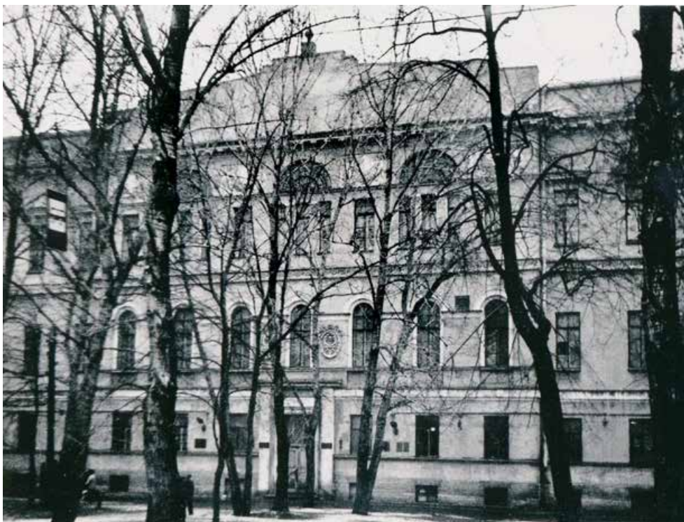
54. Бывший Николаевский дом призрения престарелых и увечных граждан Санкт-Петербургского купеческого общества. Общий вид главного здания. Фотография. 1995 г. Автор съемки: Андрей Агафонов. www.citywalls.ru .
