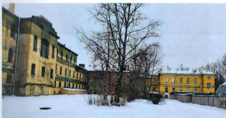
Фото 17. Фрагмент дворовых фасадов здания (Часть 1) со стороны внутриквартальной территории .
