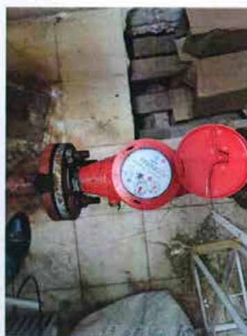
Фото 81. Приборы учета системы колодезного водоснабжения в Части 4 (на 1-ом этаже в ч.п. 1 помещения 72-Н).
