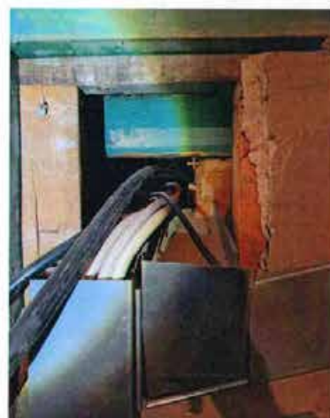
Фото 59. Ввод электрических кабелей в здание в ч.п. 1 помещения 45-Н на цокольном этаже (Часть 1).
