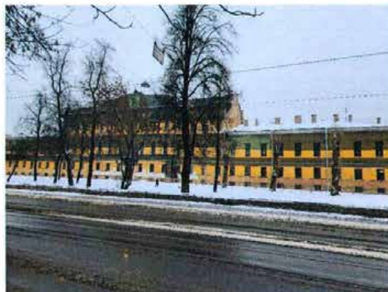
Фото 1. Фрагмент фасада здания (Часть 1) вдоль улицы Расстанная.
