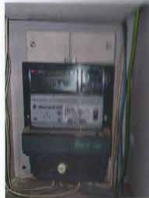
Фото 71. Приборы учета электроэнергии с группой автоматических выключателей в Части 3 (в ч.п. 1 помещения 24-Н).
