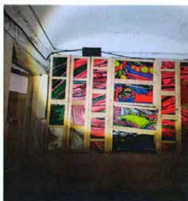
Фото 48. Фрагмент общей стены между Частью 1 и Частью 2 на 1-ом этаже в ч.п. 1 помещения 47-Н (Часть 1).
