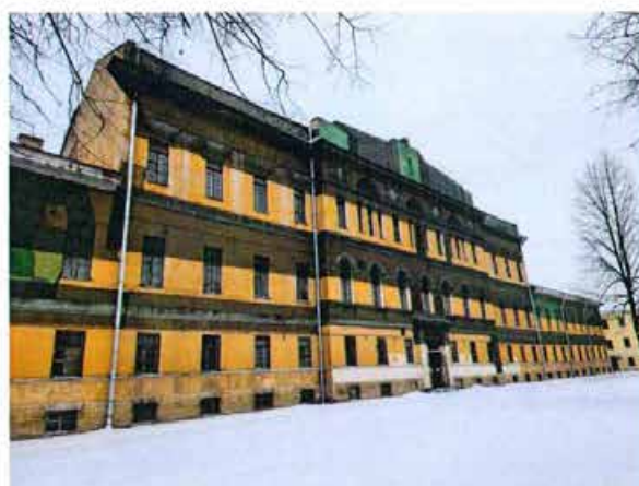
Фото 3. Фрагмент фасада здания (Часть 1) вдоль улицы Расстанная
