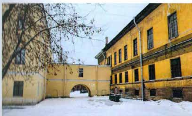
Фото 29. Фрагмент фасадов здания на границе примыкания Части 4 и Части 1.
