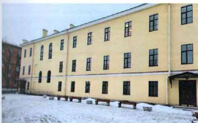
Фото 32. Фрагмент фасада здания (Часть 4) вдоль Днепровской улицы.
