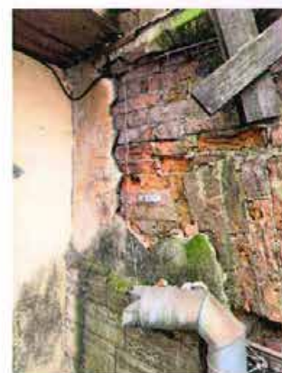
Фото 38. Конструкция наружных стен Части 1 здания с клинчатой перемычкой со стороны Днепропетровской улицы.
