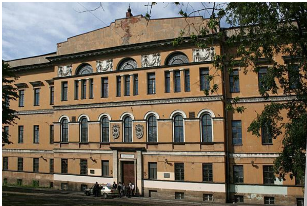
58. Бывший Николаевский дом призрения престарелых и увечных граждан Санкт-Петербургского купеческого общества. Общий вид главного здания. Фотография. 2000-е гг. www.citywalls.ru .
