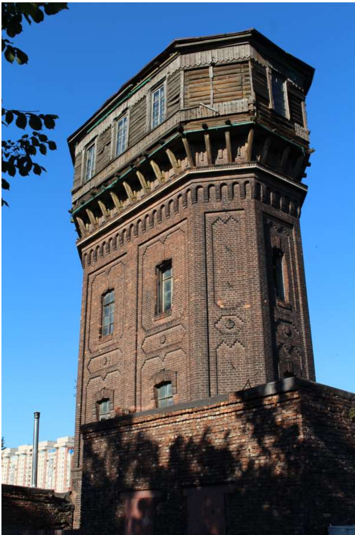
Фото 15. Вид на западный фасад башни объекта культурного наследия федерального значения «Башня водонапорная».
