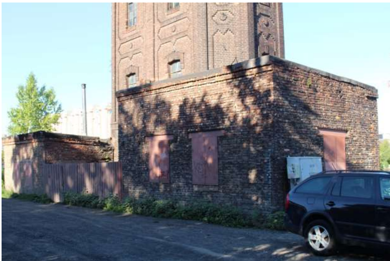
Фото 11. Фрагмент западного фасада объекта культурного наследия федерального значения «Башня водонапорная».
