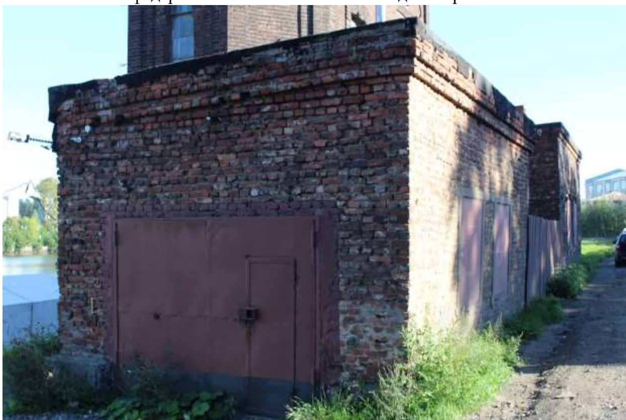
Фото 10. Фрагмент северного фасада объекта культурного наследия федерального значения «Башня водонапорная».
