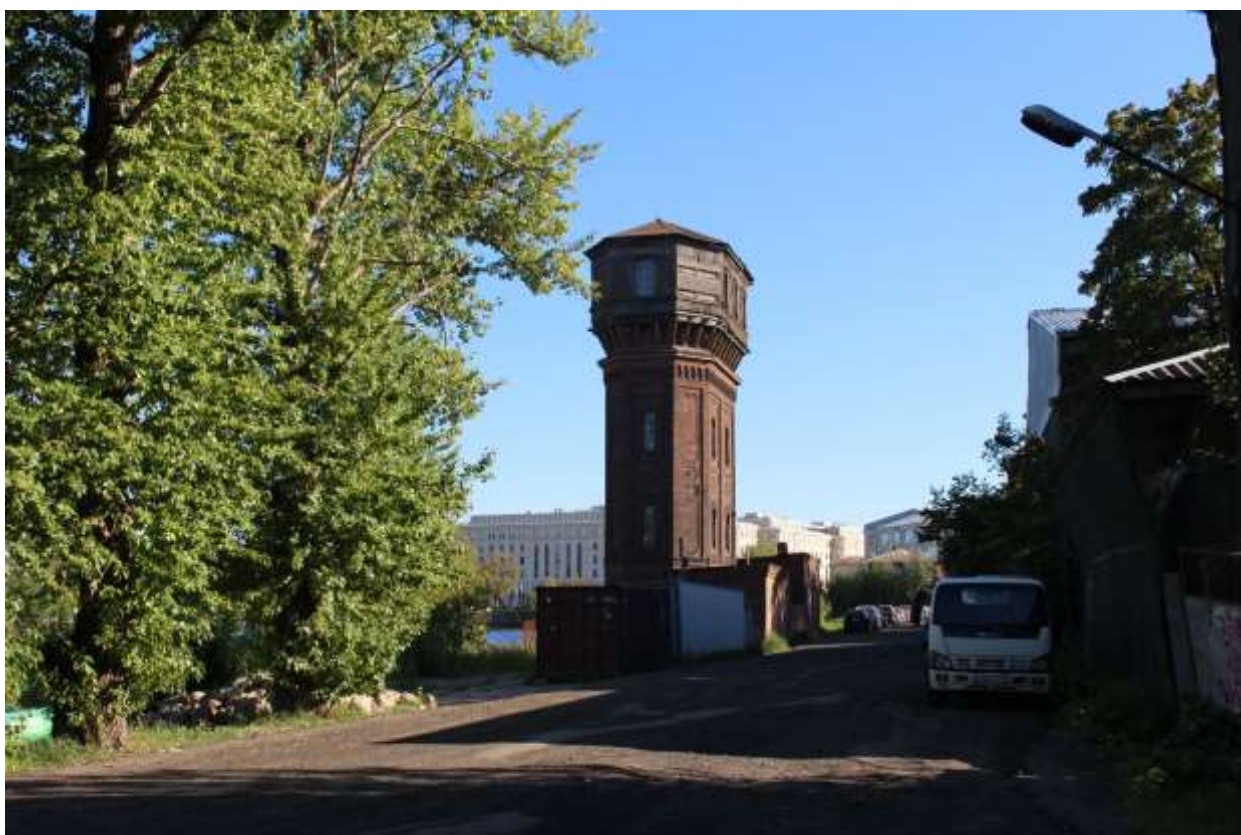
Фото 8. Вид на объект культурного наследия федерального значения «Башня водонапорная» с северо-запада.
