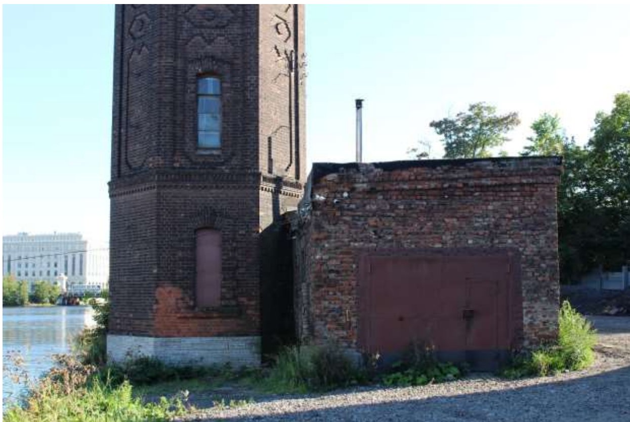
Фото 9. Фрагмент северного фасада объекта культурного наследия федерального значения «Башня водонапорная».
