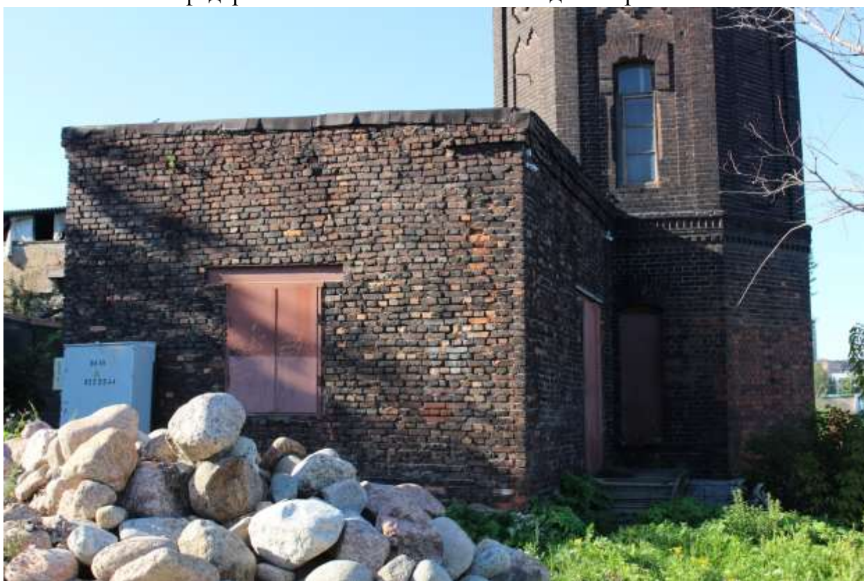
Фото 12. Фрагмент южного фасада объекта культурного наследия федерального значения «Башня водонапорная».
