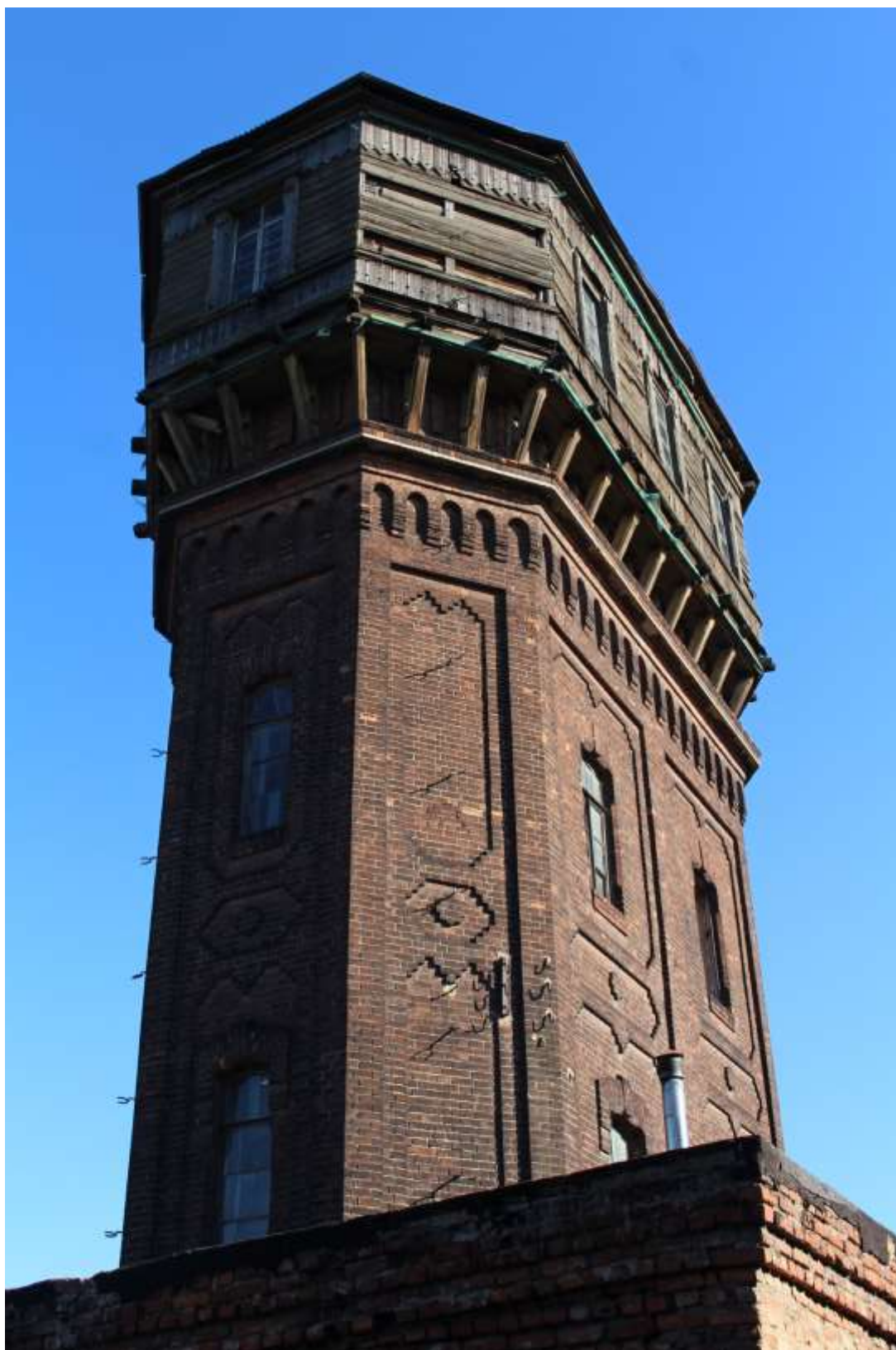
Фото 14. Вид на северный и западный фасады башни объекта культурного наследия федерального значения «Башня водонапорная».
