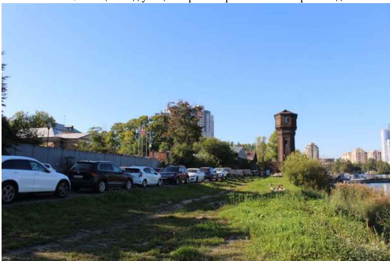
Фото 4. Вид на объект культурного наследия федерального значения «Башня водонапорная» с юго-востока.
