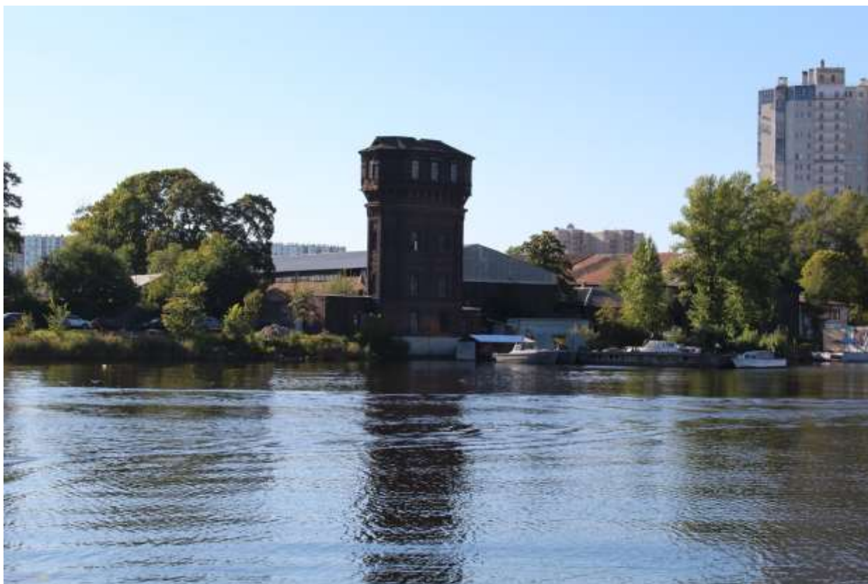
Фото 19. Вид на восточный фасад объекта культурного наследия федерального значения «Башня водонапорная» с восточного берега Бассейна большого.
