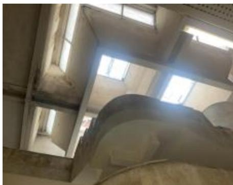
входные зоны и лестничные марши в вестибюле – местоположение, габариты, материал (железобетон), материал отделки (фактурный известняк, облицовка полов плитами с наливным покрытием, битая керамическая плитка), архитектурно-художественное решение, тип (распашные лестницы);
