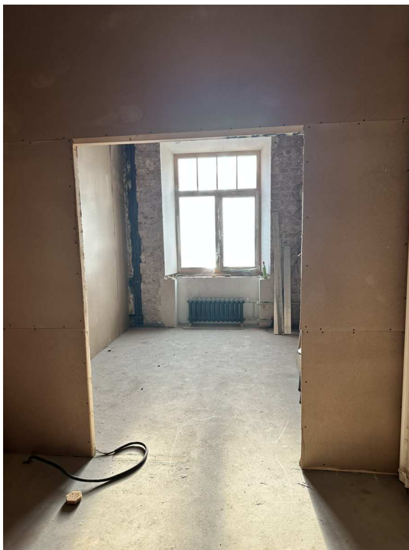
6.Фрагмент интерьера коридора и помещение №12;
