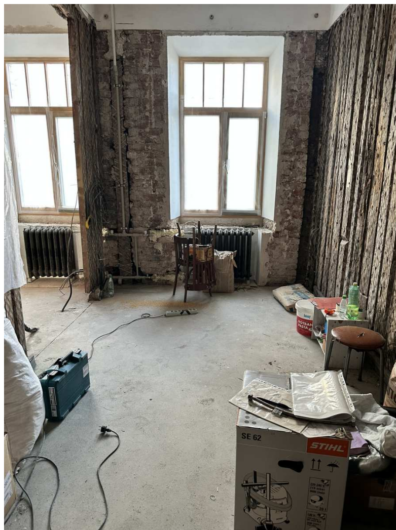
12. Фрагмент интеръера помещение №4;
