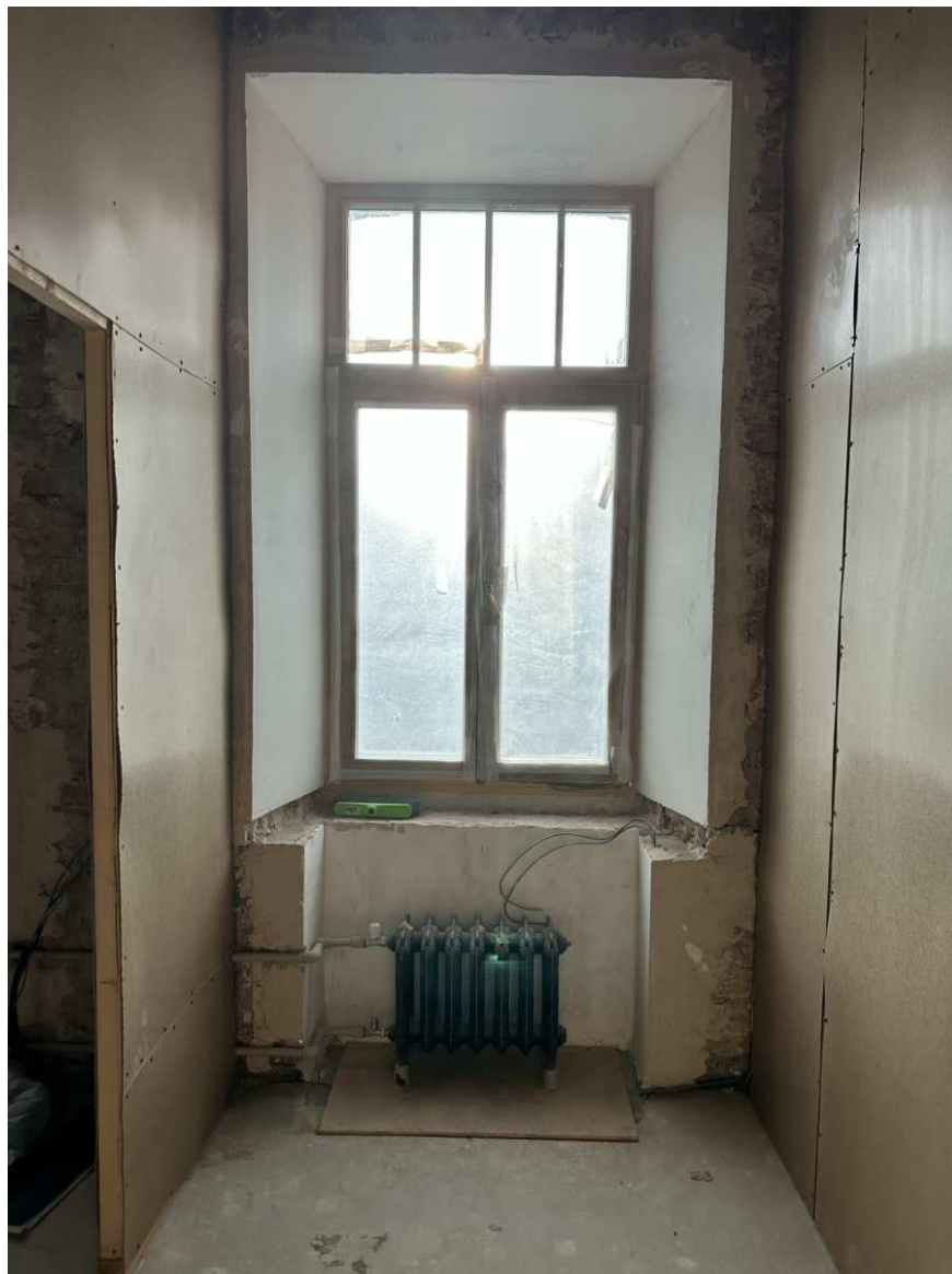
15. Фрагмент интерьера комнаты помещение №11;
