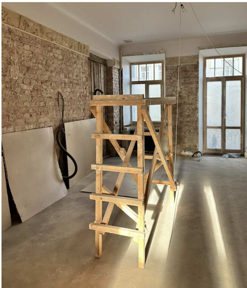
8. Фрагмент интерьера комнаты (помещение №2);
