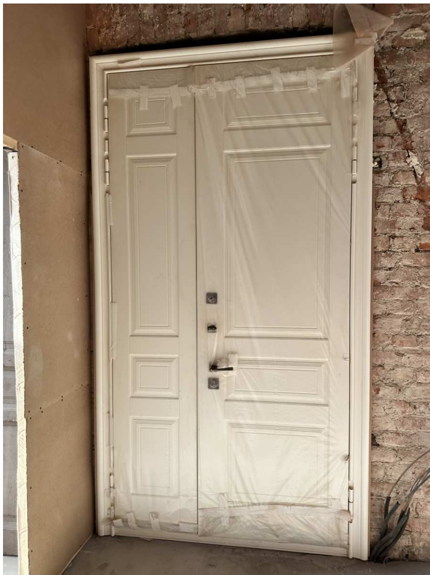
5. Вид на входную дверь в квартире;
