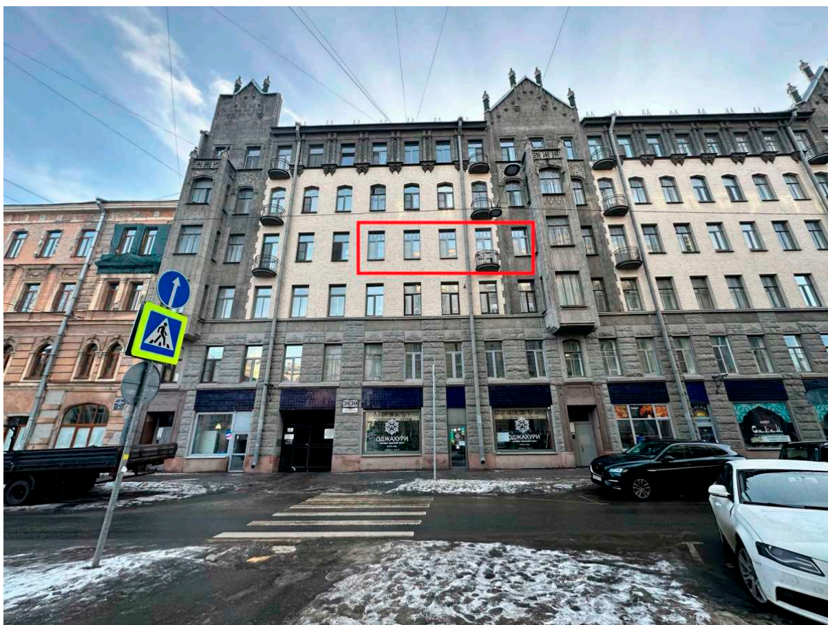
2. Общий вид на главный фасад здания и окна квартиры;
