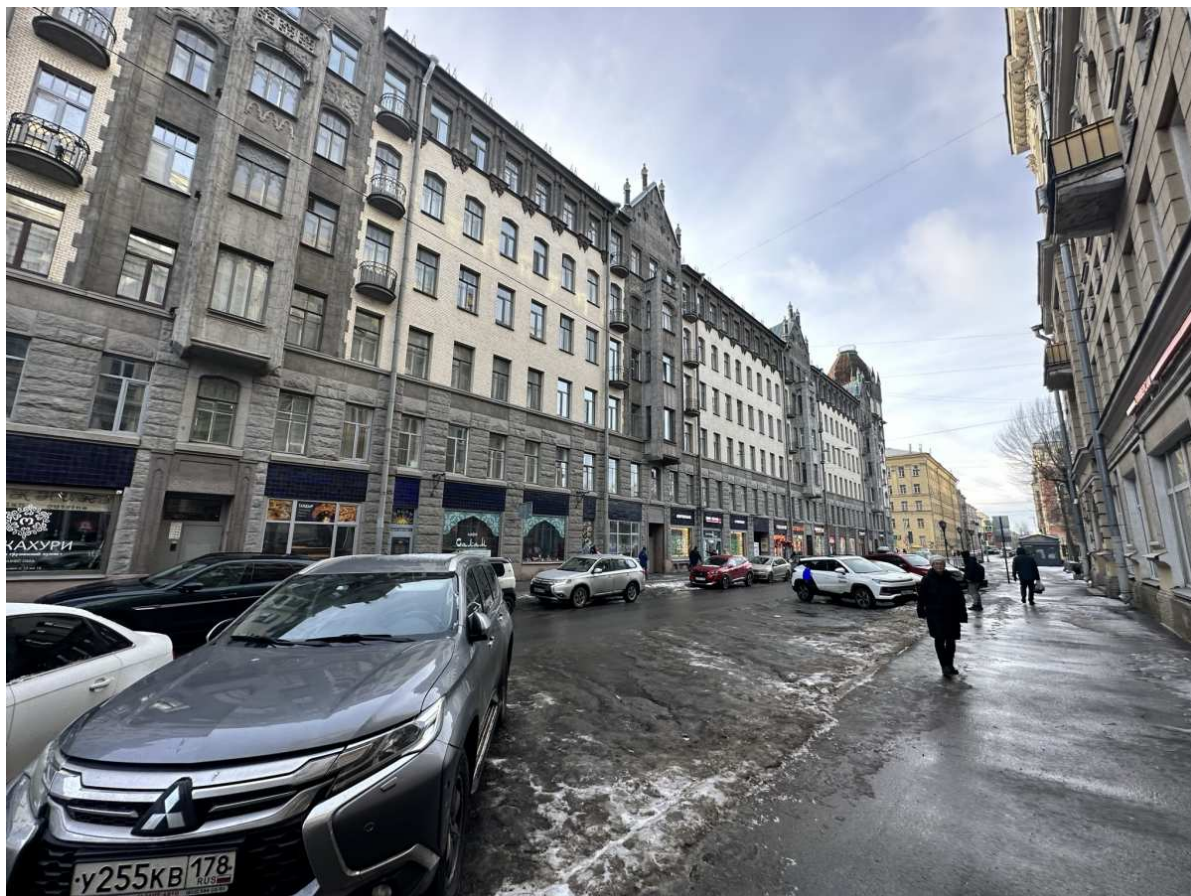
1. Общий вид на главный фасад здания
