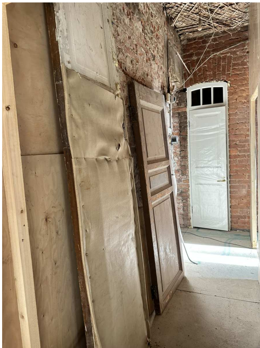
21. Фрагмент интерьера коридора помещения №8;
