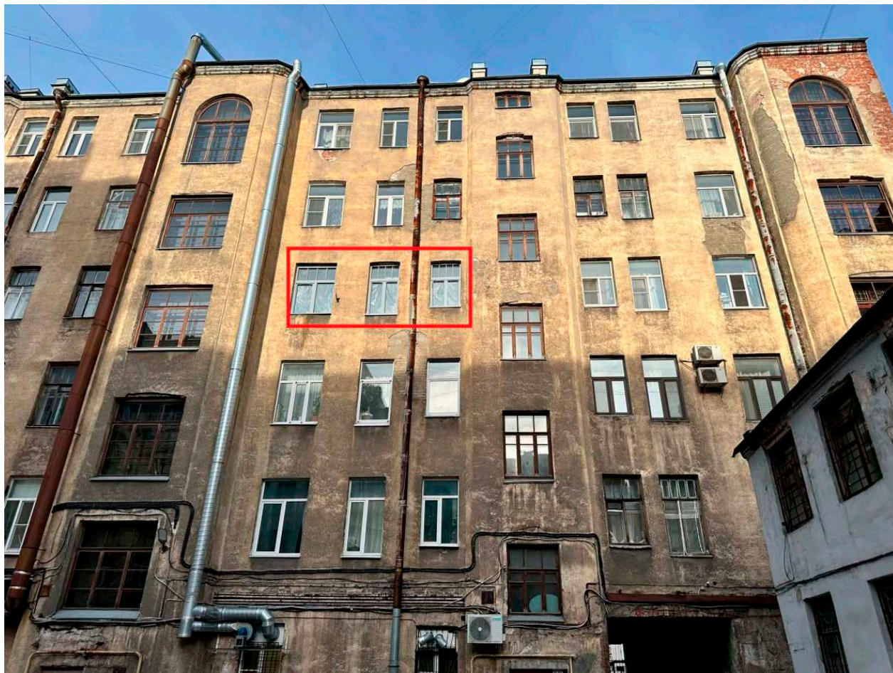
3. Общий вид на дворовой фасад здания и окна квартиры;
