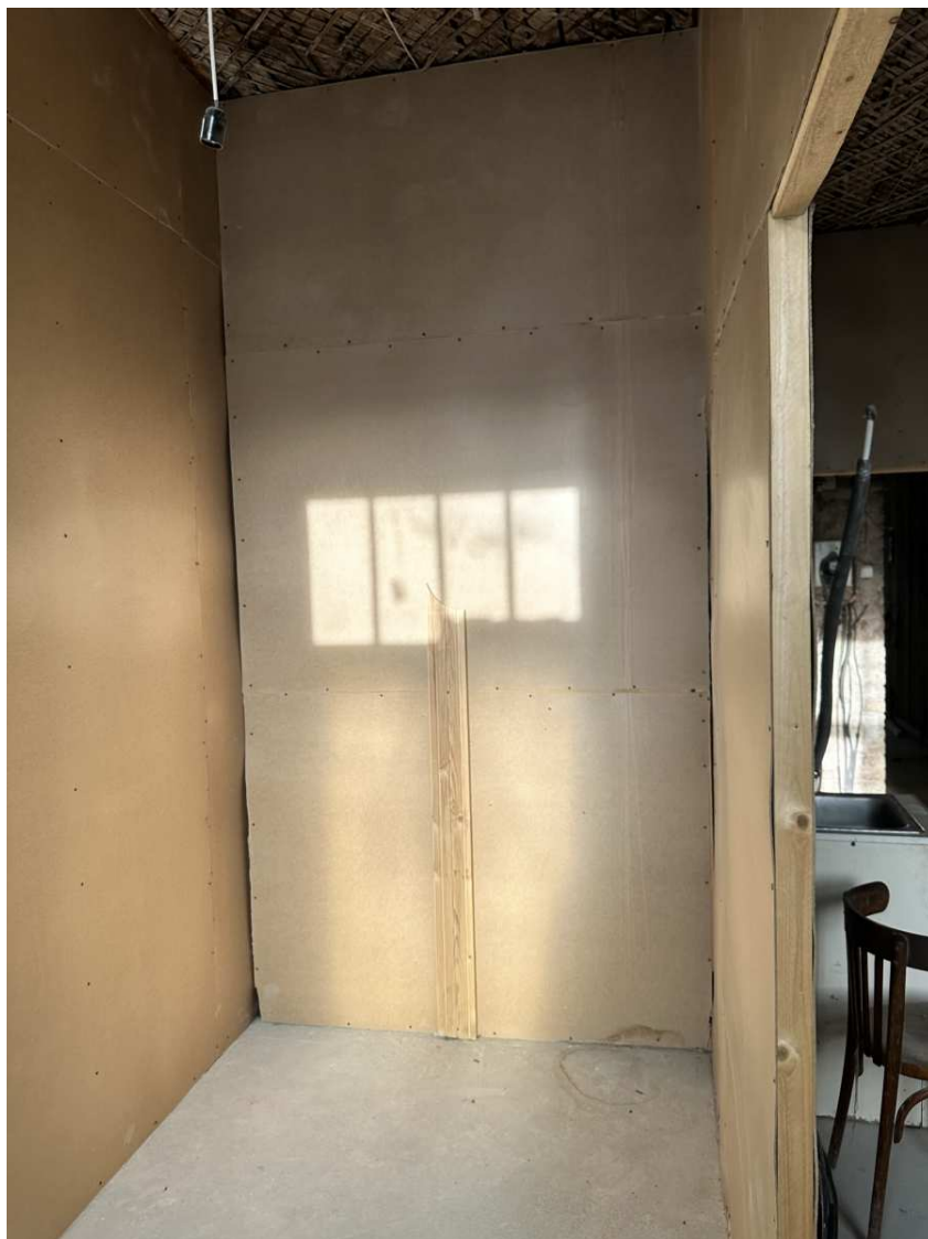
16. Фрагмент интерьера комнаты помещение №11;
