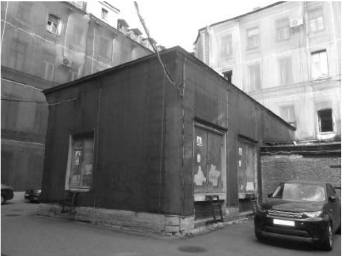
Фото 6. Фрагмент дворового фасада и внутренней территории объекта культурного наследия по Замятину переулку. Вид на ТП ОКН Дом Утина И. Здесь с 1860 г. жил и в 1911 г. умер историк, издатель журнала "Вестник Европы" Стасюлевич М.М. Здесь с 1893 г. жил и в 1895 г. умер ученый-машинистроитель Вышнеградский И.А. Здесь в 1884-1888 гг. останавливался скульптор Антокольский М.М.
