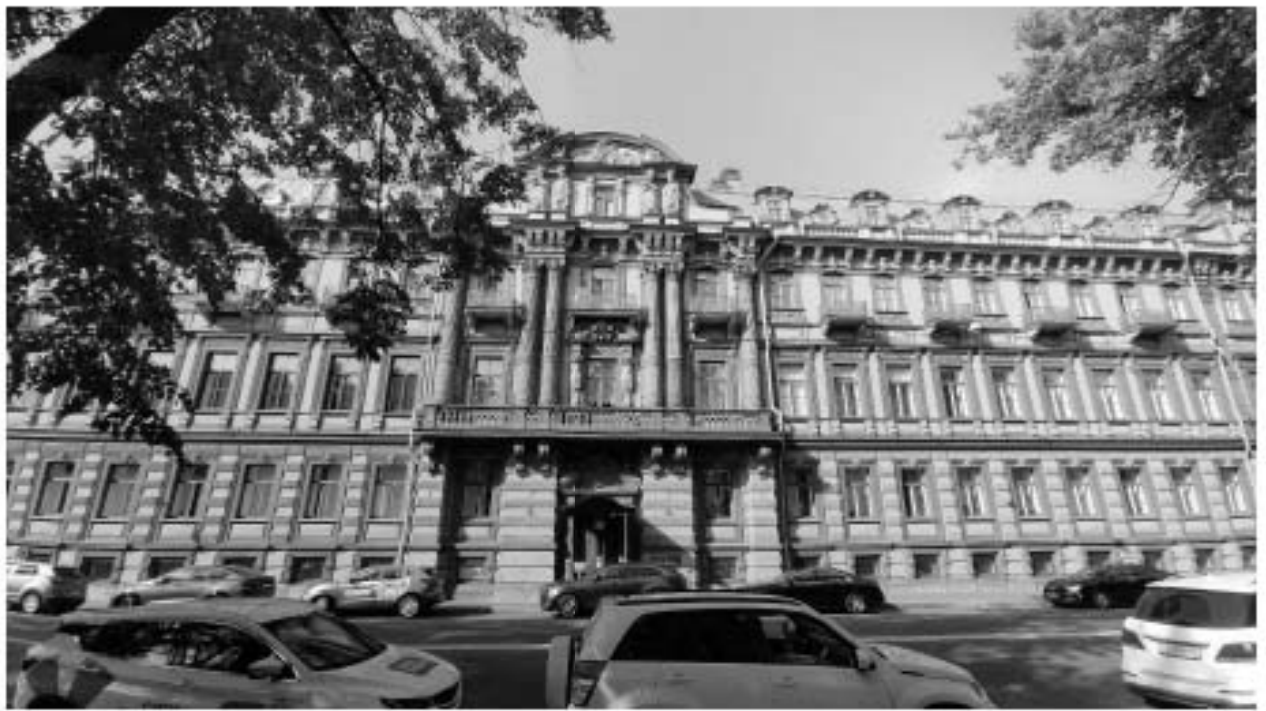
Фото 1. Фрагмент лицевого фасада объекта культурного наследия по Конногвардейскому бульвару. ОКН Дом Утина И. Здесь с 1860 г. жил и в 1911 г. умер историк, издатель журнала "Вестник Европы" Стасюлевич М.М. Здесь с 1893 г. жил и в 1895 г. умер ученый-машиностроитель Вышнеградский И.А. Здесь в 1884-1888 гг. останавливался скульптор Антокольский М.М.
