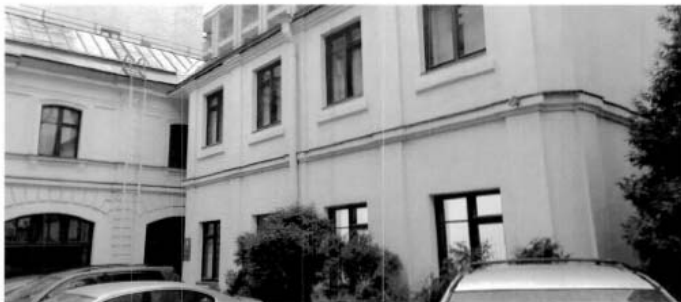
3. Вид на западный фасад дворового флигеля объекта культурного наследия
