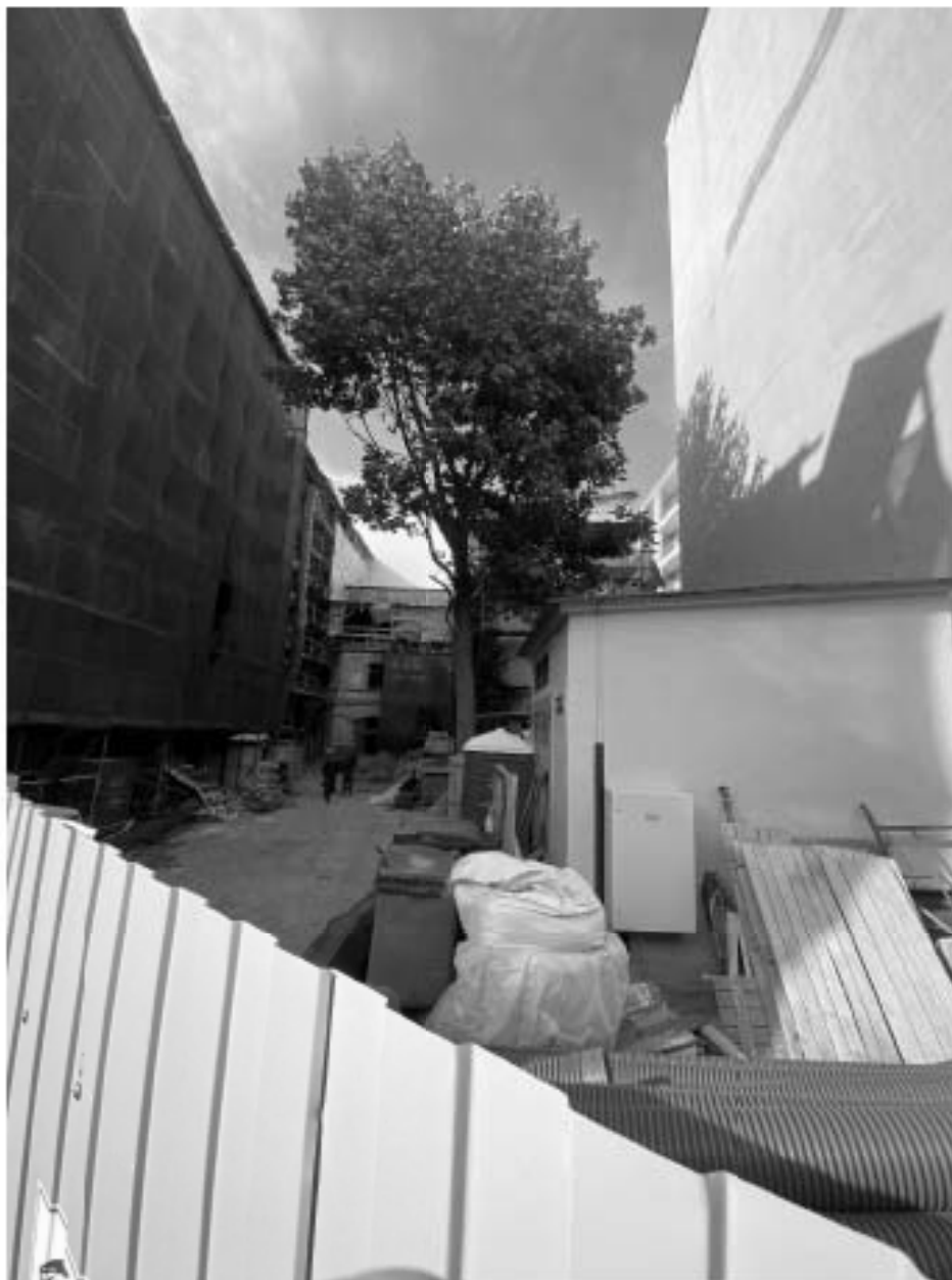
Фото 12. Объект культурного наследия федерального значения «Дом Кочубея М.В.», расположенного по адресу: г. Санкт-Петербург, Конногвардейский бульвар, д.7, лит. А
