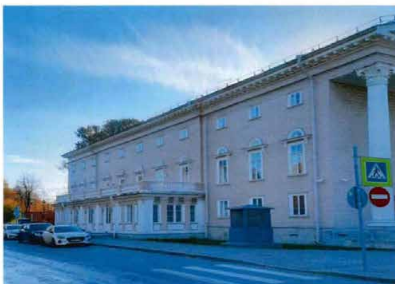
Фото 6: северный лицевой фасад.
