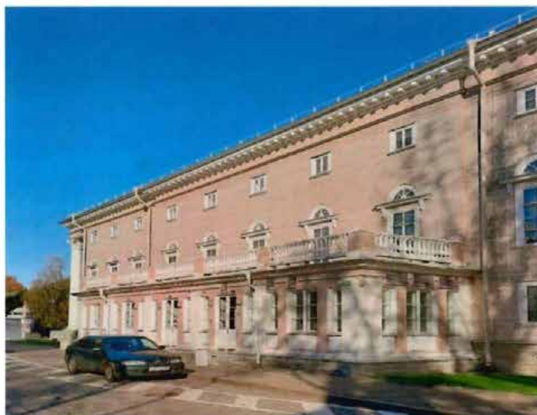
Фото 4: фрагмент объекта культурного наследия (южный лицевой фасад).
