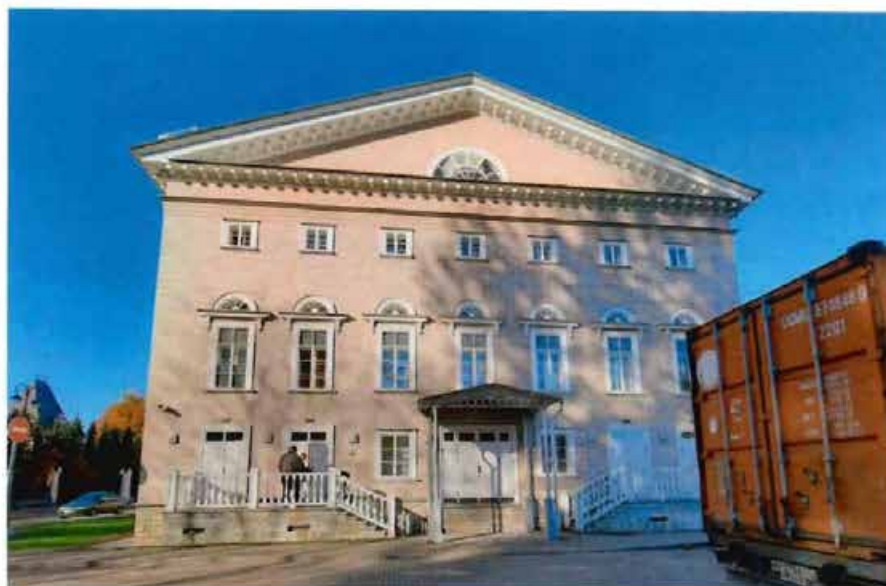
Фото 5: восточный лицевой фасад.
