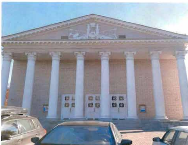
Фото 1: западный лицевой фасад (главный вход в театр).
