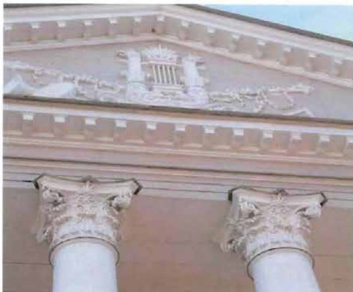
Фото 3: фрагмент объекта культурного наследия (западный лицевой фасад): гипсовые капители колонн, декорированы акантовыми листьями, мелкими волютами, пальметами; гипсовая фронтовая композиция на гладком фоне деревянной обшивки, в виде лиры, декорированной акантом, прорезной звездой и пальметтой, увенчанной головками драконов, фланкирована тирсами, увитыми плющем, с театральными масками и музыкальными инструментами (труба, бубен, флейта пана).
