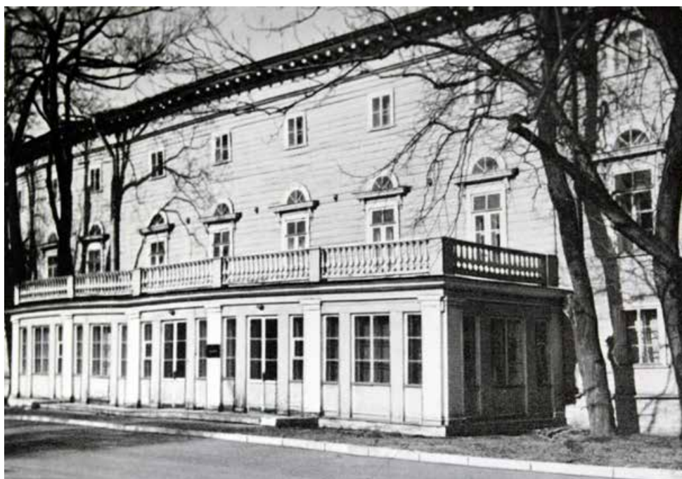
44. Каменноостровский театр. Фотография. 1980-е г. https://www.citywalls.ru/
