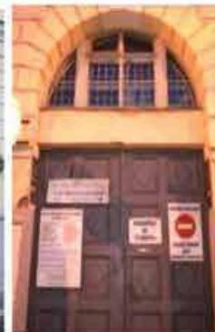
дверной проем парадного входа – историческое местоположение (по центральной оси), габариты, конфигурация (с полуциркульным завершением), оформление (профилированный наличник, архивольт на импостах); исторические конструкция (двустворчатое, глухое, с полуциркульной, радиально остекленной фрамугой), оформление (профилированные фигурейные филенки), материал (дуб), цвет (цвет натурального дерева) заполнения дверного проема;
