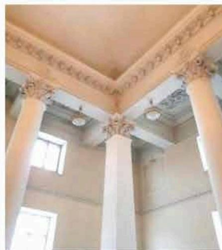
подшивка антаблемента: разделена на глубокие профилированные кессоны с рельефными лепными композициями в виде вихревой розетки из листьев аканта с боковыми рокайльными завитками в поле и периметральной порезкой в виде поясков из иоников и листьев аканта;
