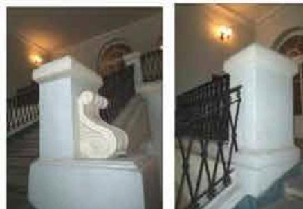
двухмаршевая межэтажная лестница с известняковыми ступенями на косоурах (помещение 1-Н(18), с литым ограждением, рисунок ограждения (вертикальные стойки с перехватами и стилизованные балясины в нижнем уровне, вертикальные стойки со сквозным растительным ажурным орнаментом),
