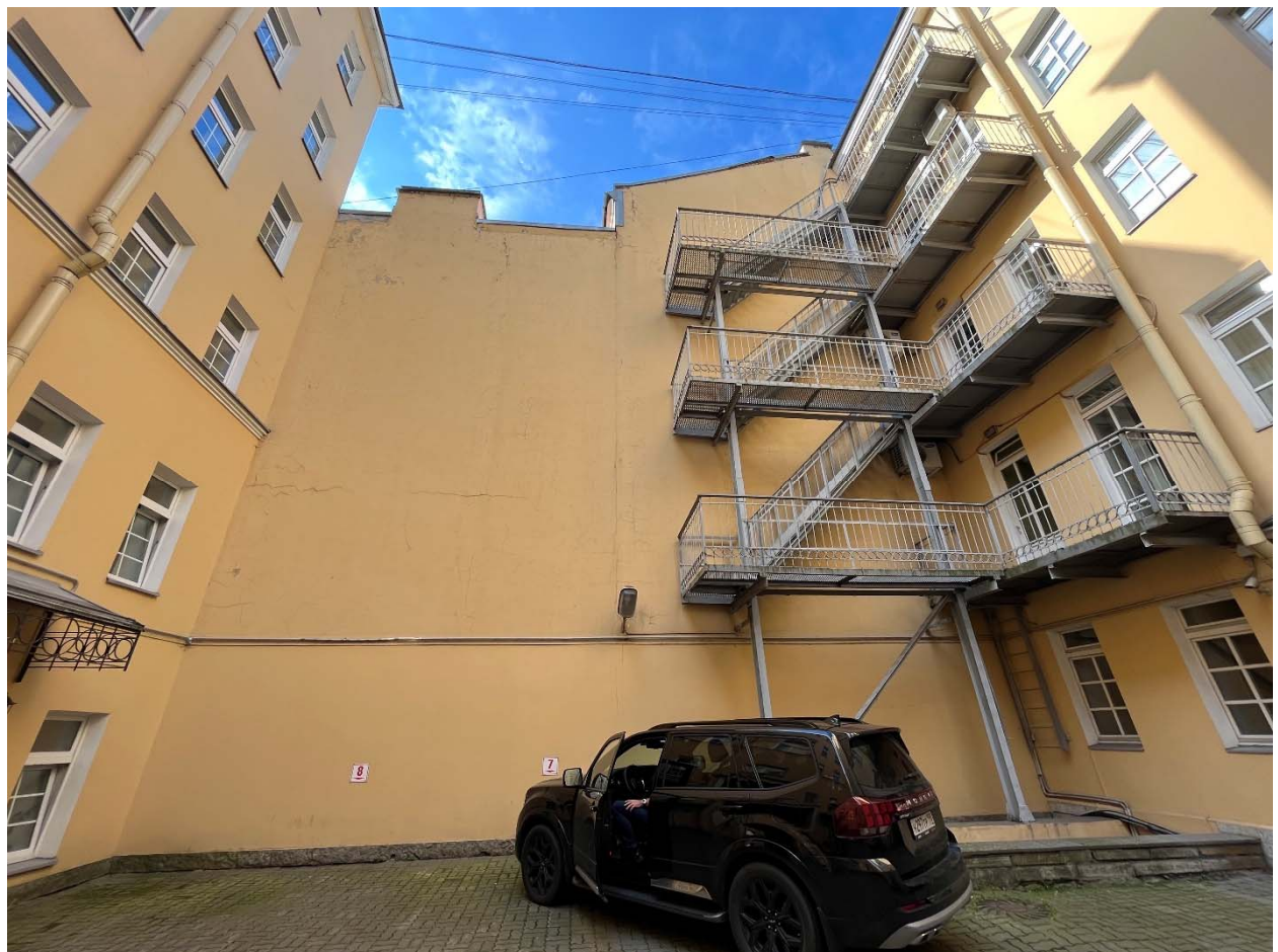
Фото №15. Фрагмент северного дворового фасада.
