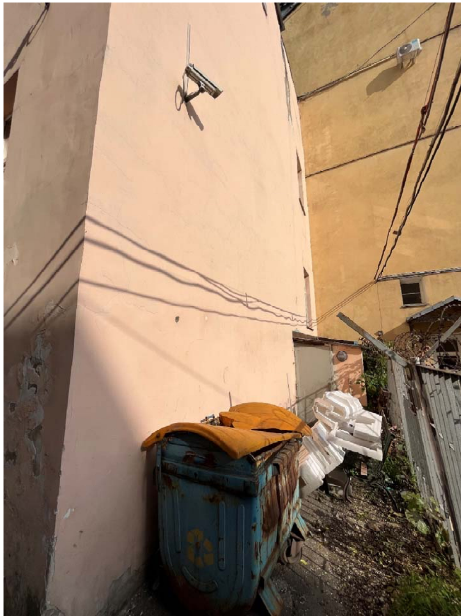
Фото №13. Фрагмент восточного (торцевого) дворового фасада.
