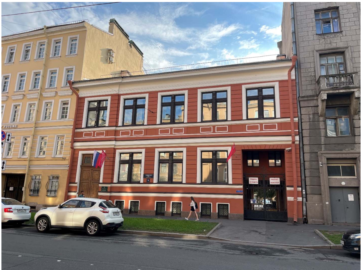
Фото №1. Лицевой западный фасад, общий вид.
