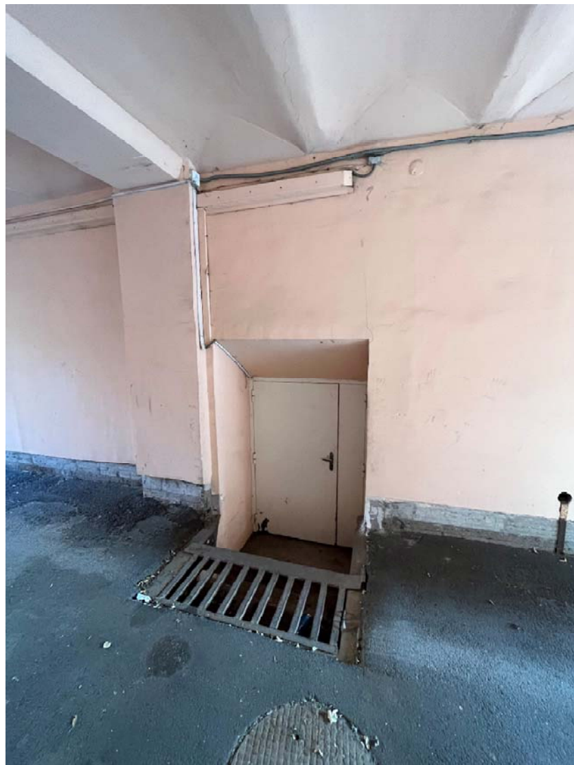
Фото №5. Воротный проезд, приямок, вход в подвал.
