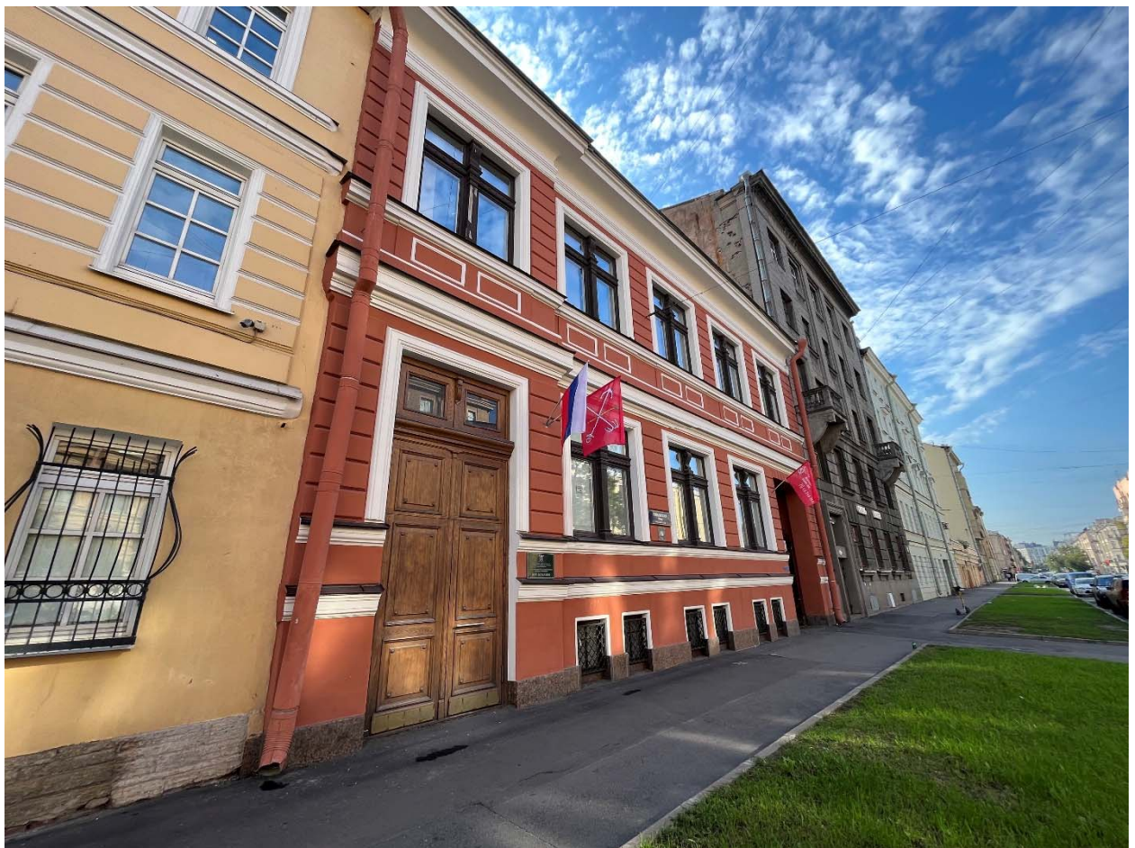
Фото №3. Лицевой западный фасад, общий вид.
