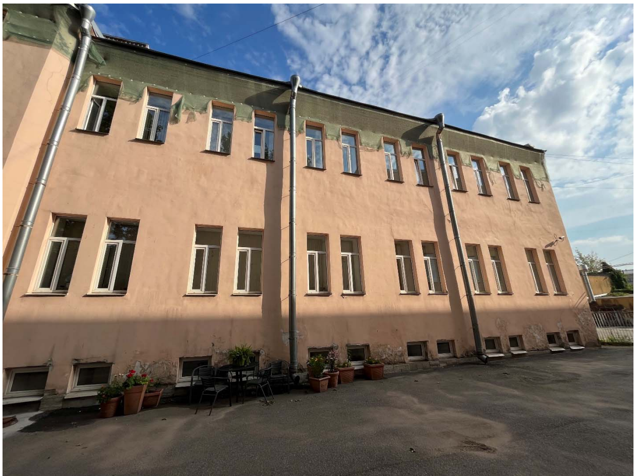
Фото №12. Фрагмент южного дворового фасада, вход здание.
