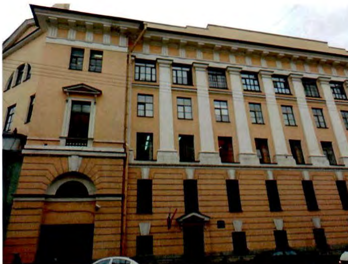
1. Фрагмент южного фасада.
