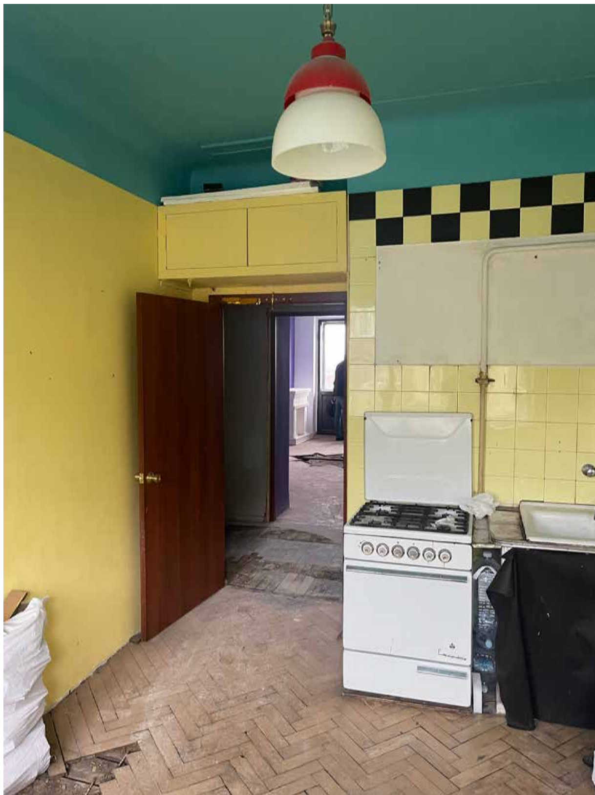
4. Фрагмент интерьера кухни (помещение 2/12.8);
