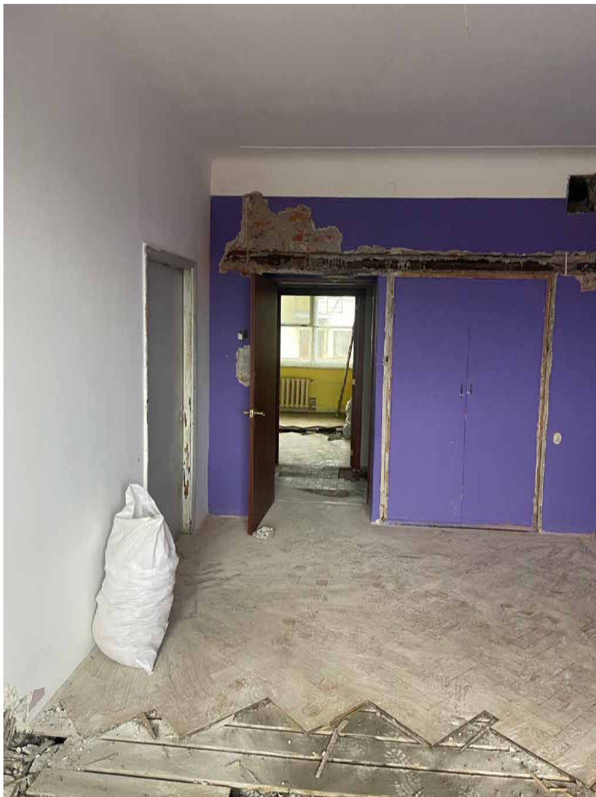
10. Фрагмент интерьера комнаты (помещение 7/17.7);
