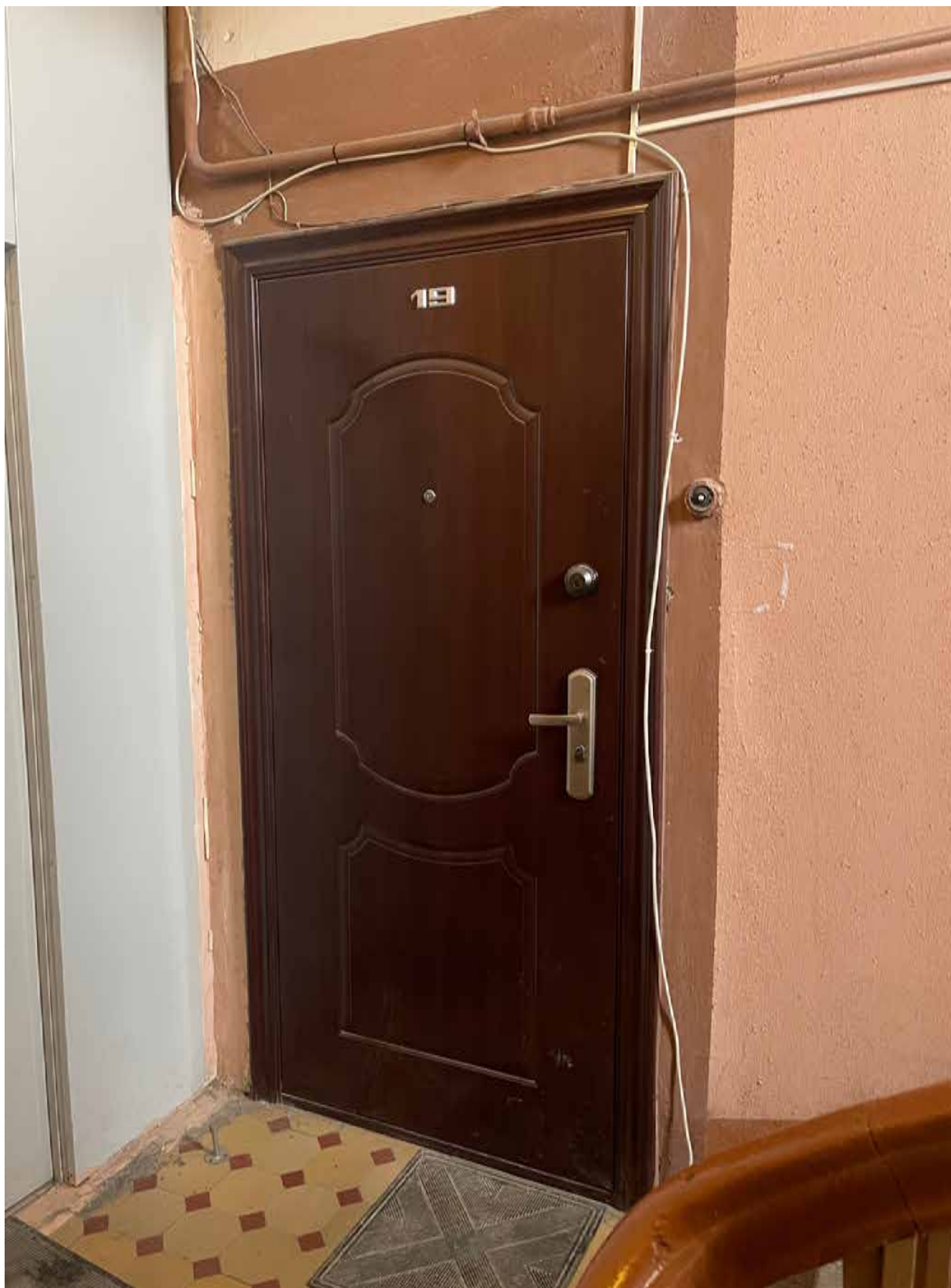
18. Вид на входную дверь в квартиру №19;
