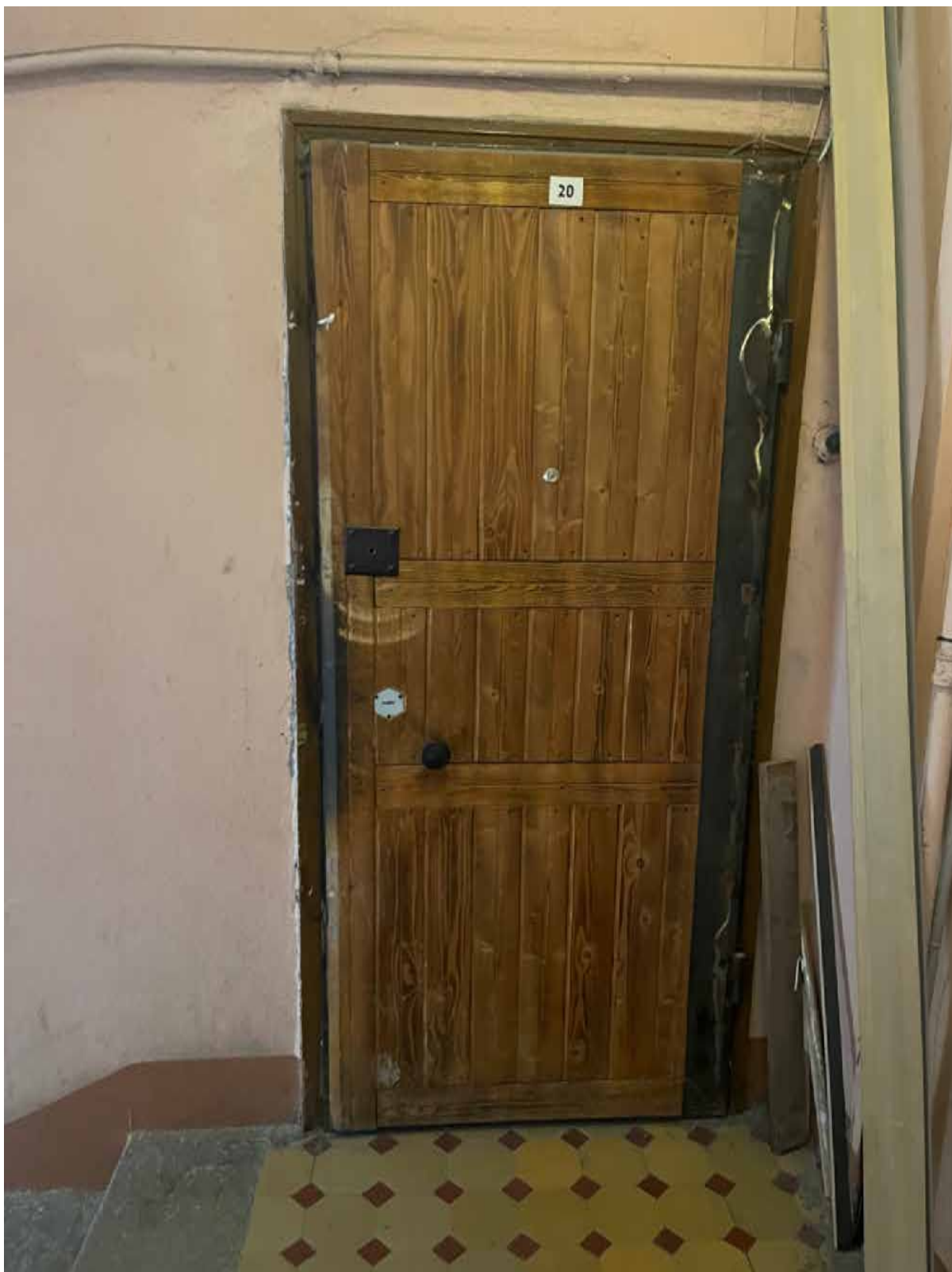
1. Вид на входную дверь в квартиру №20;
