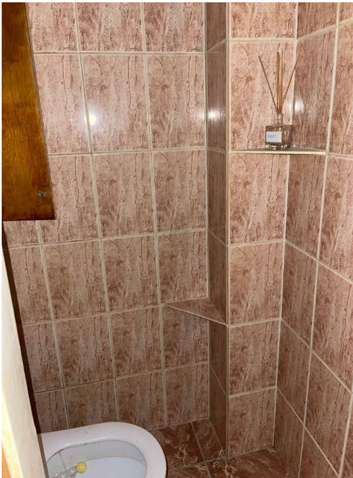
26. Фрагмент интерьера туалета (помещение 3/1.3);
