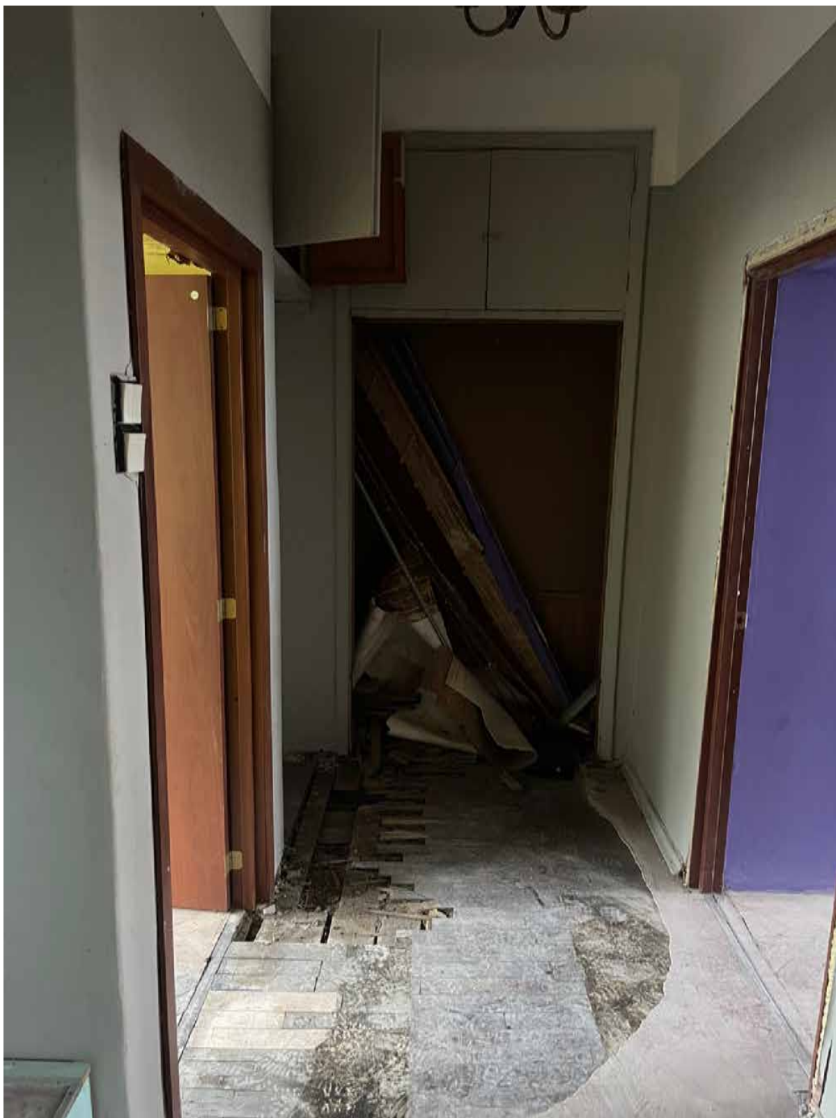
2. Фрагмент интерьера коридора (помещение 1/8.2);
