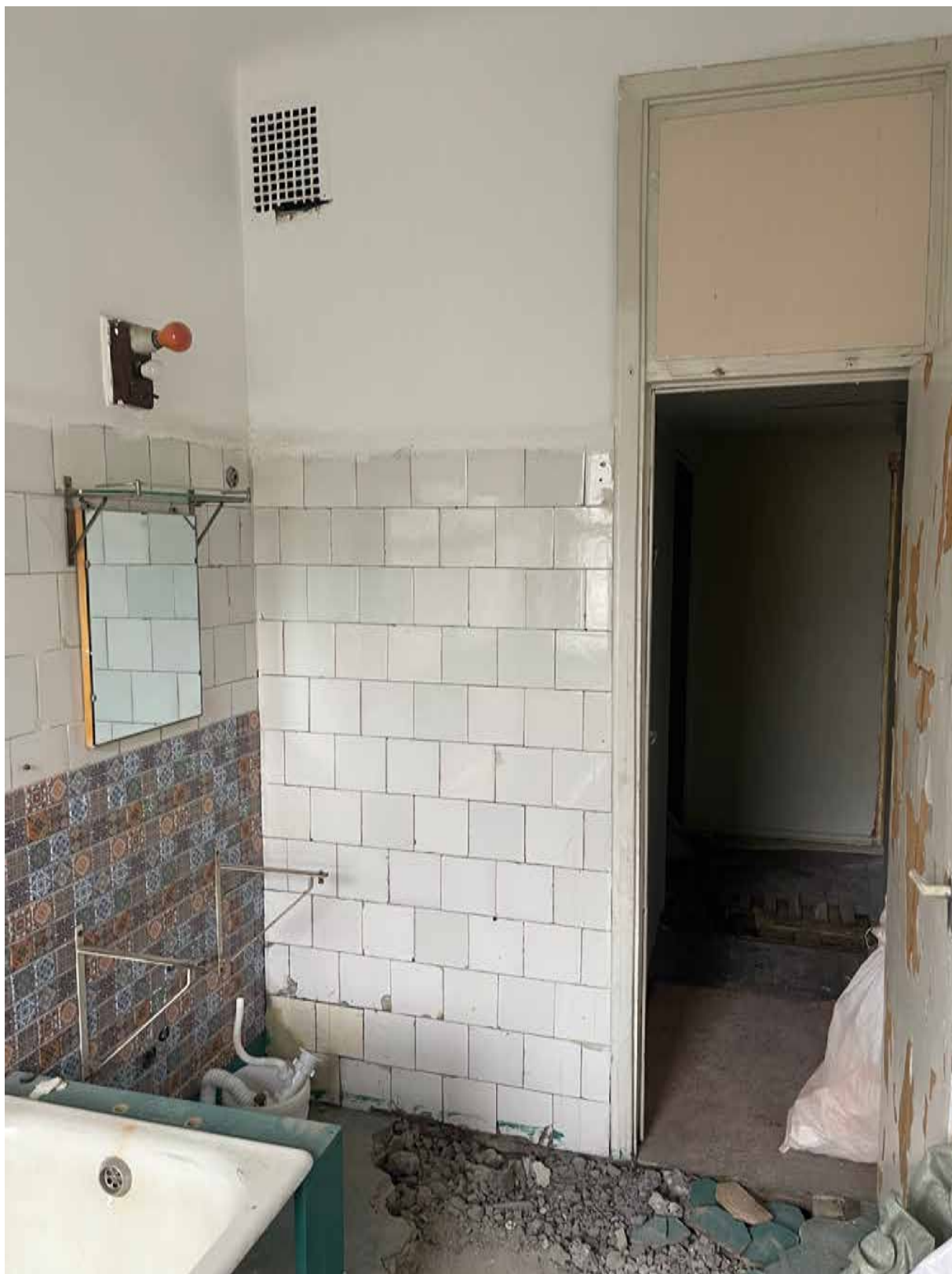
8. Фрагмент интерьера ванной (помещение 3/5.5);
