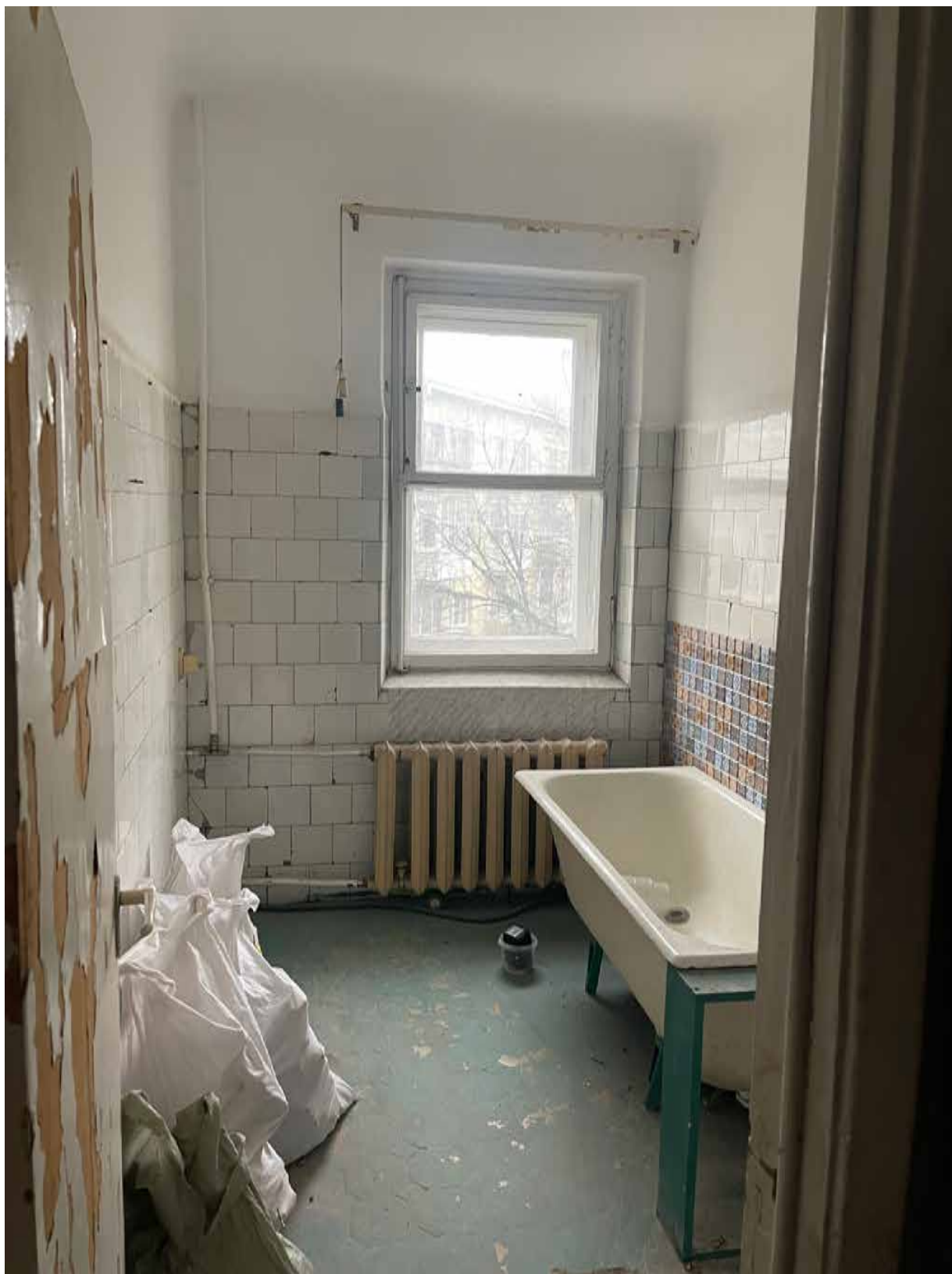
7. Фрагмент интерьера ванной (помещение 3/5.5);
