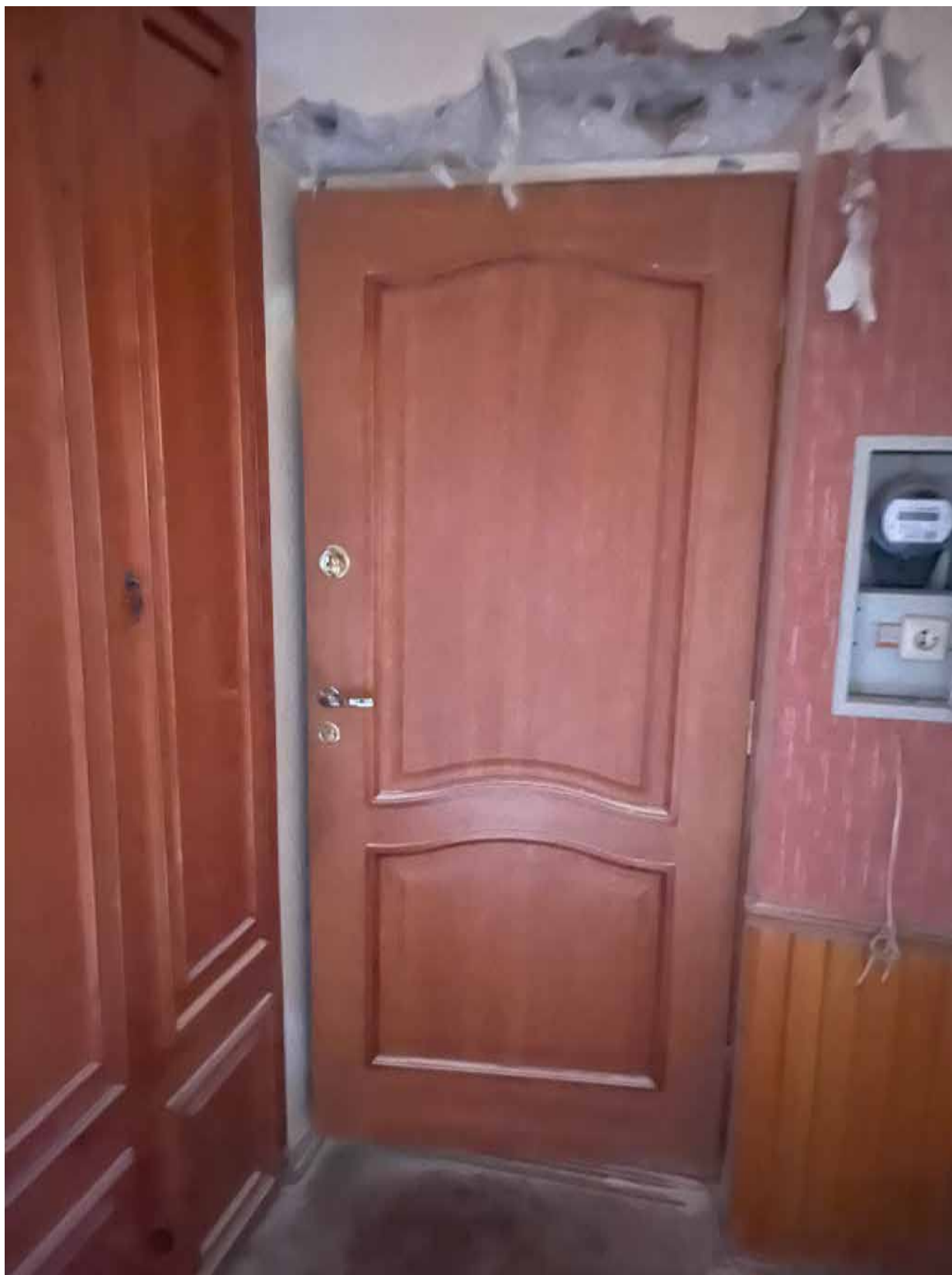
19. Вид на входную дверь в квартире №19;
