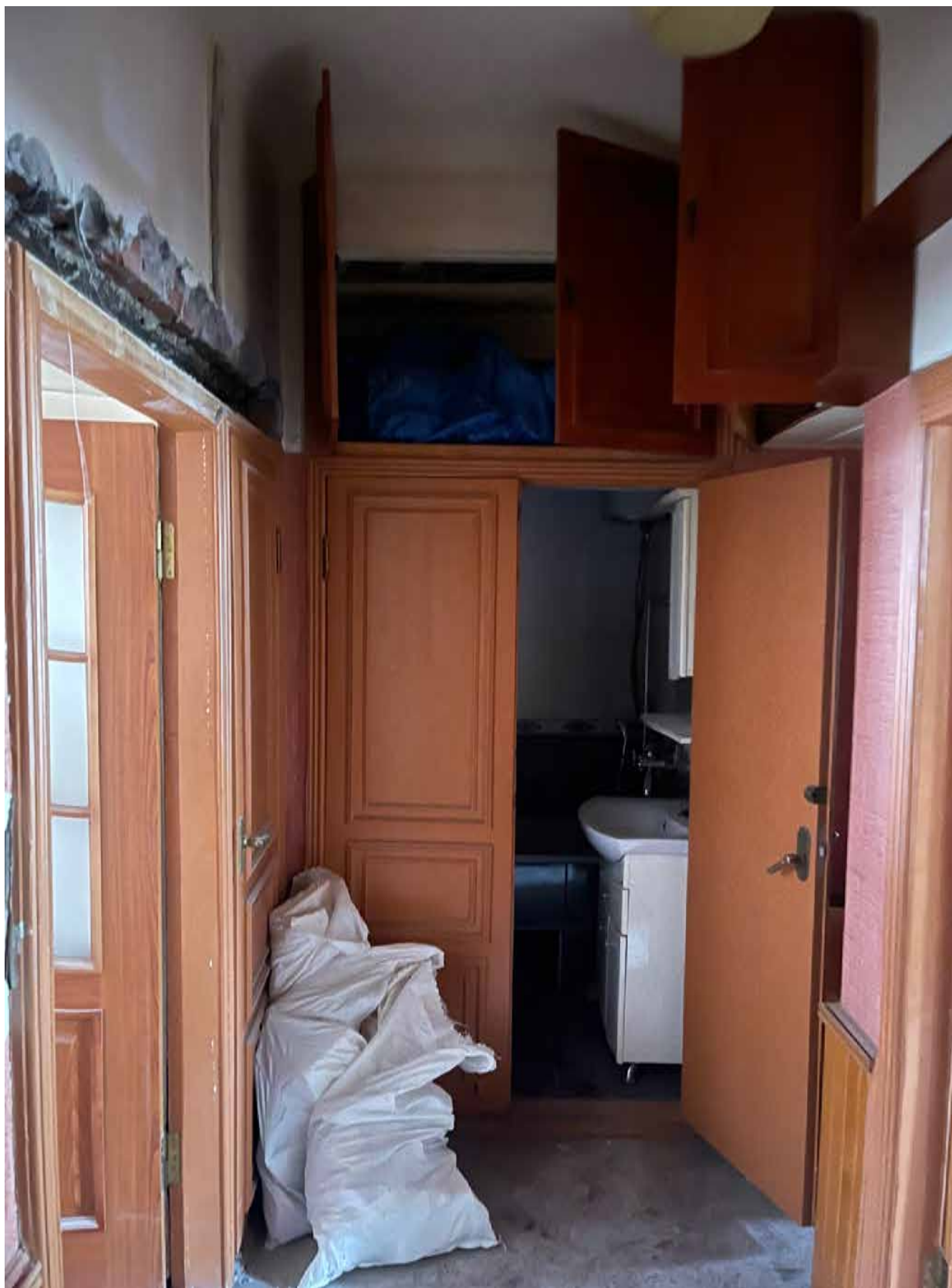
20. Фрагмент интерьера коридора (помещение 1/7.7);
