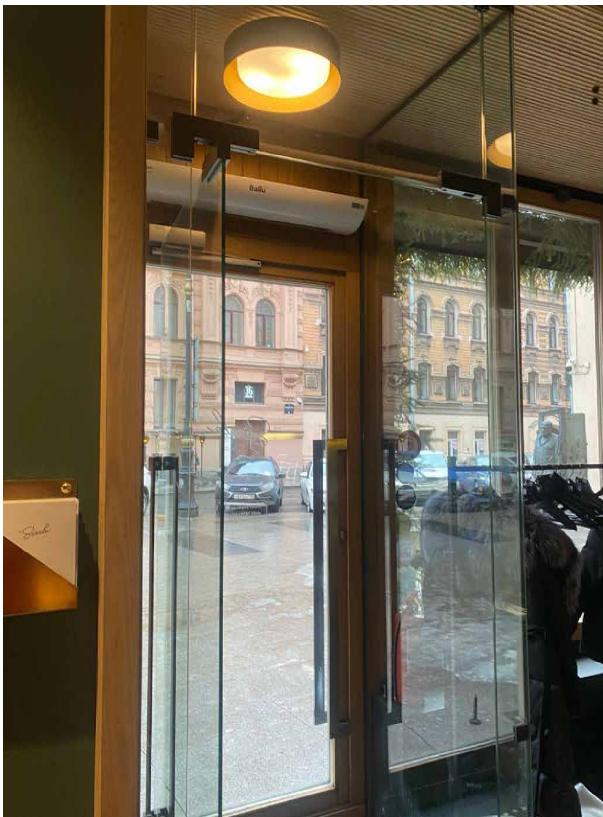
3. Вид на входную дверь в помещение 3-Н;
