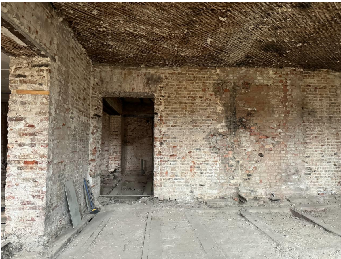
Фото 7. Вид на помещения №№ 6 и 7.
