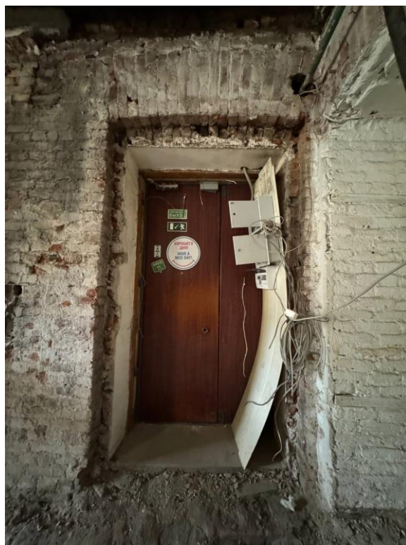
Фото 2. Вид на входную дверь.
