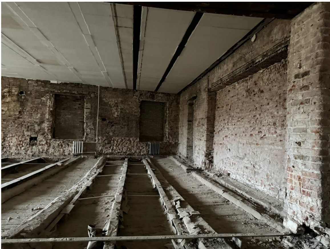
Фото 4. Вид на помещения №№ 8 и 9.
