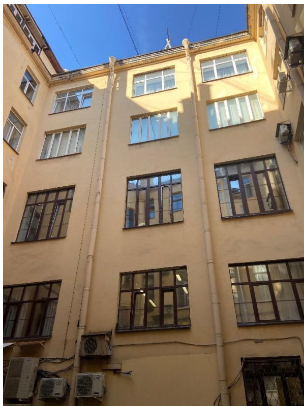
Фото 9. Вид на дворовый фасад.
