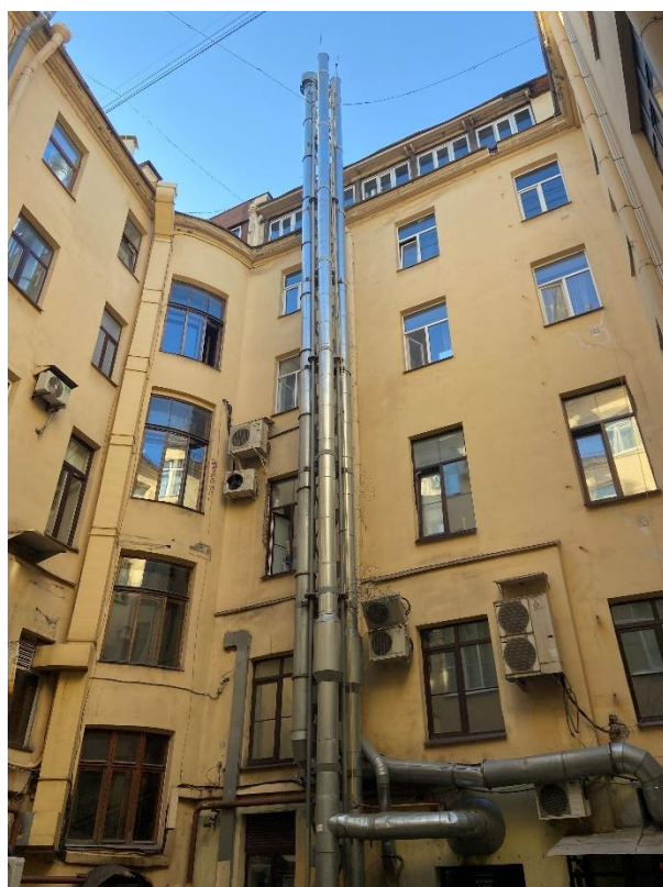
Фото 7. Вид на дворовый фасад.
