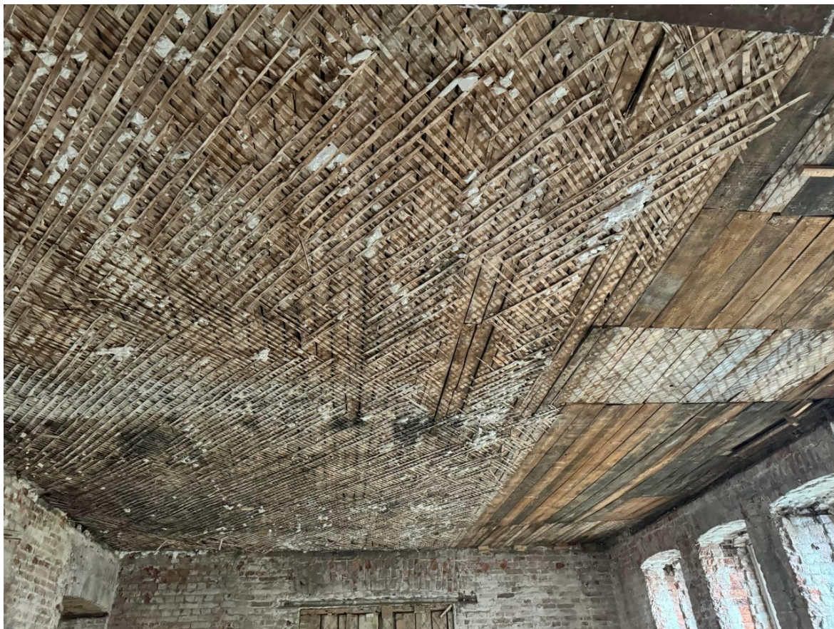
Фото 6. Перекрытие в помещениях №№ 8 и 9.
