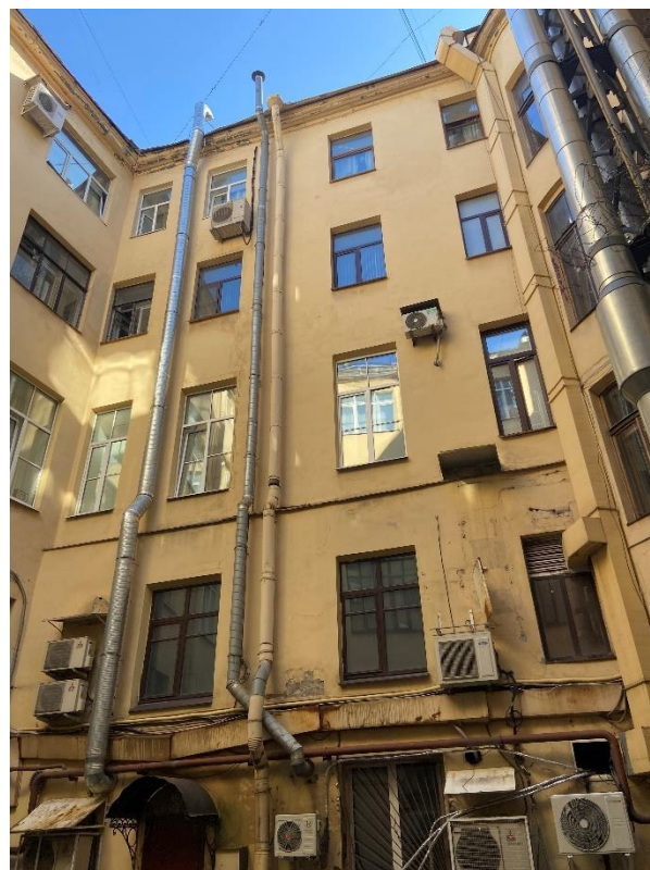
Фото 10. Вид на дворовый фасад.
