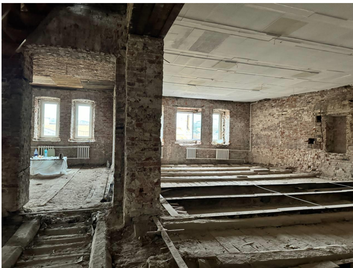
Фото 5. Вид на помещения (частично) №№ 6, 7 и №№ 8, 9.
