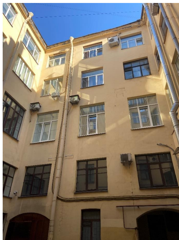
Фото 8. Вид на дворовый фасад.
