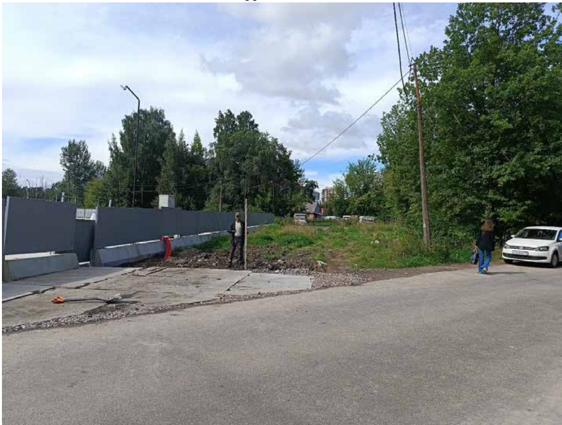
Рис. 14. Усть-Славянка-2024. КН_78:12:0721202:1395. Точка фотофиксации 1, вид с востока.
