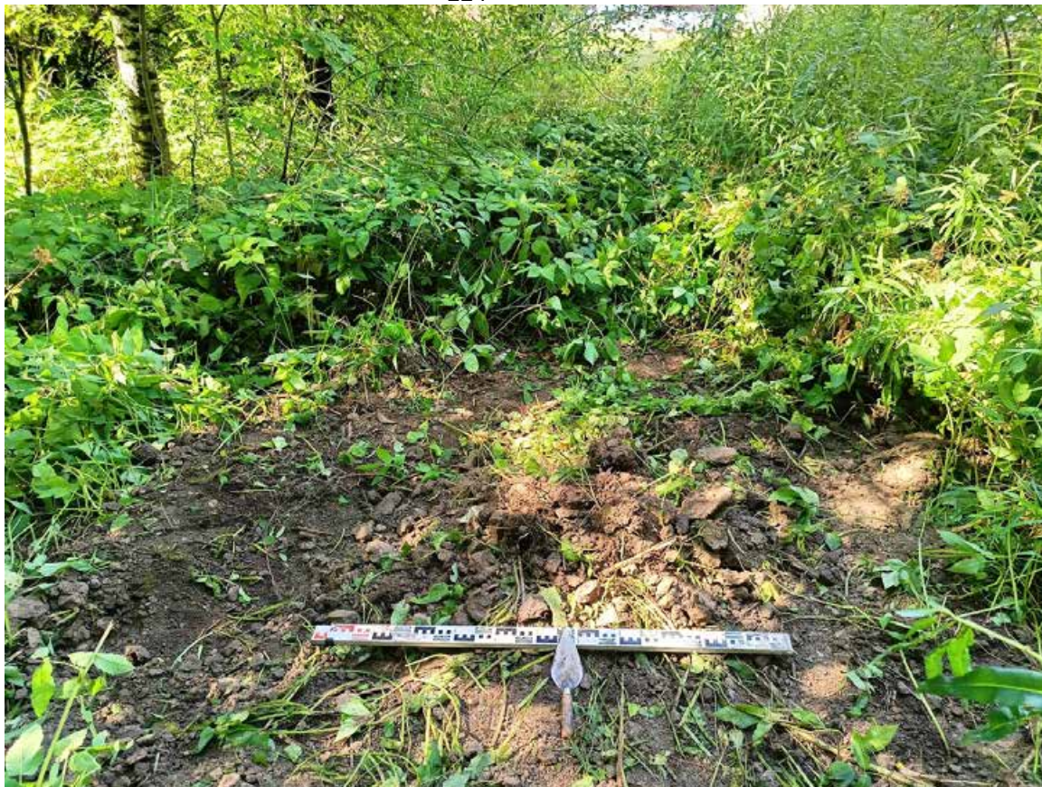
Рис. 50. Усть-Славянка-2024. КН_78:12:0721202:1395. Шурф 3 после рекультивации, вид с юга.
