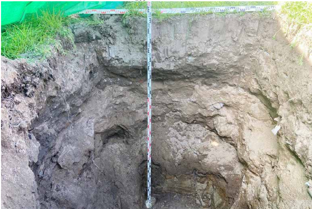
Рис. 55. СПб-2024. Красногвардейский р-н. Земельный участок: 78:11:0006047:2514. Шурф №3. Стратиграфия. Северная стенка. Вид с юга.
