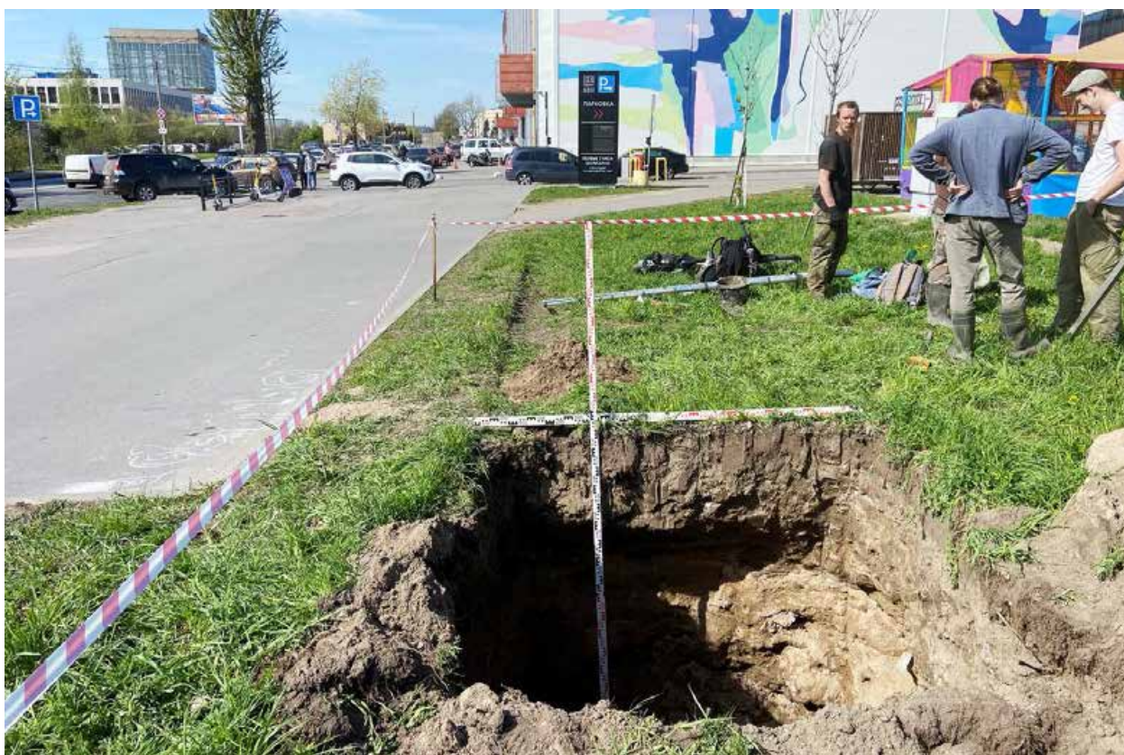
Рис. 58. СПб-2024. Красногвардейский р-н. Земельный участок: 78:11:0006047:2514. Шурф №2. Общий вид местоположения шурфа на этапе завершения работ. Вид с юга.
