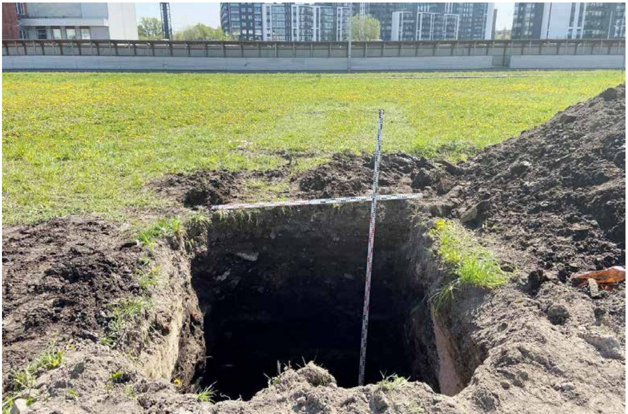
Рис. 37. СПБ-2024. Красногвардейский р-н. Земельный участок: 78:11:0006047:2514. Шурф №1. Общий вид шурфа на этапе завершения работ.
