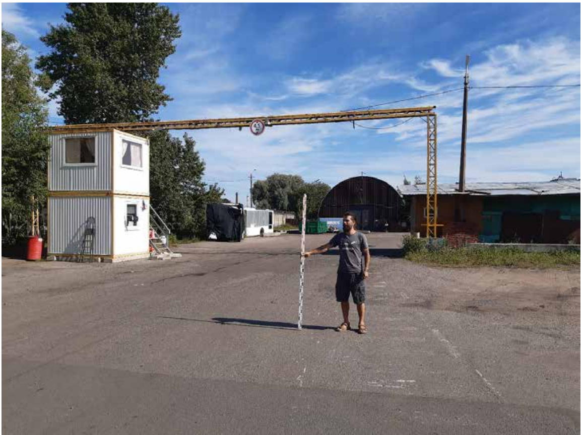
Рис. 33. Санкт-Петербург, Пр. Стачек 108, Автобусный парк №5. Общий вид участка. Точка съемки 6. Вид на юго-восток.
