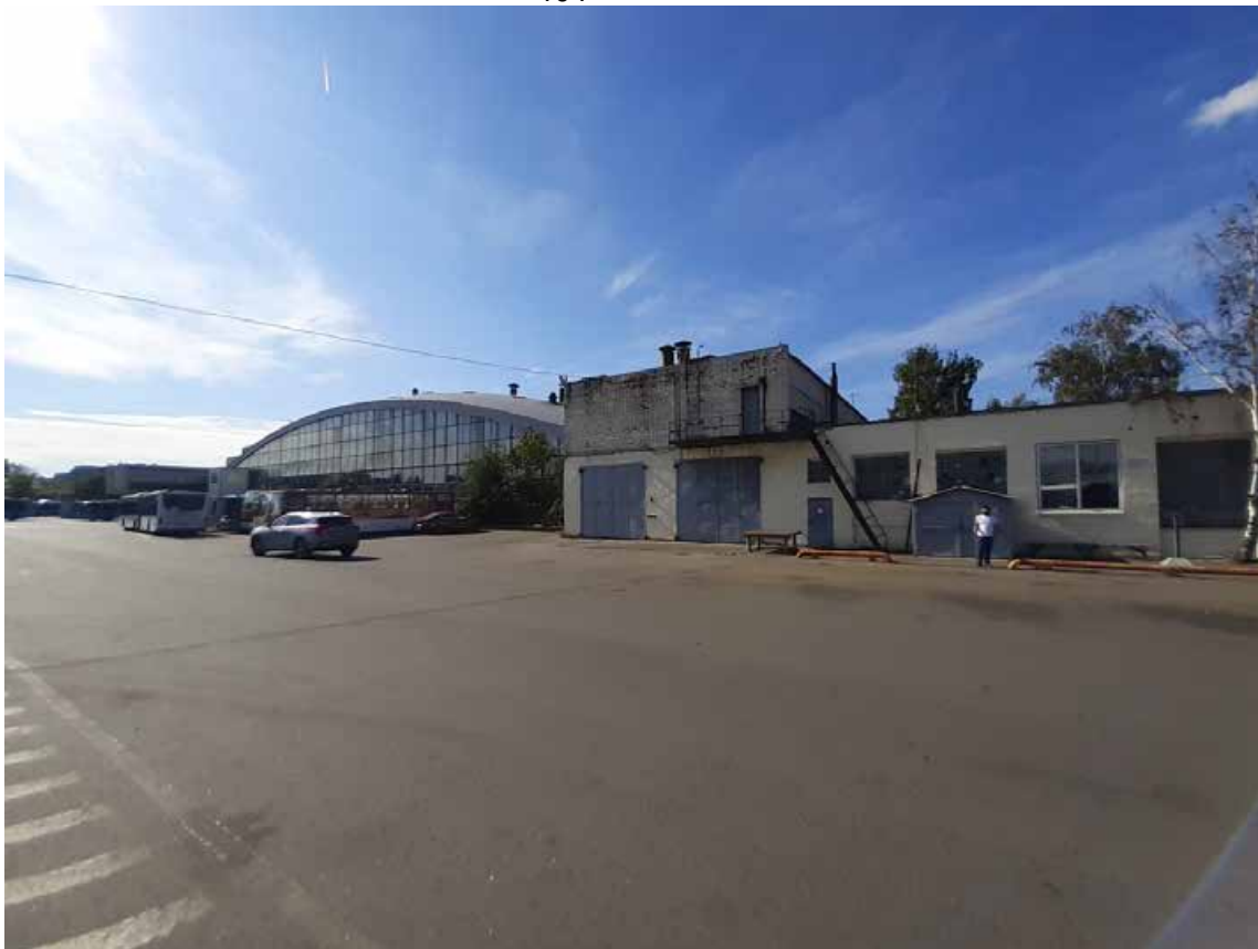
Рис. 50. Санкт-Петербург, Пр. Стачек 108, Автобусный парк №5. Общий вид участка. Точка съемки 10. Вид на запад-северо-запад.
