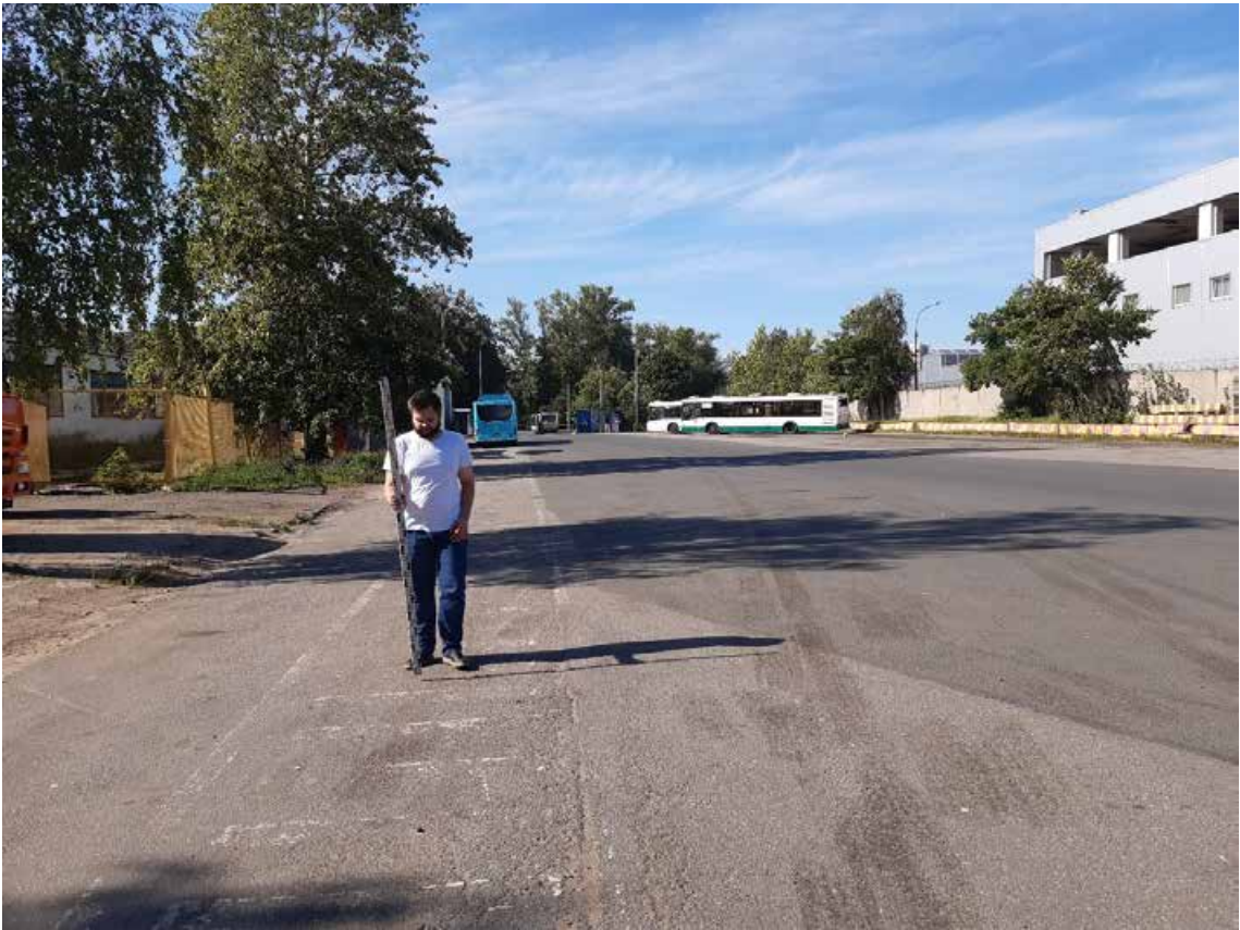
Рис. 44. Санкт-Петербург, Пр. Стачек 108, Автобусный парк №5. Общий вид участка. Точка съемки 8. Вид на северо-запад.
