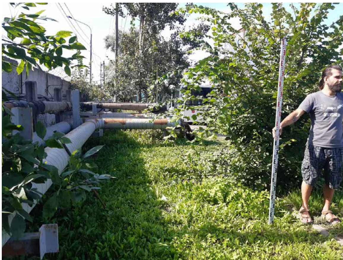
Рис. 17. Санкт-Петербург, Пр. Стачек 108, Автобусный парк №5. Общий вид участка. Точка съемки 1. Вид на северо-запад.
