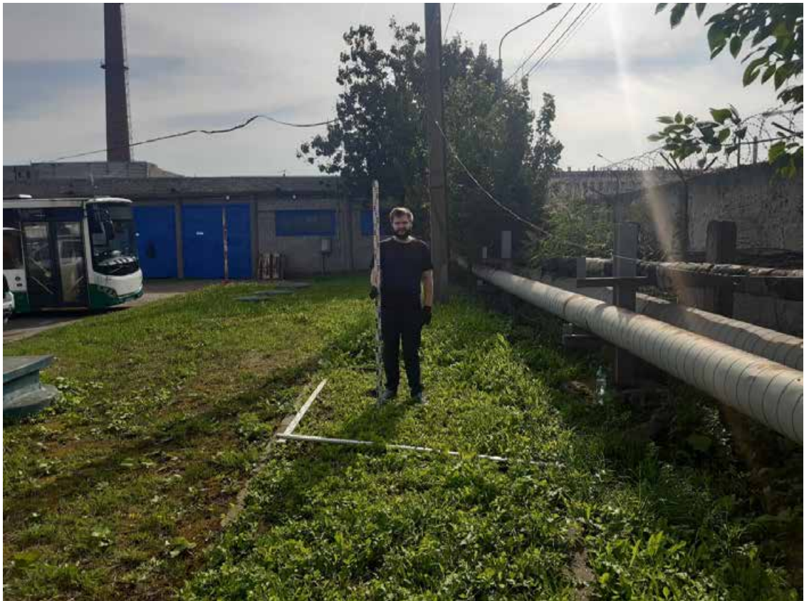
Рис. 72. Санкт-Петербург, Пр. Стачек 108, Автобусный парк №5. Шурф 1. Фотофиксация общего вида до начала работ. Вид на юго-восток.
