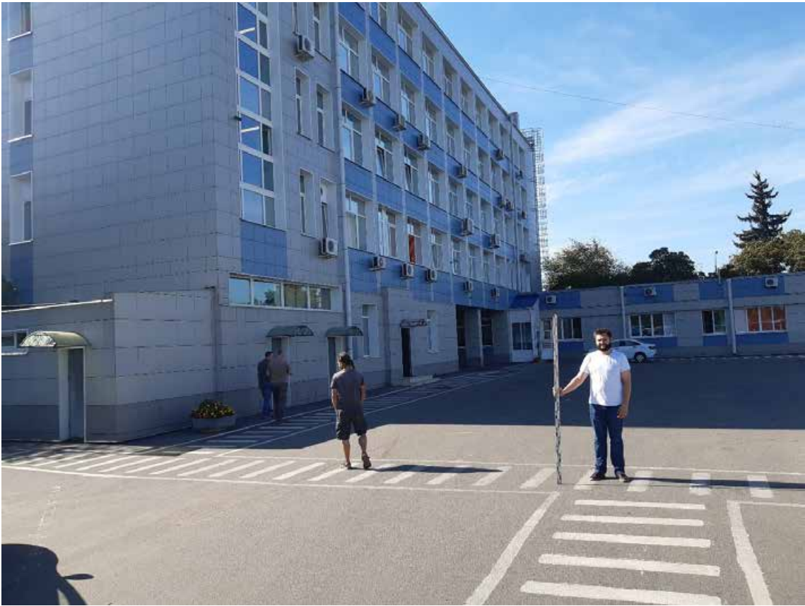
Рис. 60. Санкт-Петербург, Пр. Стачек 108, Автобусный парк №5. Общий вид участка. Точка съемки 14. Вид на северо-восток.
