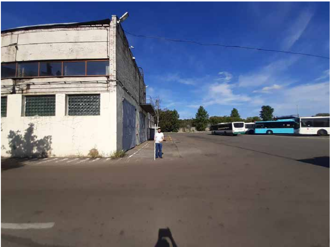
Рис. 47. Санкт-Петербург, Пр. Стачек 108, Автобусный парк №5. Общий вид участка. Точка съемки 9. Вид на северо-восток.
