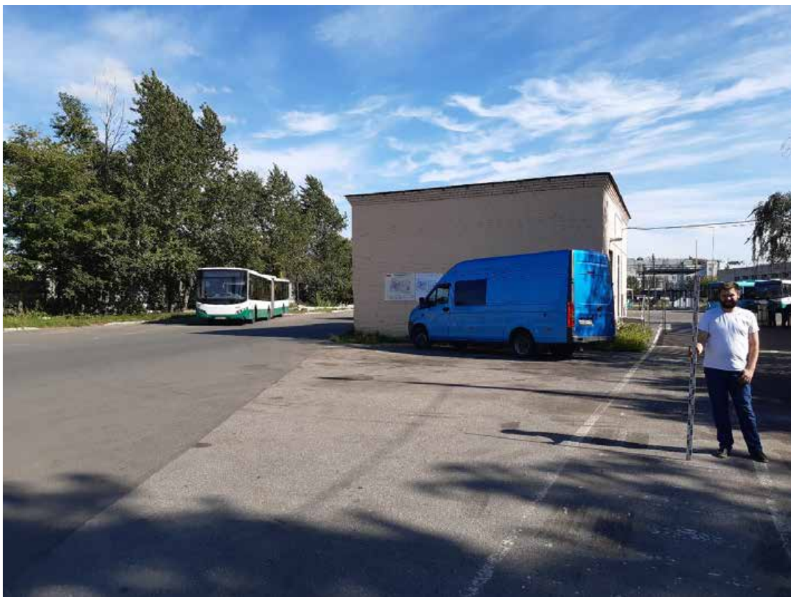
Рис. 39. Санкт-Петербург, Пр. Стачек 108, Автобусный парк №5. Общий вид участка. Точка съемки 8. Вид на юго-восток.
