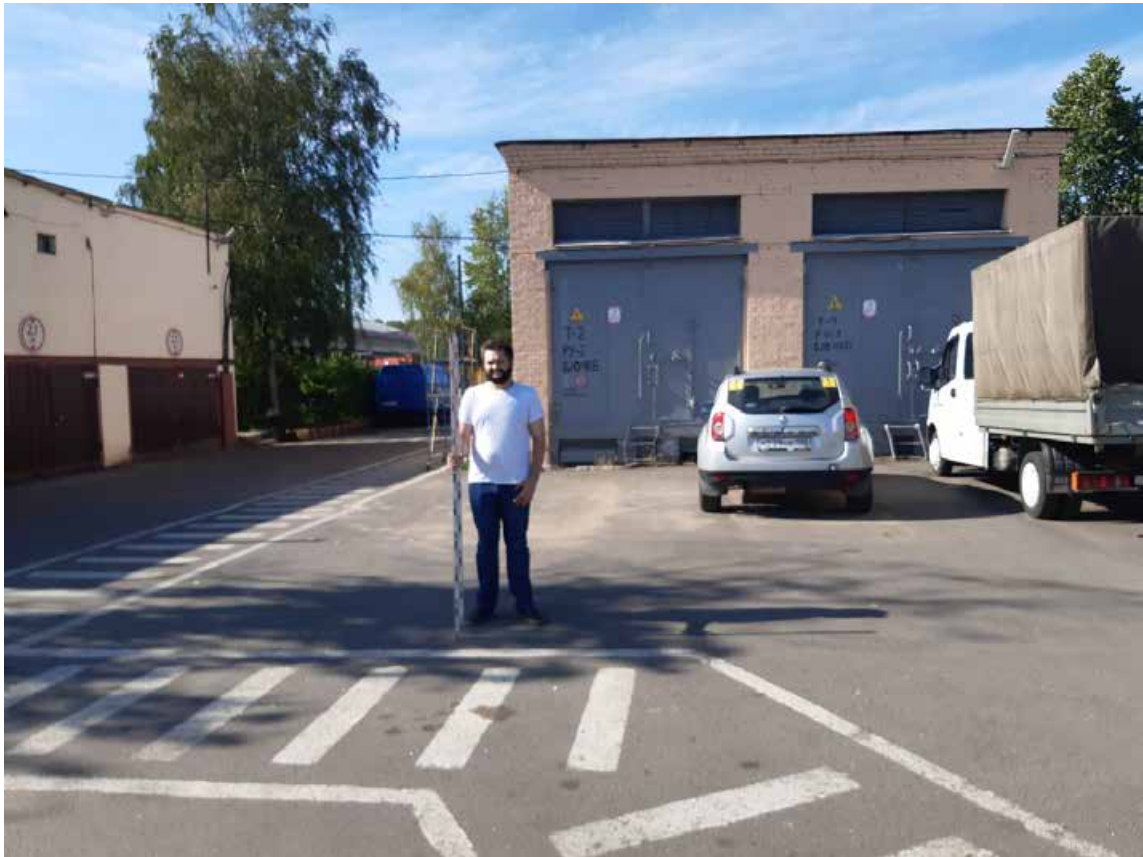
Рис. 36. Санкт-Петербург, Пр. Стачек 108, Автобусный парк №5. Общий вид участка. Точка съемки 7. Вид на северо-запад.
