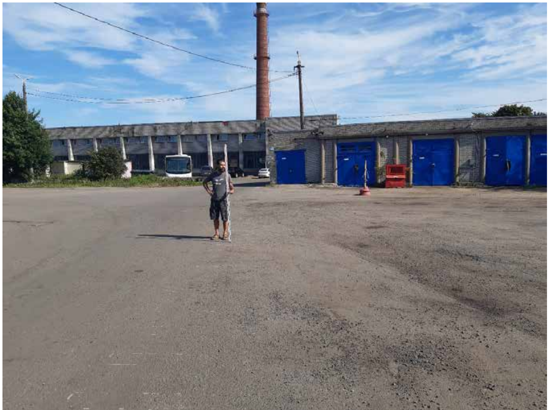
Рис. 21 Санкт-Петербург, Пр. Стачек 108, Автобусный парк №5. Общий вид участка. Точка съемки 2. Вид на юго-восток.
