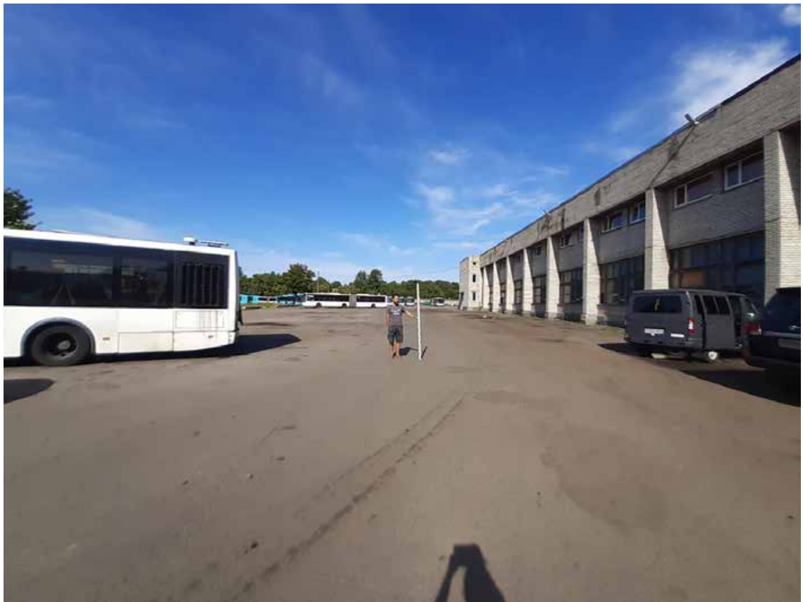
Рис. 23. Санкт-Петербург, Пр. Стачек 108, Автобусный парк №5. Общий вид участка. Точка съемки 2. Вид на северо-восток.
