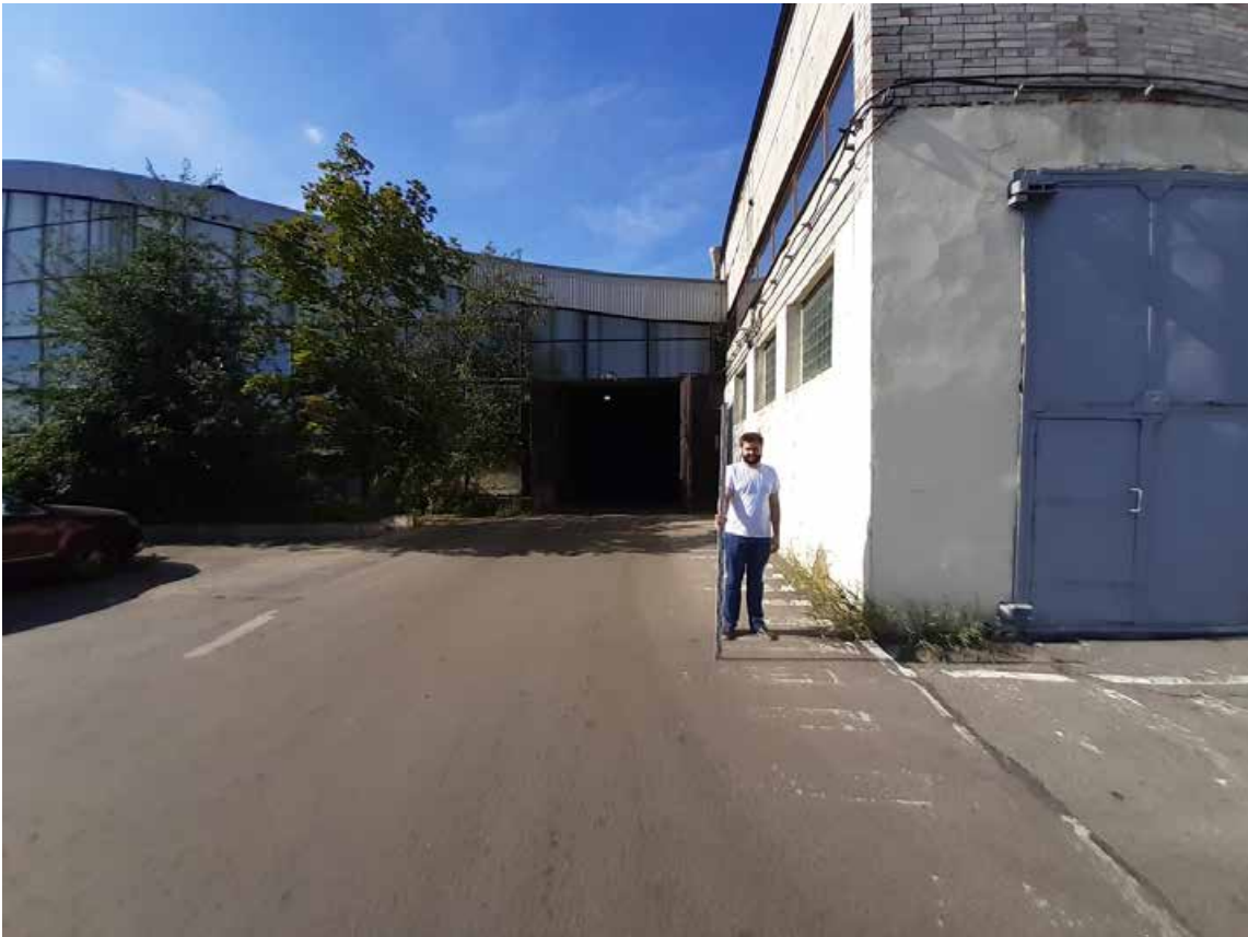
Рис. 46. Санкт-Петербург, Пр. Стачек 108, Автобусный парк №5. Общий вид участка. Точка съемки 9. Вид на северо-запад.
