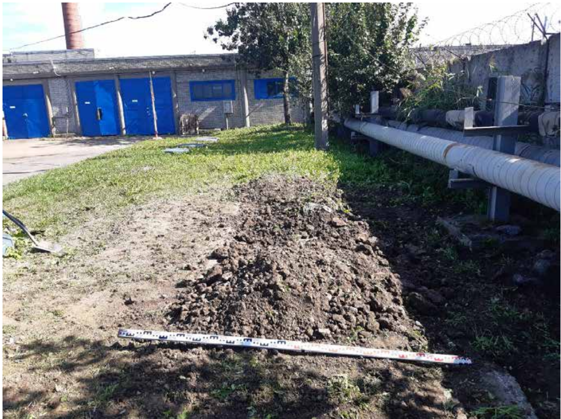
Рис. 85. Санкт-Петербург, Пр. Стачек 108, Автобусный парк №5. Шурф 1. Фотофиксация после рекультивации вид на юго-восток.
