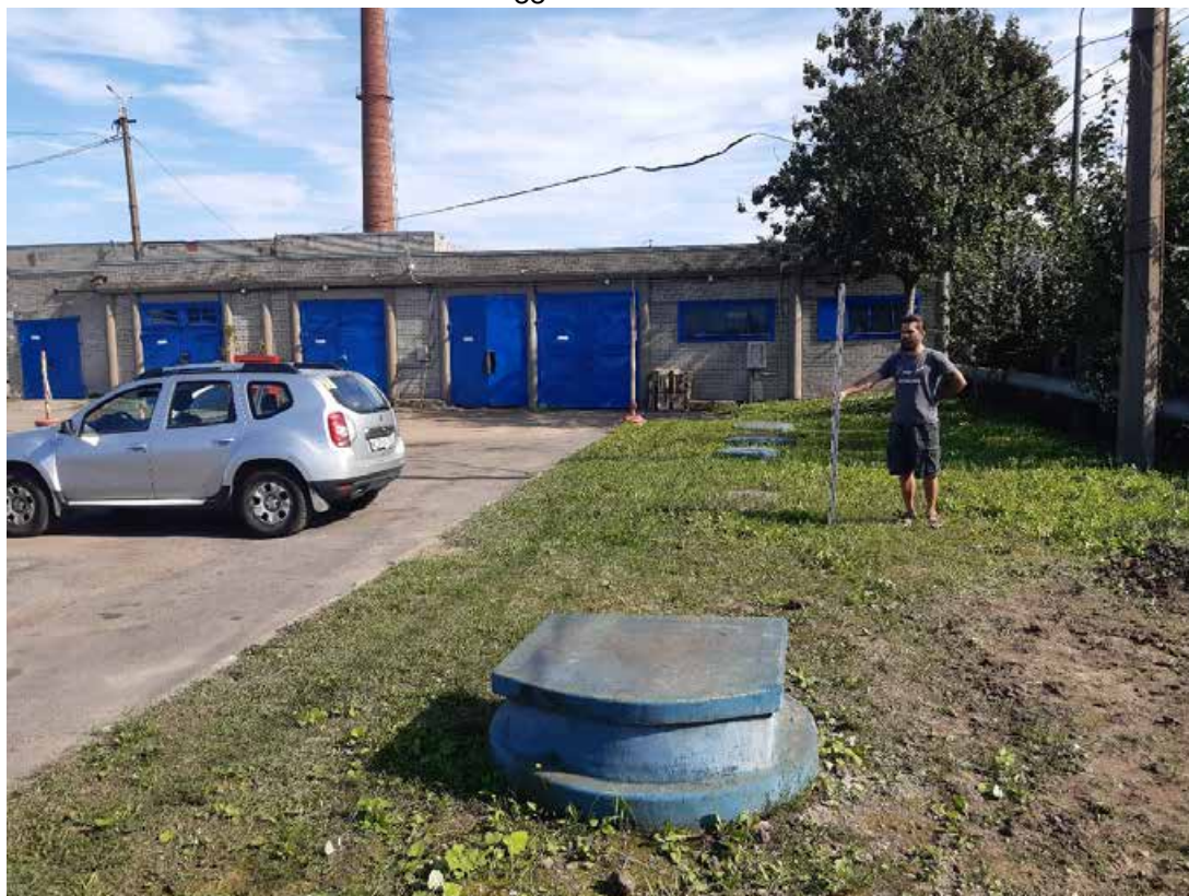
Рис. 18. Санкт-Петербург, Пр. Стачек 108, Автобусный парк №5. Общий вид участка. Точка съемки 1. Вид на юго-восток.
