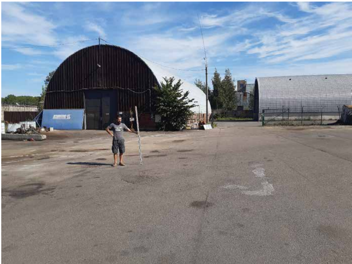
Рис. 27. Санкт-Петербург, Пр. Стачек 108, Автобусный парк №5. Общий вид участка. Точка съемки 3. Вид на восток-юго-восток.
