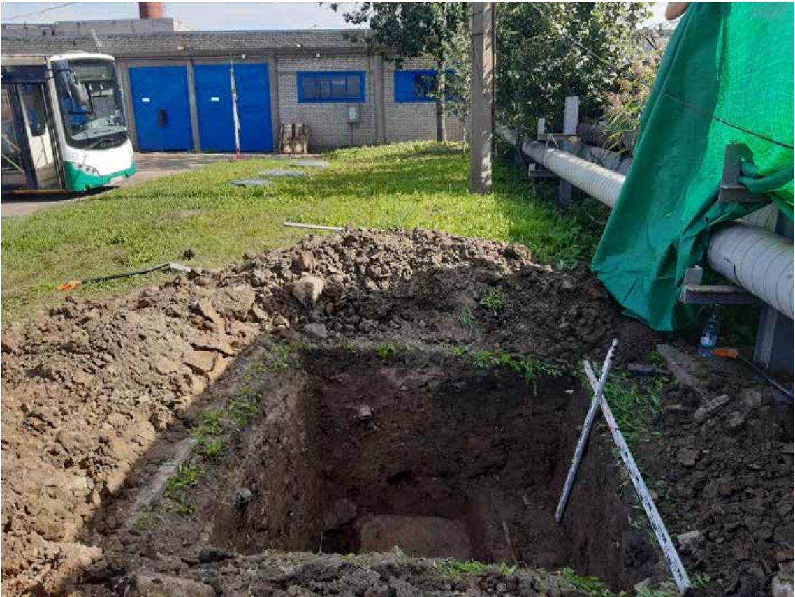
Рис. 84. Санкт-Петербург, Пр. Стачек 108, Автобусный парк №5. Шурф 1. Фотофиксация с окружающим пейзажем. Вид на юго-восток.
