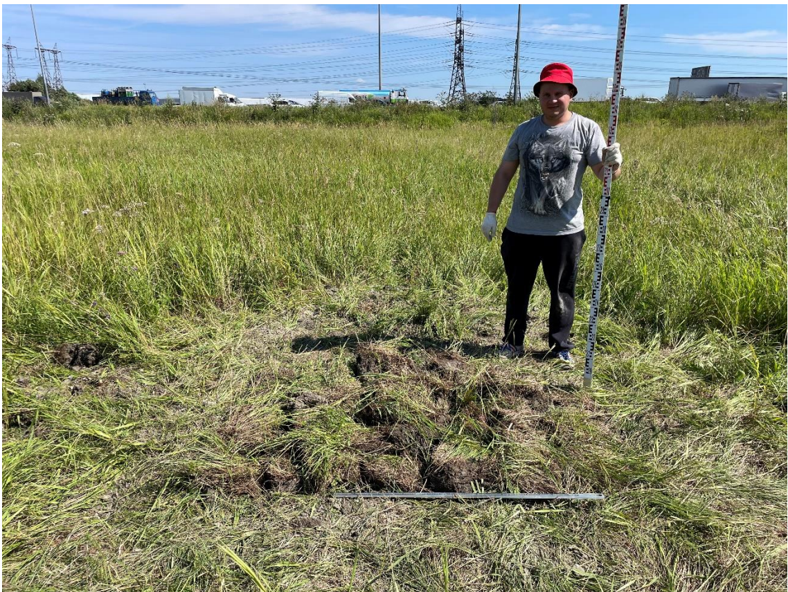
Рис. 36. Шурф 2. Рекультивация шурфа. Вид на север.
