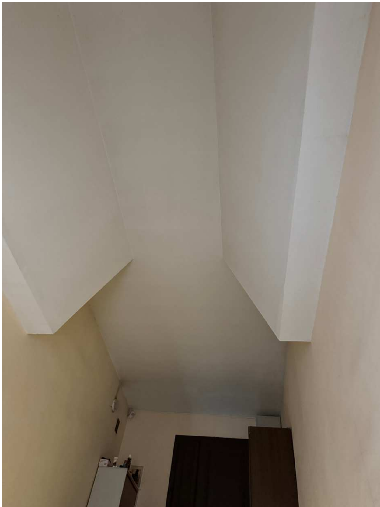
Фото 32. Верхнее перекрытие парадной лестницы объекта культурного наследия.
