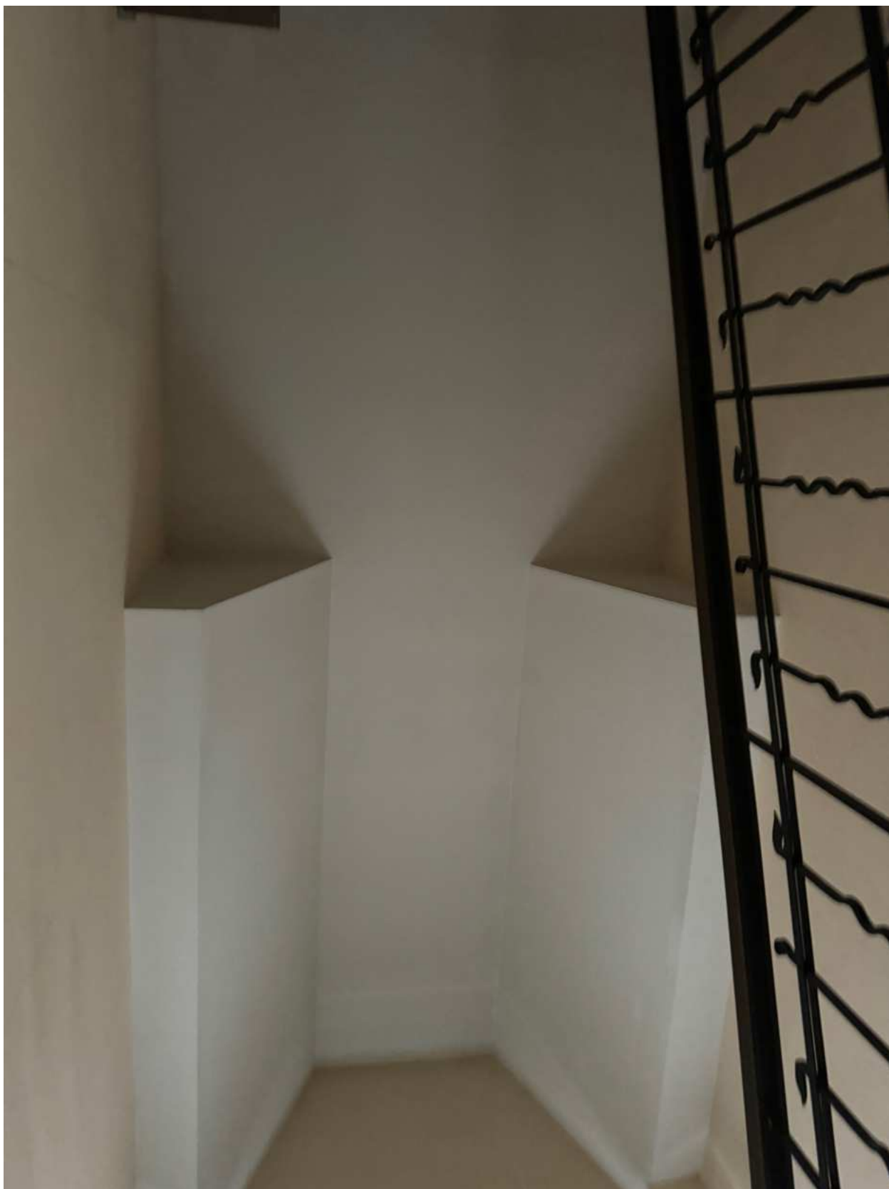
Фото 28. Верхнее перекрытие парадной лестницы объекта культурного наследия.
