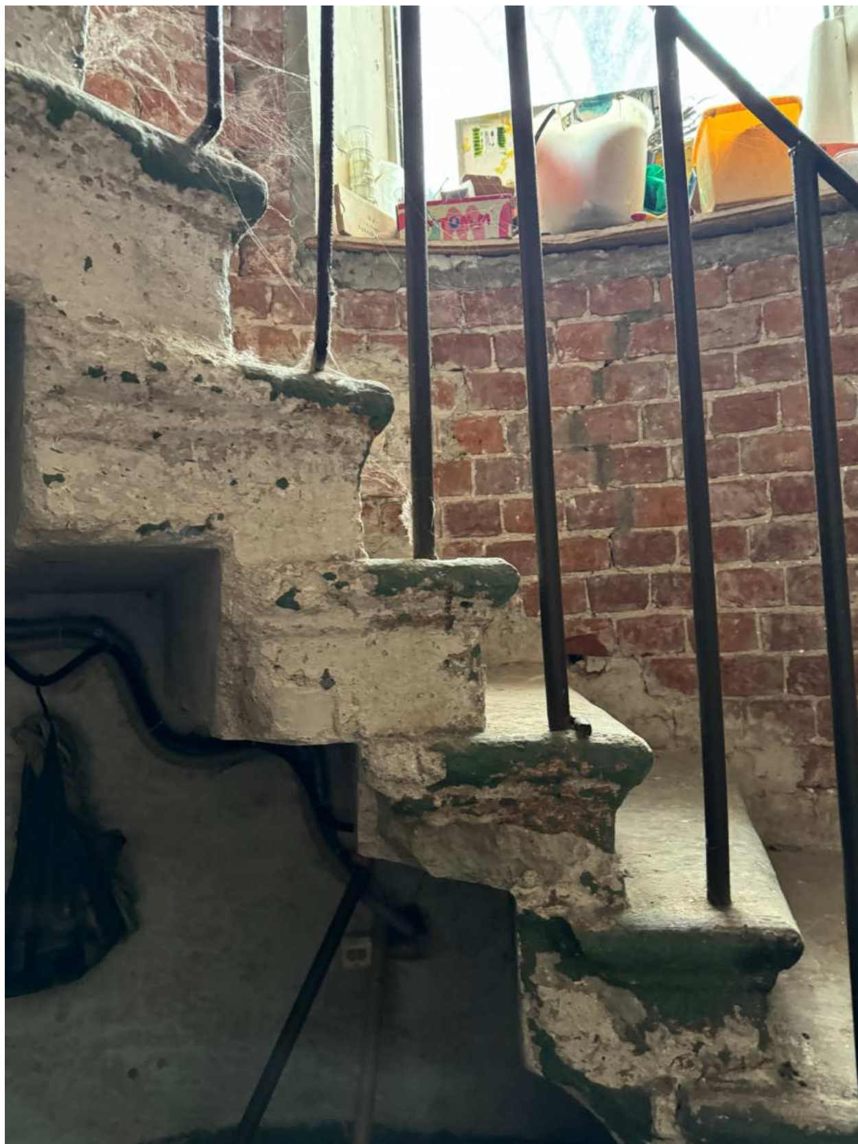
Фото 34. Фрагмент ступеней и ограждения черной лестницы объекта культурного наследия в уровне 1-го этажа.
