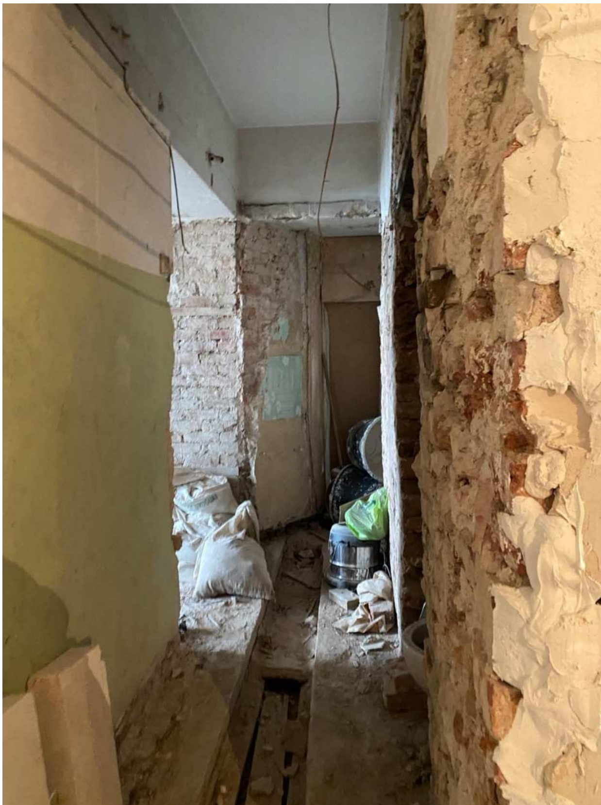
Фото 22. Вид на помещение квартиры № 81 объекта культурного наследия.
