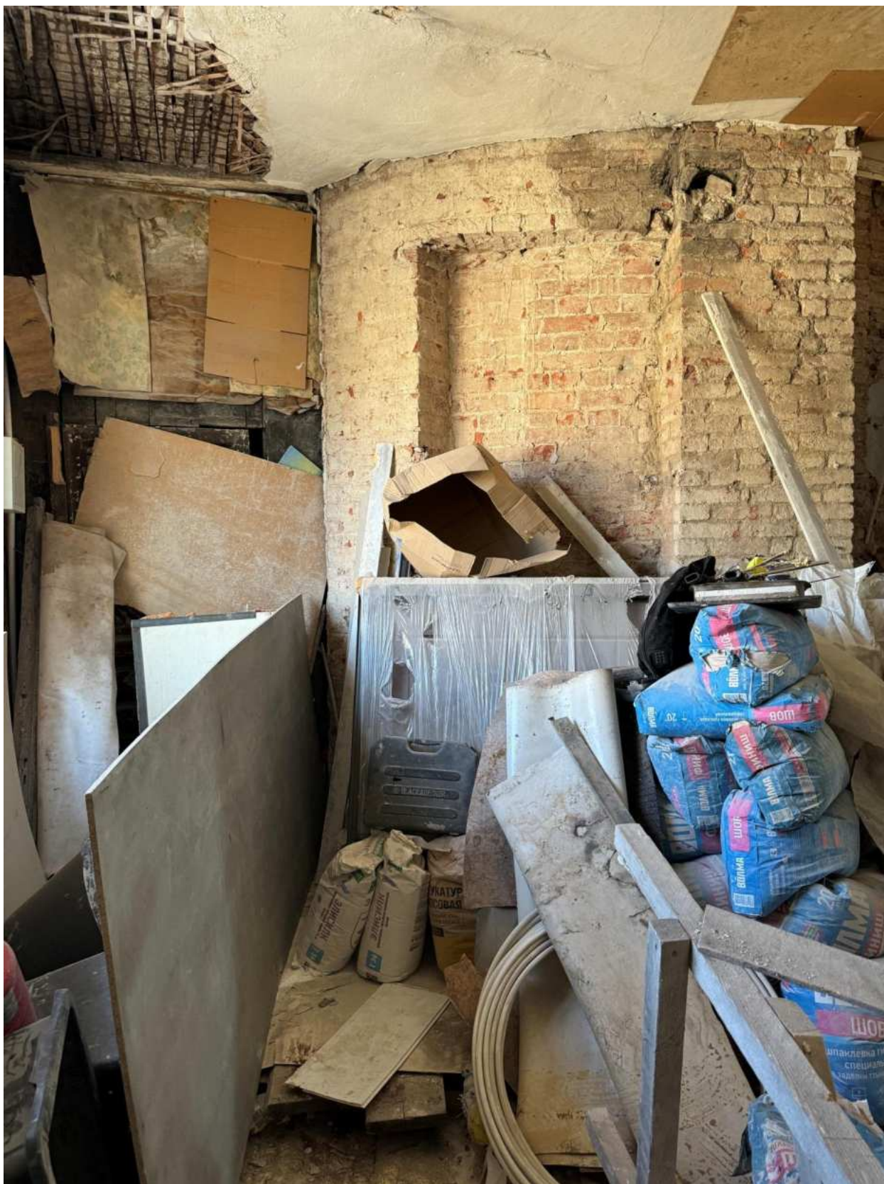
Фото 21. Вид на помещение квартиры № 81 объекта культурного наследия.
