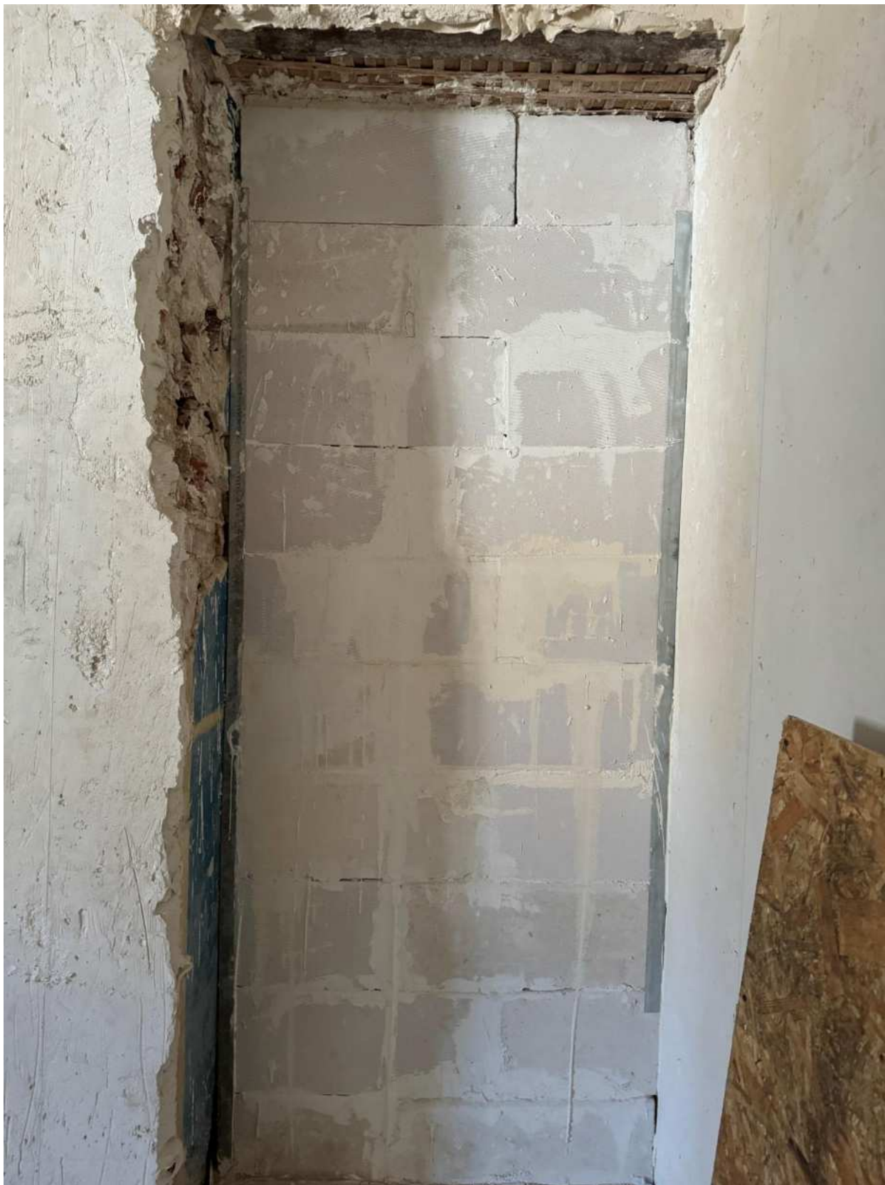
Фото 31. Вид на помещение квартиры № 81 объекта культурного наследия.
