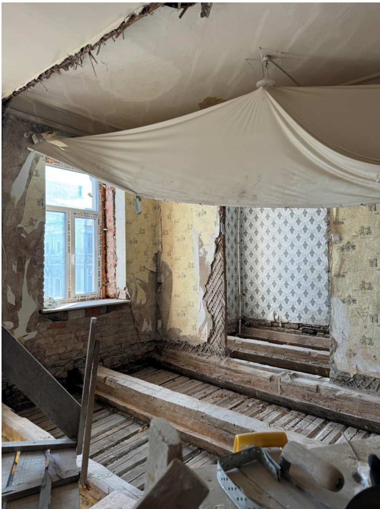
Фото 23. Вид на помещение квартиры № 81 объекта культурного наследия.
