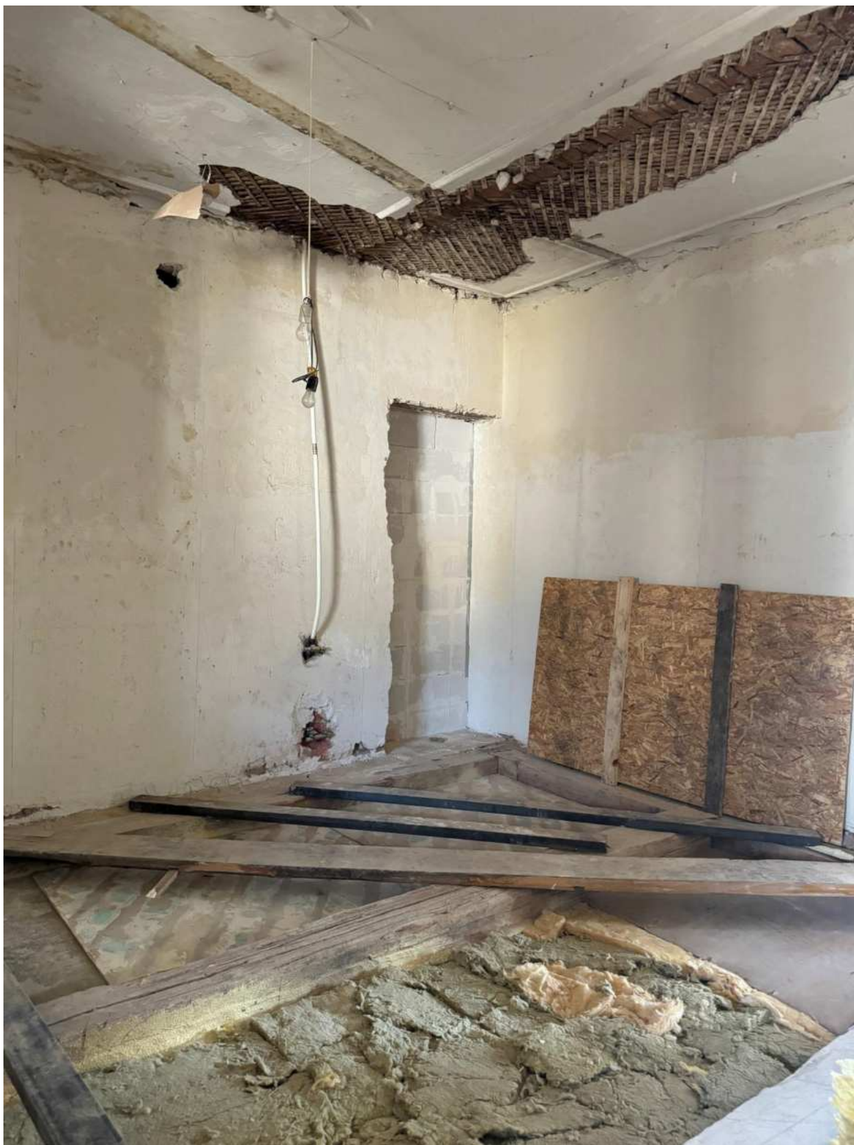
Фото 17. Вид на помещение квартиры № 81 объекта культурного наследия.
