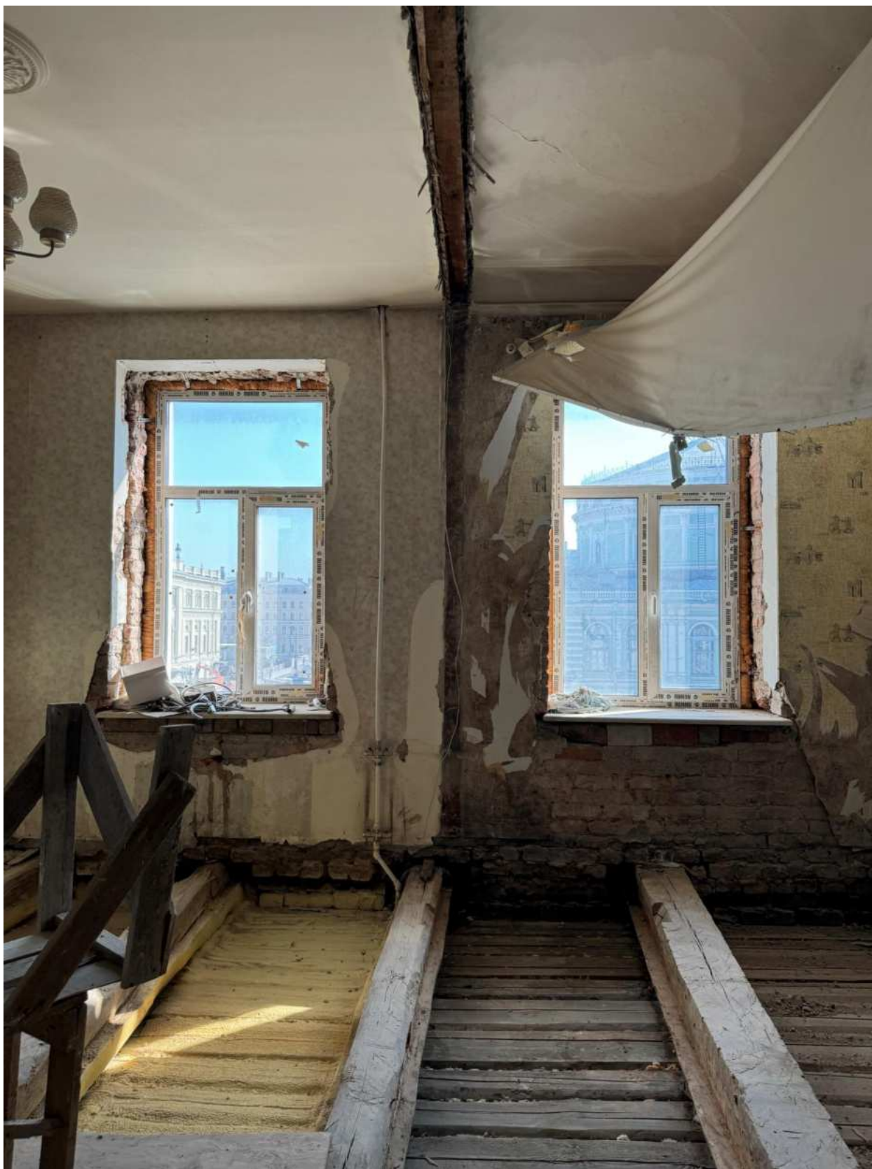
Фото 25. Вид на помещение квартиры № 81 объекта культурного наследия.
