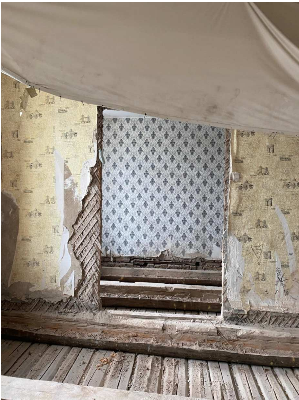
Фото 28. Вид на помещение квартиры № 81 объекта культурного наследия.
