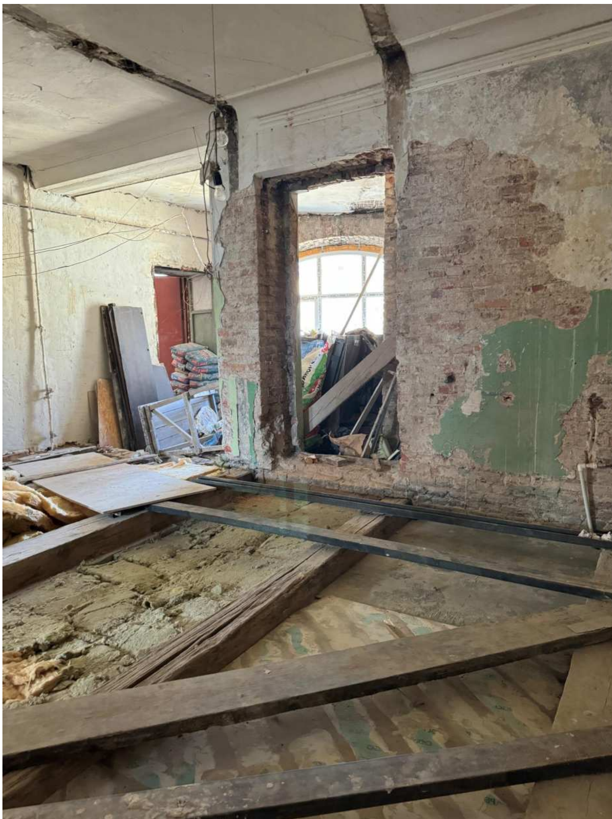
Фото 32. Вид на помещение квартиры № 81 объекта культурного наследия.
