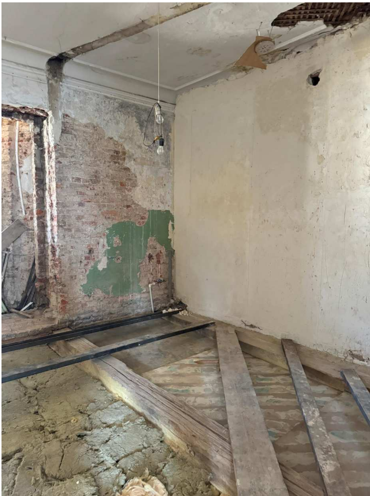
Фото 36. Вид на помещение квартиры № 81 объекта культурного наследия.
