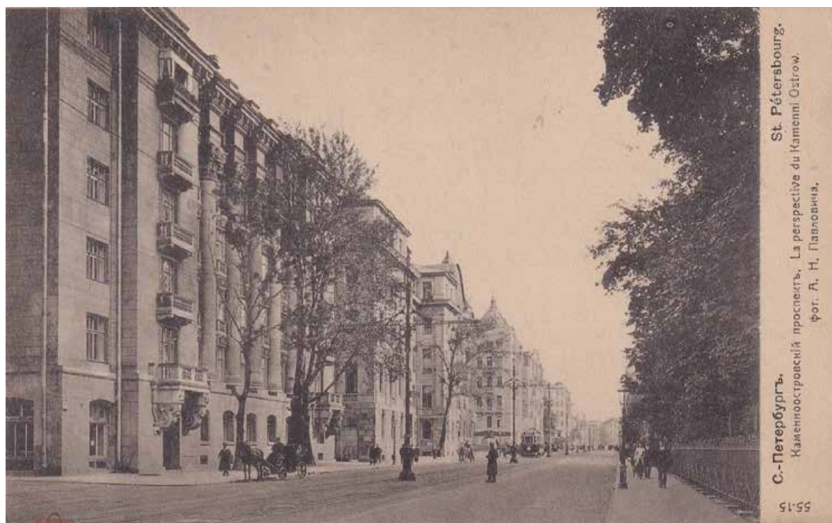
66.!Каменноостровский проспект, 1914 г. [Электронный ресурс] URL: https://pastvu.com/p/1143486
