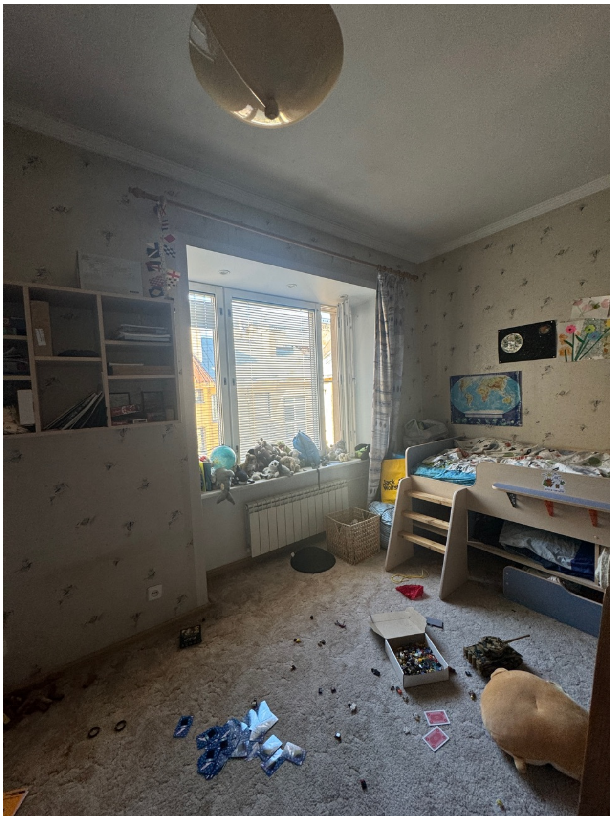
Фото 23. Вид на помещение квартиры № 50 объекта культурного наследия.
