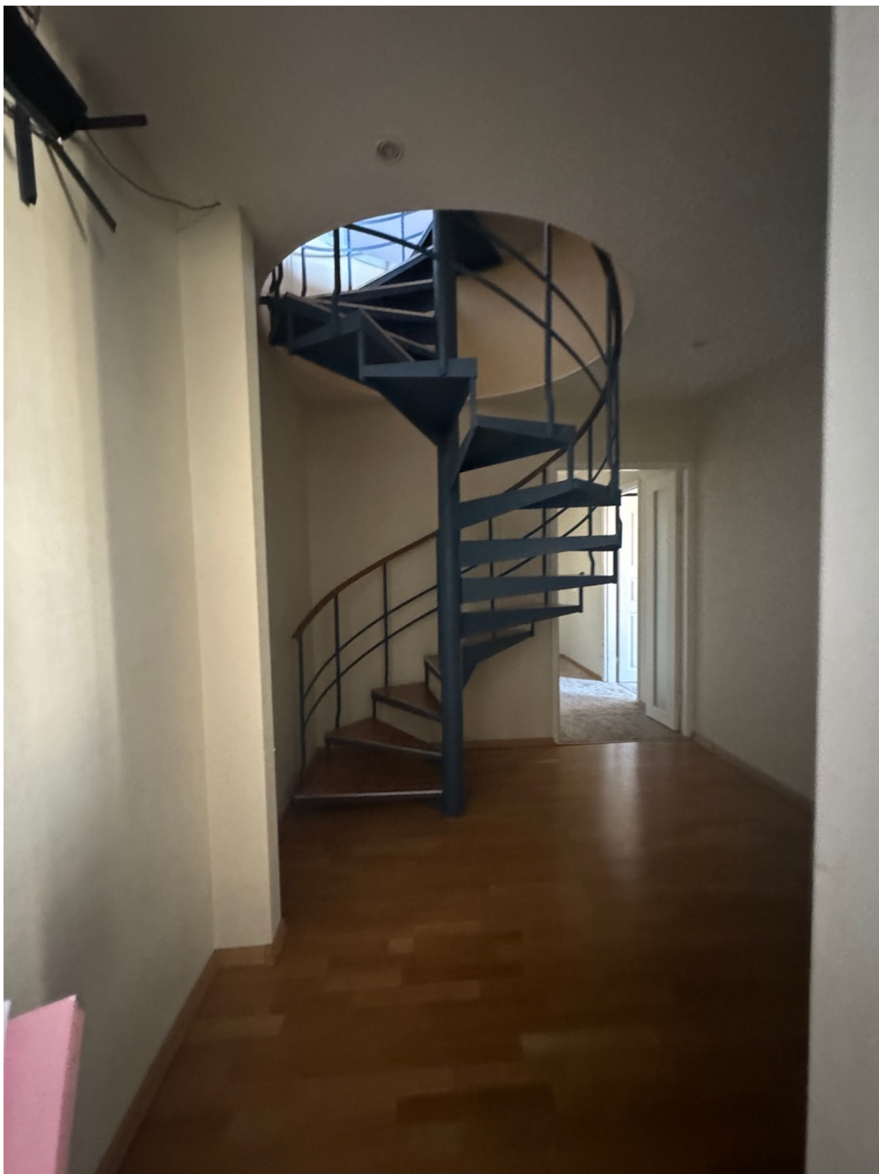
Фото 20. Вид на помещение квартиры № 50 объекта культурного наследия.
