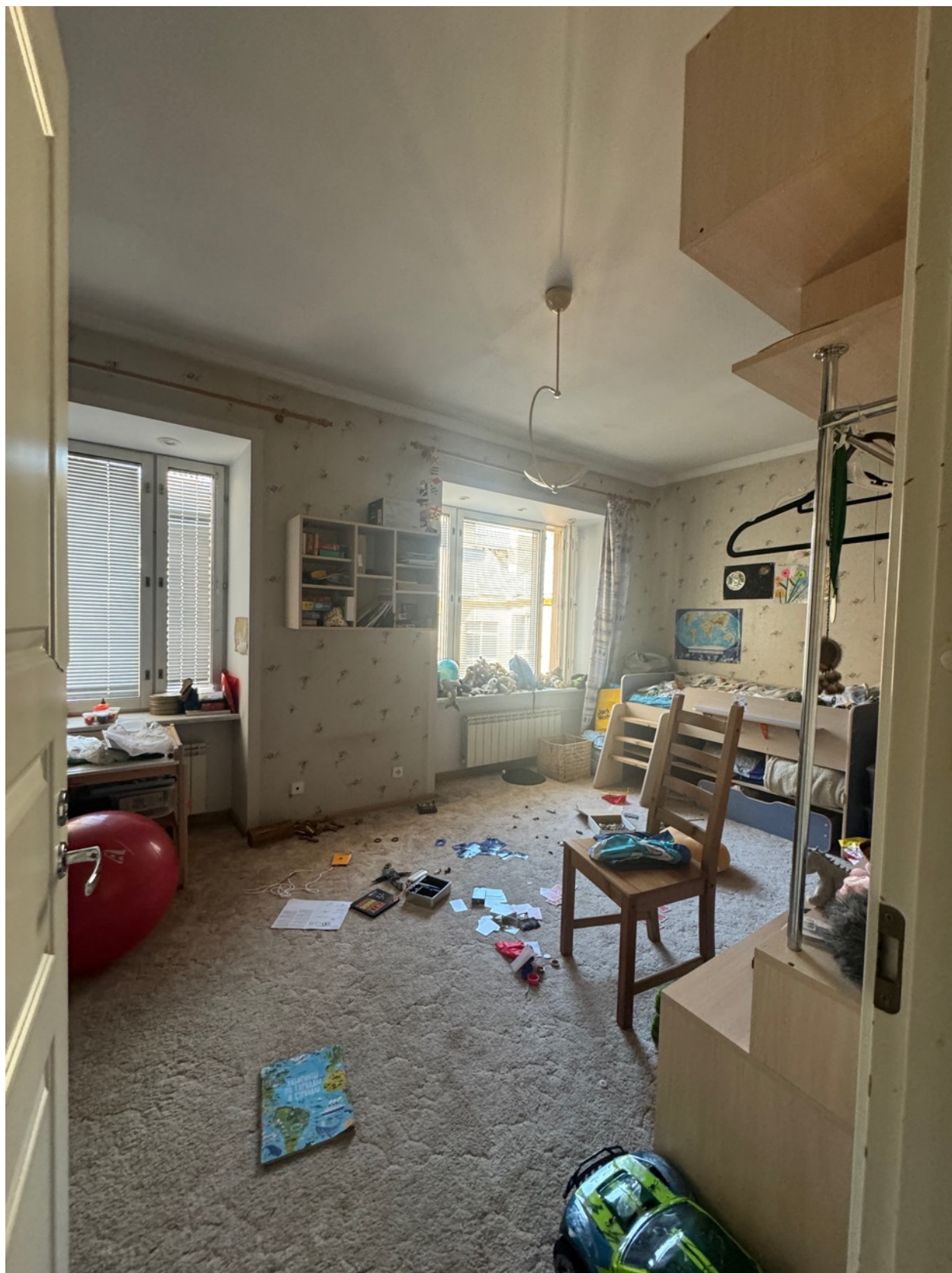
Фото 22. Вид на помещение квартиры № 50 объекта культурного наследия.
