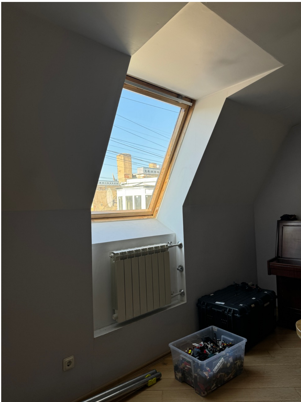
Фото 36. Вид на помещение квартиры № 50 объекта культурного наследия.
