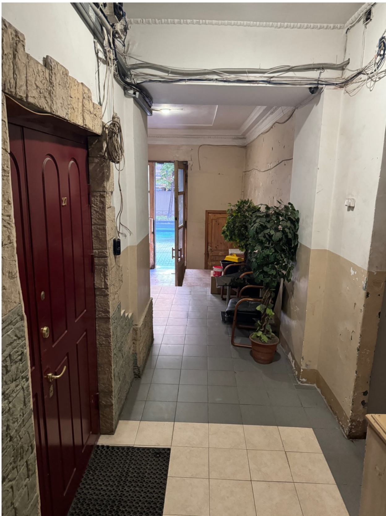
Фото 8. Вестибюль парадной, ведущей в квартиру № 50, объекта культурного наследия.
