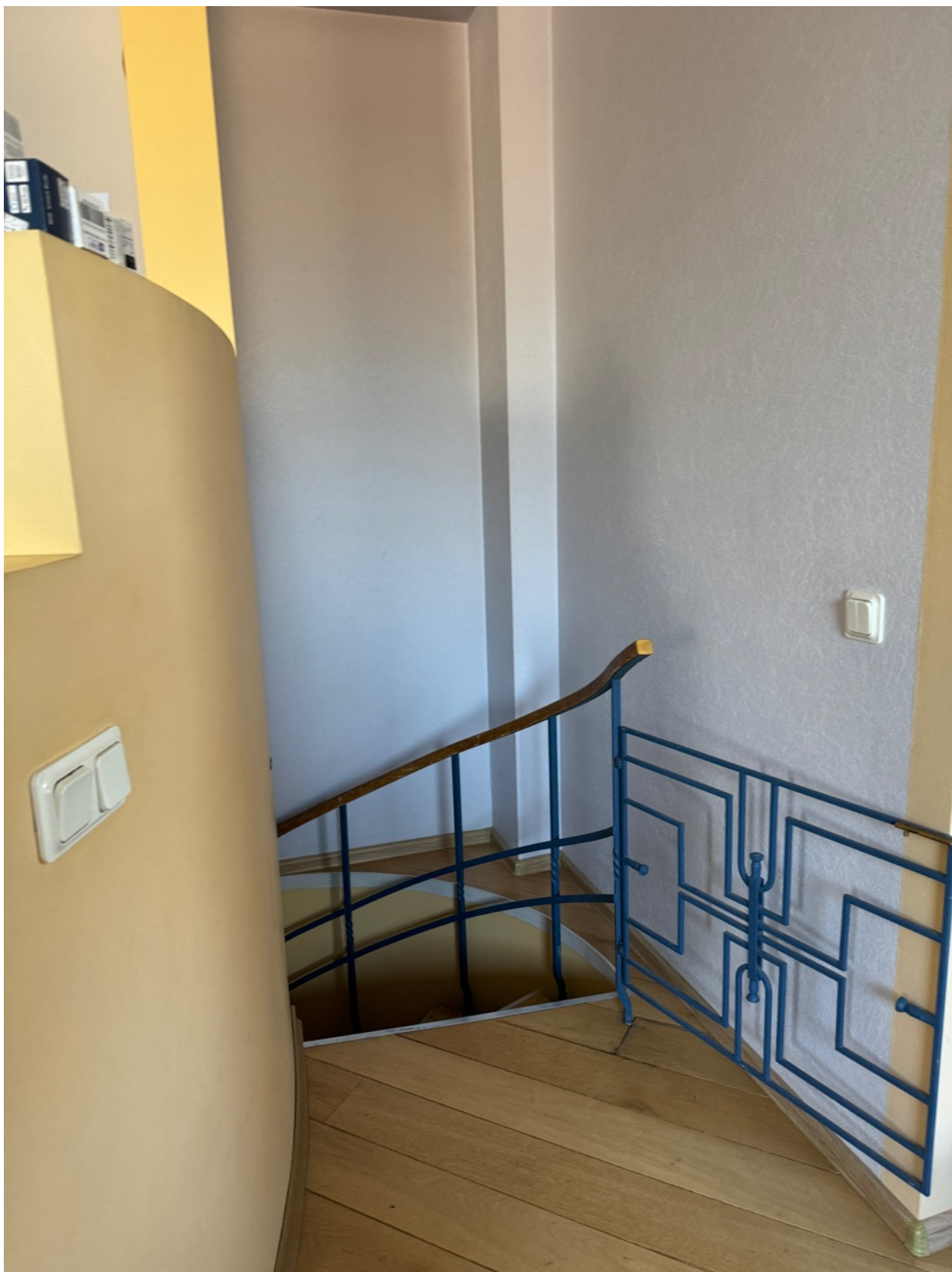
Фото 48. Вид на лестницу квартиры № 50 объекта культурного наследия.
