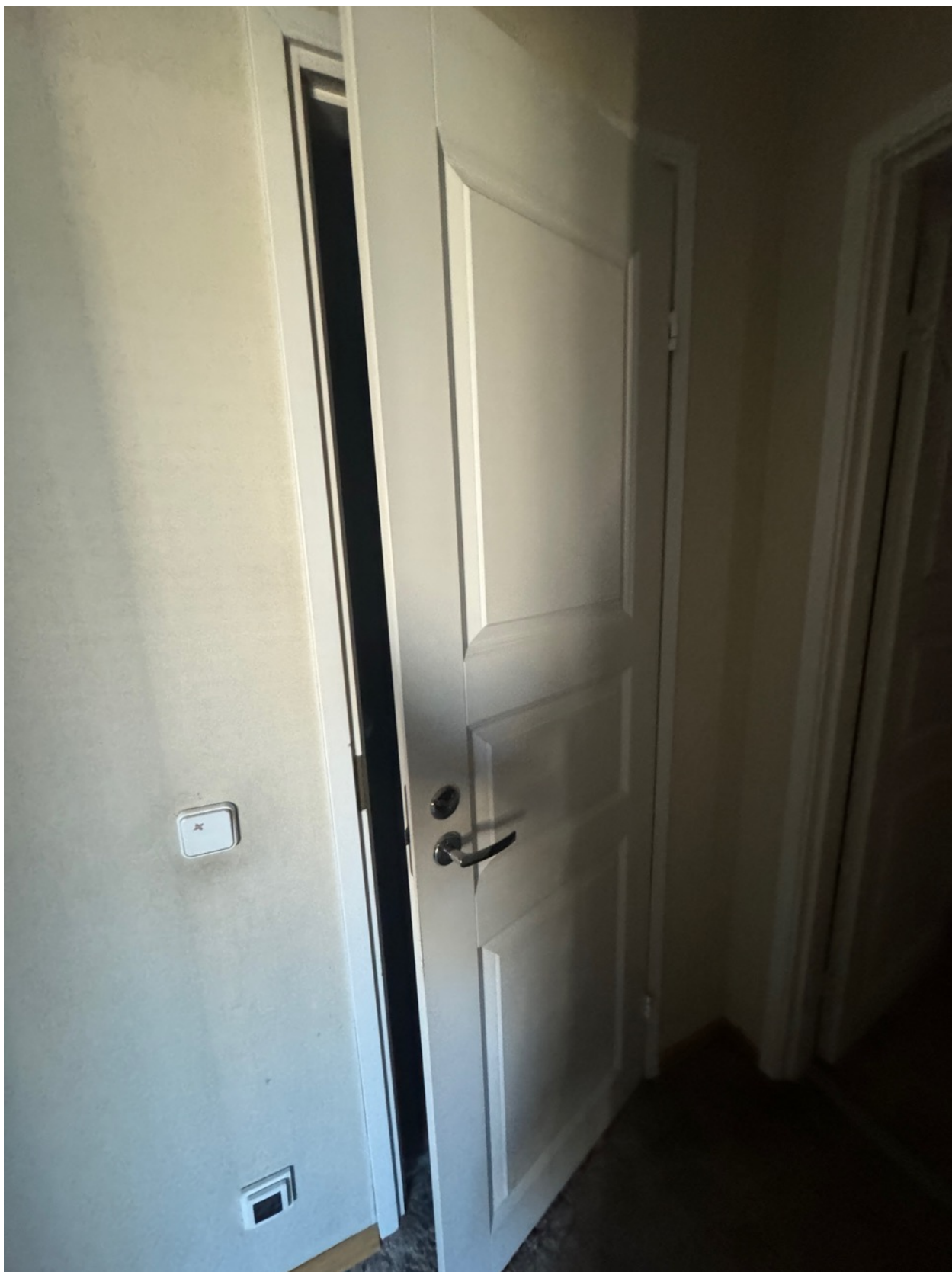
Фото 28. Вид на помещение квартиры № 50 объекта культурного наследия.
