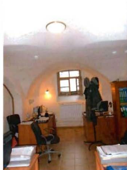
4. Свод цокольного этажа.
