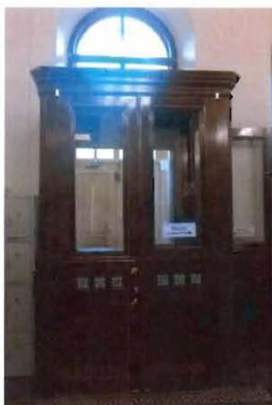
3. Тамбур главного входа.
