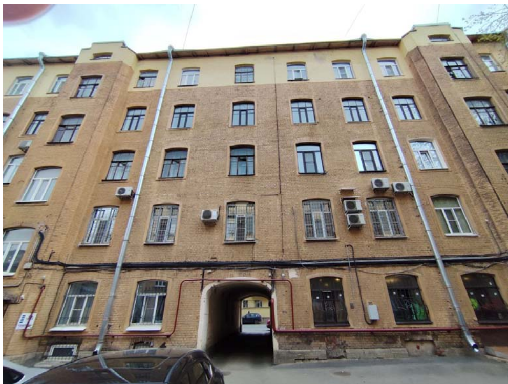
Фото 3. Юго-восточный дворовой фасад лицевого флигеля.
