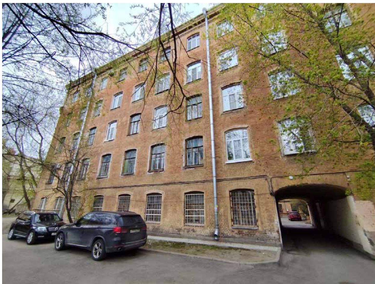
Фото 9. Юго-восточный фасад дворового корпуса.
