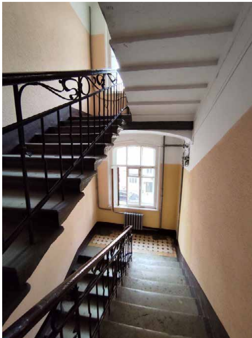
Фото 14. Лестничная клетка 2-3 этаж.
