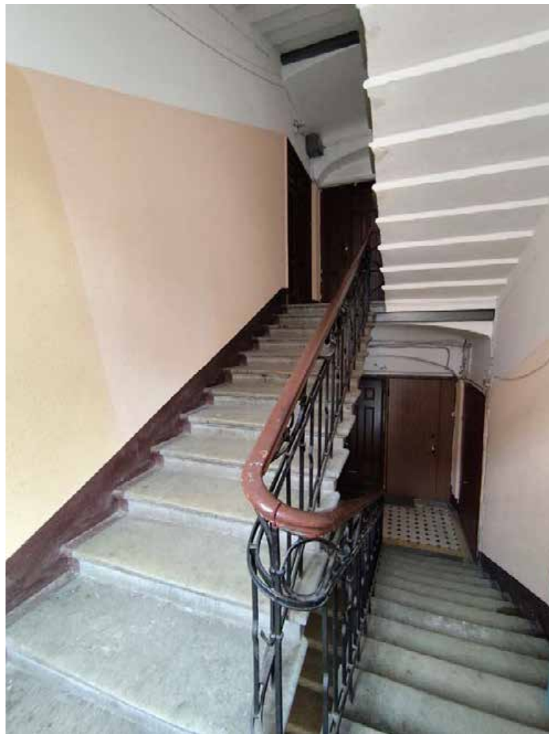
Фото 13. Лестничная клетка 2-3 этаж.
