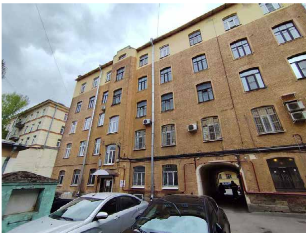
Фото 4. Юго-восточный дворовой фасад лицевого флигеля.
