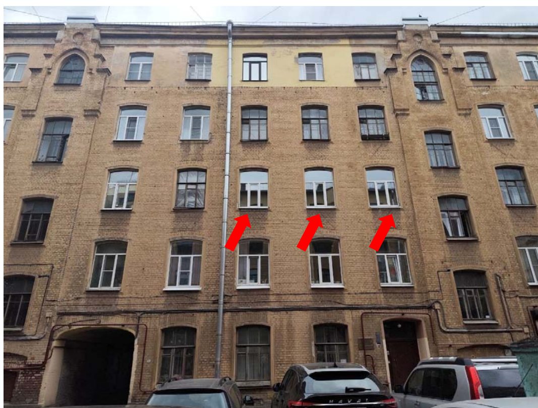
Фото 11. Северо-западный фасад дворового корпуса, окна квартиры №32.
