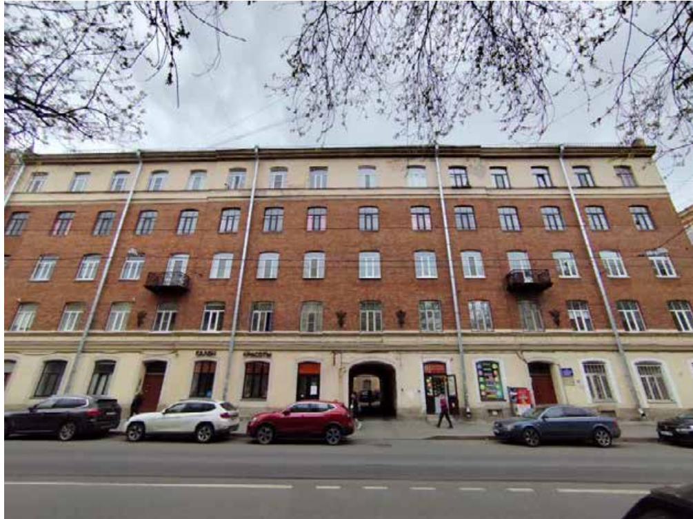
Фото 1. Северо-западный лицевой фасад.
