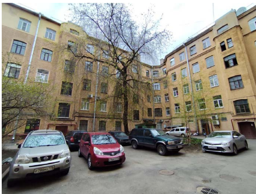
Фото 5. Дворовые фасады, общий вид.
