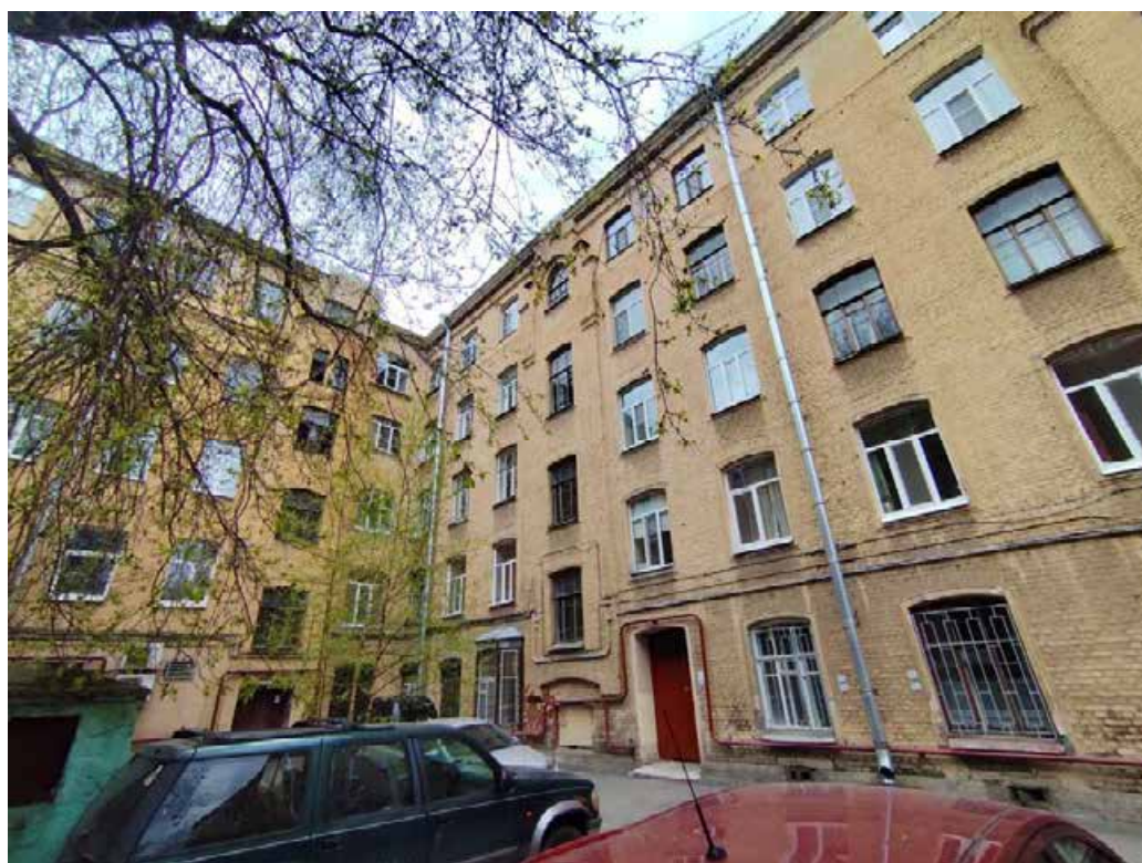
Фото 6. Дворовые фасады, общий вид.
