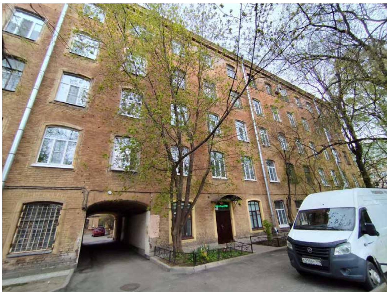
Фото 10. Юго-восточный фасад дворового корпуса.
