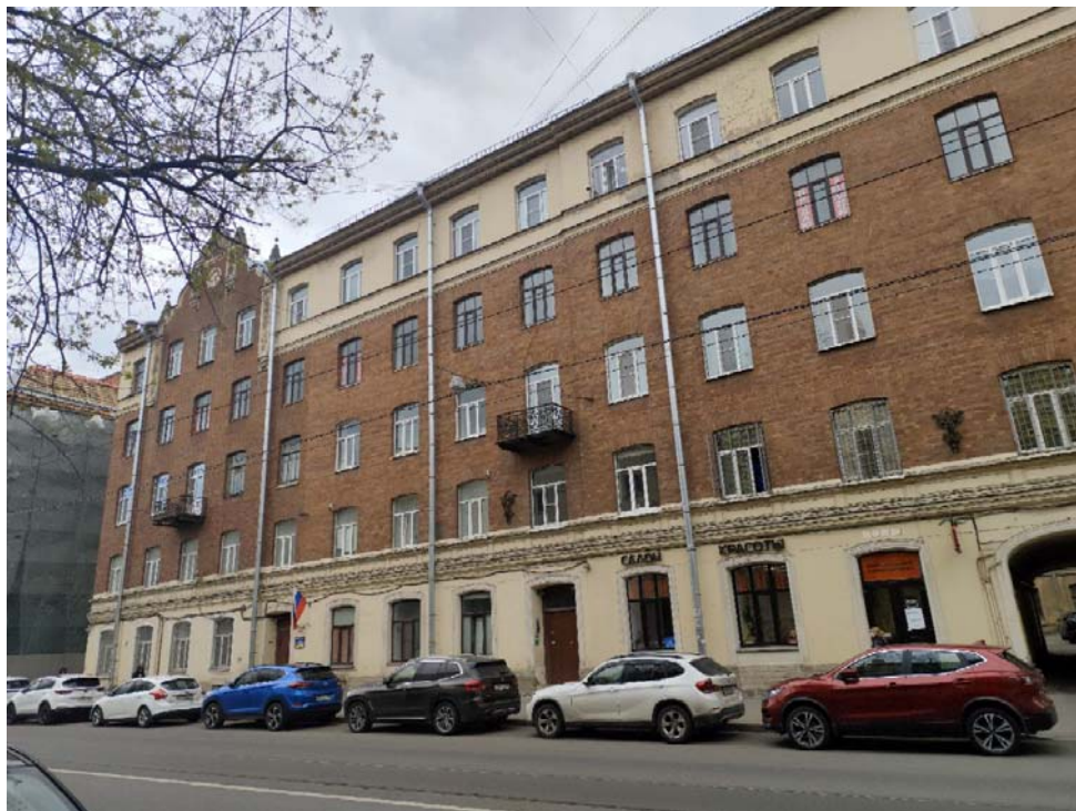
Фото 2. Северо-западный лицевой фасад.
