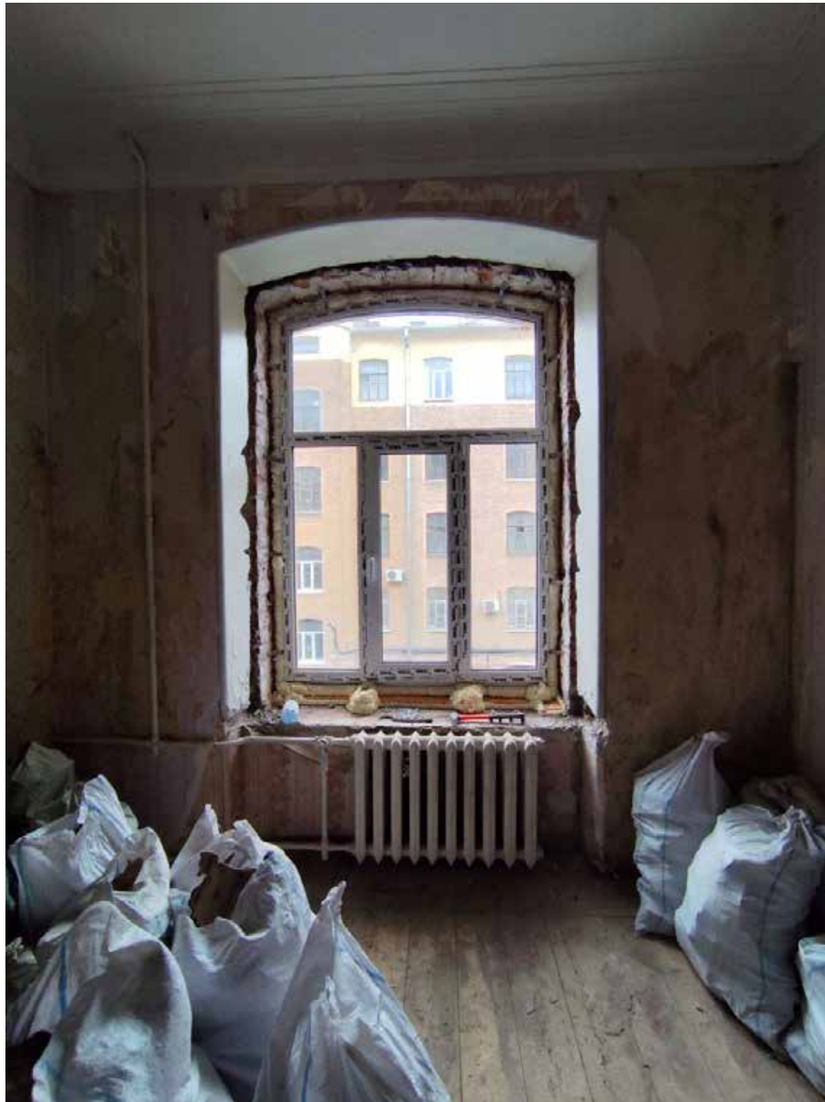
Фото 27. Квартира №32, помещение №5, оконный проем.
