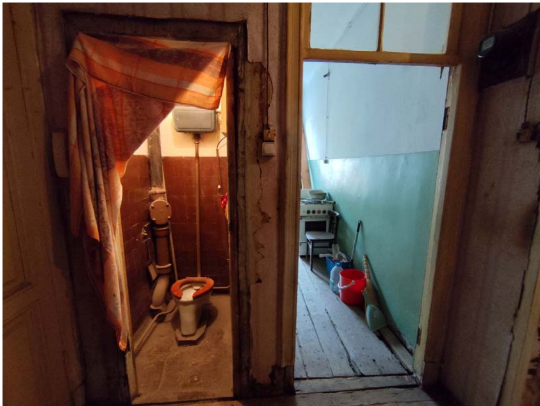
Фото 18. Квартира №32, помещение №2 и №3.
