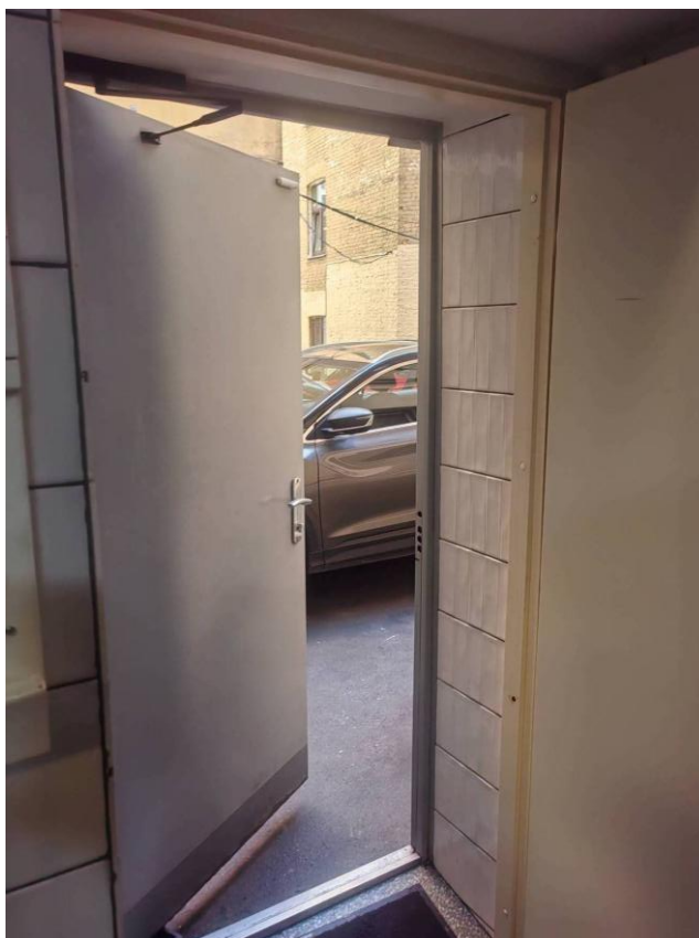
Фото 10. Интерьер пом. 3-Н объекта культурного наследия регионального значения «Дом М.Н. и Н.А. Мельцеров»
