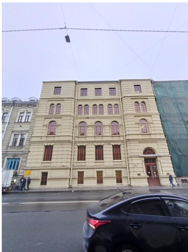
Фото 5. Фрагмент лицевого фасада выявленного объекта культурного наследия «Здание Третьей военной гимназии» (по Садовой ул.)
