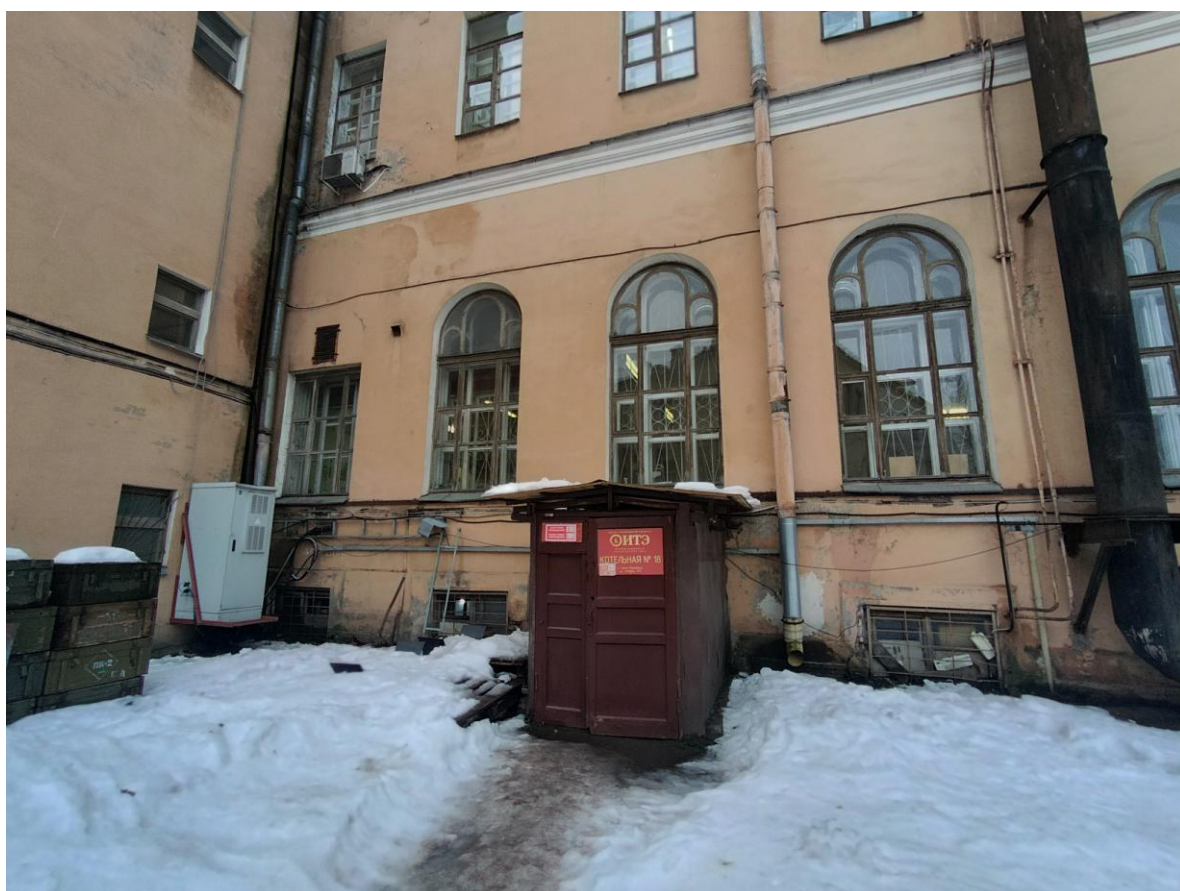
Фото 10. Фрагмент дворового фасада выявленного объекта культурного наследия «Здание Третьей военной гимназии»
