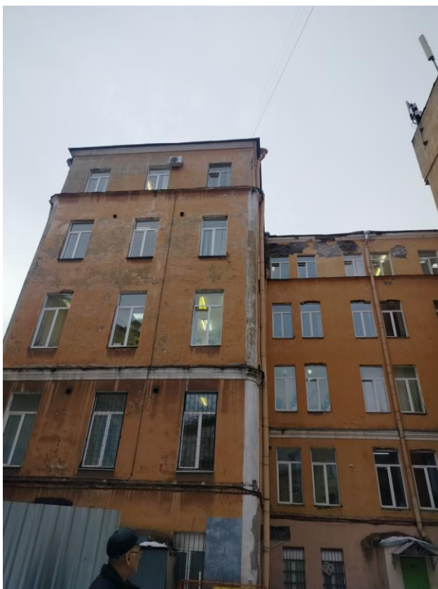
Фото 9. Фрагмент дворового фасада выявленного объекта культурного наследия «Здание Третьей военной гимназии»
