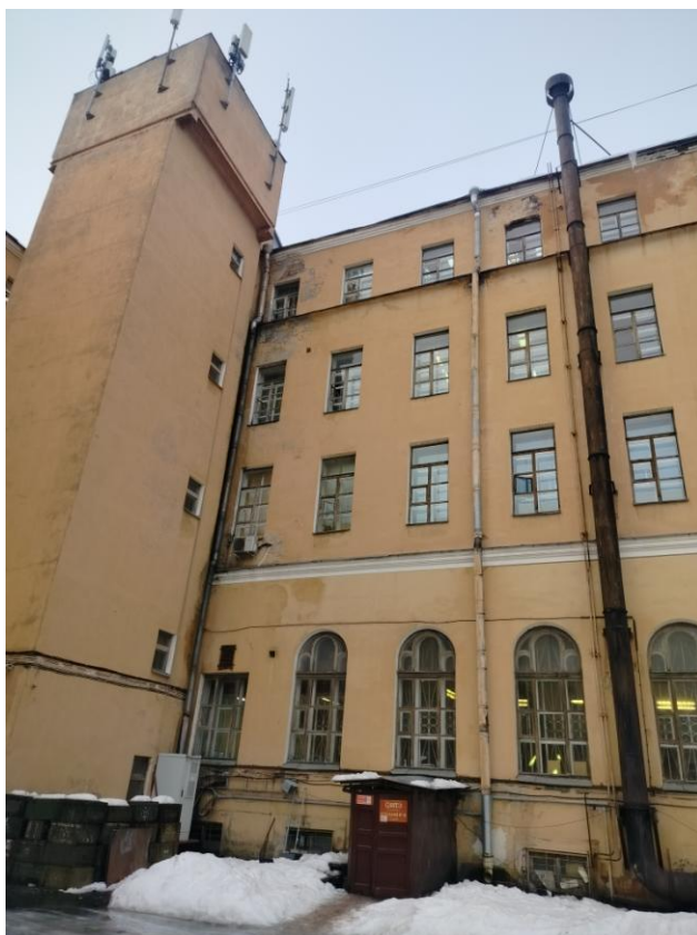
Фото 7. Фрагмент дворового фасада выявленного объекта культурного наследия «Здание Третьей военной гимназии»
