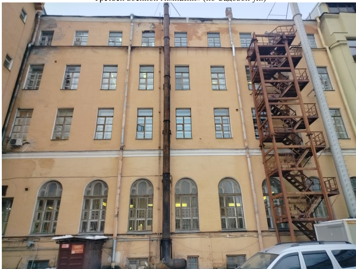
Фото 6. Фрагмент дворового фасада выявленного объекта культурного наследия «Здание Третьей военной гимназии»
