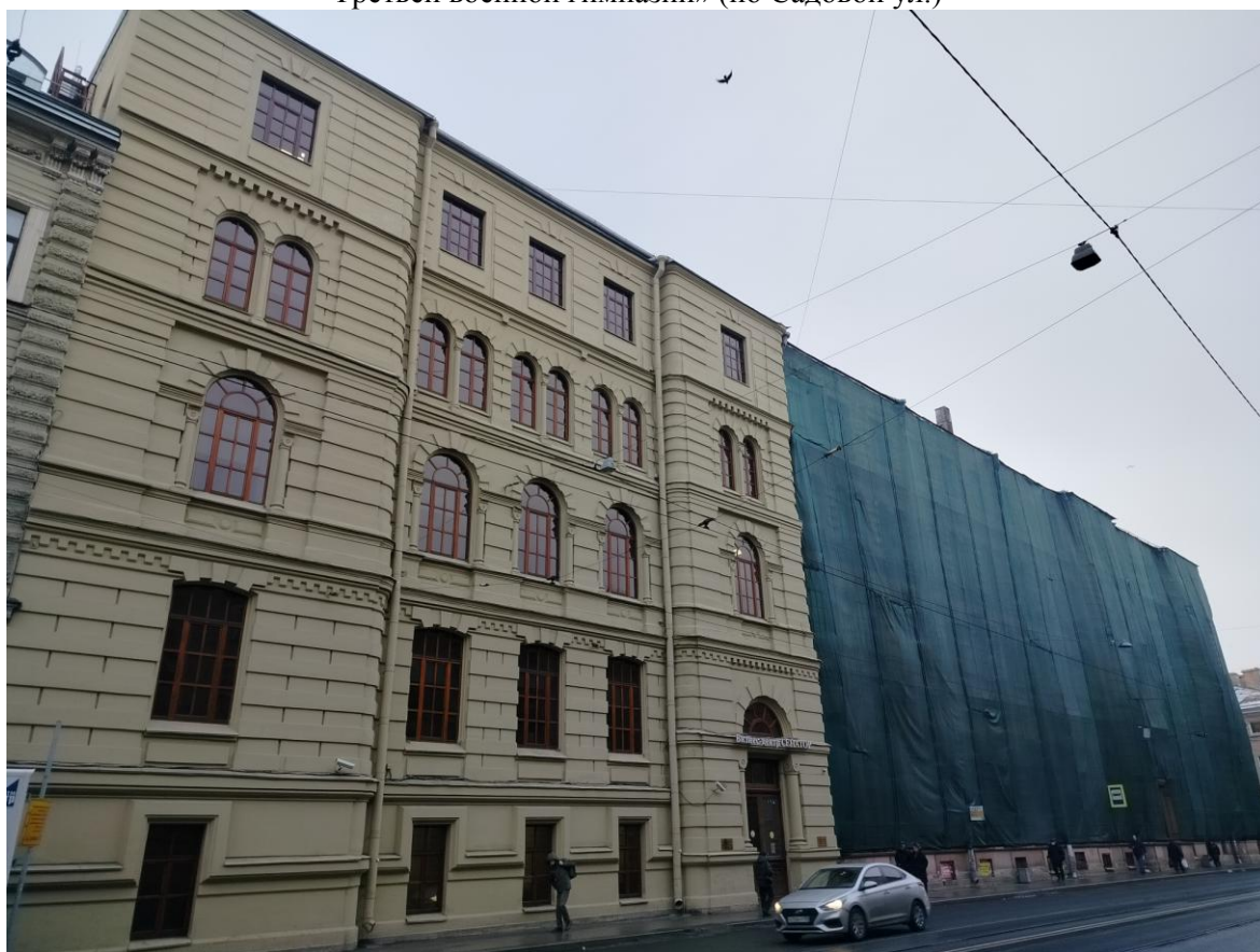
Фото 4. Фрагмент лицевого фасада выявленного объекта культурного наследия «Здание Третьей военной гимназии» (по Садовой ул.)
