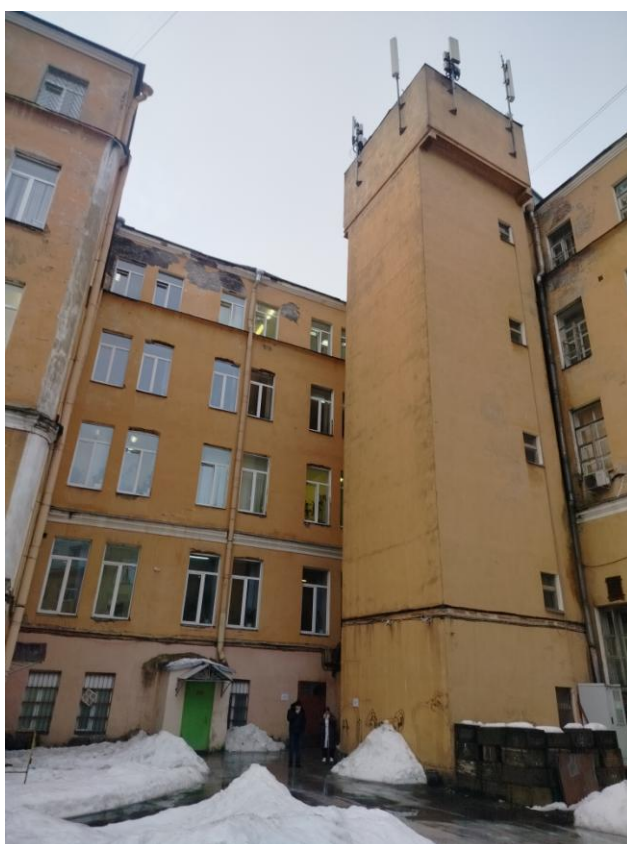
Фото 8. Фрагмент дворового фасада выявленного объекта культурного наследия «Здание Третьей военной гимназии»
