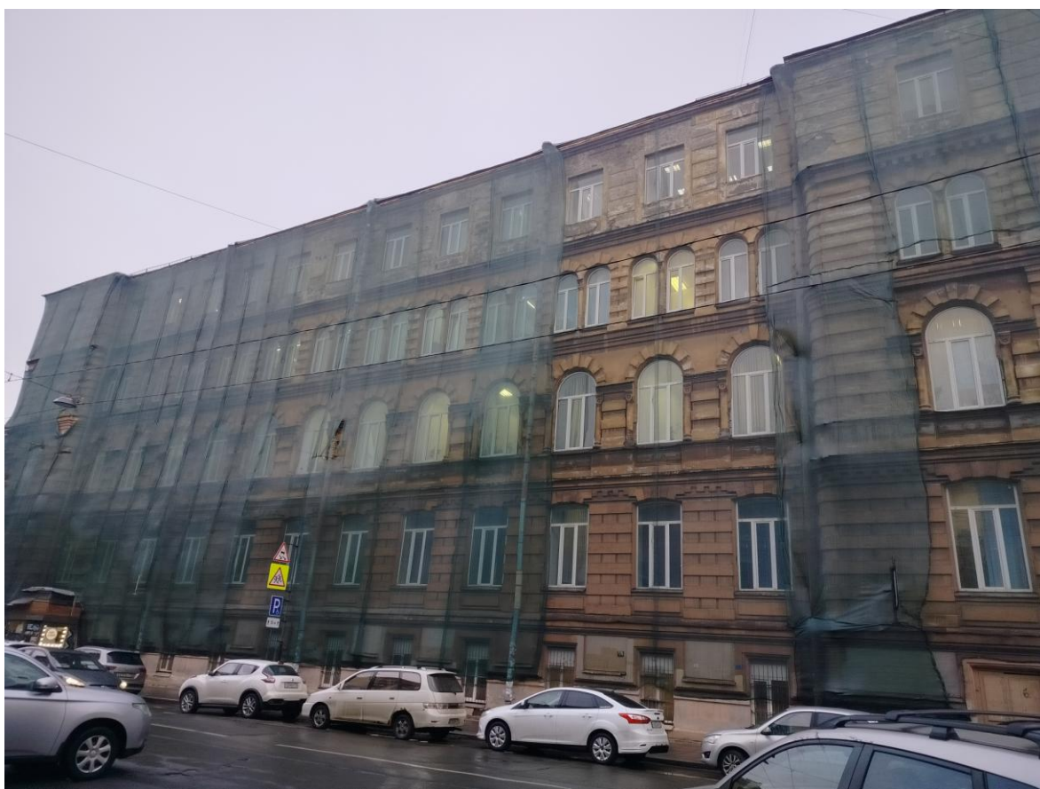
Фото 2. Фрагмент лицевого фасада выявленного объекта культурного наследия «Здание Третьей военной гимназии» (по Итальянской ул.)
