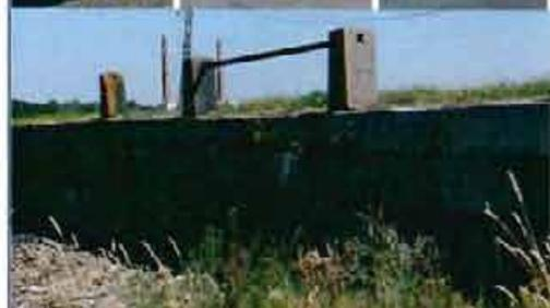
историческая облицовка устоев моста дамбы крупногабаритными гранитными блоками;
