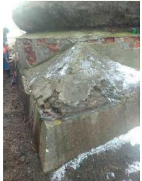
кирпичный боров (горизонтальный кирпичный канал) соединяющий трубу и здание котельной (конструкция сводов – полуциркульные);
