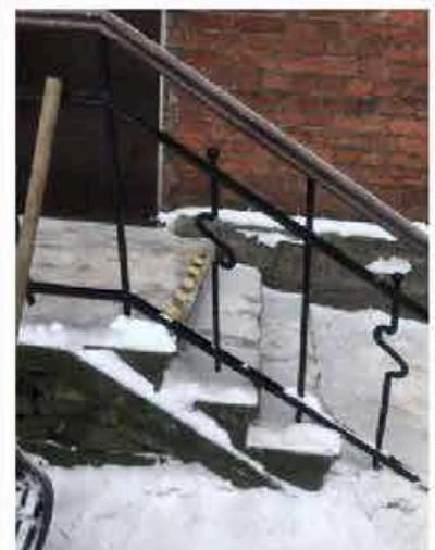
ограждение крыльца — материал (металл), техника исполнения (ковка), оформление (в виде вертикальных стоек, чередующихся с изогнутыми прутьями, оканчивающихся шариками);
