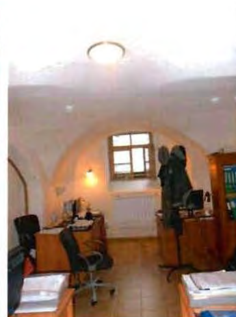
4. Свод цокольного этажа.
