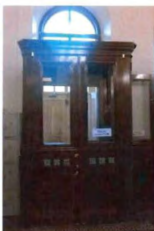
3. Тамбур главного входа.
