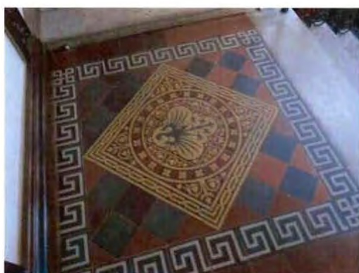
5. Покрытие пола верхнего уровня вестибюля.
