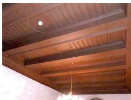
8. Оформление потолка над лестничной клеткой.
