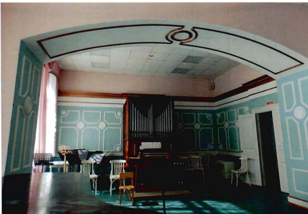
3. Помещение 2 этажа (50-Н).
