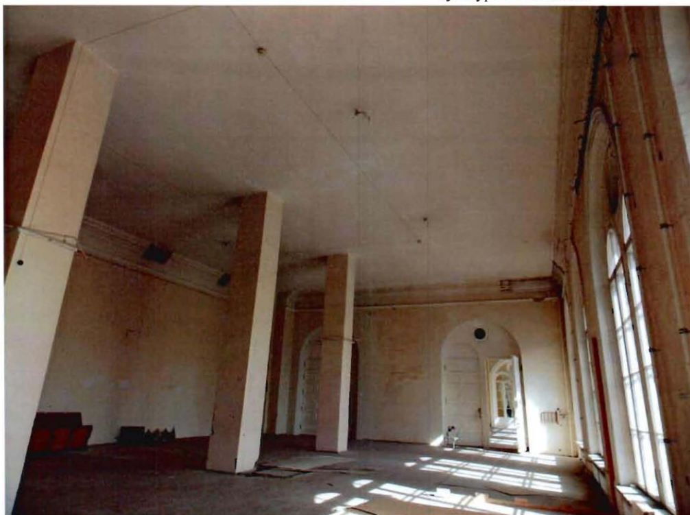
6. Помещение 3 этажа (41-Н).
