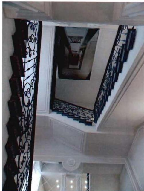
5. Лестница в северной части объекта культурного наследия.
