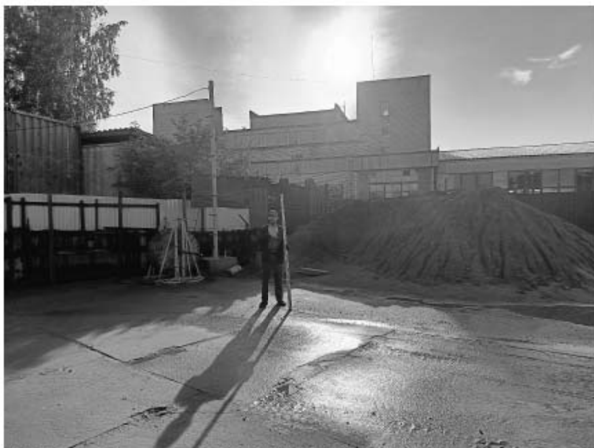
Рис. 18. Маршала Новикова ул., 40А-2024. КН 78:34:0004120:11. Точка фотофиксации 2, вид с юга.
