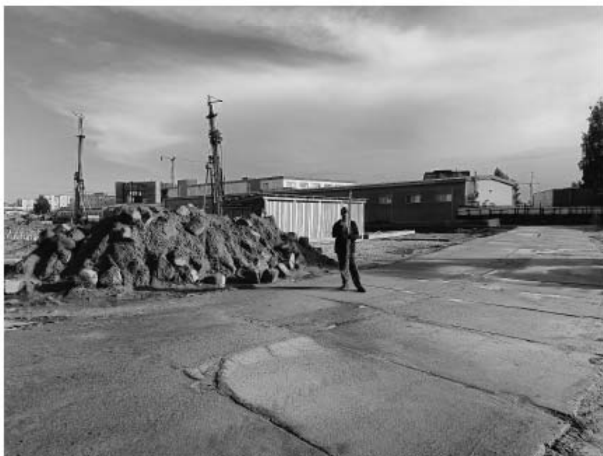
Рис. 20. Маршала Новикова ул., 40А-2024. КН 78:34:0004120:11. Точка фотофиксации 2, вид с севера.
