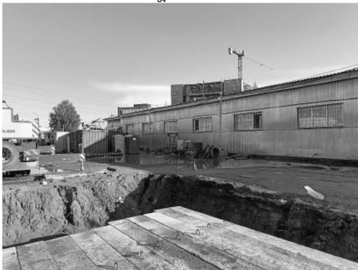
Рис. 29. Маршала Новикова ул., 40А-2024. КН 78:34:0004120:11. Точка фотофиксации 6, вид с севера.
