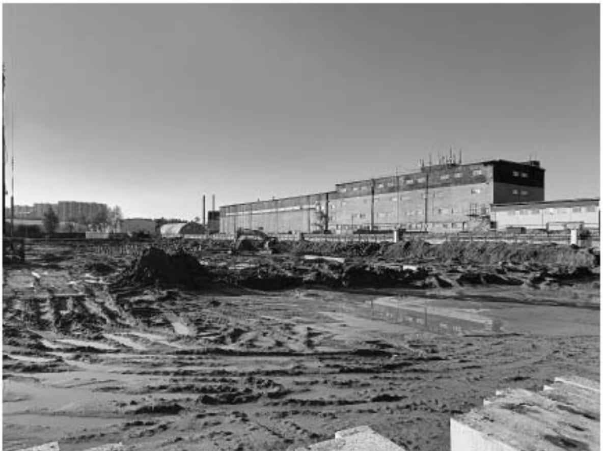
Рис. 28. Маршала Новикова ул., 40А-2024. КН 78:34:0004120:11. Точка фотофиксации 6, вид с юга.
