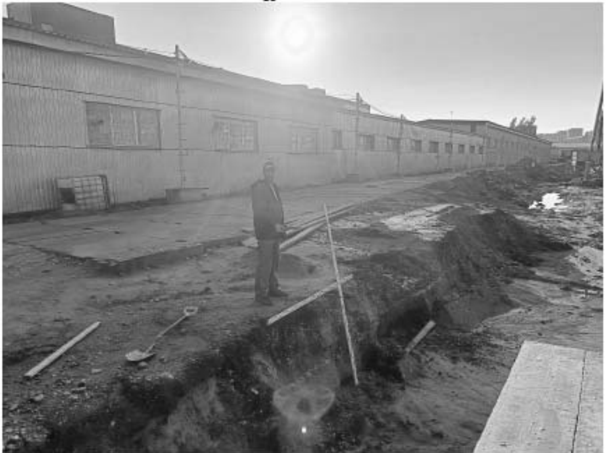
Рис. 39. Маршала Новикова ул., 40А-2024. КН 78:34:0004120:11. Местоположение шурфа 3, вид с востока.
