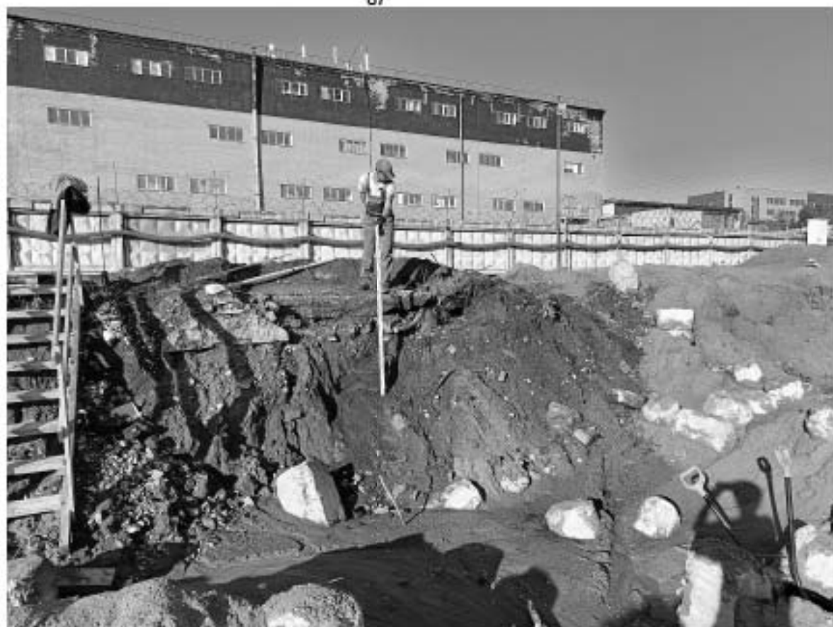
Рис. 35. Маршала Новикова ул., 40А-2024. КН 78:34:0004120:11. Местоположение шурфа 2, вид с запада.
