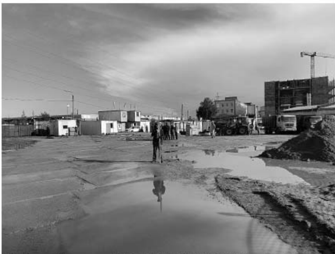
Рис. 16. Маршала Новикова ул., 40А-2024. КН 78:34:0004120:11. Точка фотофиксации 1, вид с севера.
