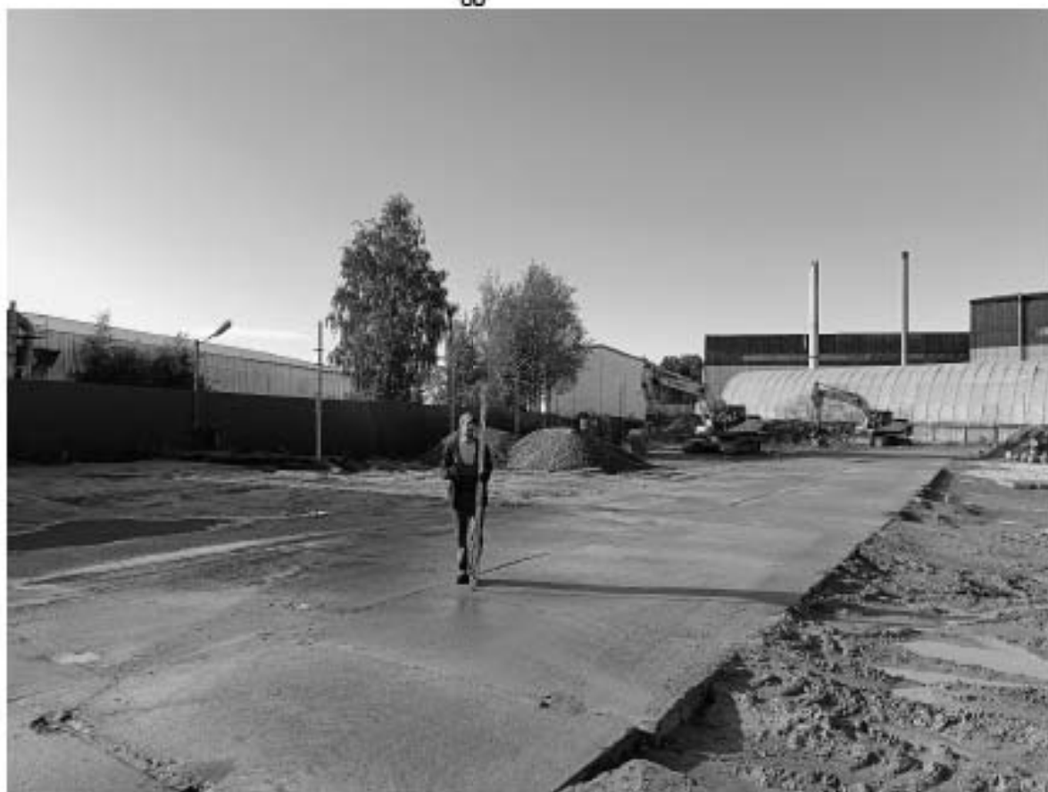
Рис. 21. Маршала Новикова ул., 40А-2024. КН 78:34:0004120:11. Точка фотофиксации 3, вид с юга.
