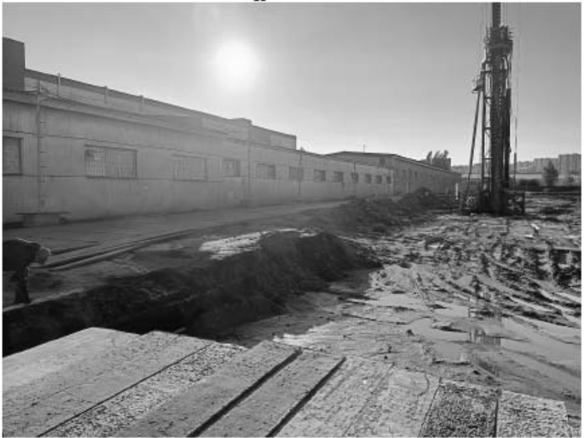
Рис. 27. Маршала Новикова ул., 40А-2024. КН 78:34:0004120:11. Точка фотофиксации 6, вид с востока.
