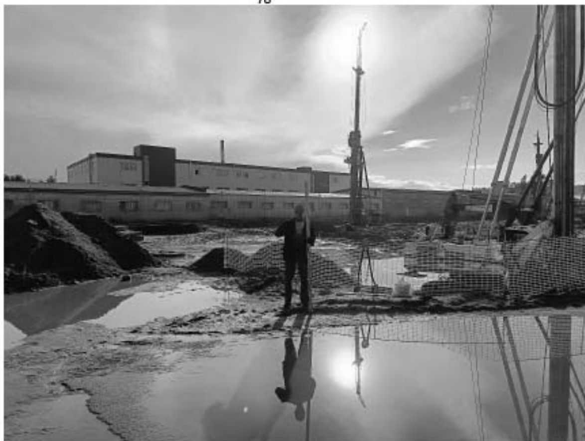
Рис. 17. Маршала Новикова ул., 40А-2024. КН 78:34:0004120:11. Точка фотофиксации 1, вид с востока.
