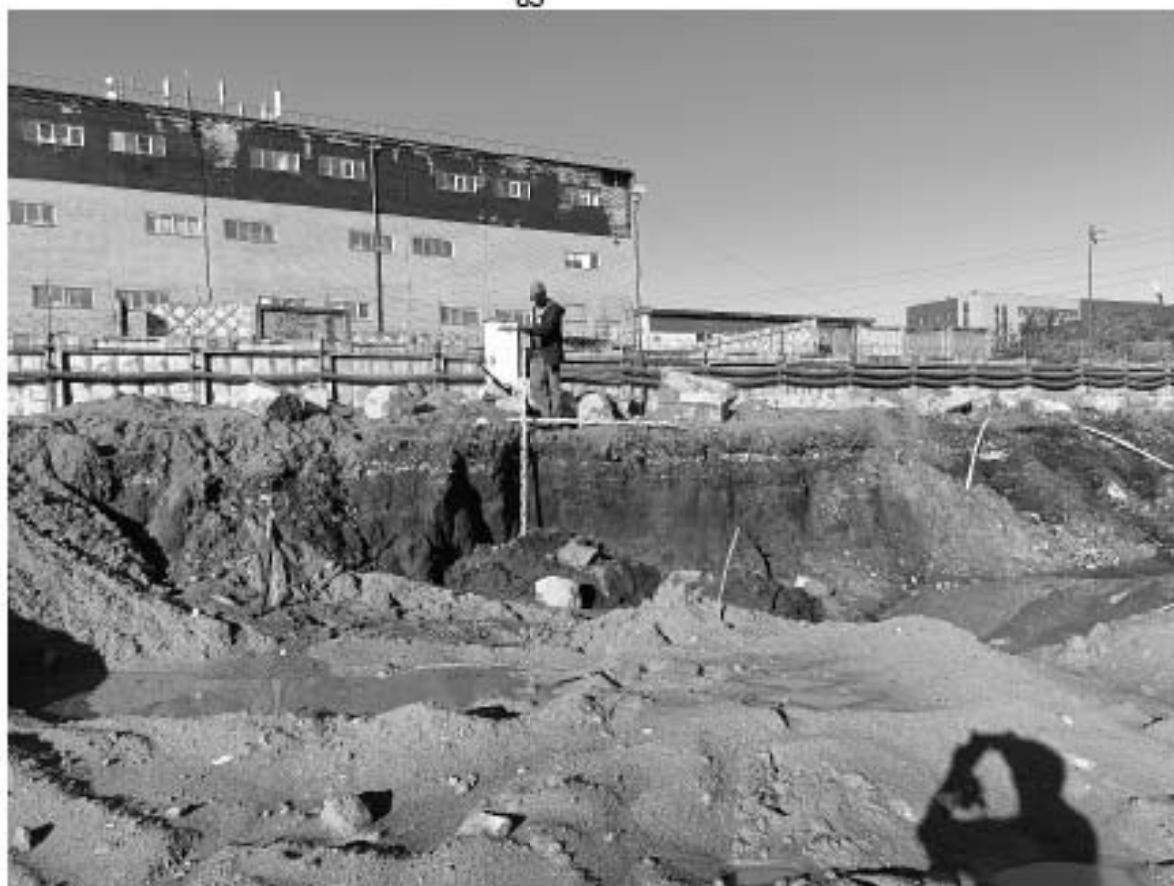
Рис. 31. Маршала Новикова ул., 40А-2024. КН 78:34:0004120:11. Местоположение шурфа 1, вид с запада.
