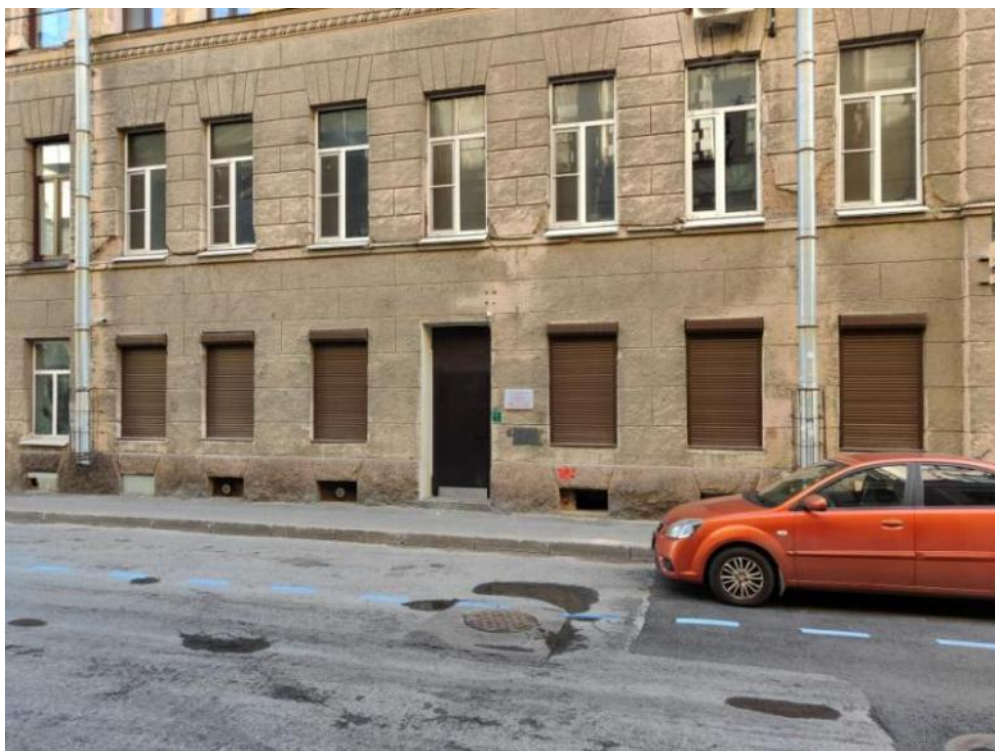
Фото 5 Лицевой фасад объекта культурного наследия регионального значения «Доходный дом А.А. Антоновой» (по Подрезова ул.) – окна пом. 12-Н
