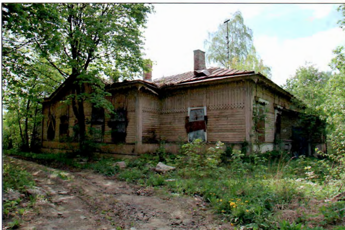
22. Общий вид. Юго-восточный фасад.
