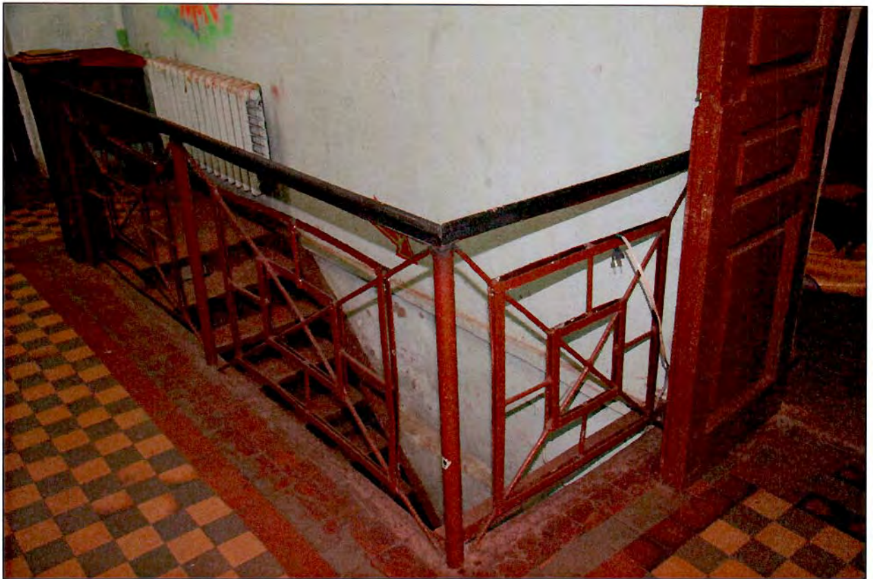
9. Интерьер. Лестница в подвал.
