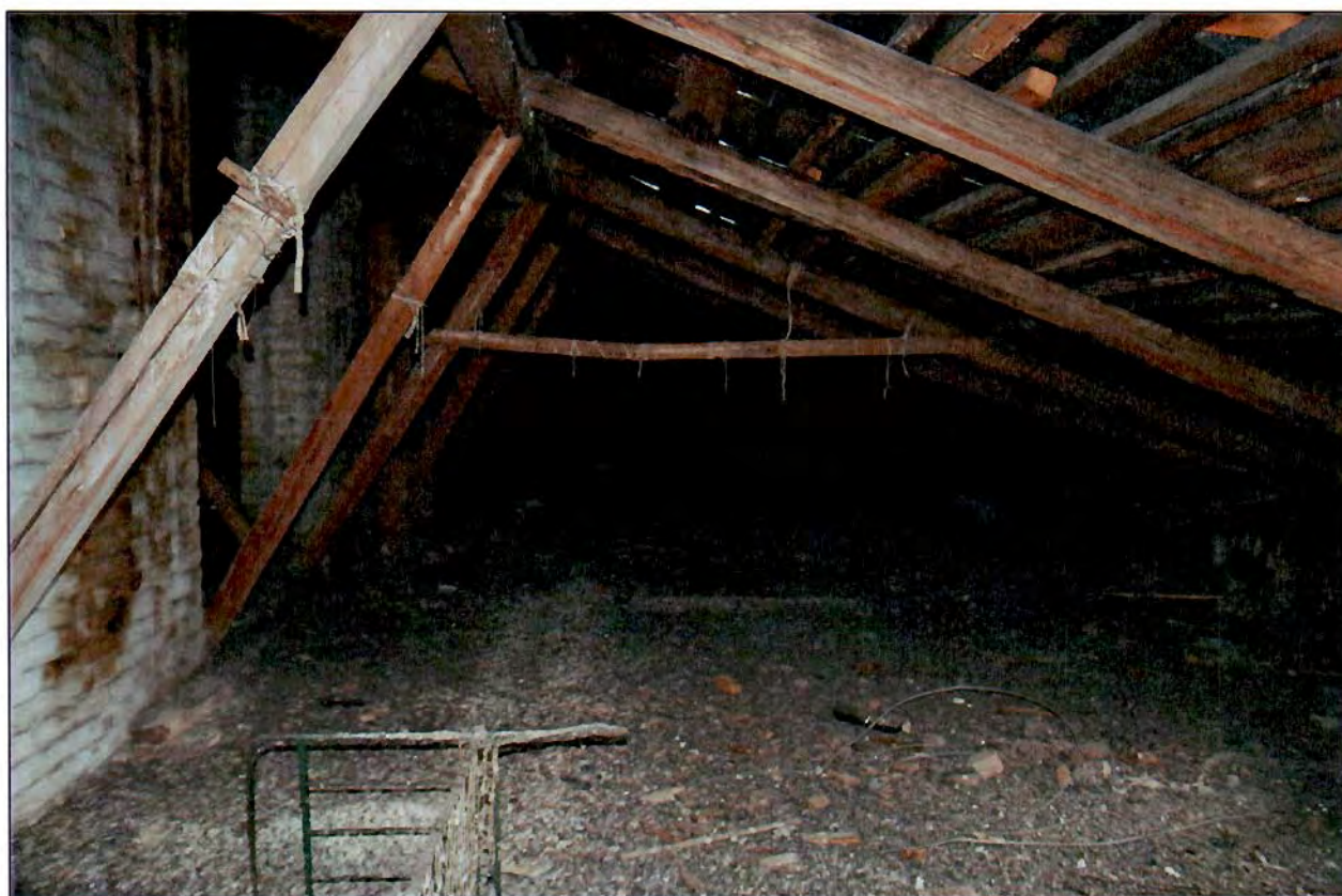
14. Интерьер. Чердак. Стропильная система.
