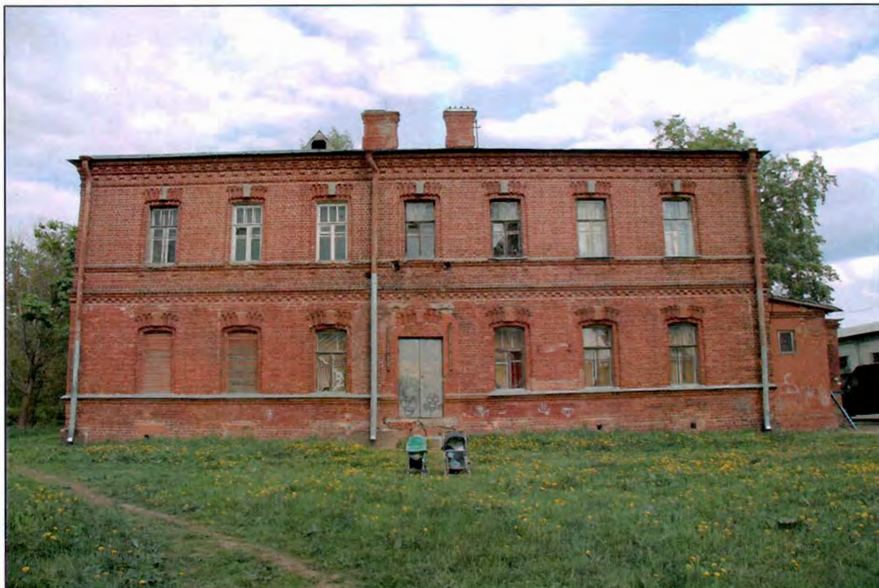
3. Общий вид. Западный фасад
