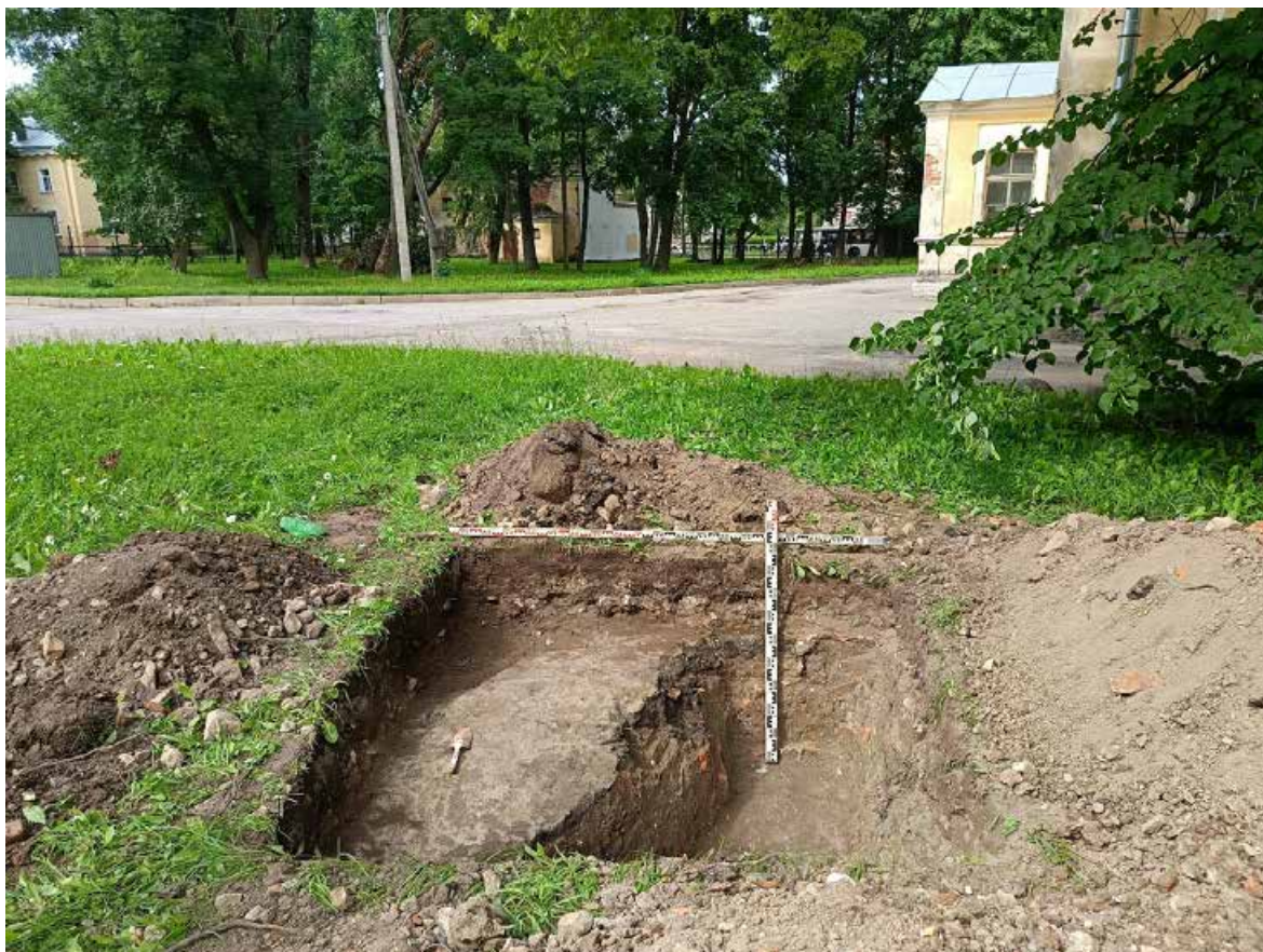
Рис. 48. Петергоф-2024. КН: 78:40:1924801:1440. Шурф 3, фиксация по уровню окончания работ, вид с юга.
