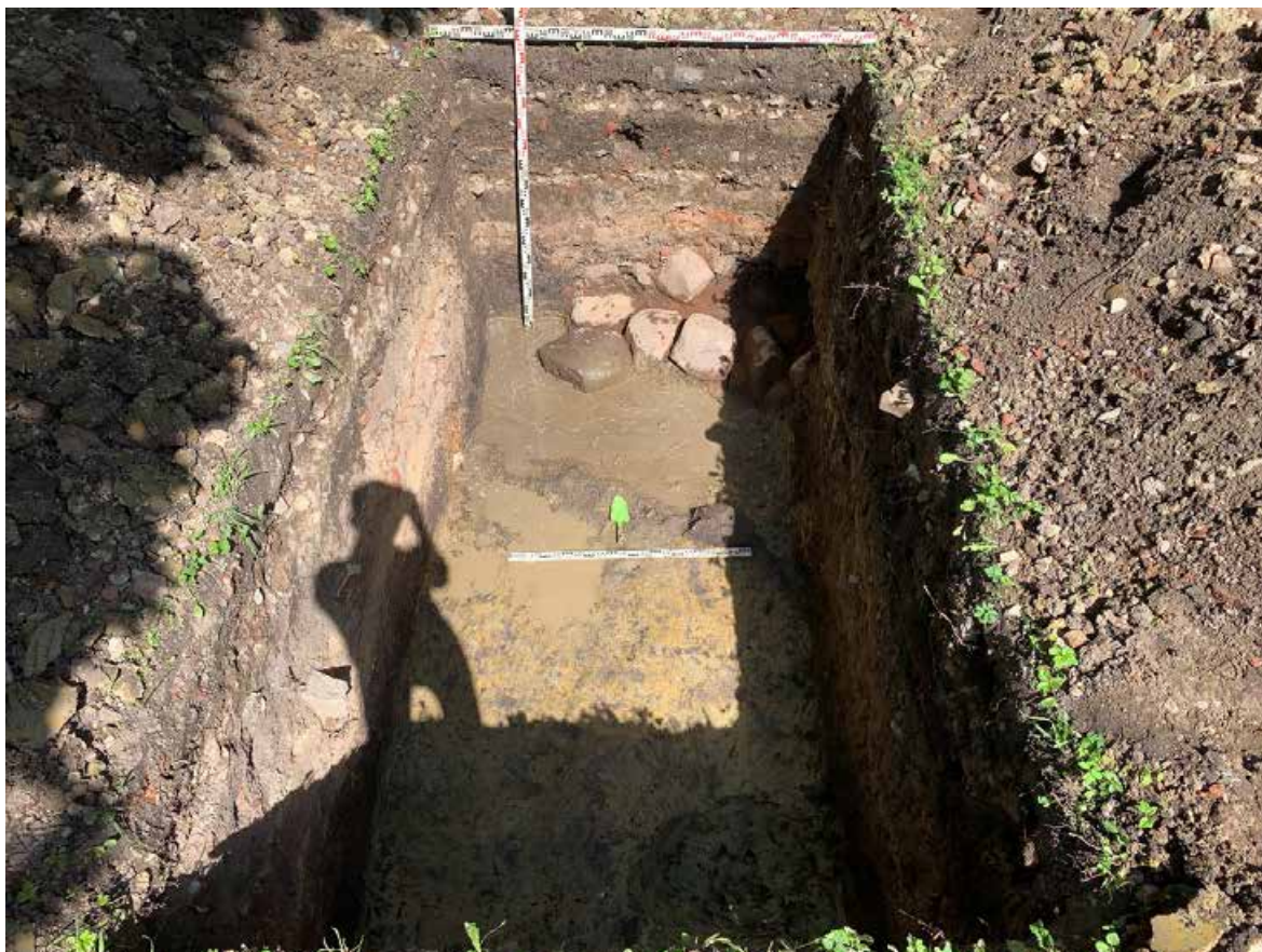
Рис. 42. Петергоф-2024. КН: 78:40:1924801:1440. Шурфы 1-2, фиксация по уровню окончания работ, вид с юга.
