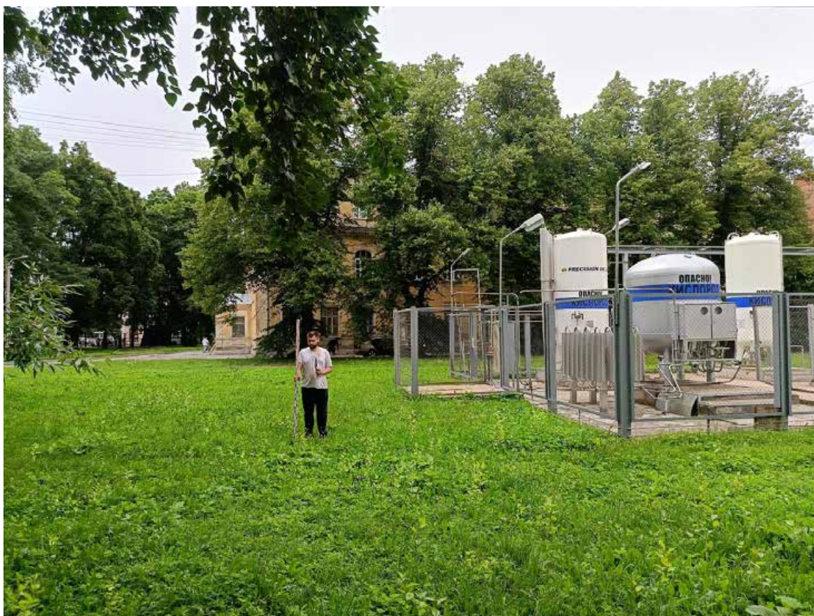
Рис. 22. Петергоф-2024. КН: 78:40:1924801:1440. Точка фотофиксации 3, вид с юга.
