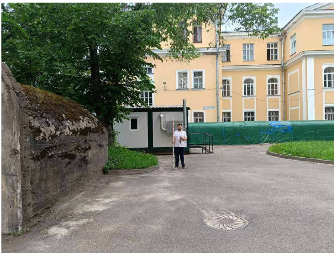
Рис. 20. Петергоф-2024. КН: 78:40:1924801:1440. Точка фотофиксации 2, вид с севера.
