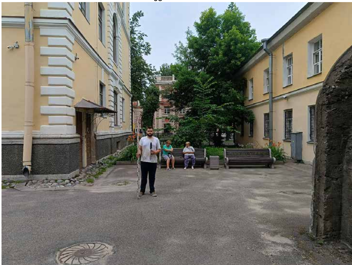
Рис. 19. Петергоф-2024. КН: 78:40:1924801:1440. Точка фотофиксации 2, вид с юга.
