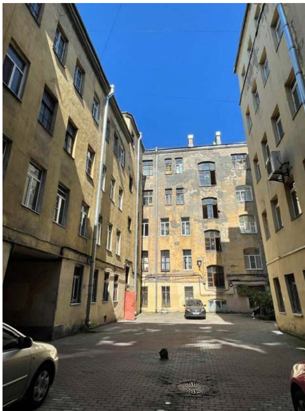
Фото 9. Фрагмент дворового фасада объекта культурного наследия регионального значения «Дом Е.Н.Сухомлиной (П.П.Баранова)»
