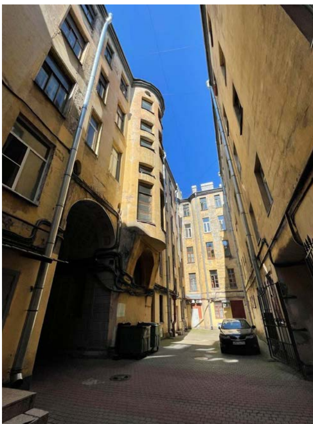
Фото 6. Фрагмент дворового фасада объекта культурного наследия регионального значения «Дом Е.Н.Сухомлиной (П.П.Баранова)»
