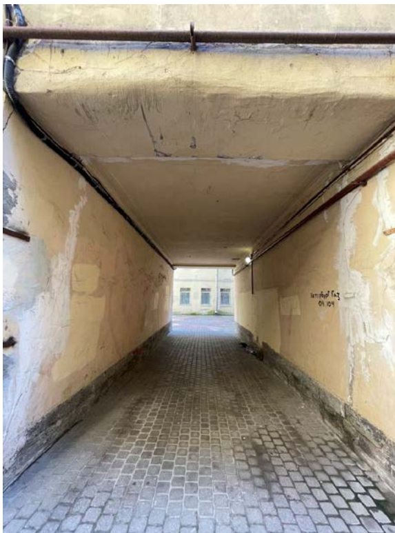
Фото 7. Фрагмент дворового фасада объекта культурного наследия регионального значения «Дом Е.Н.Сухомлиной (П.П.Баранова)»
