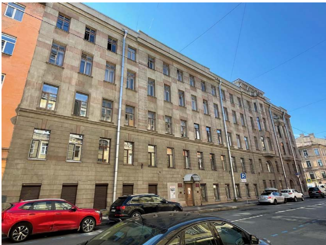
Фото 1. Лицевой фасад объекта культурного наследия регионального значения «Дом Е.Н.Сухомлиной (П.П.Баранова)» (по 5-ой Красноармейской ул.)
