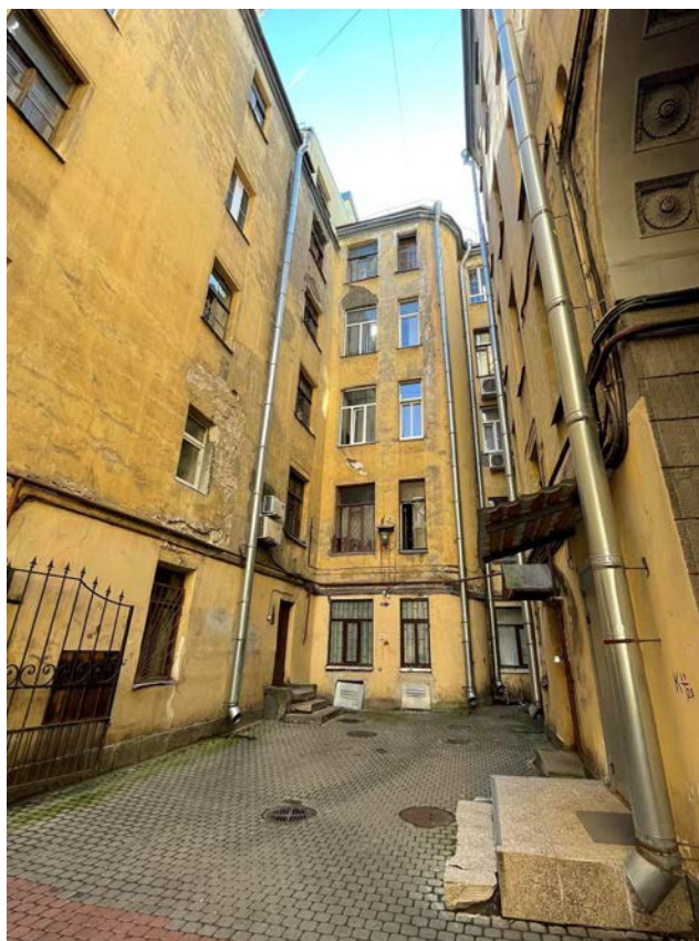
Фото 5. Фрагмент дворового фасада объекта культурного наследия регионального значения «Дом Е.Н.Сухомлиной (П.П.Баранова)»
