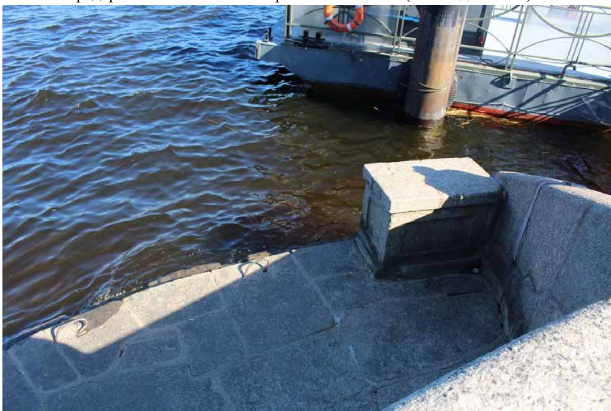
Фото 8. Вид на парапет юго-восточной лестницы объекта культурного наследия федерального значения «Пристань Невская (Комендантская)».
