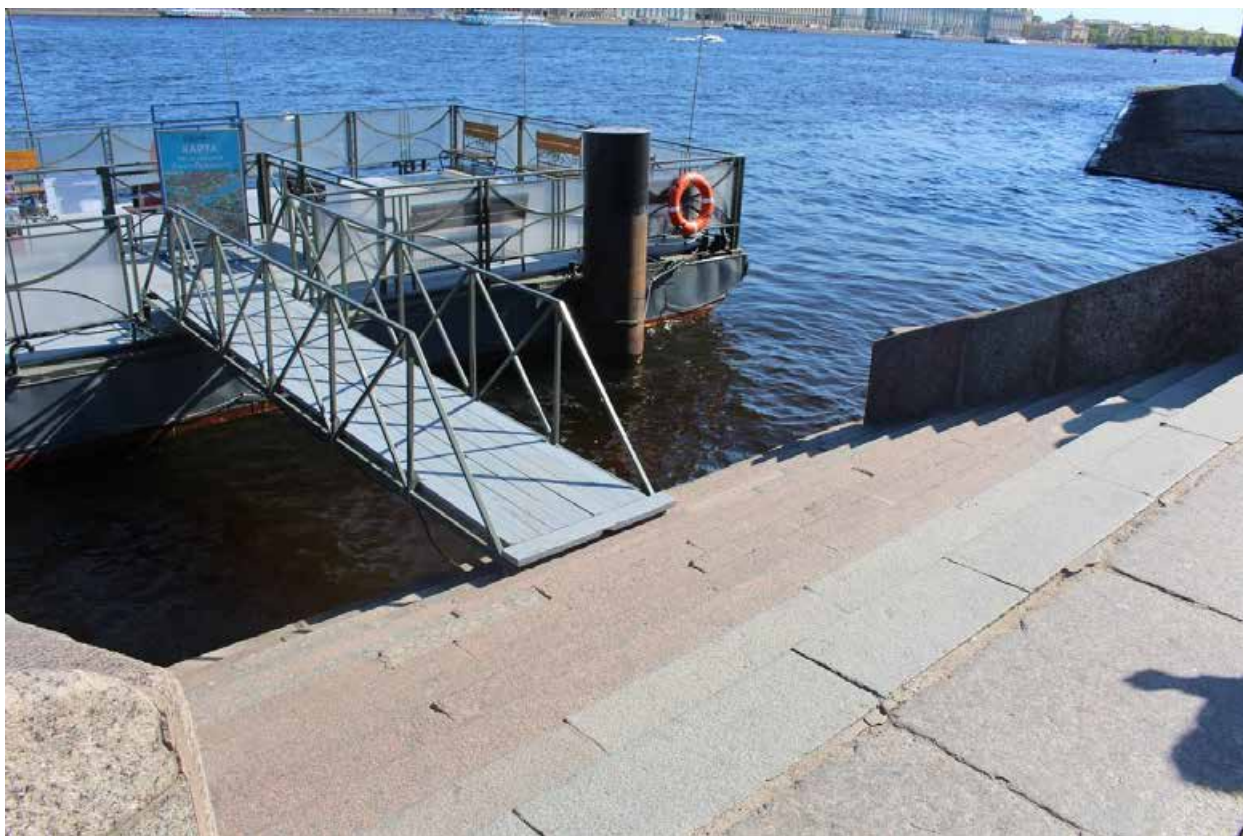
Фото 5. Вид на юго-восточную лестницу объекта культурного наследия федерального значения «Пристань Невская (Комендантская)».
