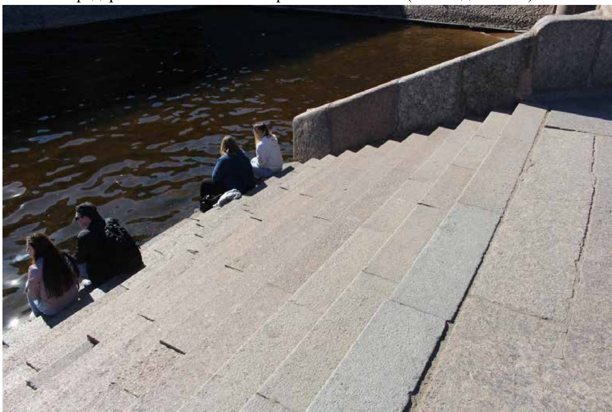
Фото 10. Вид на юго-западную лестницу объекта культурного наследия федерального значения «Пристань Невская (Комендантская)».
