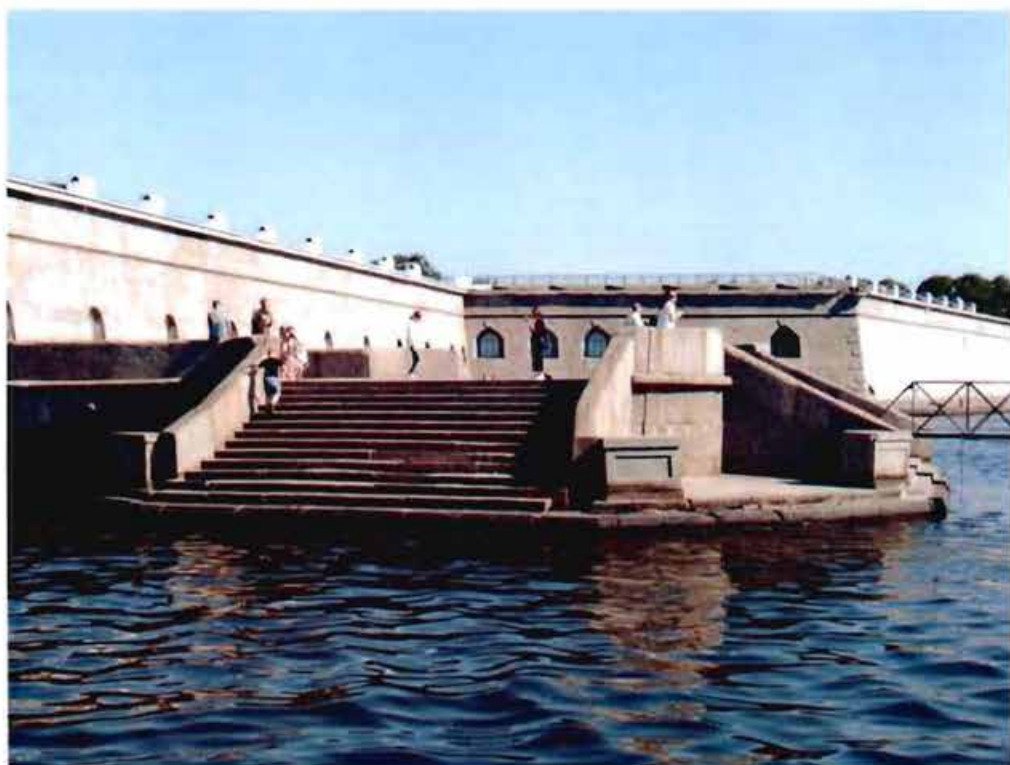
3. Площадка с лестничными спусками.
