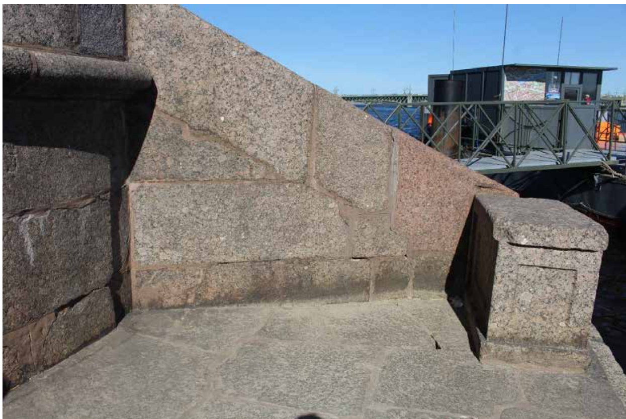
Фото 7. Вид на парапет юго-восточной лестницы объекта культурного наследия федерального значения «Пристань Невская (Комендантская)».
