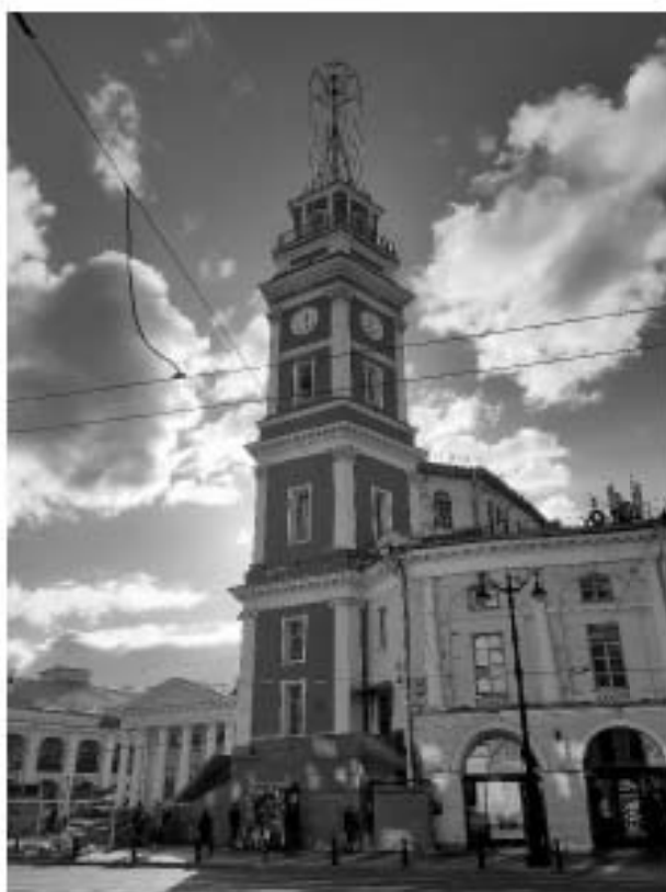
1. «Дума городская с башней (1752-1753 г.г., 1799-1804 г.г., арх. Феррари Д. 1848-1852 г.г., арх. Ефимов Н.Е., 1913-1914 г.г., арх. Кенель А.В.)», ул. Думская, д 1-3, лит. А, Невский проспект. Общий вид башни с севера. Фото 17.10.2023г.
