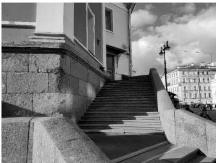
21. «Дума городская с башней (1752-1753 г.г., 1799-1804 г.г., арх. Феррари Д. 1848-1852 г.г., арх. Ефимов Н.Е., 1913-1914 г.г., арх. Кенель А.В.)», ул. Думская, д 1-3, лит. А, Невский проспект. Восточный фасад. Фрагмент. Фото 17.10.2023г.
