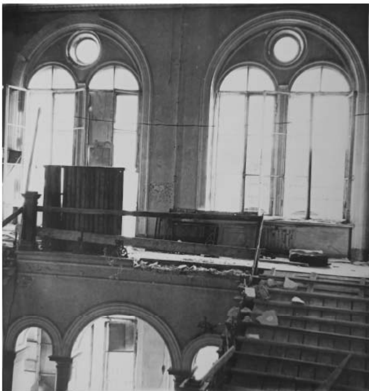
Илл. 65. Парадная лестница. Лестничная площадка 3-го этажа. 1986 г. ЦГАНДТ СПб. Ф. Р-488. Оп. 323. Д. 656
