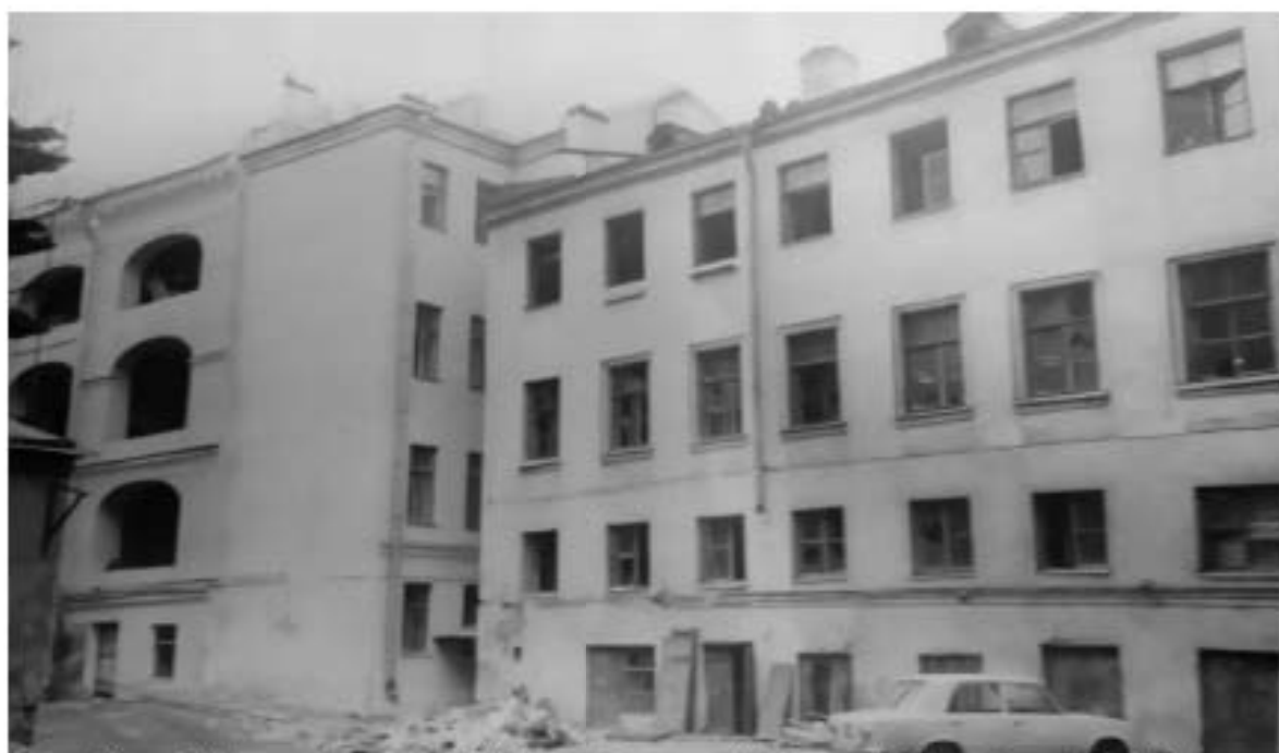
Илл. 54. Здание Городской Думы. Дворовый фасад. 1979 г. Архив КТИОП
