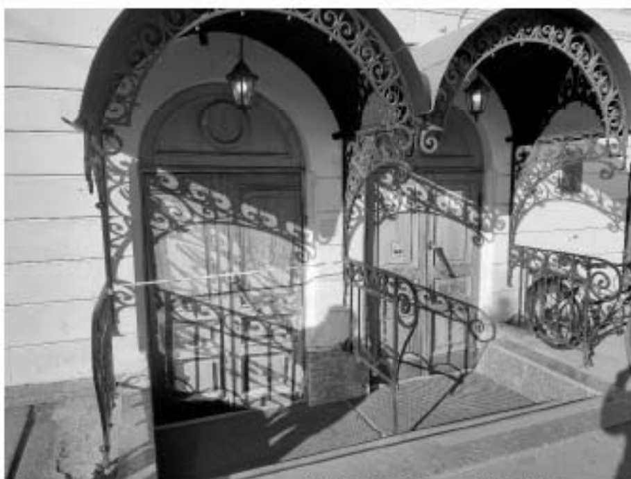
10. «Дума городская с башней (1752-1753 г.г., 1799-1804 г.г., арх. Феррари Д. 1848-1852 г.г., арх. Ефимов Н.Е., 1913-1914 г.г., арх. Кенель А.В.)», ул. Думская, д 1-3, лит. А, Невский проспект. Восточный фасад. Входная группа. Общий вид. Фото 17.10.2023г.
