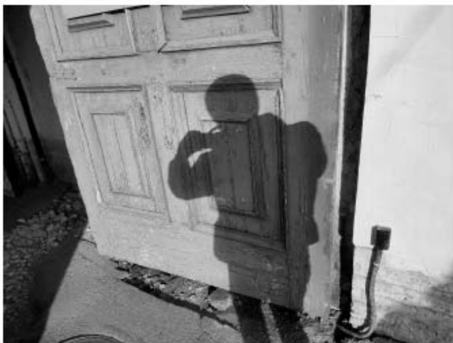
16. «Дума городская с башней (1752-1753 г.г., 1799-1804 г.г., арх. Феррари Д. 1848-1852 г.г., арх. Ефимов Н.Е., 1913-1914 г.г., арх. Кенель А.В.)», ул. Думская, д 1-3, лит. А, Невский проспект. Восточный фасад. Проезд во двор. Фрагмент. Фото 17.10.2023г.
