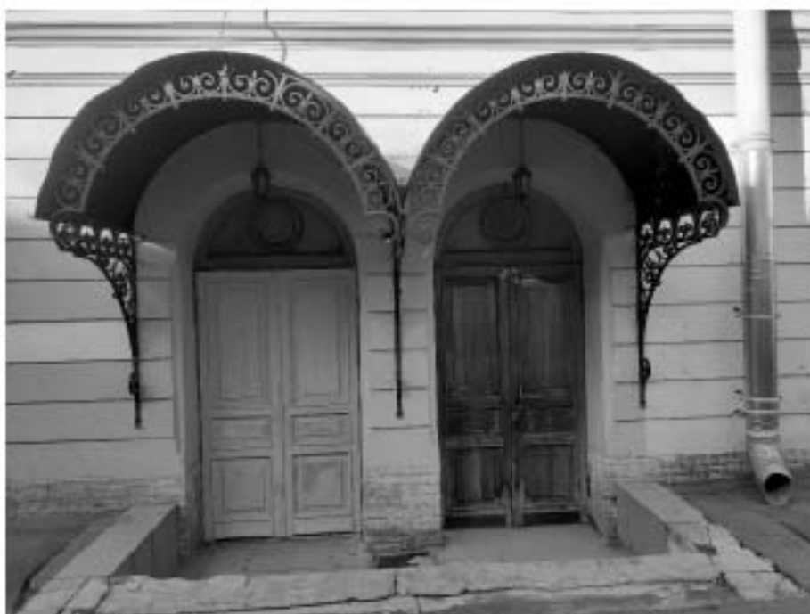
5. «Дума городская с башней (1752-1753 г.г., 1799-1804 г.г., арх. Феррари Д. 1848-1852 г.г., арх. Ефимов Н.Е., 1913-1914 г.г., арх. Кенель А.В.)», ул. Думская, д 1-3, лит. А, Невский проспект. Восточный фасад. Входная группа. Общий вид. Фото 17.10.2023г.
