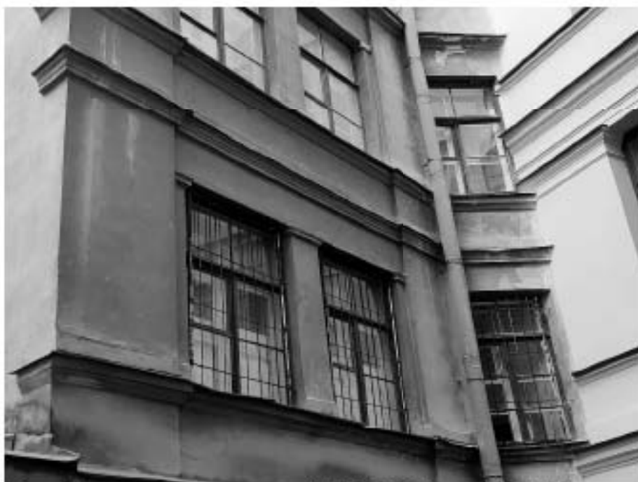
50. «Дума городская с башней (1752-1753 гг., 1799-1804 гг., арх. Феррари Д. 1848-1852 гг., арх. Ефимов Н.Е., 1913-1914 гг., арх. Кенель А.В.)», ул. Думская, д 1-3, лит. А, Невский проспект. Дворовый фасад. Фрагмент. Фото 17.10.2023г.
