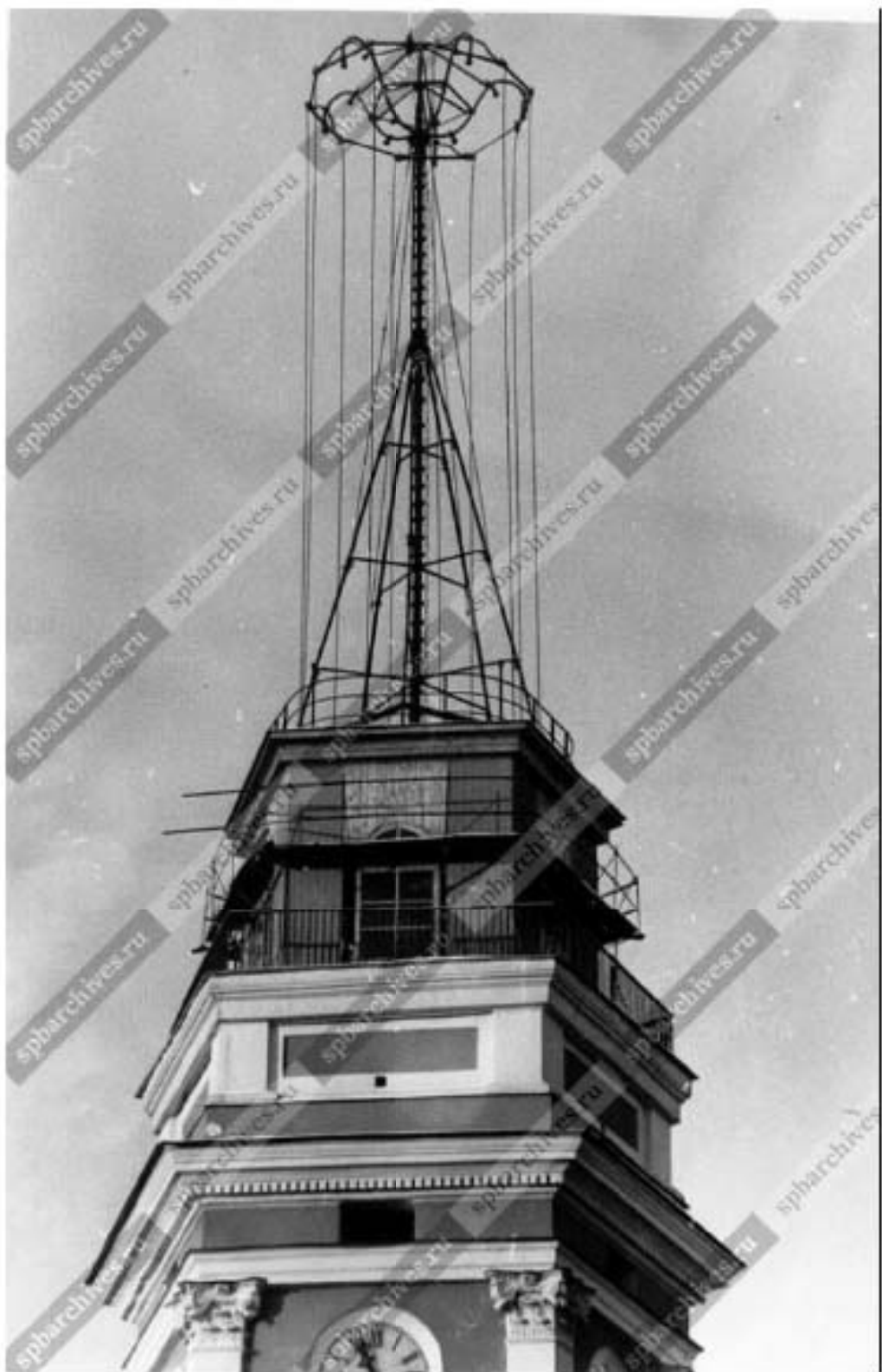
Илл. 57. Станция оптического телеграфа, венчающая башню Городской думы (дома № 1-3 на Думской улице). Конец 1980-х гг. ЦГАКФФД СПб. Фотодокумент Ар 207514.
