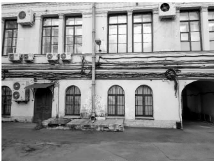
42. «Дума городская с башней (1752-1753 гг., 1799-1804 гг., арх. Феррари Д. 1848-1852 гг., арх. Ефимов Н.Е., 1913-1914 гг., арх. Кенель А.В.)», ул. Думская, д 1-3, лит. А, Невский проспект. Дворовый фасад. Фрагмент. Фото 17.10.2023г.
