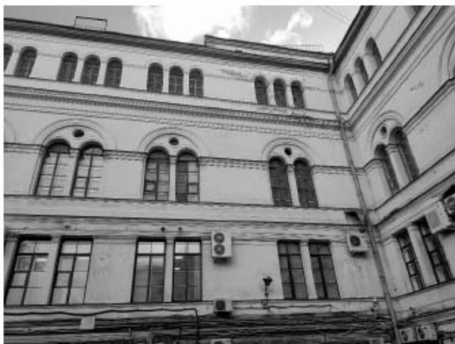
37. «Дума городская с башней (1752-1753 гг., 1799-1804 гг., арх. Феррари Д. 1848-1852 гг., арх. Ефимов Н.Е., 1913-1914 гг., арх. Кенель А.В.)», ул. Думская, д 1-3, лит. А, Невский проспект. Дворовый фасад. Фрагмент. Фото 17.10.2023г.
