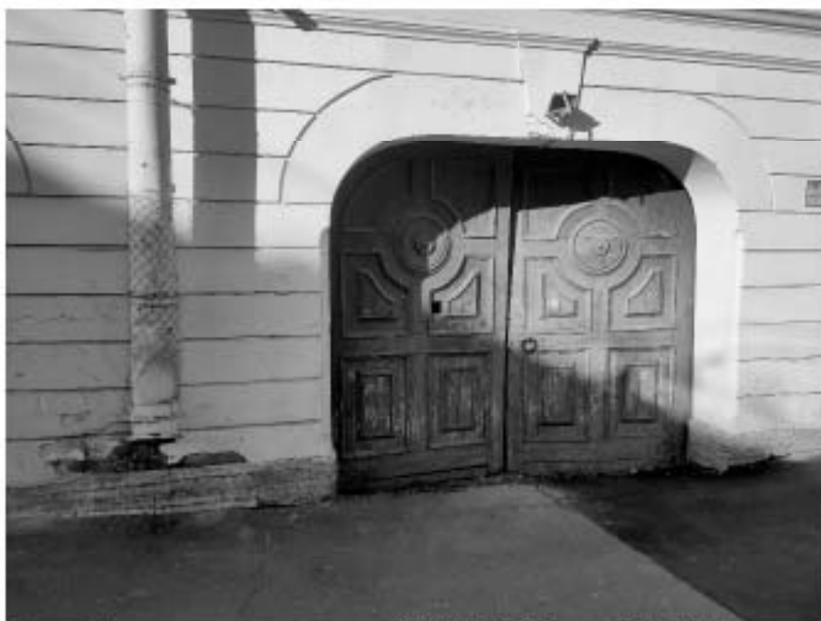
8. «Дума городская с башней (1752-1753 г.г., 1799-1804 г.г., арх. Феррари Д. 1848-1852 г.г., арх. Ефимов Н.Е., 1913-1914 г.г., арх. Кенель А.В.)», ул. Думская, д 1-3, лит. А, Невский проспект. Восточный фасад. Входная группа. Общий вид. Фото 17.10.2023г.
