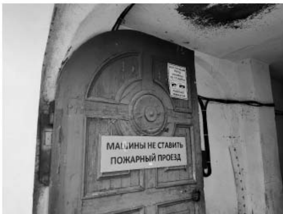
13. «Дума городская с башней (1752-1753 г.г., 1799-1804 г.г., арх. Феррари Д. 1848-1852 г.г., арх. Ефимов Н.Е., 1913-1914 г.г., арх. Кенель А.В.)», ул. Думская, д 1-3, лит. А, Невский проспект. Восточный фасад. Проезд во двор. Фрагмент. Фото 17.10.2023г.
