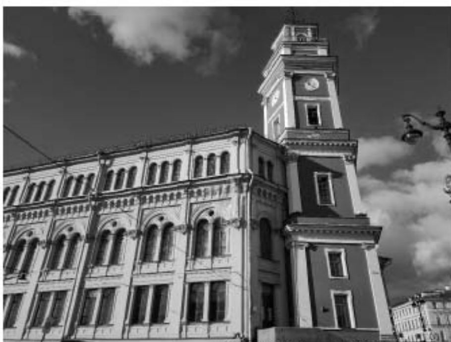
2. «Дума городская с башней (1752-1753 г.г., 1799-1804 г.г., арх. Феррари Д. 1848-1852 г.г., арх. Ефимов Н.Е., 1913-1914 г.г., арх. Кенель А.В.)», ул. Думская, д 1-3, лит. А, Невский проспект. Общий вид башни с востока. Фото 17.10.2023г.
