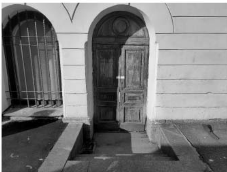
9. «Дума городская с башней (1752-1753 г.г., 1799-1804 г.г., арх. Феррари Д. 1848-1852 г.г., арх. Ефимов Н.Е., 1913-1914 г.г., арх. Кенель А.В.)», ул. Думская, д 1-3, лит. А, Невский проспект. Восточный фасад. Входная группа. Общий вид. Фото 17.10.2023г.
