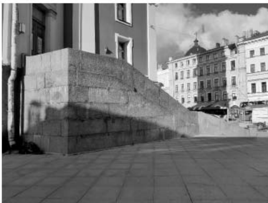
19. «Дума городская с башней (1752-1753 г.г., 1799-1804 г.г., арх. Феррари Д. 1848-1852 г.г., арх. Ефимов Н.Е., 1913-1914 г.г., арх. Кенель А.В.)», ул. Думская, д 1-3, лит. А, Невский проспект. Восточный фасад. Фрагмент. Фото 17.10.2023г.
