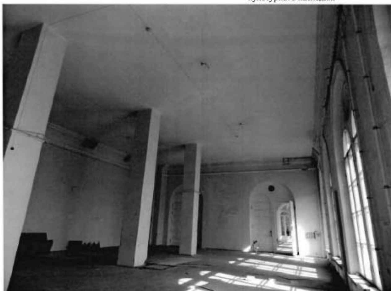
6. Помещение 3 этажа (41-Н).
