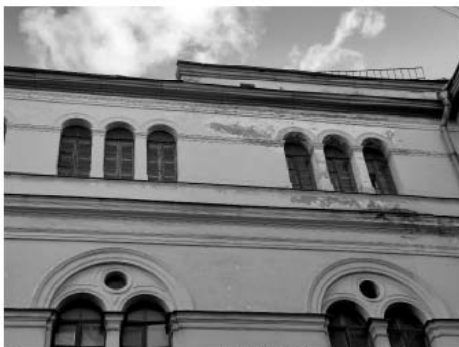
38. «Дума городская с башней (1752-1753 гг., 1799-1804 гг., арх. Феррари Д. 1848-1852 гг., арх. Ефимов Н.Е., 1913-1914 гг., арх. Кенель А.В.)», ул. Думская, д 1-3, лит. А, Невский проспект. Дворовый фасад. Фрагмент. Фото 17.10.2023г.
