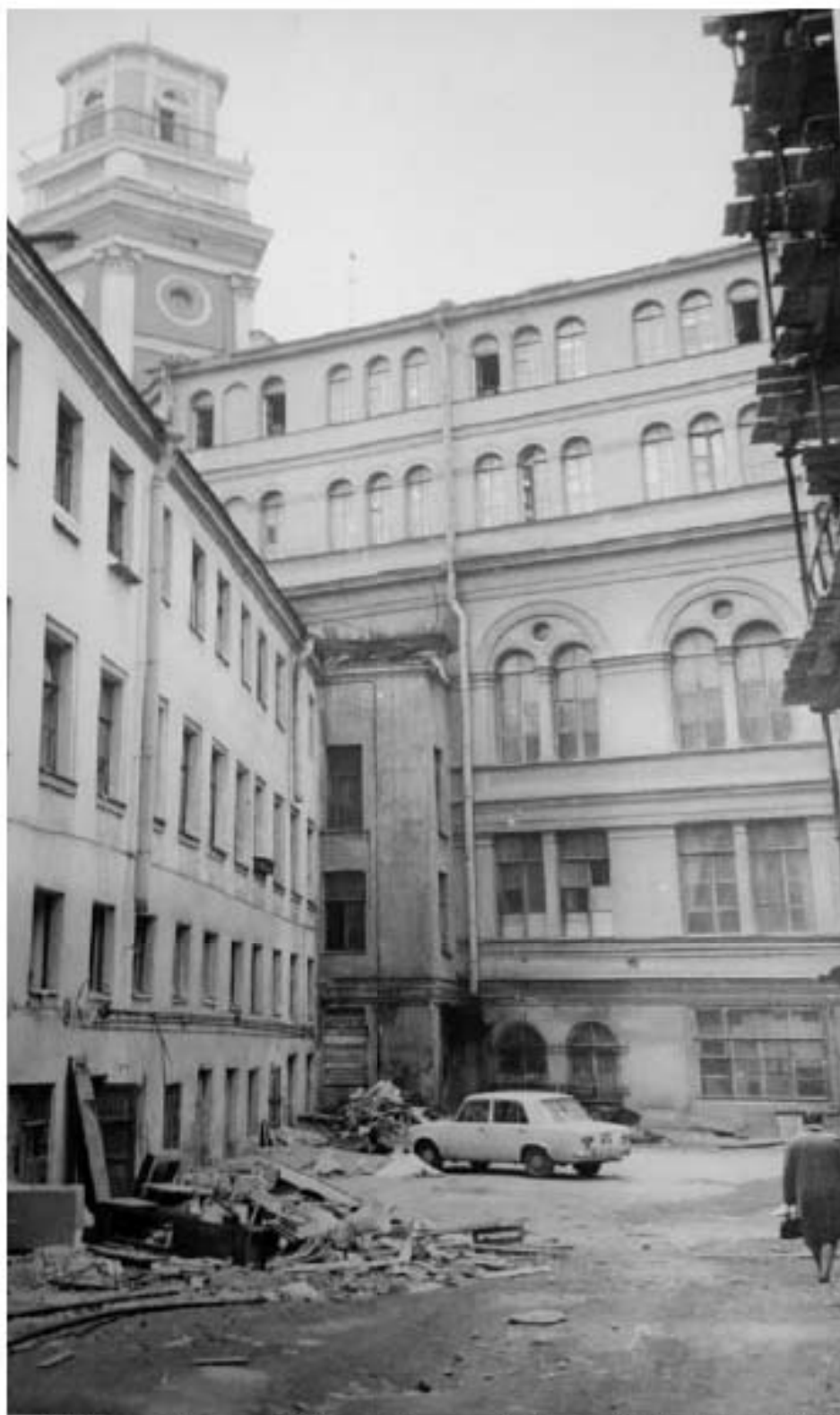
Илл. 55. Здание Городской Думы. Дворовый фасад. 1979 г. Архив КТИОП
