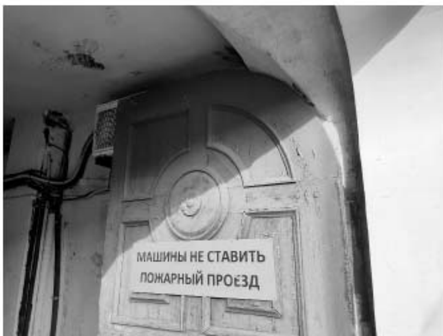
15. «Дума городская с башней (1752-1753 г.г., 1799-1804 г.г., арх. Феррари Д. 1848-1852 г.г., арх. Ефимов Н.Е., 1913-1914 г.г., арх. Кенель А.В.)», ул. Думская, д 1-3, лит. А, Невский проспект. Восточный фасад. Проезд во двор. Фрагмент. Фото 17.10.2023г.
