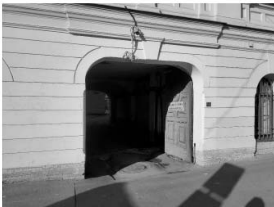
11. «Дума городская с башней (1752-1753 г.г., 1799-1804 г.г., арх. Феррари Д. 1848-1852 г.г., арх. Ефимов Н.Е., 1913-1914 г.г., арх. Кенель А.В.)», ул. Думская, д 1-3, лит. А, Невский проспект. Восточный фасад. Входная группа. Общий вид. Фото 17.10.2023г.
