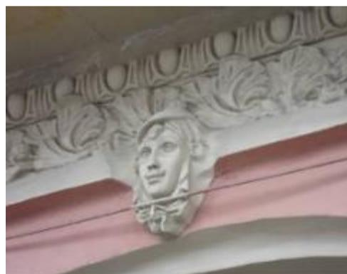
оформление оконных проемов 1-4 этажей: замковые камни с маскаронами. профилированные наличники, межэтажные филенки второго-третьего и третьего-четвертого этажей в оконных осях с лепными композициями в характере модерна, прямые сандрики оконных проемов третьего этажа;
