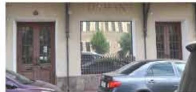
историческое заполнение дверных проемов – конструкция (двухстворчатое, полусветлое), материал (дерево), оформление (филенчатое), рисунок расстекловки верхней части;
