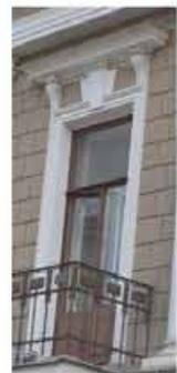
металлические оконные решетки в уровне 1-го этажа – местоположение, габариты, материал, техника исполнения (ковка), оформление (вертикальные прутья с верхним горизонтальным поясом с квадратными вставками);
