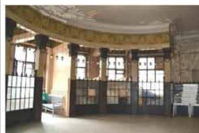
пилоны, несущие балки, со стилизованными фигурными капителями чугунного литья;
